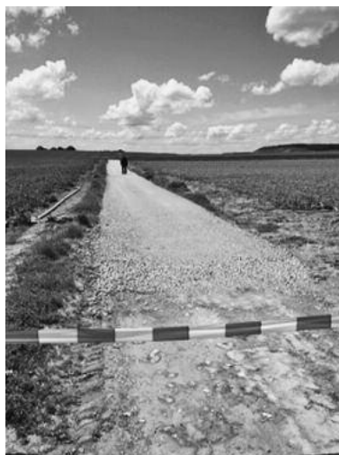
Ein rundum sanierter Feldweg der Stadt, am Ende der Sanierungsmaßnahme.
