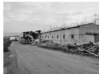
Mittlerweile wurde die ehemalige Kartoffelhalle auf dem Baywa-Gelände abgebrochen
