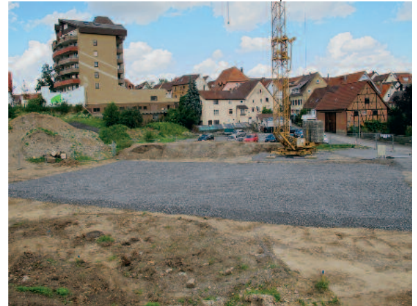
Die Schotterfläche markiert die Lage des Neubaus.
