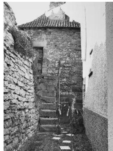
Stadtmauer Altes Heilbronner Tor
