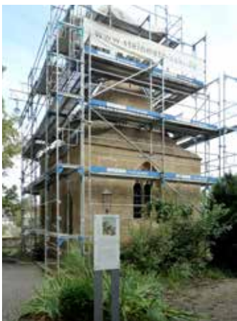
1 | denkmalgerechte Sanierung der Regiswindiskapelle
