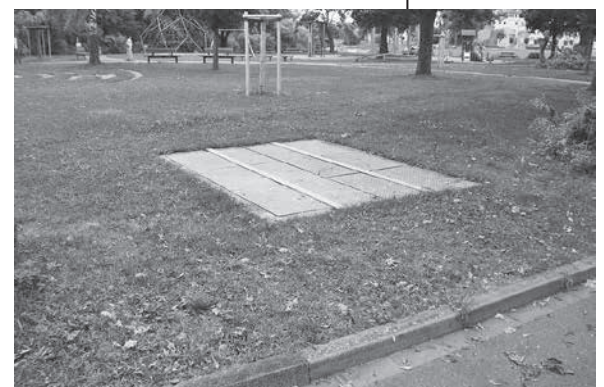
Blick auf die Abdeckung des Geröllfangs am Rückhaltebecken am Kies.
