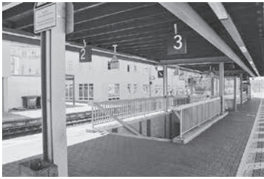
Am Mittelbahnsteig soll anstelle eines Treppenaufgangs ein Aufzug eingebaut werden.
