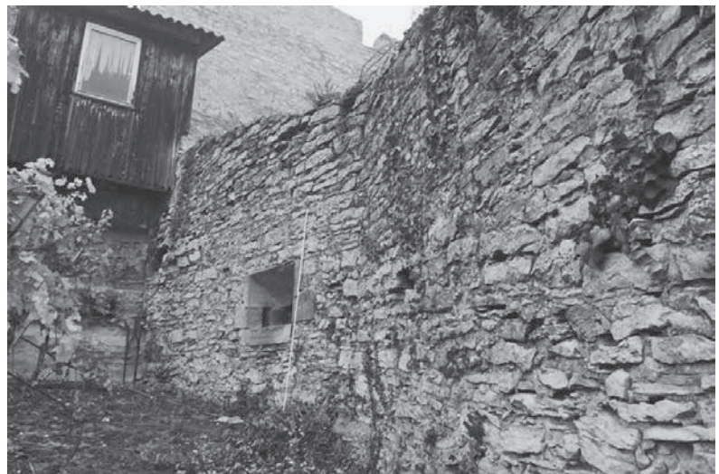
Oberer Mauerabschnitt stadteitig
