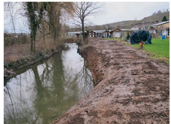
Durch die Renaturierung wird die Gewässerstruktur der Zaber im Bereich des Siedler- und Kleingärtnervereins wesentlich verbessert.
