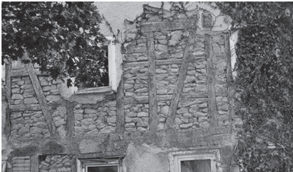
Freigelegtes Fachwerk mit verfüllten Gefachen aus Bruchsteinen.
