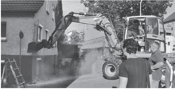
Der städtische Bagger im Einsatz. Der Putz wird entfernt, um das Fachwerk begutachten zu können (im Bild Bauhofleiter Hr. Richter, Baggerfahrer Hr. Armbruster und Markus Numberger)
