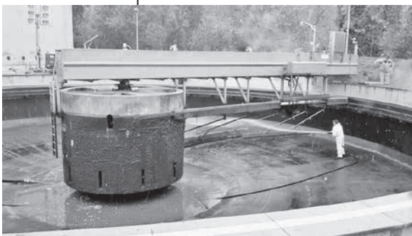
Nachklärbecken bei der Reinigung
