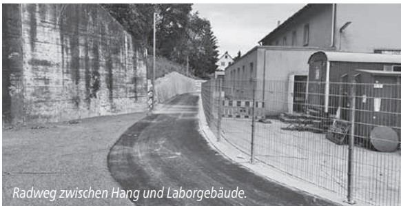
Start des Radwegs im Zementwerk an der Oskar-von-Miller-Straße.
