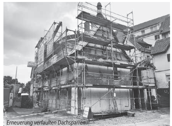
Erneuerung verfaulten Dachsparren
