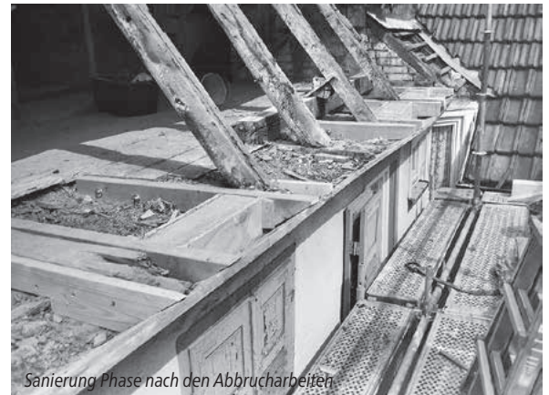
Sanierung Phase nach den Abbrucharbeiten
