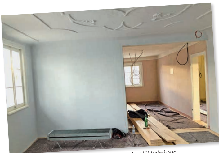
Sommerzimmer und Büros, das Dachgeschoss im Hölderlinhaus
