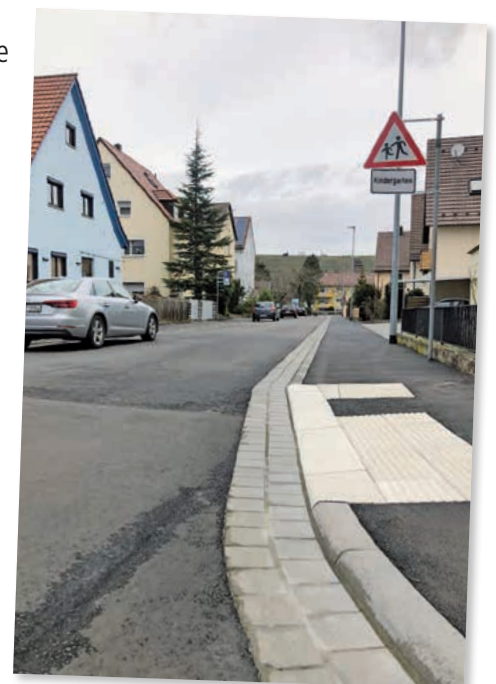
Die Herdegenstrasse wurde mit Behindertenleitsystem ausgebaut.
