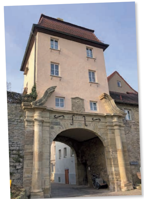
Das Neue Heilbronner Tor mit sanierter Sandsteinfassade
