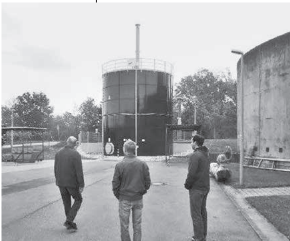
Gasbehälter mit 300 m 3 Klärgasvolumen. Abb. mit Planer und Kläranlagenbetriebsleiter Bernd Modjesch
