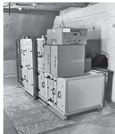
Neue Lüftungsanlagenkomponenten
