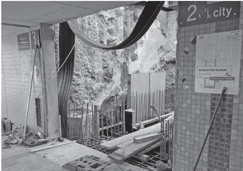
Hergestellte Baugrube für den Aufzug am Mittelbahnsteig.
