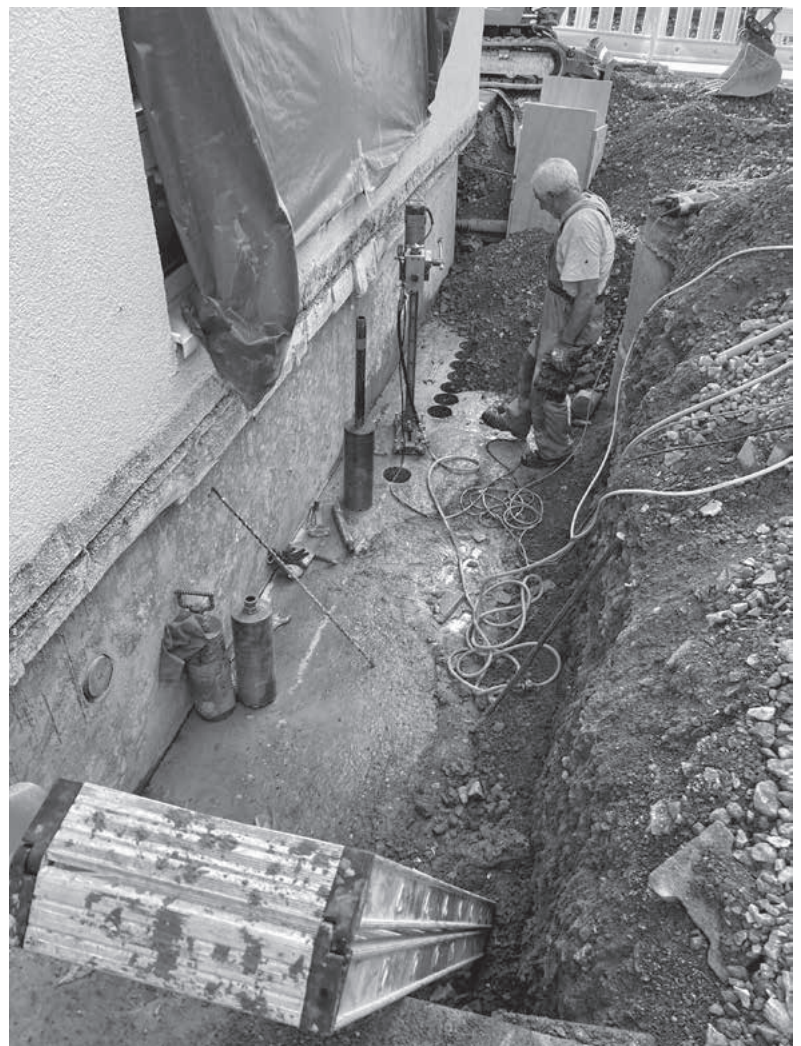
Ein unerwarteter Fundamentüberstand muss abgebohrt werden.
