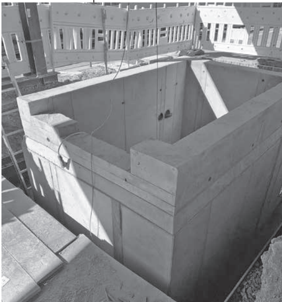
Der fertiggestellte Aufzugskern am Mittelbahnsteig im Rohbau.
