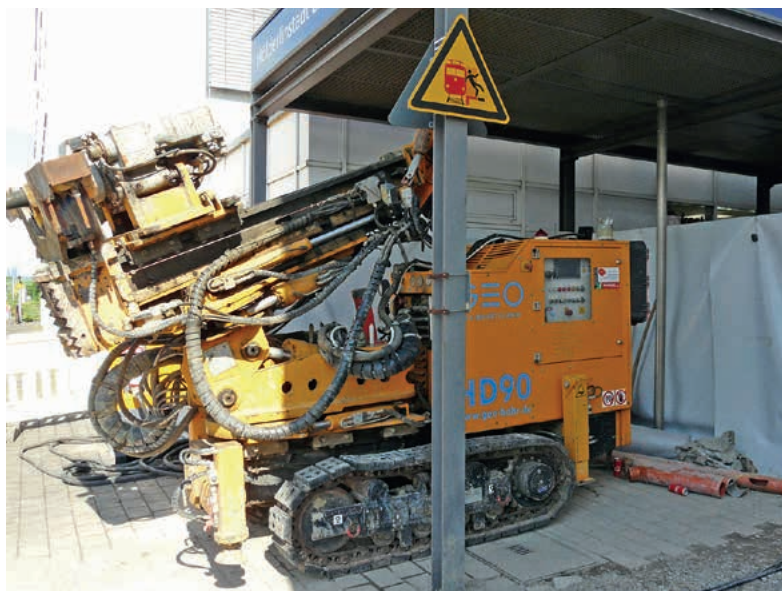
Mit diesem Bohrgerät werden die Pfähle für den Baugrubenverbau gebohrt.
