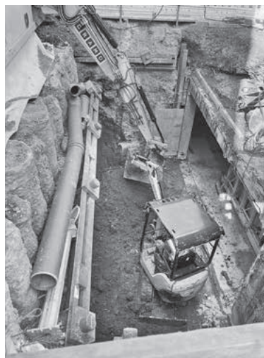
Baugrube Aufzug 1 Seitliche Öffnung der Unterführung
