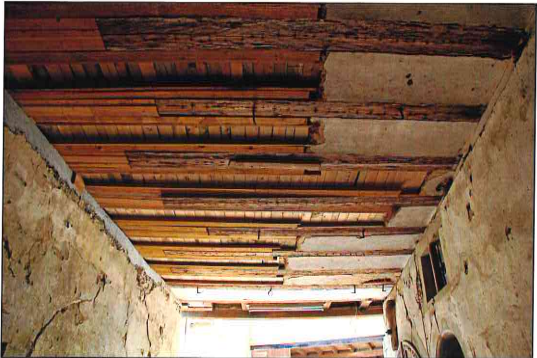
Abb. 02: Blick zur in Teilbereichen instandgesetzten Decke der Durchfahrt.
