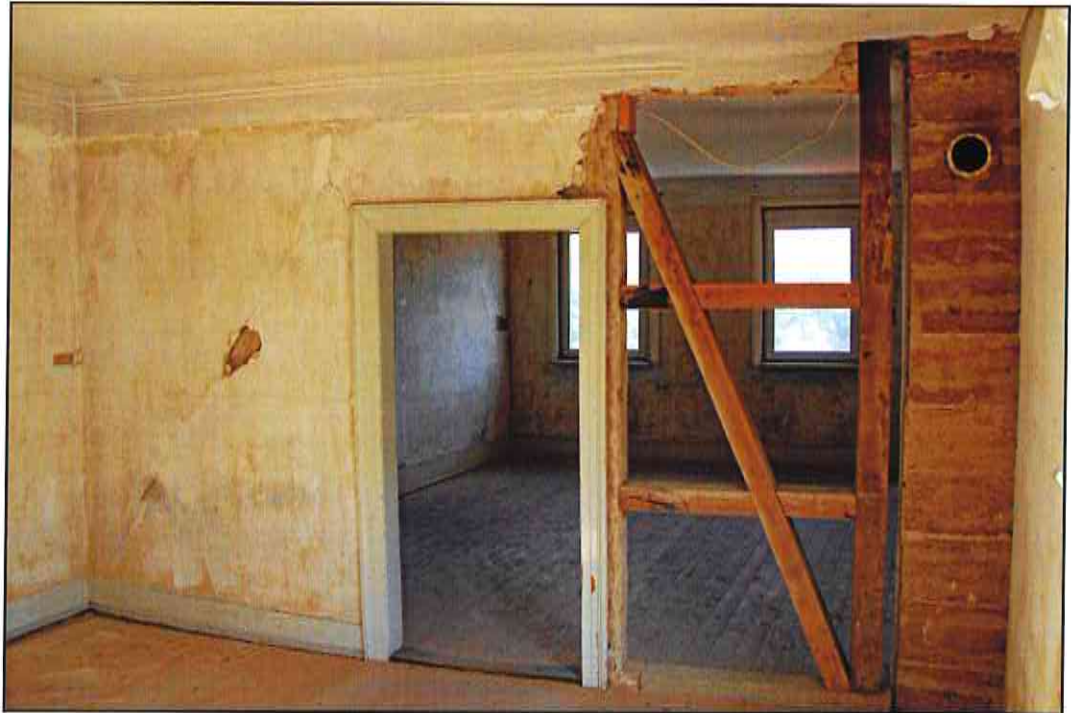
Abb. 14: Sprengwerksausbildung der Innenwand aufgrund der darunter befindlichen Durchfahrt.
