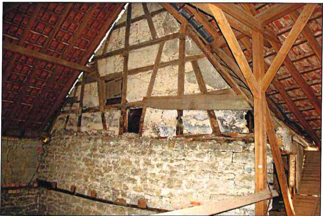
Abb. 34: Blick auf den nördlichen Fachwerkgiebel des Zwischenbaus.
