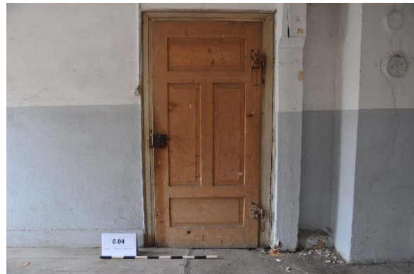
Raum 0.04d, Detailansicht der Tür zu Raum 0.02 mit Blickrichtung Westen, Foto: strebewerk. 2015 (Dateiname: R004d_Lauffen_HH_20150813)
