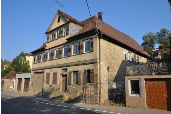
Außenfassade Süd, Diagonalaufnahme mit Blickrichtung Nordwesten, Foto: strebewerk. 2015 (Dateiname: Aussen_Lauffen_HH_20150813_13)
