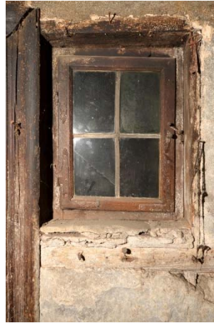
0.05, Wand d, Fenster
