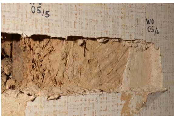
1.05, Wand a, Lehmgrundputz mit stuckartiger Deckschicht
