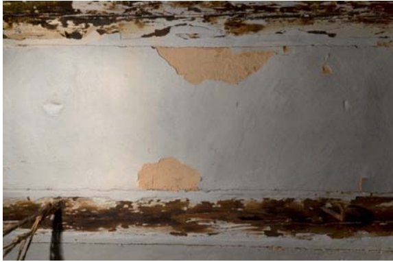
1.03, Decke, Putzfelderdecke mit getünchtem Lehmverstrich
