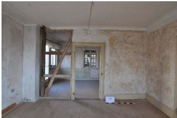
Raum 1.03a, Frontalansicht Wand a mit Blickrichtung Norden, Foto: strebewerk. 2015 (Dateiname: R103a_Lauffen_HH_20150813)
