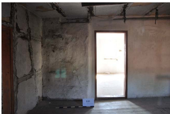
Raum 2.01c, Detailansicht der Tür zu Raum 2.04 mit Blickrichtung Süden, Foto: strebewerk. 2015 (Dateiname: R201c_Tuer_Lauffen_HH_20150813)
