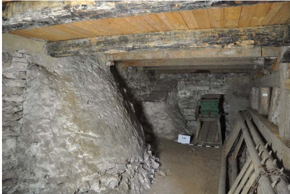
Raum 0.09ab, Diagonalaufnahme mit Blickrichtung Nordosten, Foto: strebewerk. 2015 (Dateiname: R009ab_Lauffen_HH_20150813)
