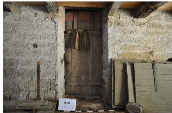
Raum 0.08c, Detailansicht der Tür zu Raum 0.06 mit Blickrichtung Süden, Foto: strebewerk. 2015 (Dateiname: R008c_tuer_Lauffen_HH_20150813)
