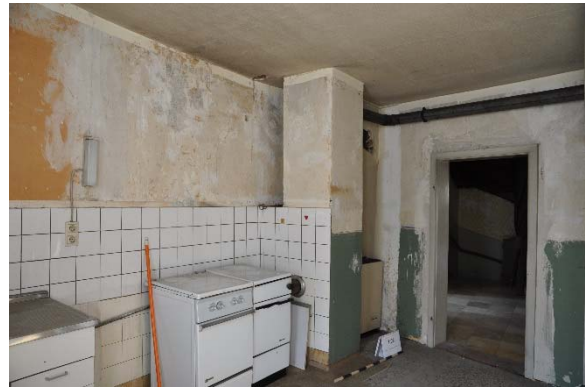
Raum 1.06cd, Diagonalaufnahme mit Blickrichtung Südwesten, Foto: strebewerk. 2015 (Dateiname: R106cd_Lauffen_HH_20150813)
