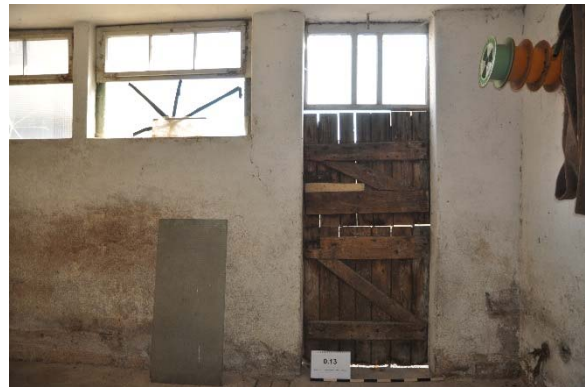
Raum 0.13c, Detailansicht der Tür zum Innenhof mit Blickrichtung Süden, Foto: strebewerk. 2015 (Dateiname: R013c_Tuer_Lauffen_HH_20150813)
