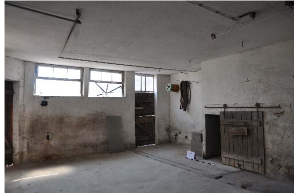
Raum 0.13cd, Diagonalaufnahme mit Blickrichtung Südwesten, Foto: strebewerk. 2015 (Dateiname: R013cd_Lauffen_HH_20150813)
