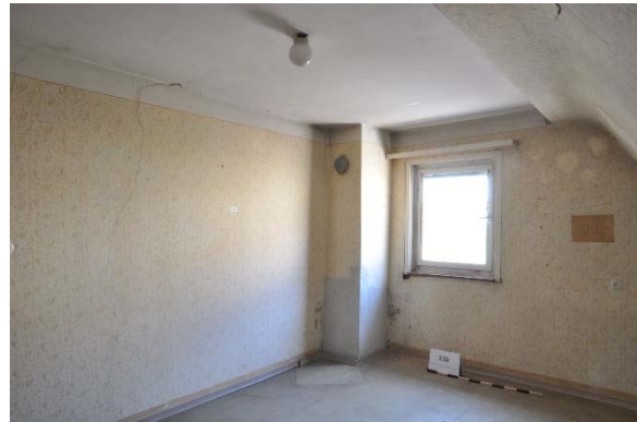
Raum 2.02cd, Diagonalaufnahme mit Blickrichtung Südwesten, Foto: strebewerk. 2015 (Dateiname: R202cd_Lauffen_HH_20150813)
