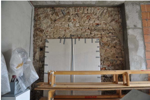
Raum 0.07b, Detailaufnahme der Wand mit Abdruck der zugesetzten Arkade, Foto: strebewerk. 2015 (Dateiname: R007b_Lauffen_HH_20151005)
