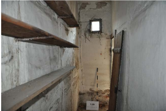
Raum 1.09abc, Diagonalaufnahme mit Blickrichtung Nordosten, Foto: strebewerk. 2015 (Dateiname: R109abc_Lauffen_HH_20150813)
