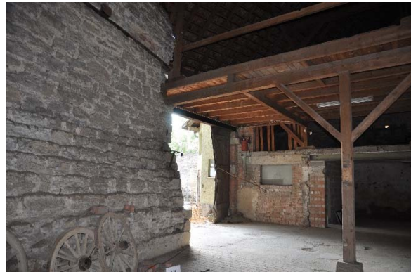
Raum 0.10cd, Diagonalaufnahme mit Blickrichtung Südwesten, Foto: strebewerk. 2015 (Dateiname: R010cd_Lauffen_HH_20150813)
