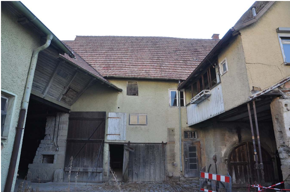
Ansicht des Innenhofs nach Osten mit historischer Scheune und Wohnhaus, Foto: strebewerk. 2015
