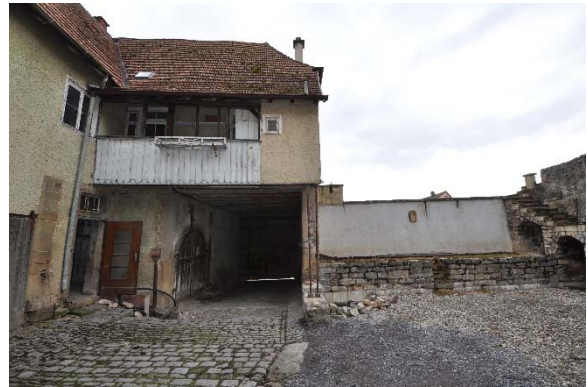
Hoffassade Südseite, Frontalaufnahme mit Blickrichtung Süden, Foto: strebewerk. 2015 (Dateiname: Hof_c_Lauffen_HH_20151005)
