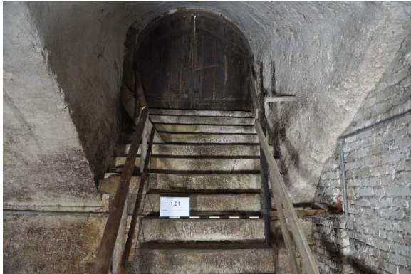
Raum -1.01d, Detailansicht des Tors zum Kellerhals und der rundbogigen Tür mit Blickrichtung Westen, Foto: strebewerk. 2015 (Dateiname: R-101d_Kellerhals_geschlossen_Lauffen_HH_20150813)
