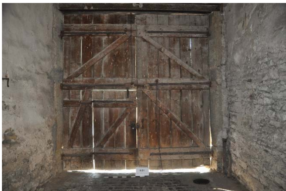
Raum 0.01c, Ansicht des Tors mit Blickrichtung Süden, Foto: strebewerk. 2015 (Dateiname: R001c_Lauffen_HH_20150813_1)
