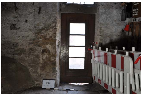
Raum 0.06d, Detailansicht der Tür zum Innenhof mit Blickrichtung Westen, Foto: strebewerk. 2015 (Dateiname: R006d_Tuer_Lauffen_HH_20150813)
