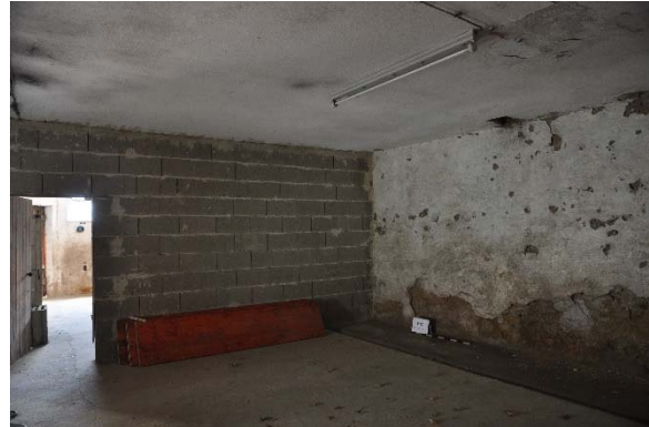
Raum 0.12cd, Diagonalaufnahme mit Blickrichtung Südwesten, Foto: strebewerk. 2015 (Dateiname: R012cd_Lauffen_HH_20150813)
