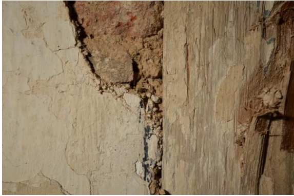
1.01, Wand c, Fachwerk mit grauer Begleiterfassung
