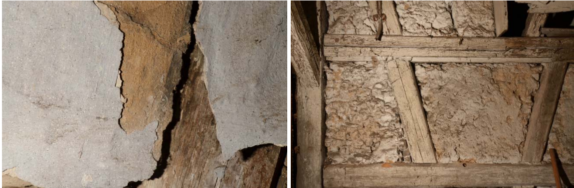
2.01, Wand b, Fachwerkwand mit grauer Begleiterfassung
