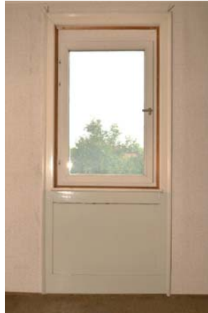
1.05, Wand c, Fensterrahmen mit Brüstungsfeld
