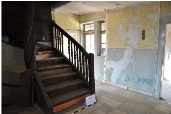
Raum 1.01da, Diagonalaufnahme mit Blickrichtung Nordwesten, Foto: strebewerk. 2015 (Dateiname: R101da_Lauffen_HH_20150813)
