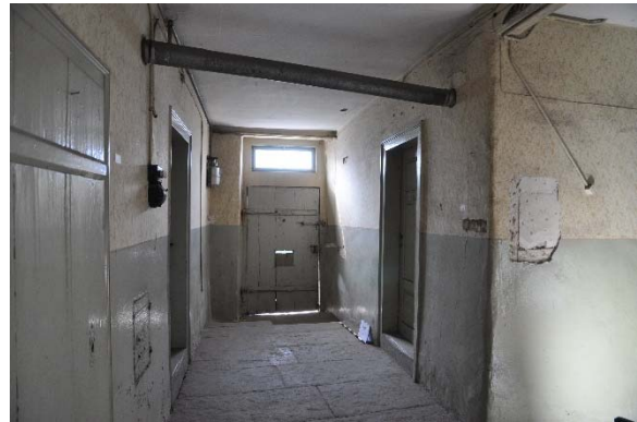
Raum 0.02cd, Diagonalaufnahme mit Blickrichtung Südwesten, Foto: strebewerk. 2015 (Dateiname: R002cd_Lauffen_HH_20150813)
