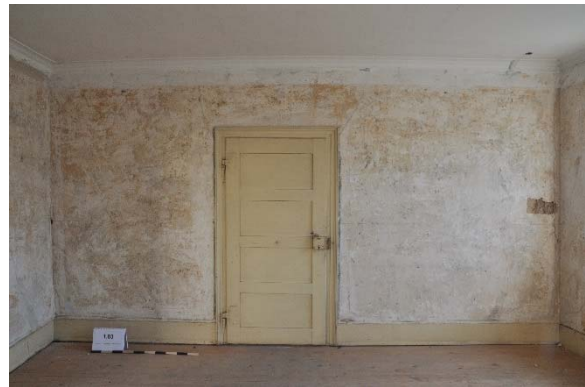
Raum 1.03b, Frontalansicht Wand b mit Blickrichtung Osten, Foto: strebewerk. 2015 (Dateiname: R103b_Lauffen_HH_20150813)
