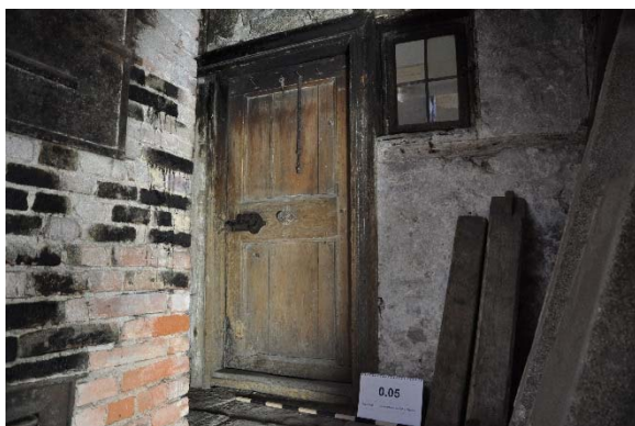
Raum 0.05d, Detailansicht der Tür zu Raum 0.02 mit Blickrichtung Westen, Foto: strebewerk. 2015 (Dateiname: R005d_Lauffen_HH_20150813)
