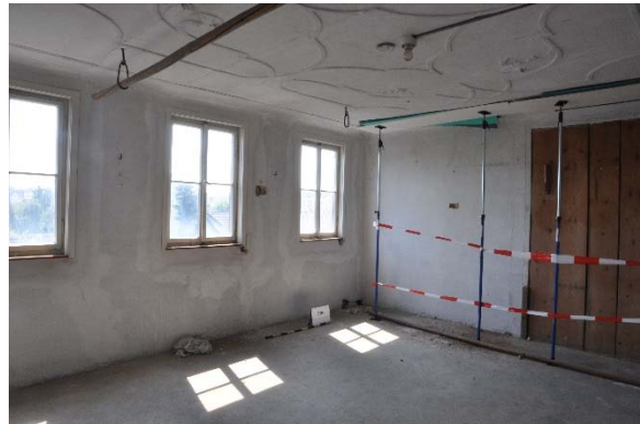
Raum 2.04cd, Diagonalaufnahme mit Blickrichtung Südwesten, Foto: strebewerk. 2015 (Dateiname: R204cd_Lauffen_HH_20150813)
