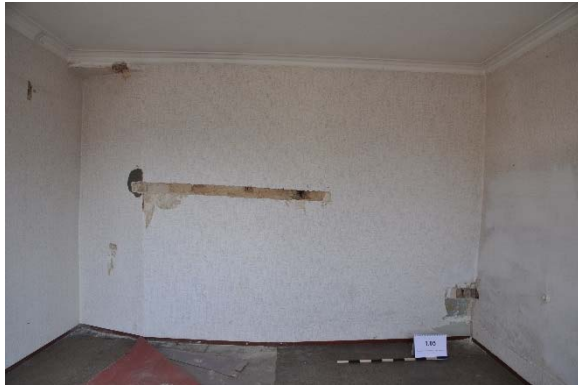
Raum 1.05a, Frontalansicht Wand a mit Blickrichtung Süden, Foto: strebewerk. 2015 (Dateiname: R105a_Lauffen_HH_20150813)
