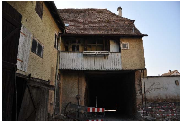
Hoffassade Südseite, Frontalaufnahme mit Blickrichtung Süden, Foto: strebewerk. 2015 (Dateiname: Aus-sen_Lauffen_HH_20150813_23)
