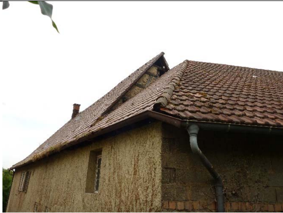
Außenfassade Nordostecke, Diagonalaufnahme mit Blickrichtung Südwesten, Foto: strebewerk. 2015 (Dateiname: Aussen_Lauffen_HH_2015_25)
