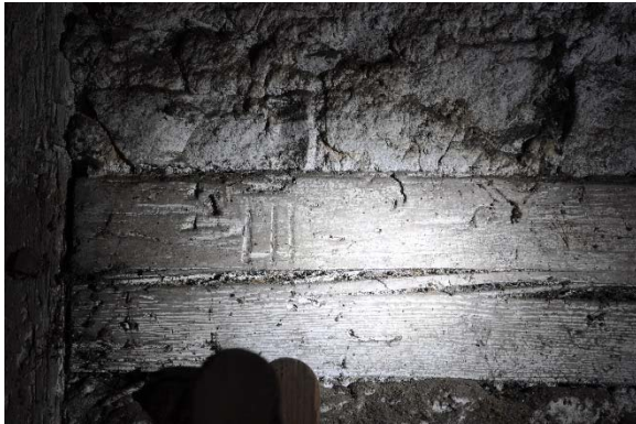
Raum 2.05a, Detailansicht der Abbundzeichen an Wand a mit Blickrichtung Norden, Foto: strebewerk. 2015 (Dateiname: R205a_Abbundzeichen_Lauffen_HH_20150813)
