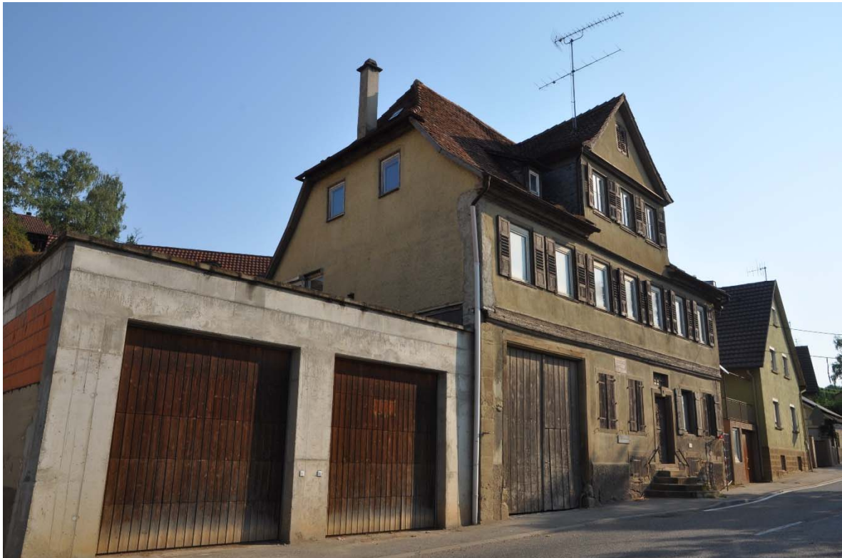
Ansicht von Südwesten, Foto: strebewerk. 2015
