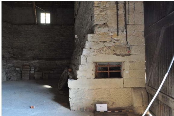
Raum 0.11ab, Detailansicht des Kellerfensters zu Raum -1.02 mit Blickrichtung Osten, Foto: strebewerk. 2015 (Dateiname: R011b_Fenster_Lauffen_HH_20150813)
