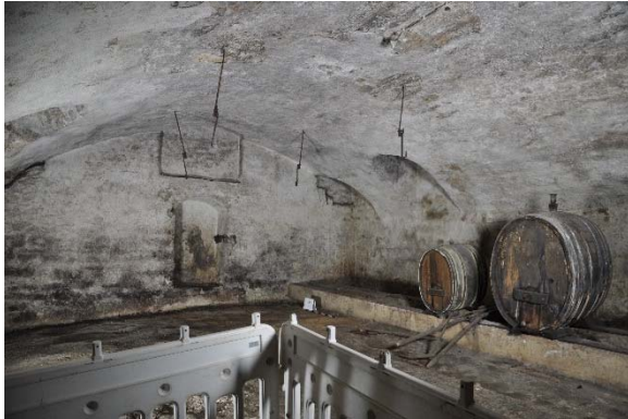
Raum -1.02ab, Diagonalaufnahme mit Blickrichtung Nordosten, Foto: strebewerk. 2015 (Dateiname: R-102ab_Lauffen_HH_20150813)
