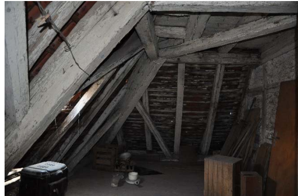
Raum 2.05c, Frontalansicht Dachuntersicht c mit Blickrichtung Süden, Foto: strebewerk. 2015 (Dateiname: R205c_Lauffen_HH_20150813)
