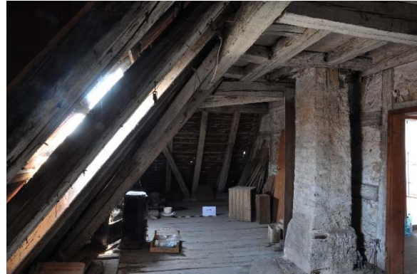
Raum 2.05cd, Diagonalaufnahme mit Blickrichtung Südwesten, Foto: strebewerk. 2015 (Dateiname: R205cd_Lauffen_HH_20150813)
