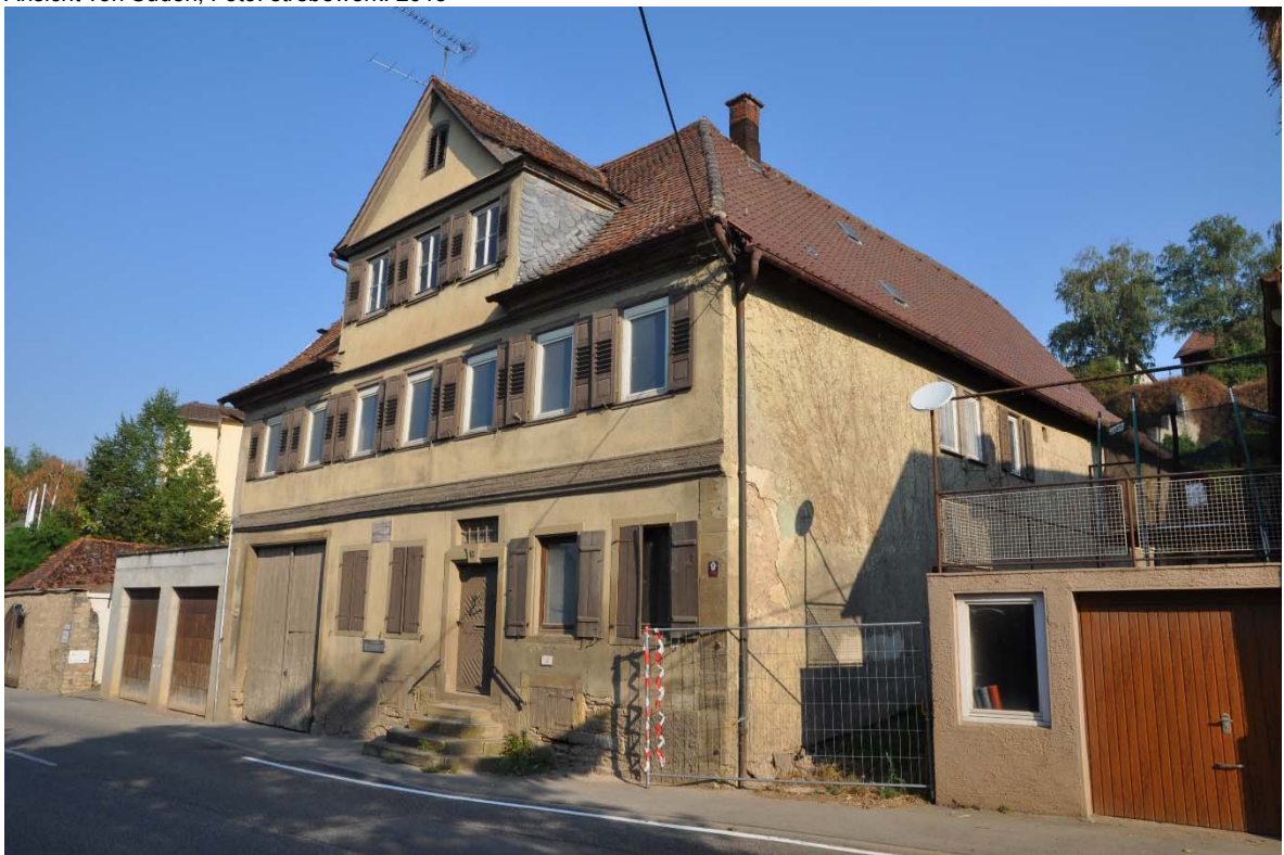
Ansicht von Südosten, Foto: strebewerk. 2015
