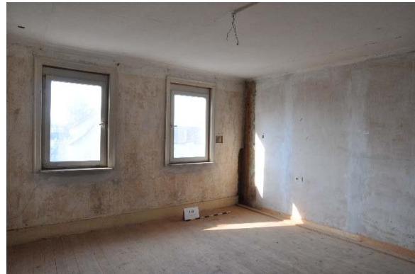
Raum 1.03cd, Diagonalaufnahme mit Blickrichtung Südwesten, Foto: strebewerk. 2015 (Dateiname: R103cd_Lauffen_HH_20150813)
