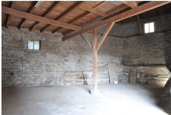
Raum 0.10ab, Diagonalaufnahme mit Blickrichtung Nordosten, Foto: strebewerk. 2015 (Dateiname: R010ab_Lauffen_HH_20150813)
