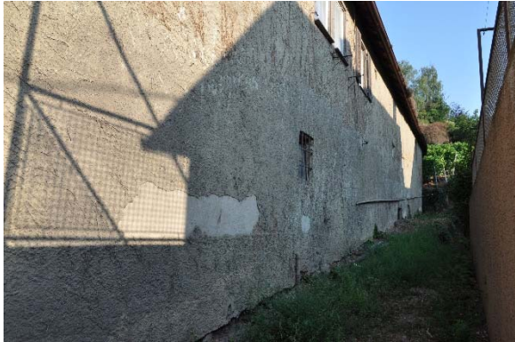
Außenfassade Ost, Diagonalaufnahme mit Blickrichtung Nordwesten, Foto: strebewerk. 2015 (Dateiname: Aussen_Lauffen_HH_20150813_10)
