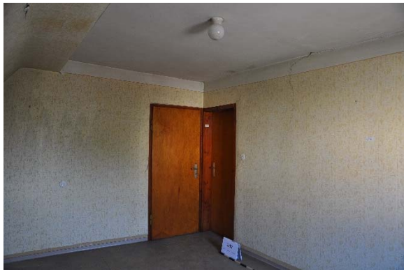
Raum 2.02bc, Diagonalaufnahme mit Blickrichtung Südosten, Foto: strebewerk. 2015 (Dateiname: R202bc_Lauffen_HH_20150813)
