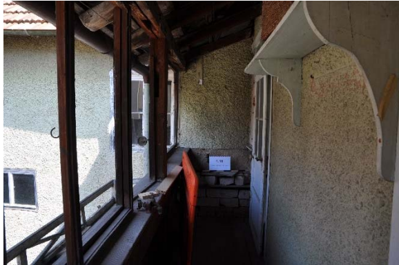
Raum 1.11abc, Diagonalaufnahme mit Blickrichtung Nordosten, Foto: strebewerk. 2015 (Dateiname: R111abc_Lauffen_HH_20150813)
