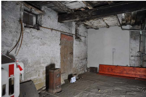
Raum 0.06ab, Diagonalaufnahme mit Blickrichtung Nordosten, Foto: strebewerk. 2015 (Dateiname: R006ab_Lauffen_HH_20150813)
