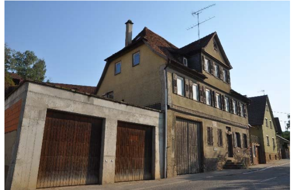
Außenfassade Süd, Diagonalaufnahme mit Blickrichtung Nordosten, Foto: strebewerk. 2015 (Dateiname: Aussen_Lauffen_HH_20150813_12)
