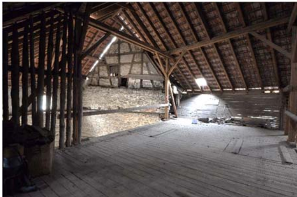
Raum 2.06bc, Diagonalaufnahme mit Blickrichtung Südosten, Foto: strebewerk. 2015 (Dateiname: R207bc_Lauffen_HH_20151005)
