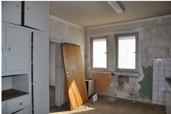
Raum 1.06ab, Diagonalaufnahme mit Blickrichtung Nordosten, Foto: strebewerk. 2015 (Dateiname: R106ab_Lauffen_HH_20150813)
