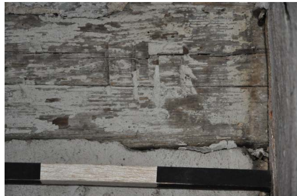
Raum 2.01b, Detailansicht der Abbundzeichen an Wand b mit Blickrichtung Osten, Foto: strebewerk. 2015 (Dateiname: R201b_Abbundzeichen_Lauffen_HH_20150813)
