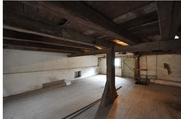
Raum 1.13cd, Diagonalaufnahme mit Blickrichtung Südwesten, Foto: strebewerk. 2015 (Dateiname: R113cd_Lauffen_HH_20151005)
