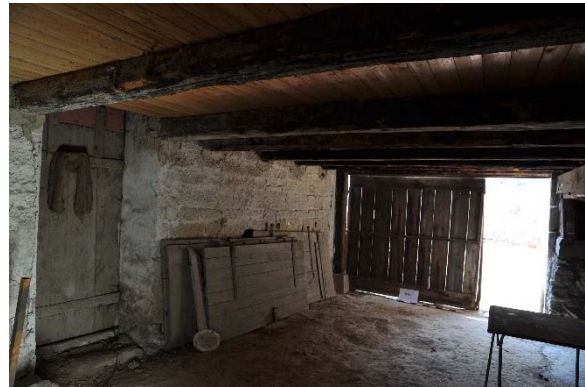
Raum 0.08cd, Diagonalaufnahme mit Blickrichtung Südwesten, Foto: strebewerk. 2015 (Dateiname: R008cd_Lauffen_HH_20150813)
