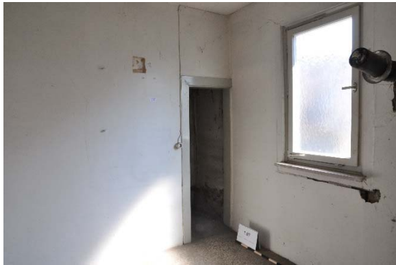
Raum 1.07ab, Diagonalaufnahme mit Blickrichtung Nordosten, Foto: strebewerk. 2015 (Dateiname: R107ab_Lauffen_HH_20150813)
