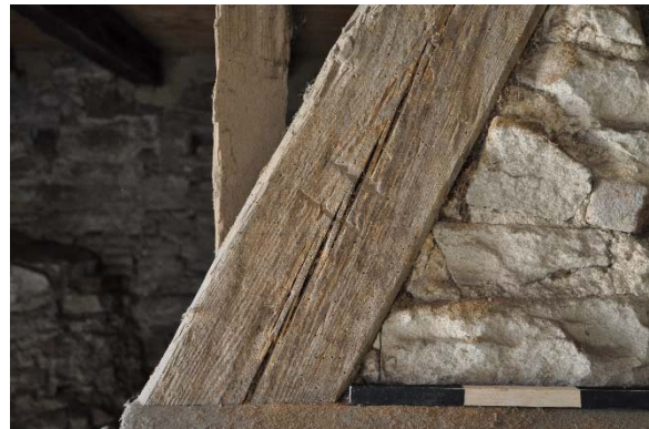
Raum 0.08a, Detailansicht der Abbundzeichen an Wand a mit Blickrichtung Norden, Foto: strebewerk. 2015 (Dateiname: R008a_Abbundzeichen_Lauffen_HH_20150813)
