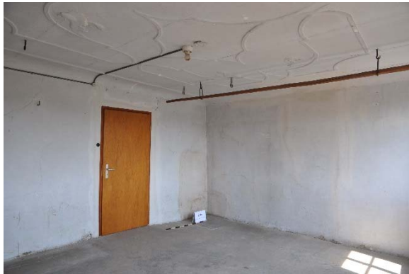
Raum 2.04ab, Diagonalaufnahme mit Blickrichtung Nordosten, Foto: strebewerk. 2015 (Dateiname: R204ab_Lauffen_HH_20150813)
