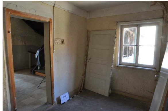
Raum 1.10cd, Diagonalaufnahme mit Blickrichtung Südwesten, Foto: strebewerk. 2015 (Dateiname: R110cd_Lauffen_HH_20150813)
