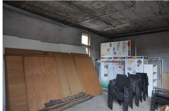
Raum 0.07ca, Diagonalaufnahme mit Blickrichtung Nordwesten, Foto: strebewerk. 2015 (Dateiname: R007ca_Lauffen_HH_20151005)
