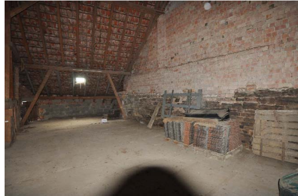
Raum 1.14cd, Diagonalaufnahme mit Blickrichtung Südwesten, Foto: strebewerk. 2015 (Dateiname: R114cd_Lauffen_HH_20151005)
