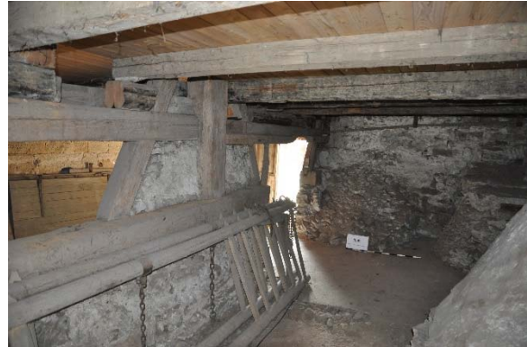
Raum 0.09cd, Diagonalaufnahme mit Blickrichtung Südwesten, Foto: strebewerk. 2015 (Dateiname: R009cd_Lauffen_HH_20150813)
