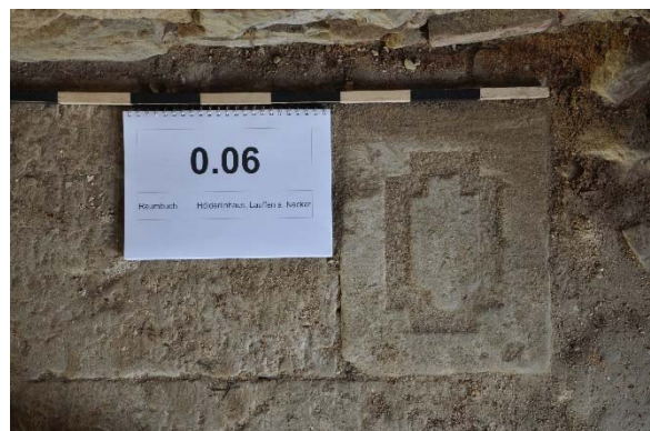
Raum 0.06c, Detailansicht des Bodenbelags an Wand c, Foto: strebewerk. 2015 (Dateiname: R006_Boden_Lauffen_HH_20150813)
