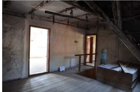
Raum 2.01cd, Diagonalaufnahme mit Blickrichtung Südwesten, Foto: strebewerk. 2015 (Dateiname: R201cd_Lauffen_HH_20150813)
