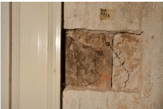
1.03, Wand b: Türbekleidung, Flächenverputzung mit Armierung
