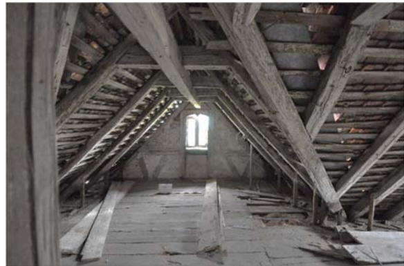
Raum 3.01c, Ansicht der Zwerchgaube mit Blickrichtung Süden, Foto: strebewerk. 2015 (Dateiname: R301c_Lauffen_HH_20151005)
