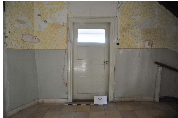
Raum 1.01c, Detailansicht der Tür zu Raum 1.04 mit Blickrichtung Süden, Foto: strebewerk. 2015 (Dateiname: R101c_Lauffen_HH_20150813)
