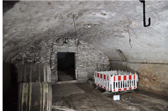
Raum -1.02cd, Diagonalaufnahme mit Blickrichtung Südwesten, Foto: strebewerk. 2015 (Dateiname: R-102cd_Lauffen_HH_20150813)
