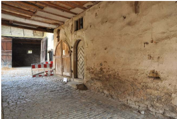
Raum 0.01ab, Diagonalaufnahme mit Blickrichtung Nordosten, Foto: strebewerk. 2015 (Dateiname: R001ab_Lauffen_HH_20150813)
