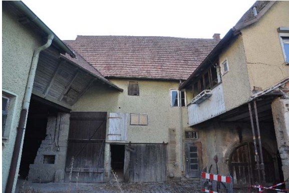
Hoffassade Ostseite, Frontalaufnahme mit Blickrichtung Osten, Foto: strebewerk. 2015 (Dateiname: Aus-sen_Lauffen_HH_20150813_17)
