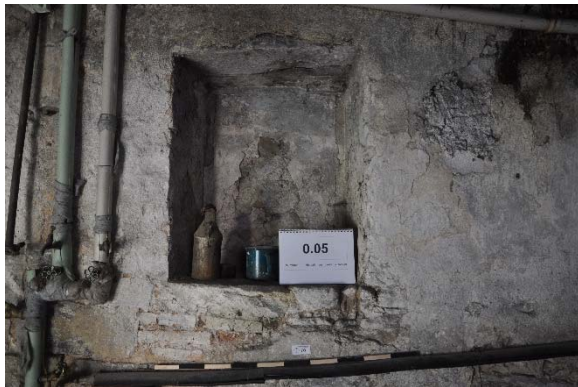
Raum 0.05b, Detailansicht der Nische in Wand b mit Blickrichtung Osten, Foto: strebewerk. 2015 (Dateiname: R005b_Nische_Lauffen_HH_20150813)
