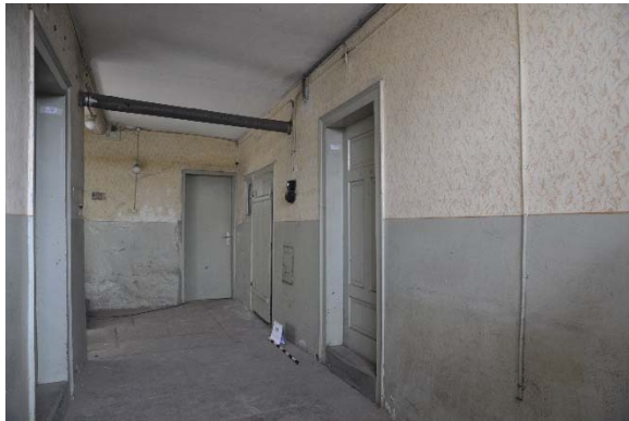
Raum 0.02ab, Diagonalaufnahme mit Blickrichtung Nordosten, Foto: strebewerk. 2015 (Dateiname: R002ab_Lauffen_HH_20150813)
