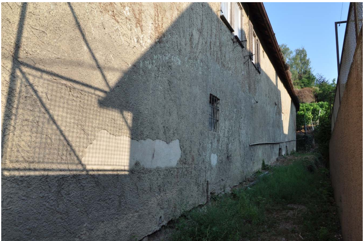
Ansicht der Ostwand von Südosten, Foto: strebewerk. 2015
