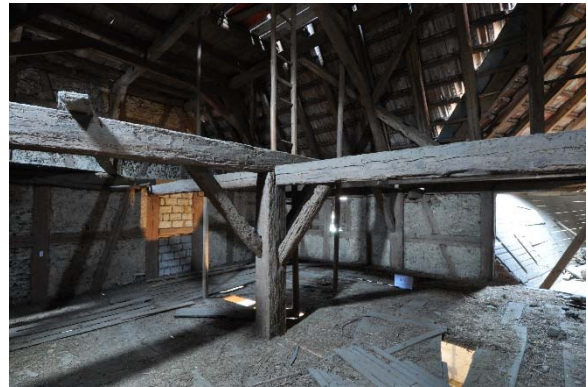
Raum 2.06cd, Diagonalaufnahme mit Blickrichtung Südwesten, Foto: strebewerk. 2015 (Dateiname: R206cd_Lauffen_HH_20151005)
