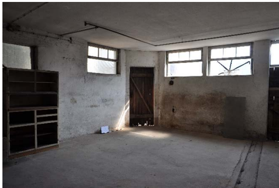
Raum 0.13bc, Diagonalaufnahme mit Blickrichtung Südosten, Foto: strebewerk. 2015 (Dateiname: R013bc_Lauffen_HH_20150813)
