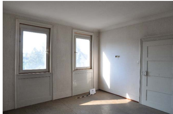
Raum 1.05cd, Diagonalaufnahme mit Blickrichtung Südwesten, Foto: strebewerk. 2015 (Dateiname: )
