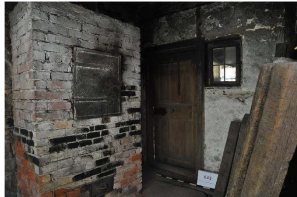
Raum 0.05cd, Diagonalaufnahme mit Blickrichtung Südwesten, Foto: strebewerk. 2015 (Dateiname: R005cd_Lauffen_HH_20150813)
