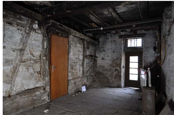
Raum 0.06cd, Diagonalaufnahme mit Blickrichtung Südwesten, Foto: strebewerk. 2015 (Dateiname: R006cd_Lauffen_HH_20150813_1)
