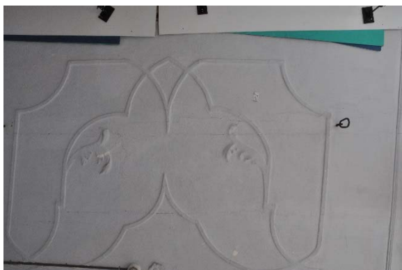
Raum 2.04d, Detailansicht der Stuckdecke im Bereich West, Foto: strebewerk. 2015 (Dateiname: R204d_DeckeWestteil_Lauffen_HH_20150813)
