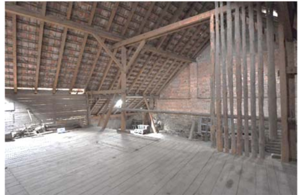
Raum 2.07cd, Diagonalaufnahme mit Blickrichtung Südwesten, Foto: strebewerk. 2015 (Dateiname: R207cd_Lauffen_HH_20151005)
