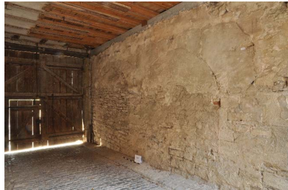
Raum 0.01cd, Diagonalaufnahme mit Blickrichtung Südwesten, Foto: strebewerk. 2015 (Dateiname: R001cd_Lauffen_HH_20150813)
