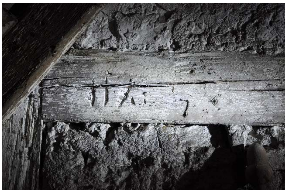
Raum 2.05d, Detailansicht der Abbundzeichen an Wand d mit Blickrichtung Westen, Foto: strebewerk. 2015 (Dateiname: R205d_Abbundzeichen_Lauffen_HH_20150813)
