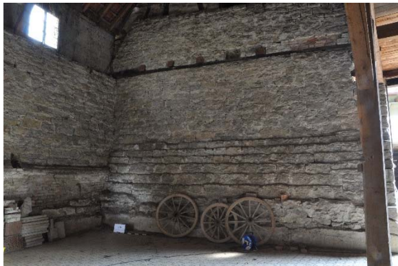
Raum 0.10bc, Diagonalaufnahme mit Blickrichtung Südosten, Foto: strebewerk. 2015 (Dateiname: R010bc_untererTeil_Lauffen_HH_20150813)
