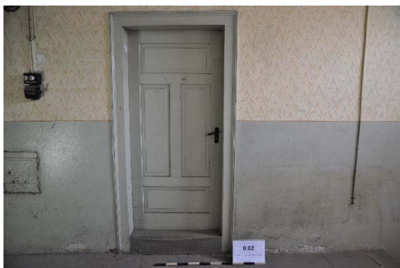
Raum 0.02b, Detailansicht der südlichen Tür der Ostwand zu Raum 0.04 mit Blickrichtung Osten, Foto: strebewerk. 2015 (Dateiname: R002b_Tuer2_Lauffen_HH_20150813)
