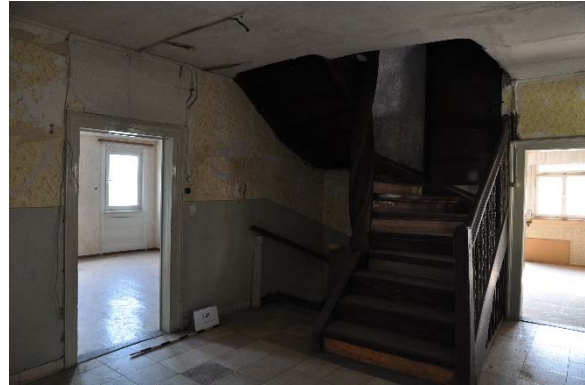
Raum 1.01cd, Diagonalaufnahme mit Blickrichtung Südwesten, Foto: strebewerk. 2015 (Dateiname: R101cd_Lauffen_HH_20150813)
