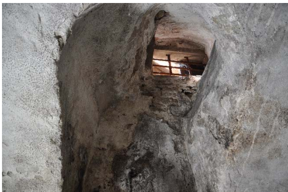
Raum -1.02d, Detailansicht des nördlichen Lichtschachts an Wand d mit Blickrichtung Westen, R-102d_Lichtschacht2_Lauffen_HH_20150813
