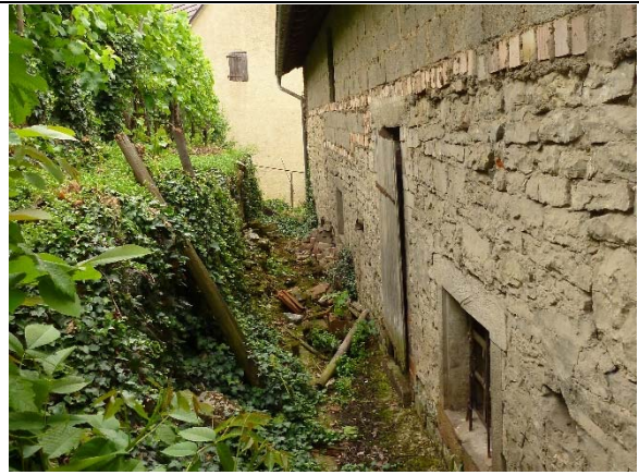
Außenfassade Nord, Diagonalaufnahme mit Blickrichtung Osten, Foto: strebewerk. 2015 (Dateiname: Aussen_Lauffen_HH_2015_26)
