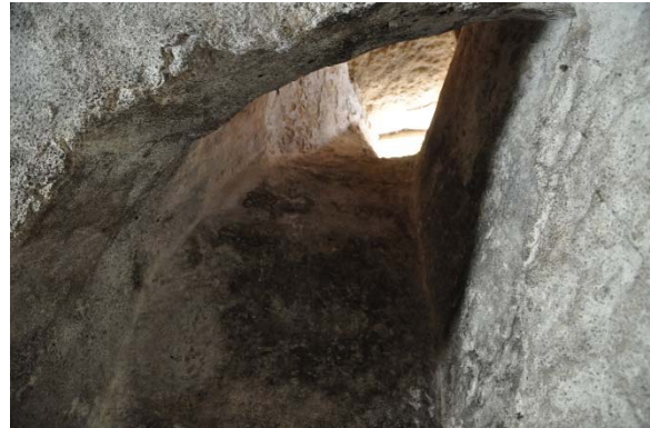
Raum -1.02d, Detailansicht des südlichen Lichtschachts an Wand d mit Blickrichtung Westen, Foto: strebewerk. 2015 (Dateiname: R-102d_Lichtschacht1_Lauffen_HH_20150813)
