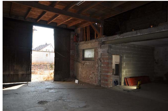
Raum 0.11cd, Diagonalaufnahme mit Blickrichtung Südwesten, Foto: strebewerk. 2015 (Dateiname: R011cd_Lauffen_HH_20150813)
