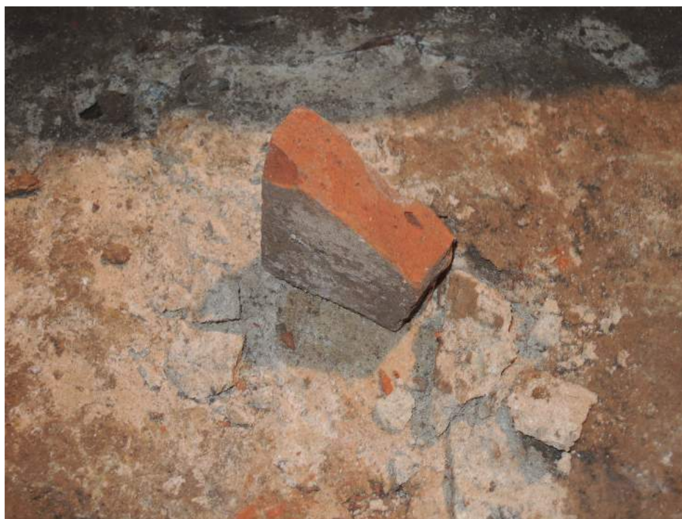
S 2, Mauerwerk, Detail Frgm. ehem. Fußbodenfliese im Mauerwerk.
