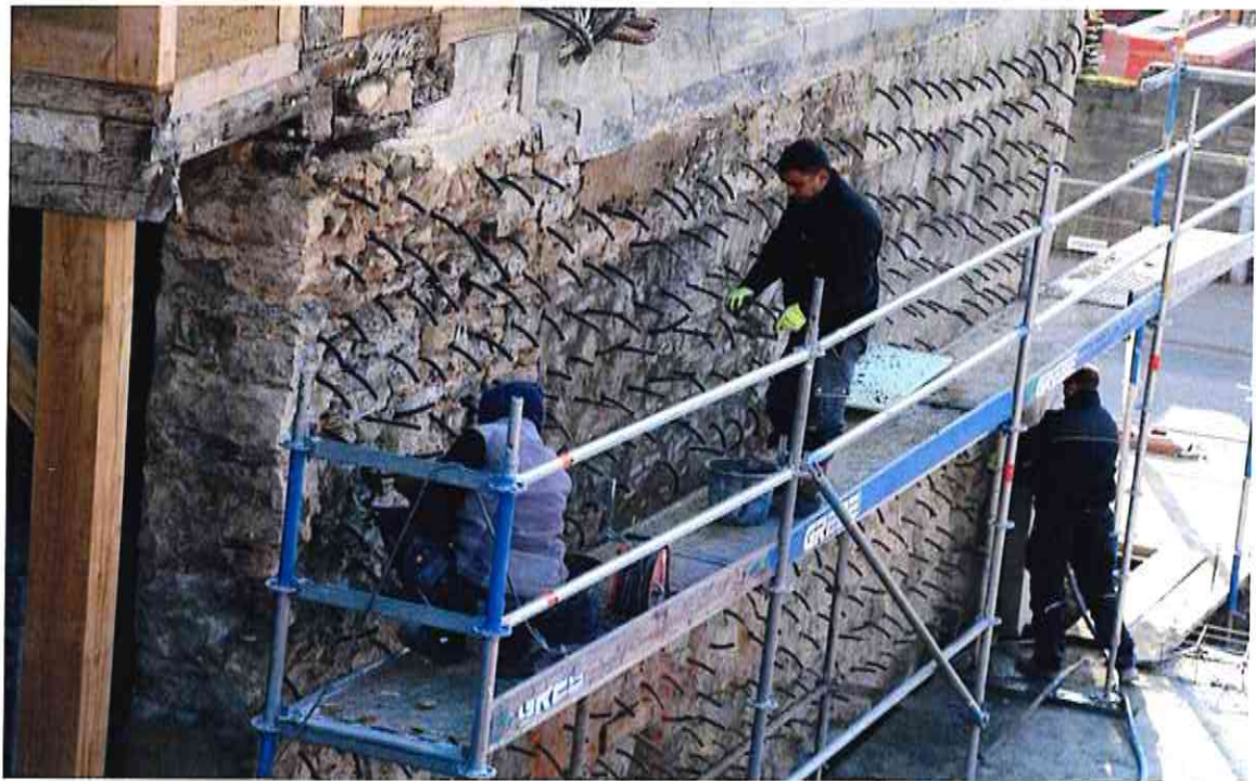
Setzen von Mörtelpacker, das Mauerwerk dünnwandig ist, wurde ein enges Raster gewählt
