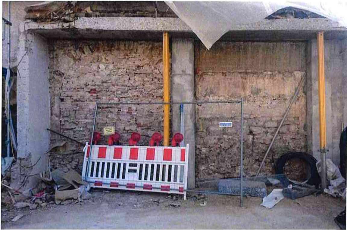
Spontane Stabilisierung der Westwand vor dem Aufstellen des Baukrans
