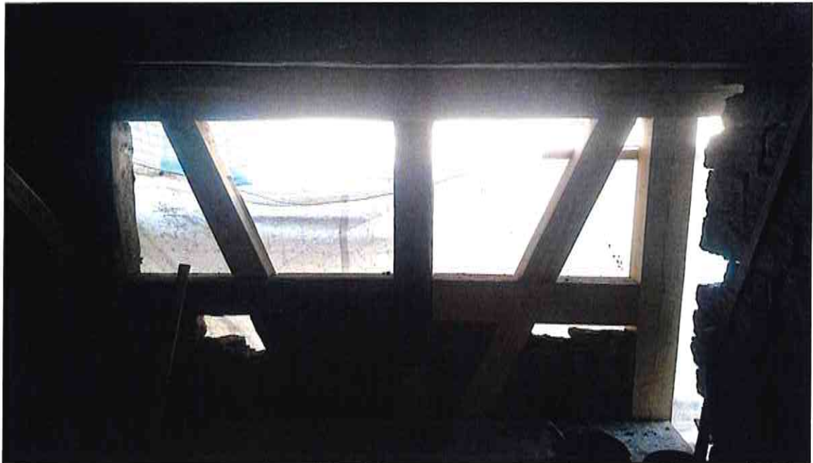
Ergänzen von abgängigen Gefachen. Lose und geschädigte Gefache wurden beladssen.
