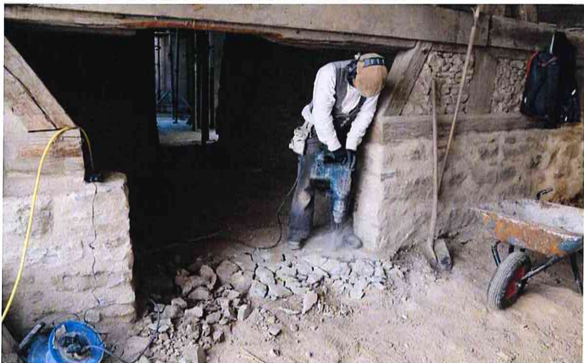
Ausbau der Bodenplatte nach dem Instandsetzen der umgebenden Mauern
