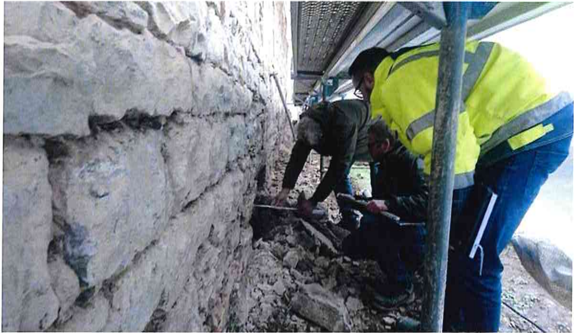
Lose Maueraußenschale im erdnahen Bereich mit Sanierungs-Skizze
