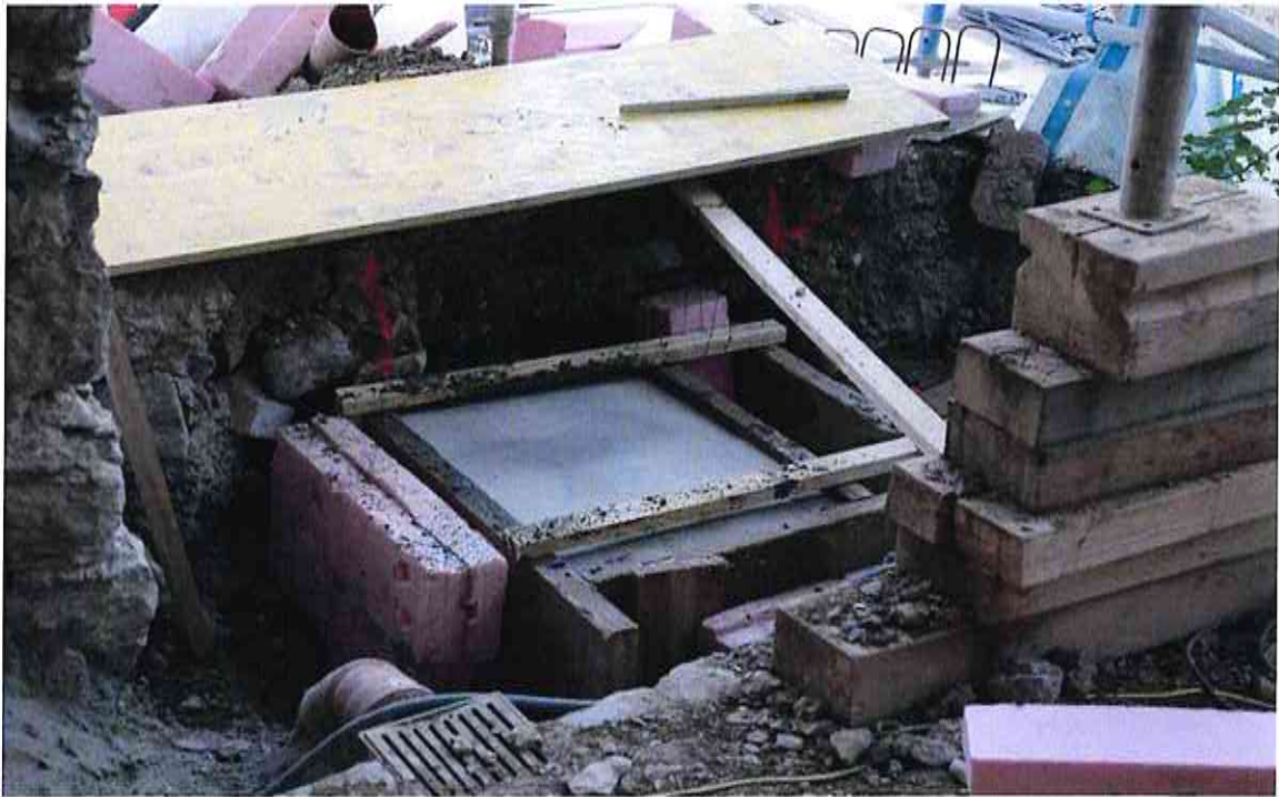
Einbau des neuen Betonfundament für den Hofbalkon
