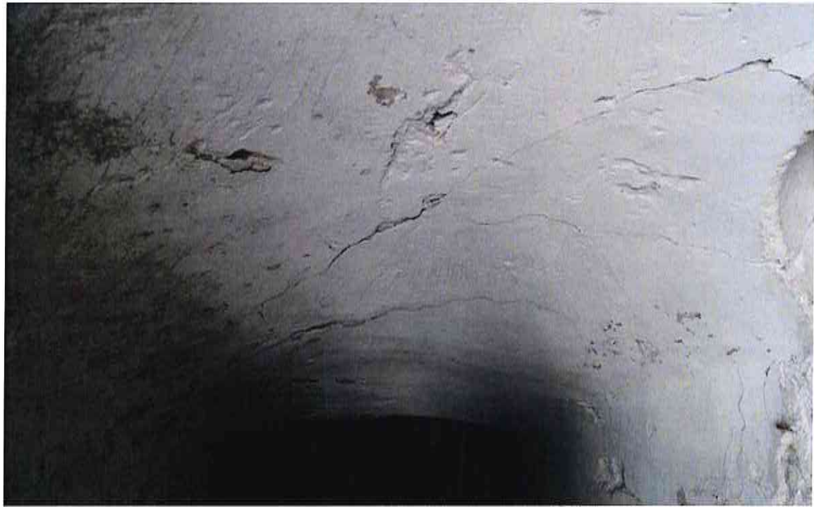
Sanierung der Deckenrisse im Kellerabgang auf provisorischem Gerüst.
