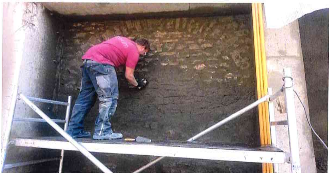
Herstellen von steinsichtigem Mauerwerk
