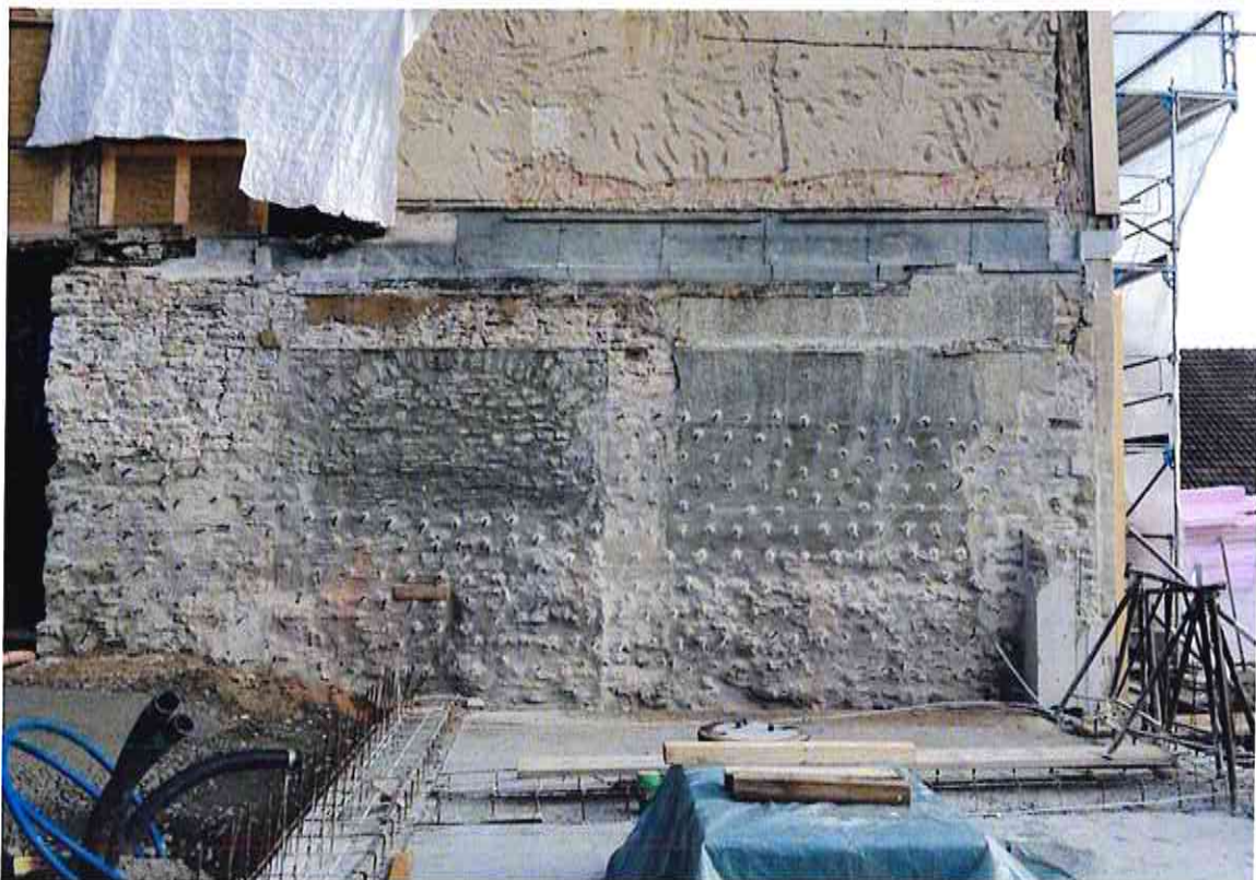
Setzen von Mörtelpacker
