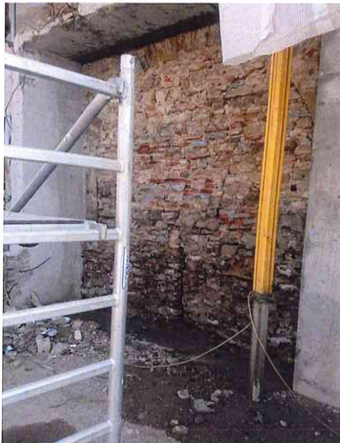
Spontane Stabilisierung der Westwand vor dem Aufstellen des Baukrans
