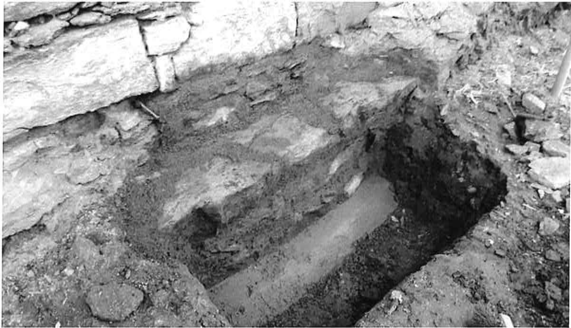
Muster der Mauerwerkssanierung und die fertige Leistung
