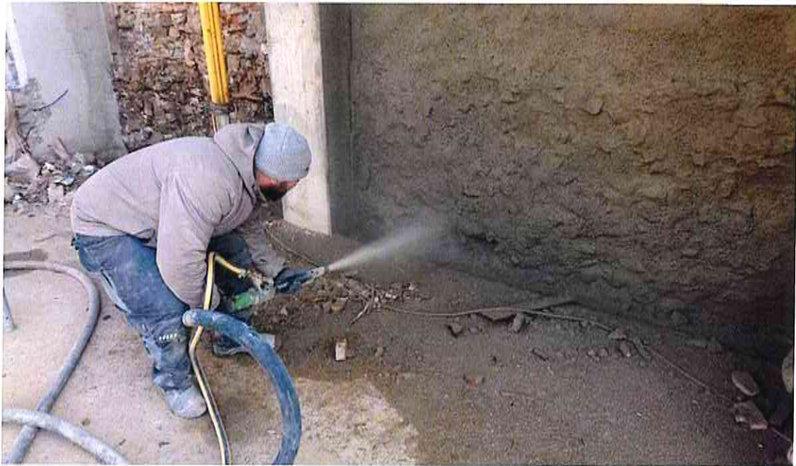
Verfüllen der Fugen und Hohlstellen im Trockenspritzverfahren mit Trasskalkmörtel Hasit 970 M5
