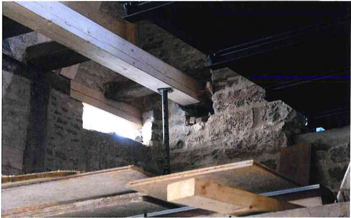
Ausbrechen des neu aufgemauerten Mauerwerk zum Einbinden des Balkens.
