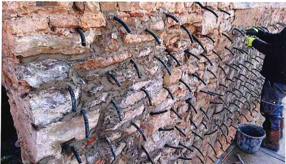
Setzen von Mörtelpacker, das Mauerwerk dünnwandig ist, wurde ein enges Raster gewählt
