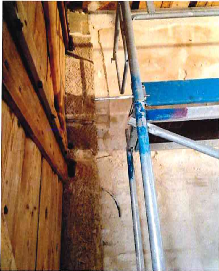
Setzen von Mörtelpacker
