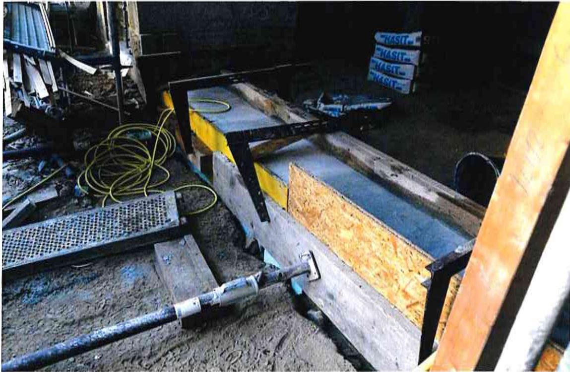
Betonschwelle Scheune EG
