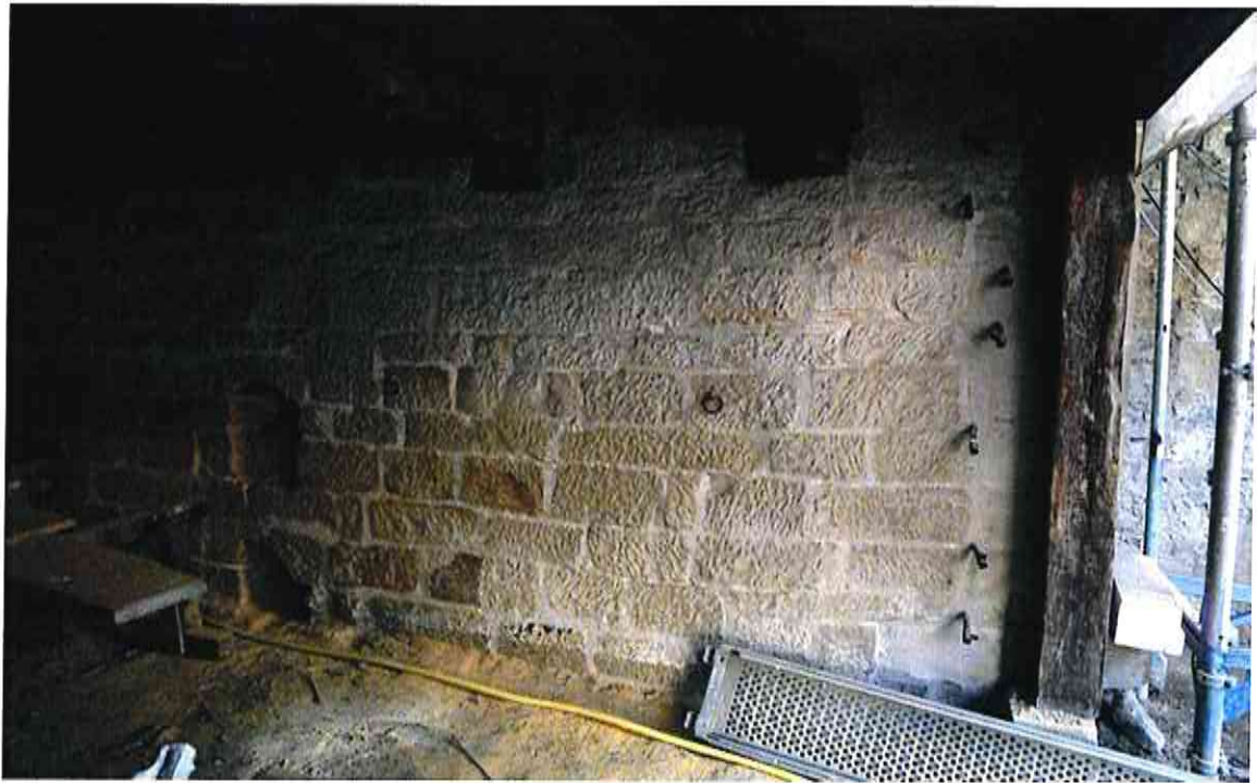
Verfüllen des Mauerwerkabriss zur Außenfassade
