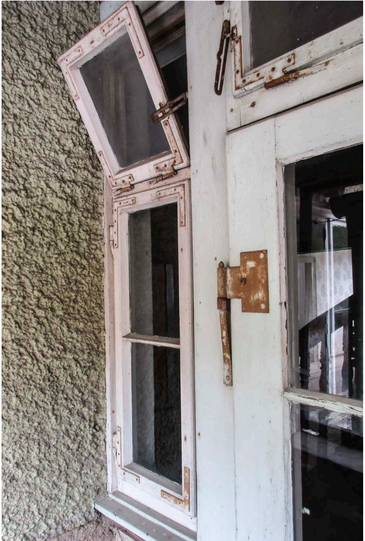
19- T1.11.1 Balkontür- fensterelement 5.07.2018 IMG_7334
