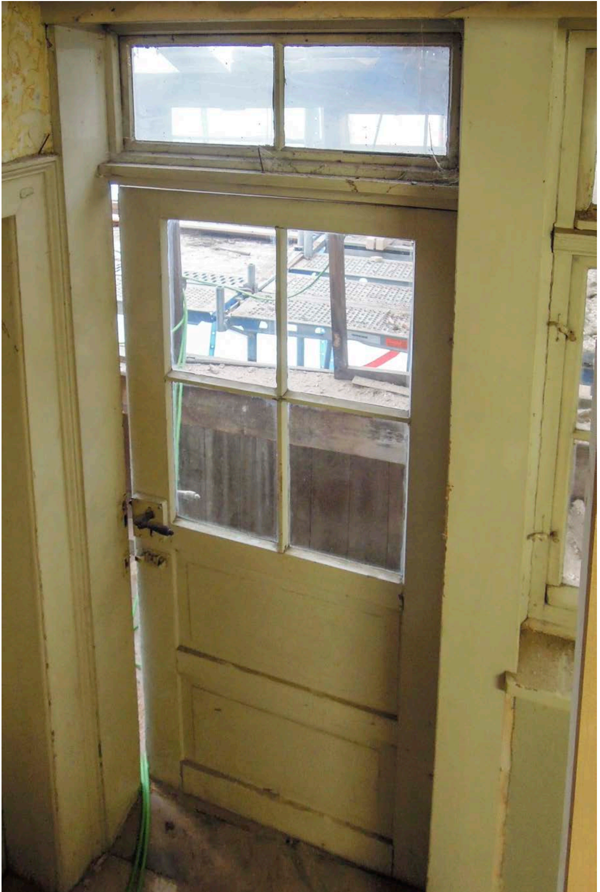
18- T1.11.1 Balkontür- fensterelement 14.11.2017 DSCN7319
