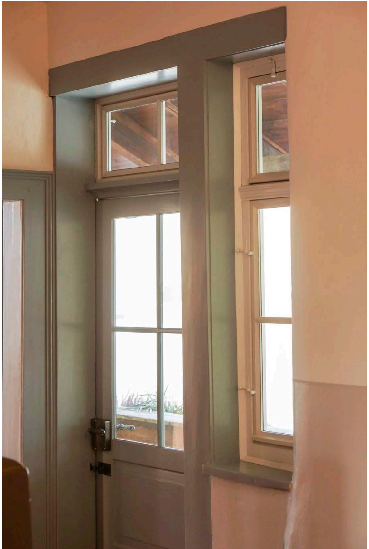
29- T1.11.1 Balkontür- fensterelement 13.11.2020 DSC01223
