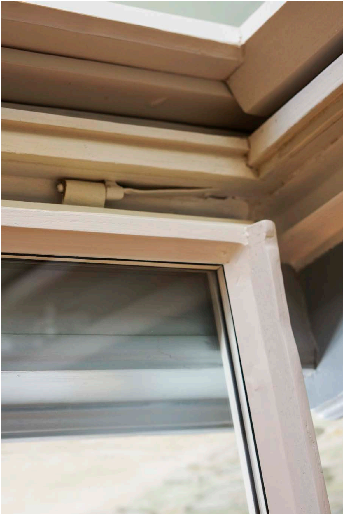
13- R1.02 Holzsprossenfenster Historismus 13.11.2020 DSC01222
