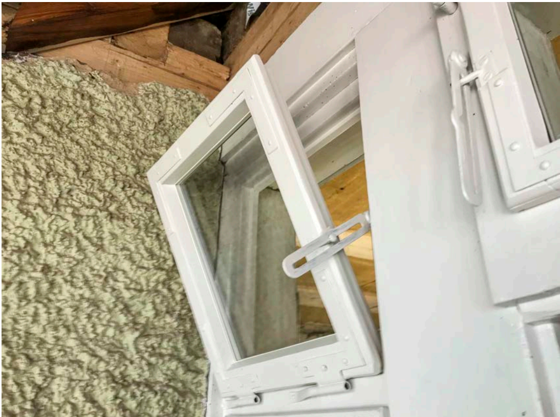
23- T1.11.1 Balkontür- fensterelement 4.06.2019 IMG_0031 2-2
