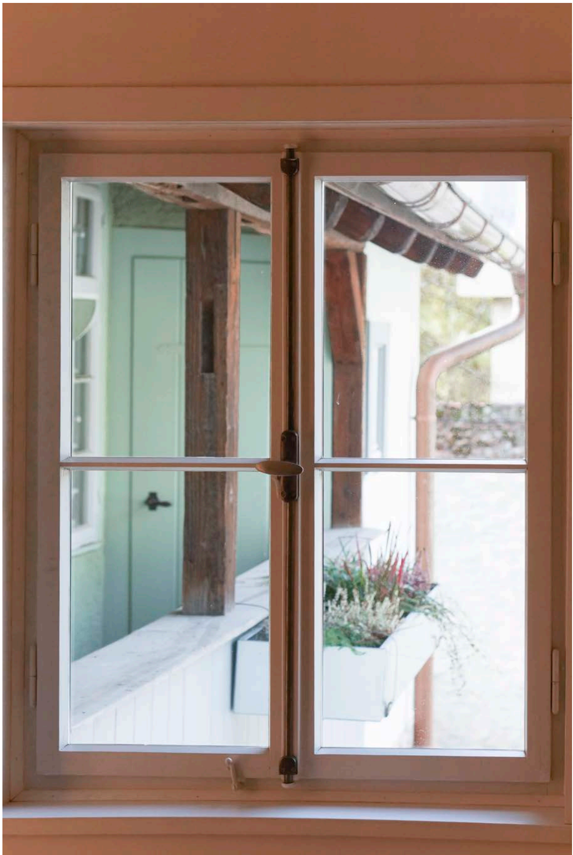
17- R1.02 Holzsprossenfenster Historismus 13.11.2020 DSC01229
