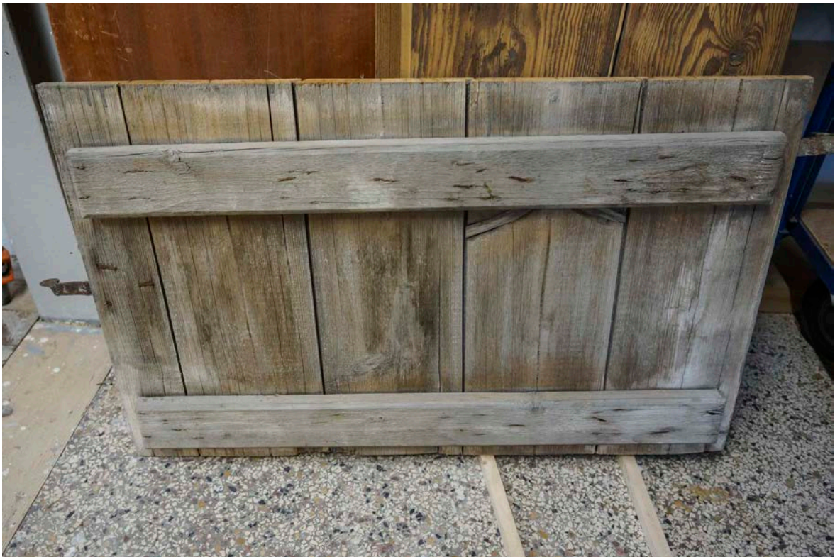
45- Brettläden mit genagelter Halteleiste 27.02.2019 DSC09863
