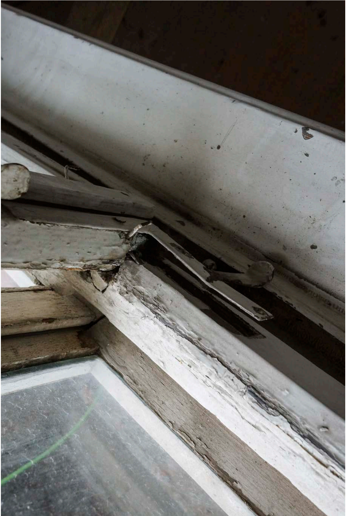
9- R1.02 Holzsprossenfenster Historismus 14.09.2018 DSC09558
