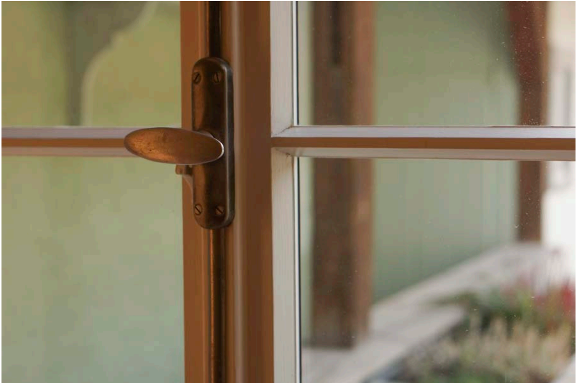
16- R1.02 Holzsprossenfenster Historismus 13.11.2020 DSC01230
