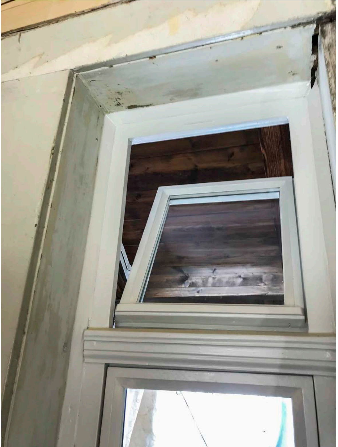
25- T1.11.1 Balkontür- fensterelement 4.06.2019 IMG_0029
