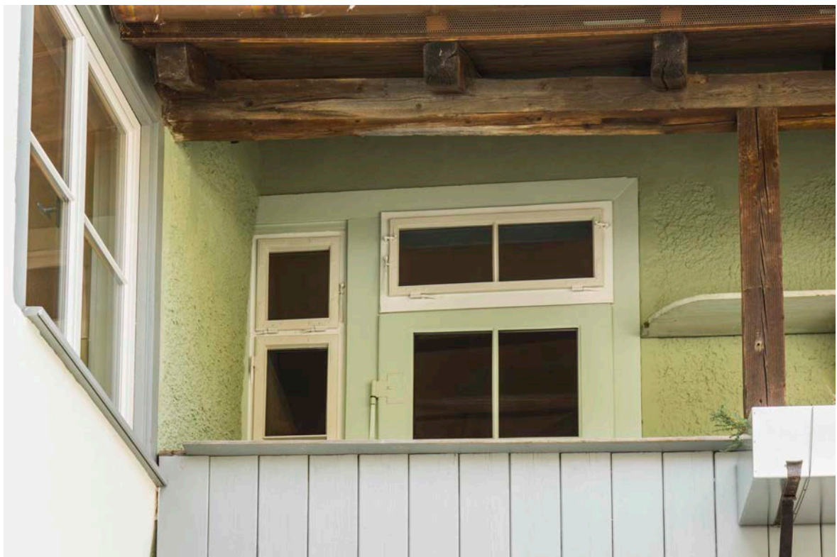
27- T1.11.1 Balkontür- fensterelement 13.11.2020 DSC01197
