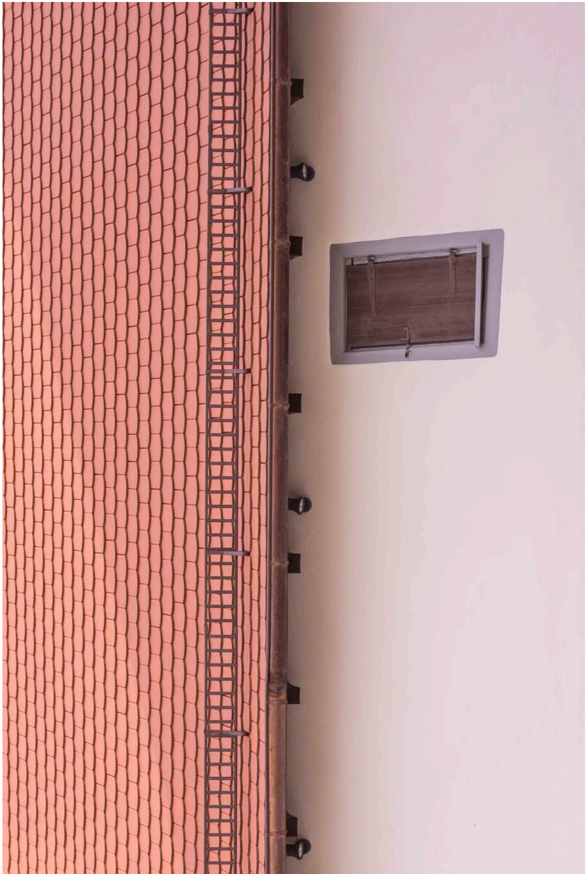
78- Impressionen nach Fertigstellung DSC01201.jpg 13.11.2020
