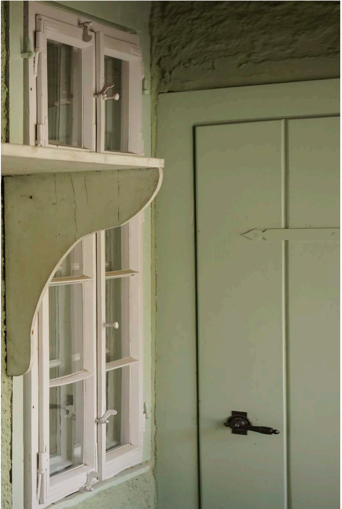
15- R1.02 Holzsprossenfenster Historismus 13.11.2020 DSC01227
