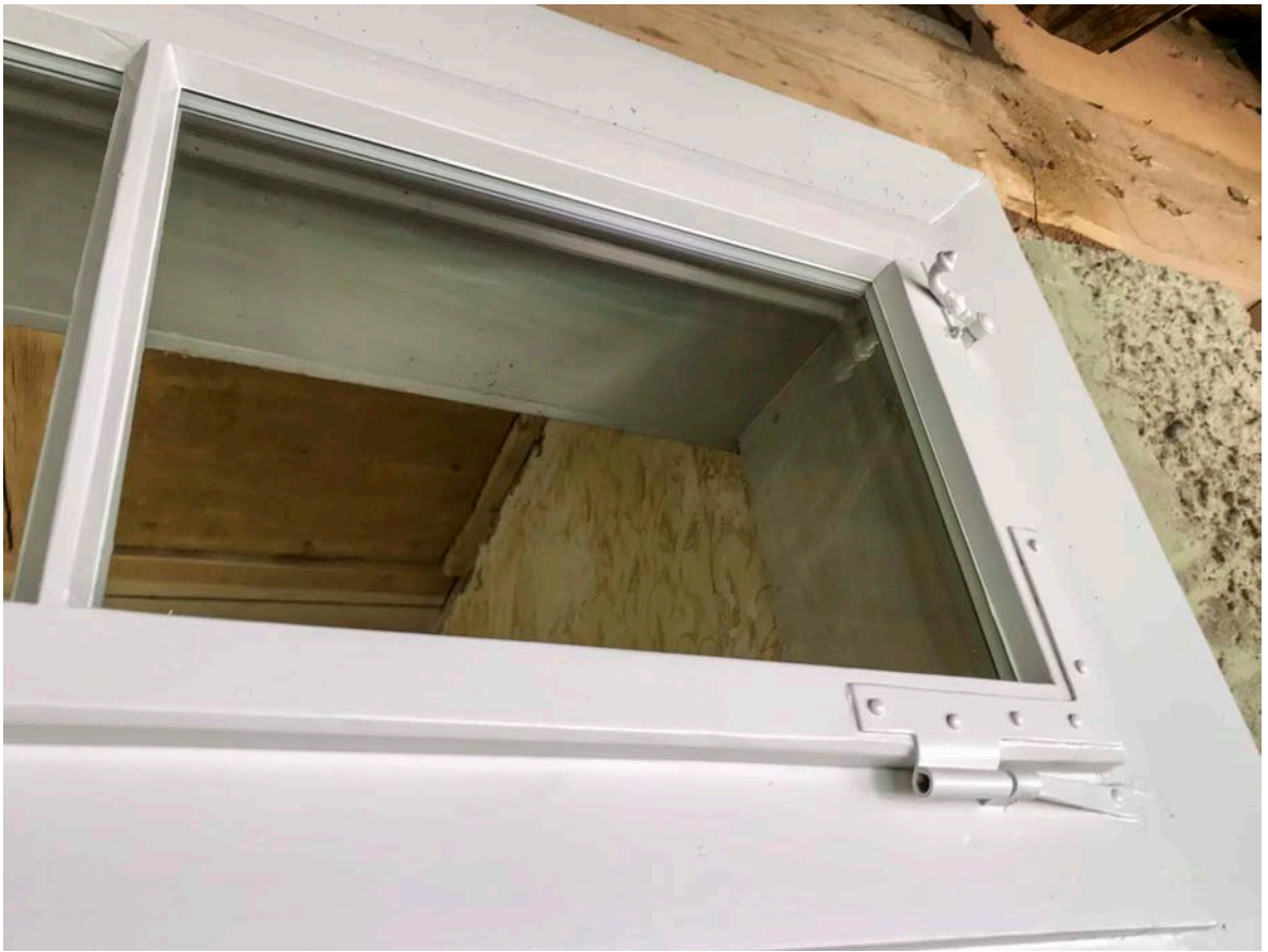
24- T1.11.1 Balkontür- fensterelement 4.06.2019 IMG_0032 2
