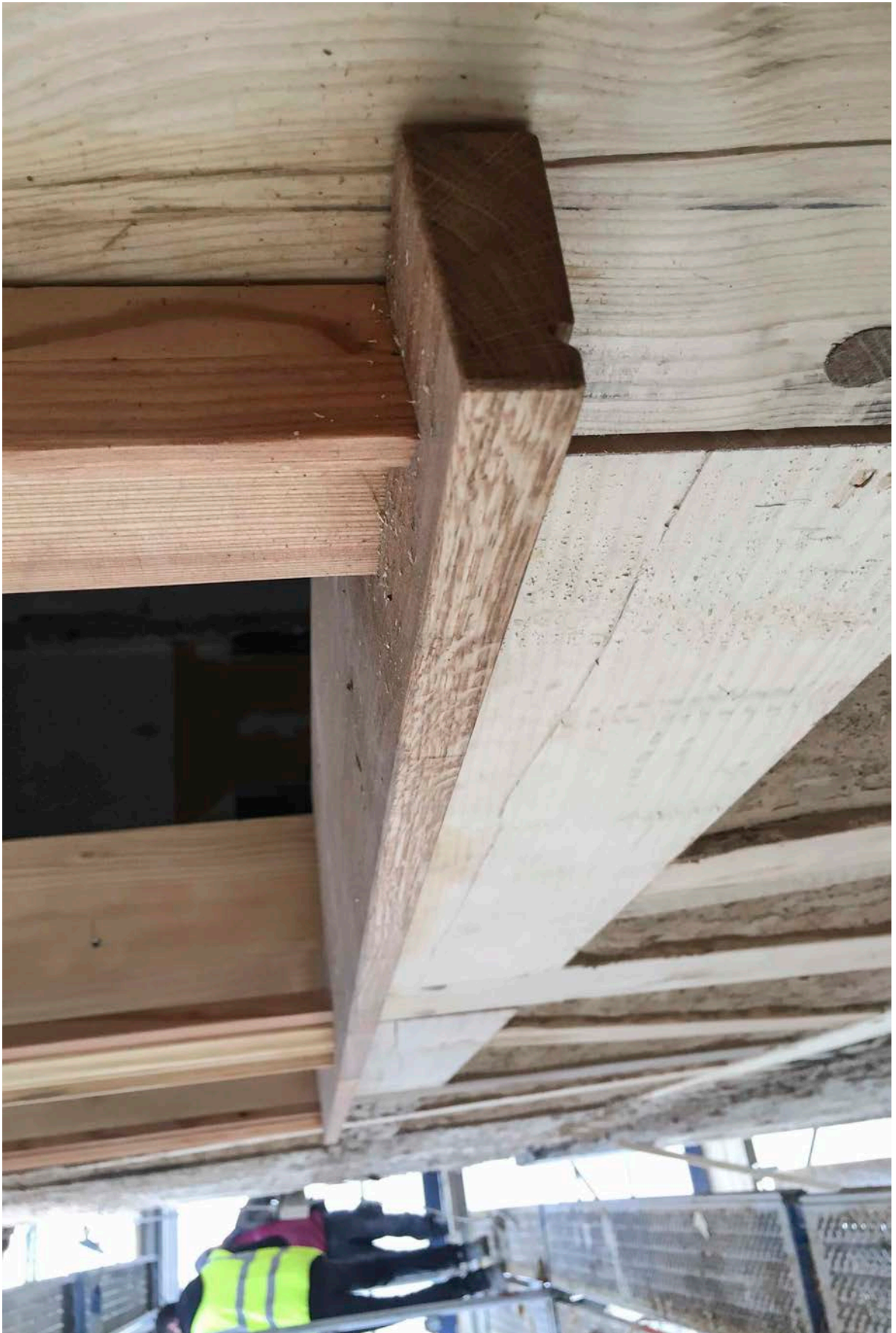
Detail der Montage der Fensterfutter. Geölter Zustand.
