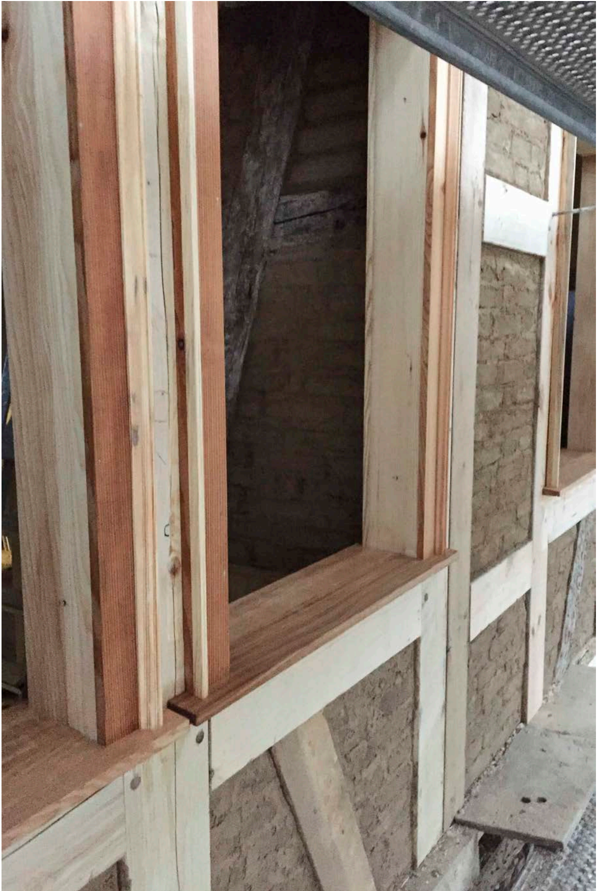
65- Fu-Bekl IMG_0230.jpg Ostfassade FeNr.: 218, 219, 220 13.03.2019
