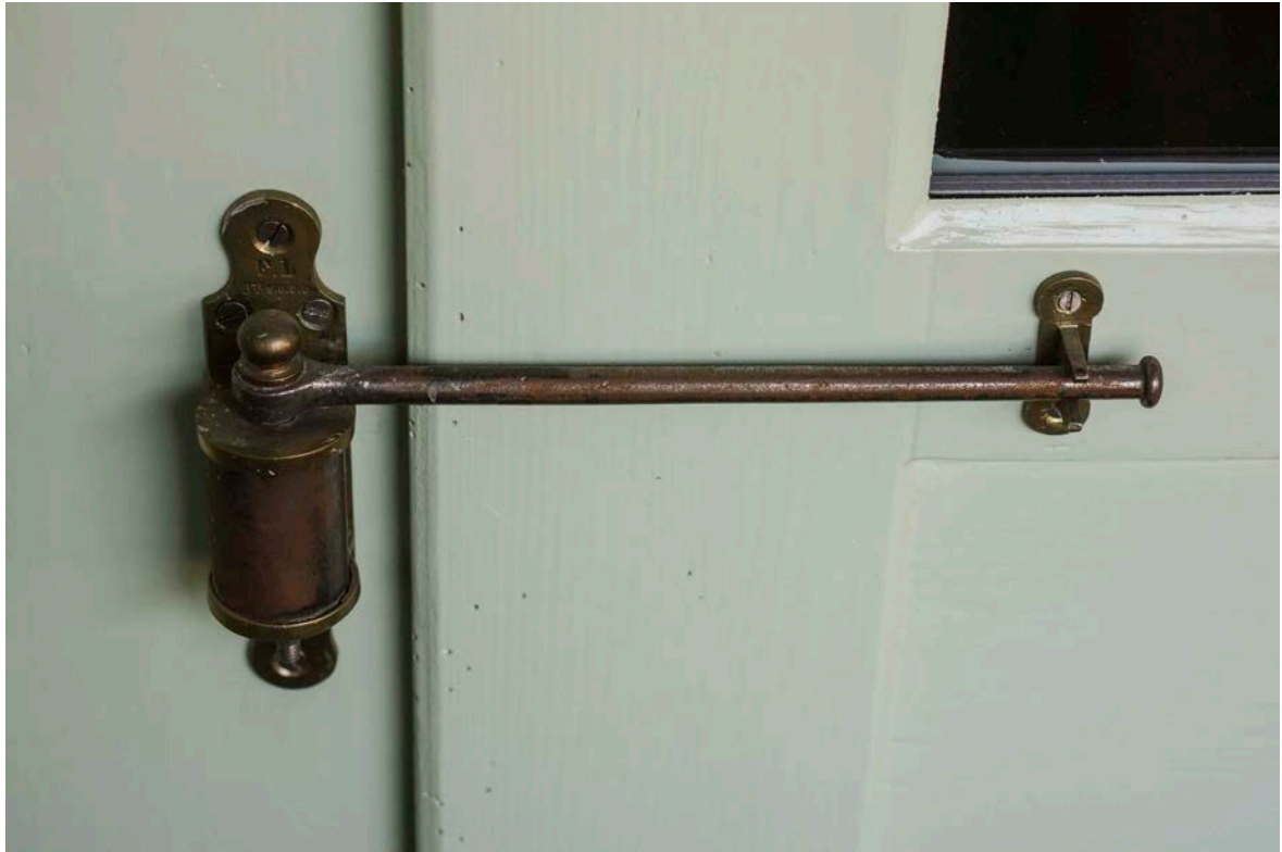
28- T1.11.1 Balkontür- fensterelement 13.11.2020 DSC01228
