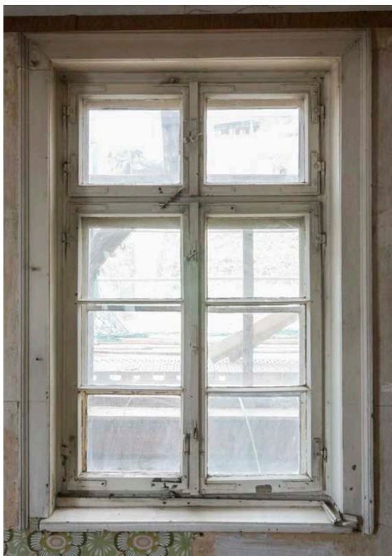
6- R1.02 Holzsprossenfenster Historismus 14.09.2018 DSC09555
