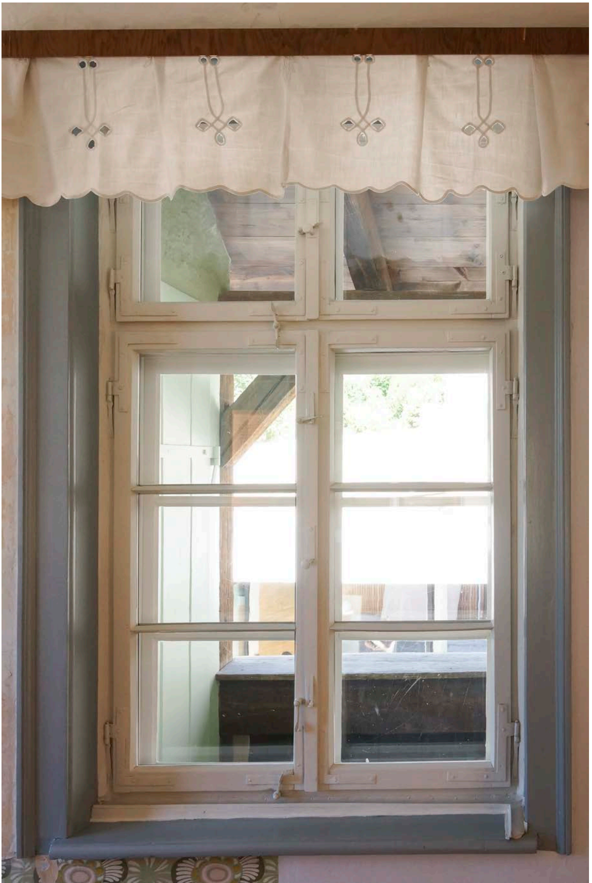
14- R1.02 Holzsprossenfenster Historismus 30.07.2020 DSC00923
