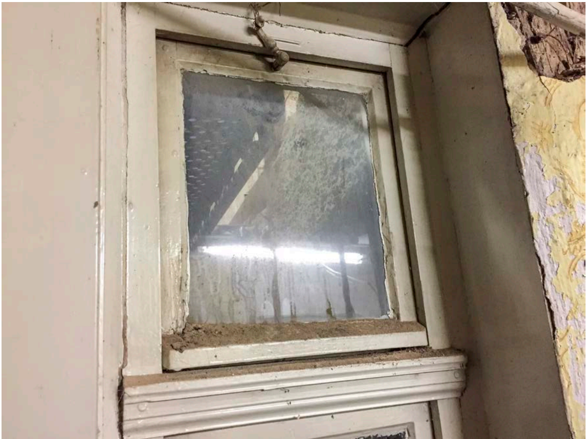
20- T1.11.1 Balkontür- fensterelement 27.11.2018 IMG_2347
