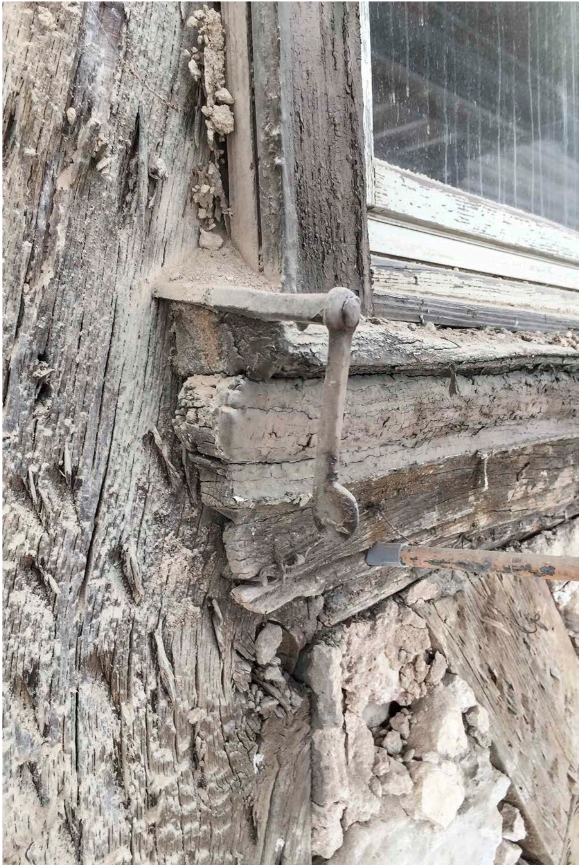
61- Fu-Bekl IMG_1787.jpg Obergeschoß 18.09.2018
