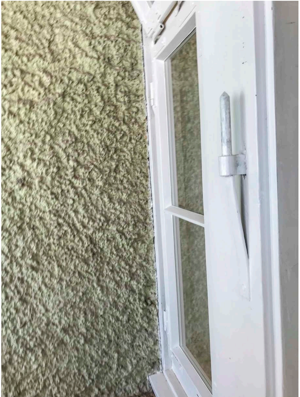
26- T1.11.1 Balkontür- fensterelement 4.06.2019 IMG_0033 2
