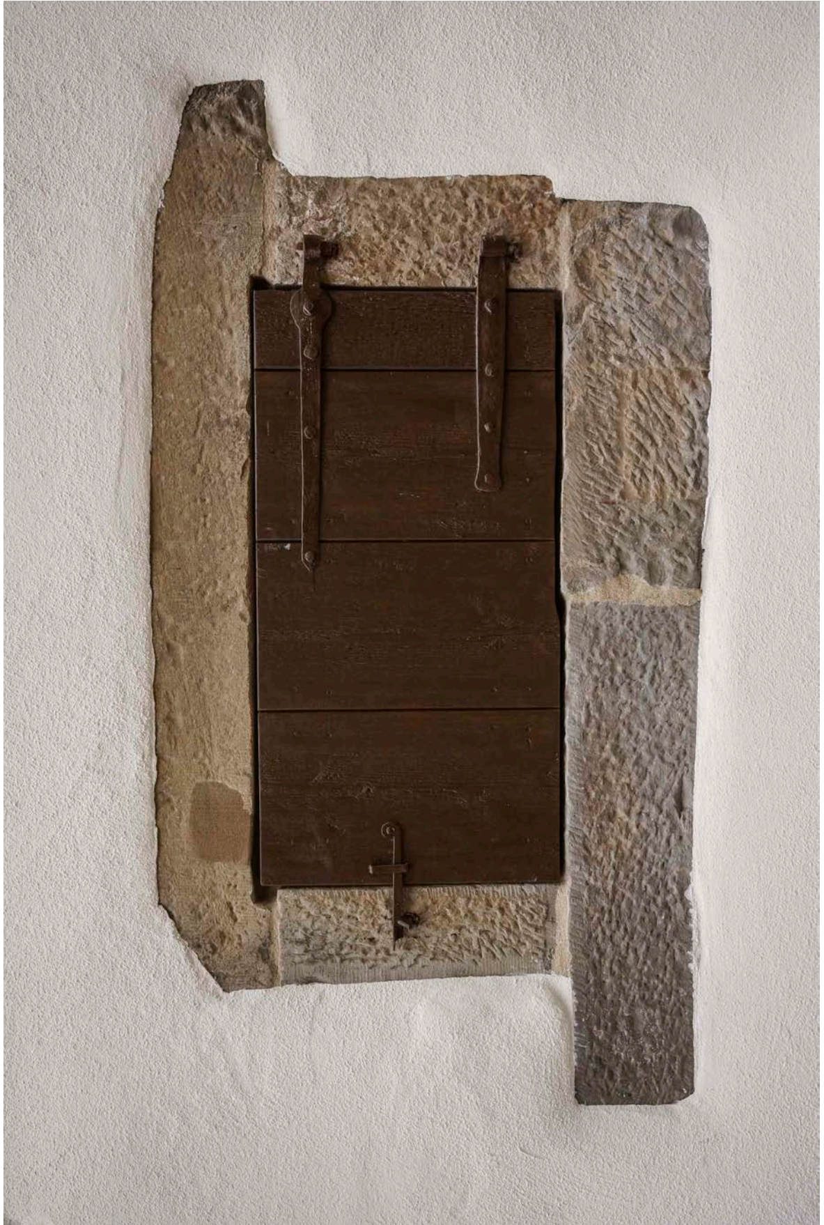
48- Brettladen mit genagelter Halteleiste 13.11.2020 DSC01266
