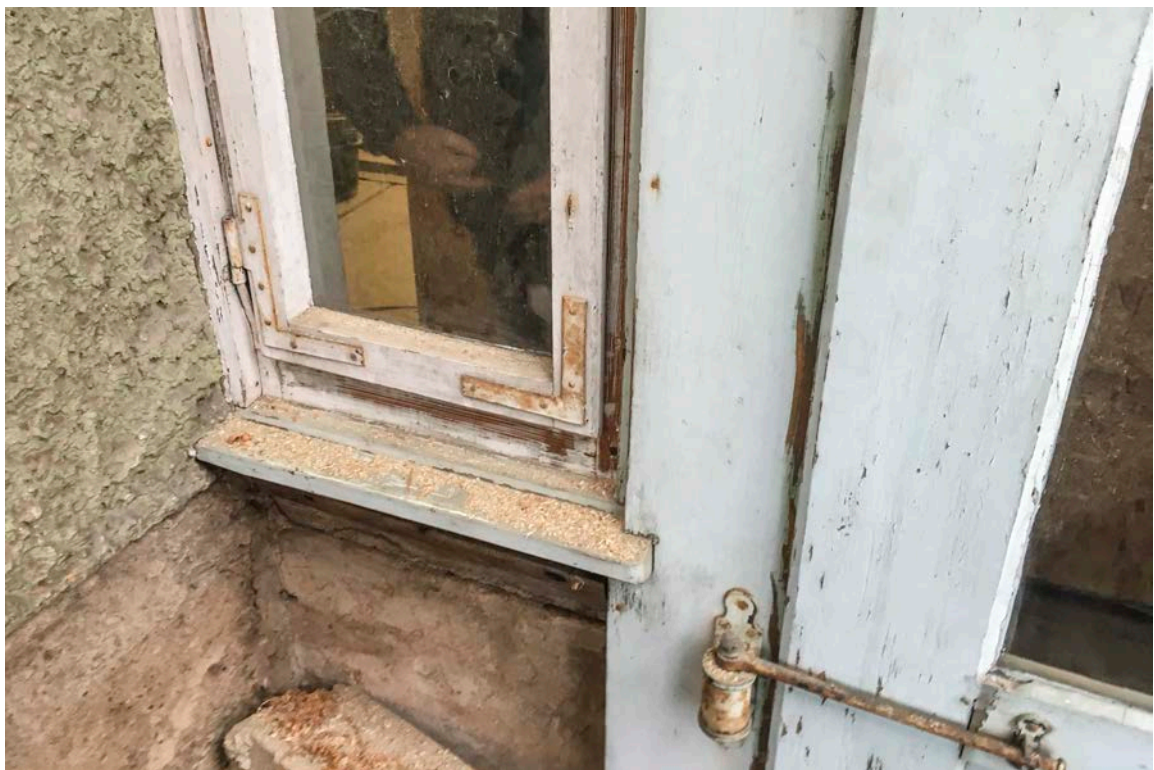
21- T1.11.1 Balkontür- fensterelement 29.01.2019 IMG_7566
