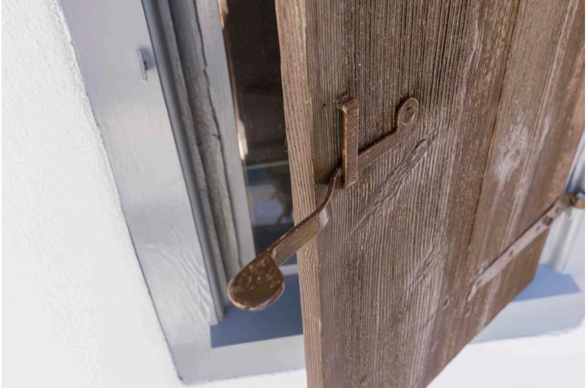
47- Brettläden mit genagelter Halteleiste 7.05.2020 DSC00400
