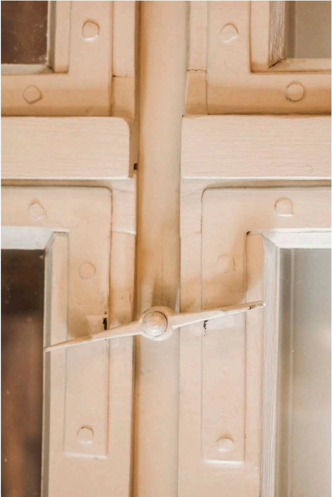
12- R1.02 Holzsprossenfenster Historismus 13.11.2020 DSC01221
