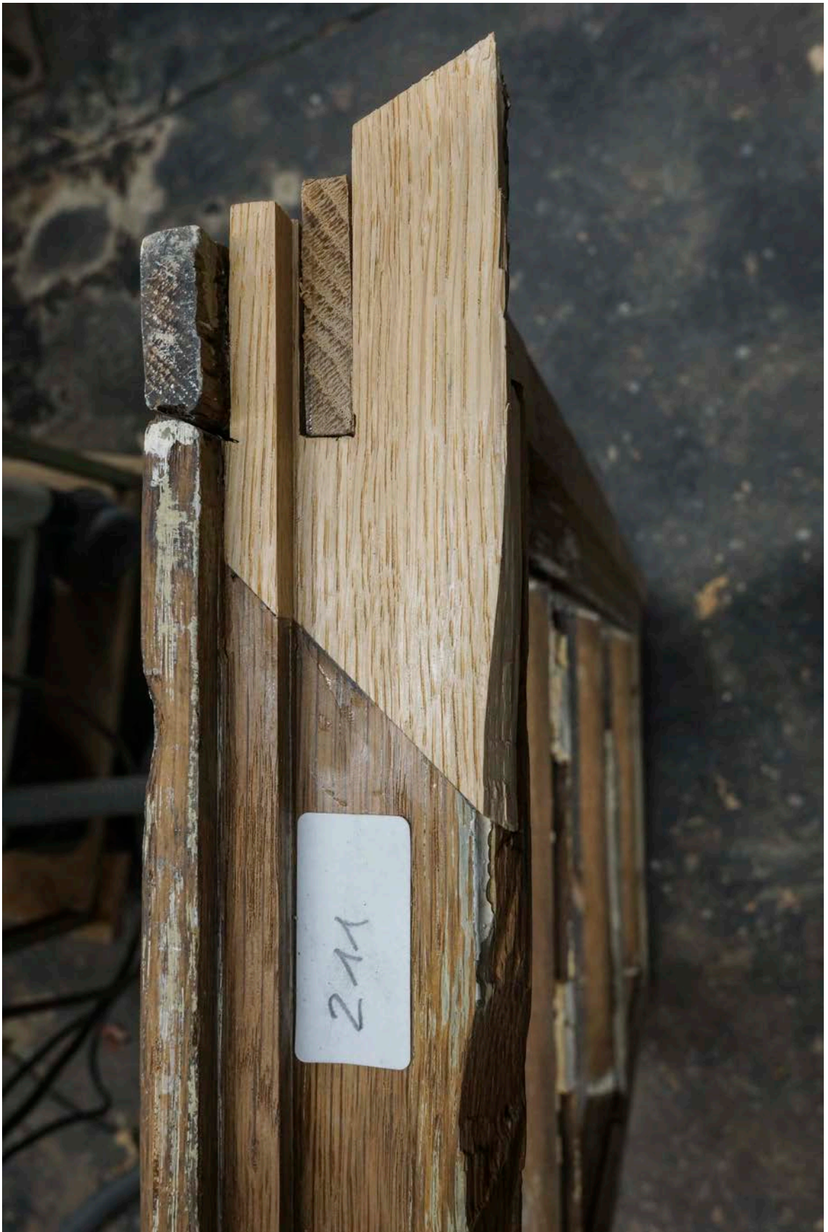
10- R1.02 Holzsprossenfenster Historismus 25.02.2019 DSC09858
