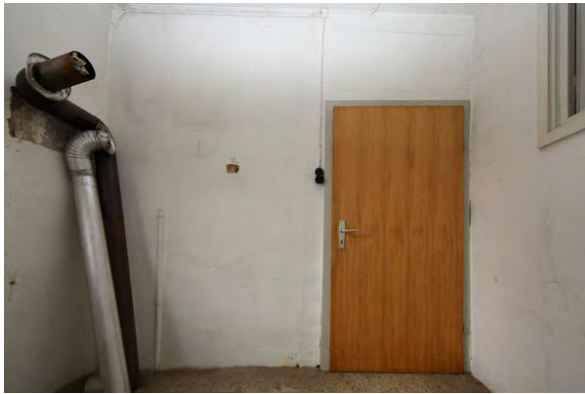
Foto 175: Raum 1.07, Wand c; Zustand vor Baumaßnahme.
