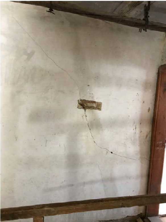
Foto 230: Raum 2.01, Wand c; Zustand vor Restaurierung.
