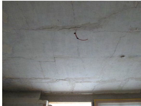
Foto 124: Raum 1.02, Decke; Zustand nach Entfernung der Tapete.
