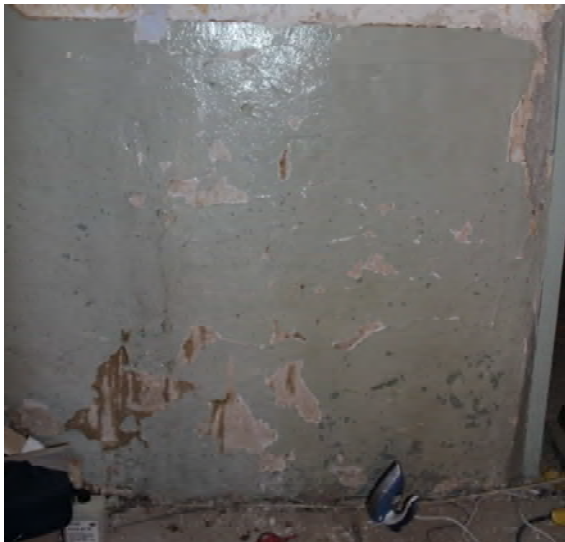
Foto 319: Raum 0.02, Wand a; niedergelegte Fassungsschichten.
