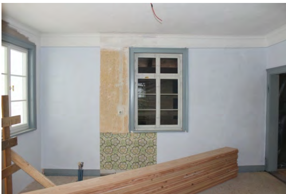
Foto 403: Raum 1.02, Wand a; Endzustand.
