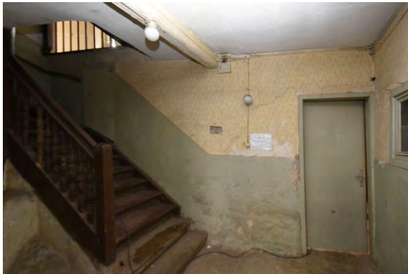
Foto 20: Raum 0.02, Wand a; Zustand vor Baumaßnahme.
