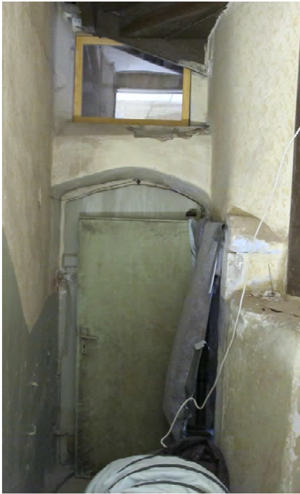
Foto 32: Raum 0.02, Wand d; Zustand vor Restaurierung.
