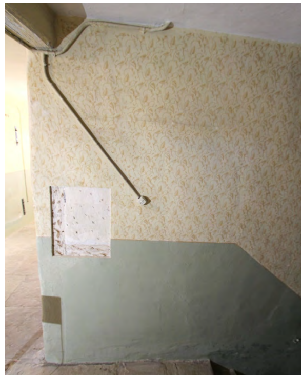
Foto 330: Raum 0.02, Wand c; Endzustand.
