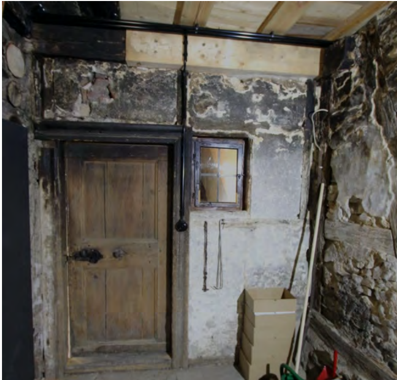
Foto 356: Raum 0.05, Wand a; Endzustand.
