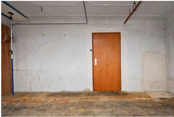
Foto 270: Raum 2.04, Wand a; Zustand vor Baumaßnahme.
