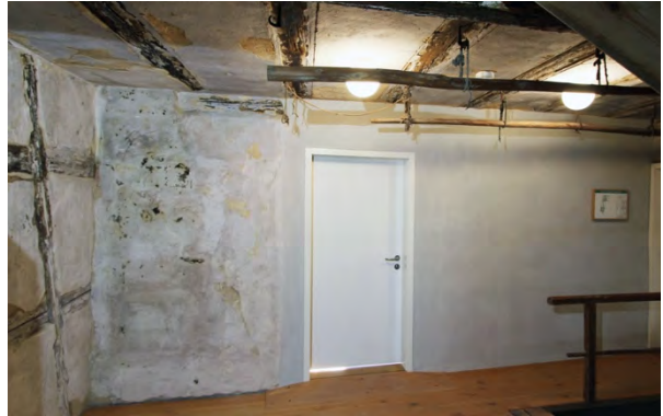
Foto 497: Raum 2.01, Wand c; Endzustand.
