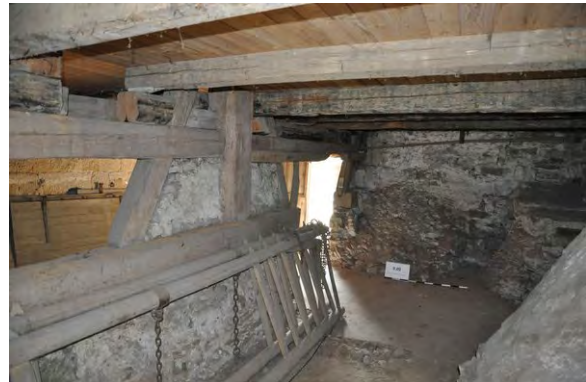
Foto 92: Raum 0.09, Wand c und d; Zustand vor Baumaßnahme.
