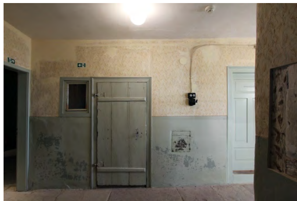
Foto 326: Raum 0.02, Wand b links; Endzustand.
