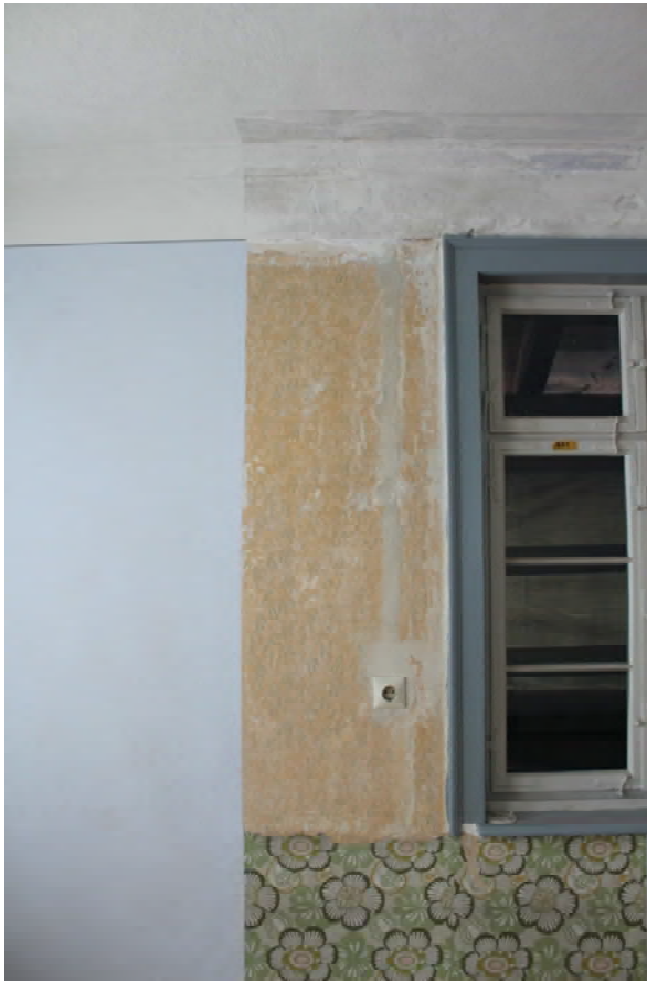
Foto 401: Raum 1.02, Wand a; Endzustand "Fenster in die Vergangenheit".
