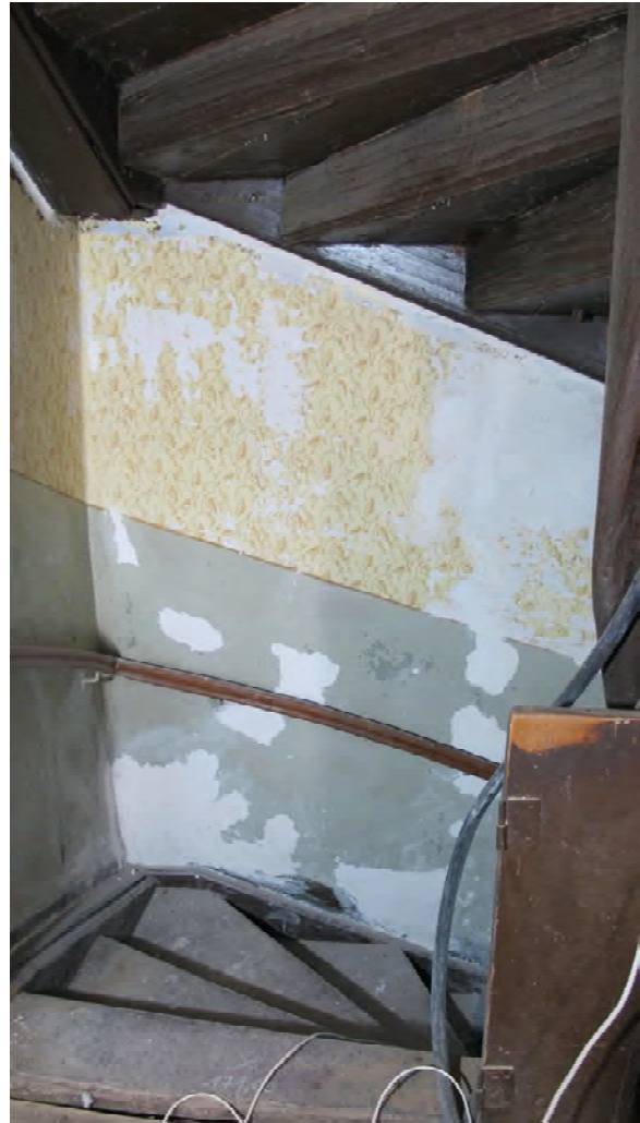
Foto 385: Raum 1.01, Wand d; Zustand nach der Ergänzung der Fehlstellen.
