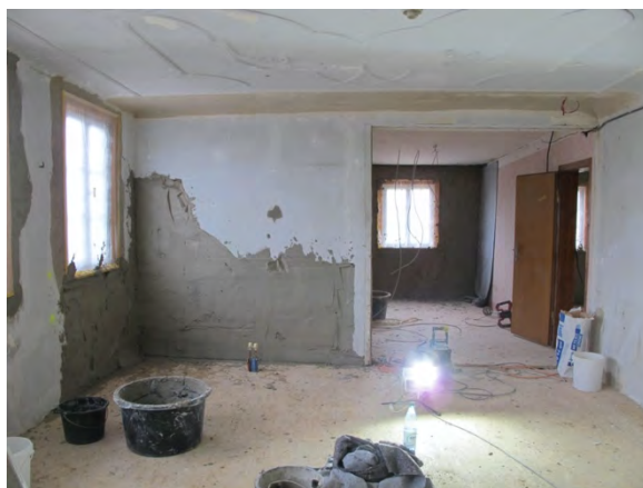
Foto 521: Raum 2.04, Wand c, d und Decke; Putzergänzungen.
