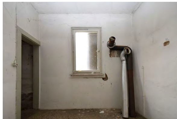
Foto 174: Raum 1.07, Wand b; Zustand vor Baumaßnahme.
