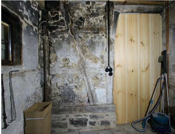
Foto 354: Raum 0.05, Wand a; Endzustand.
