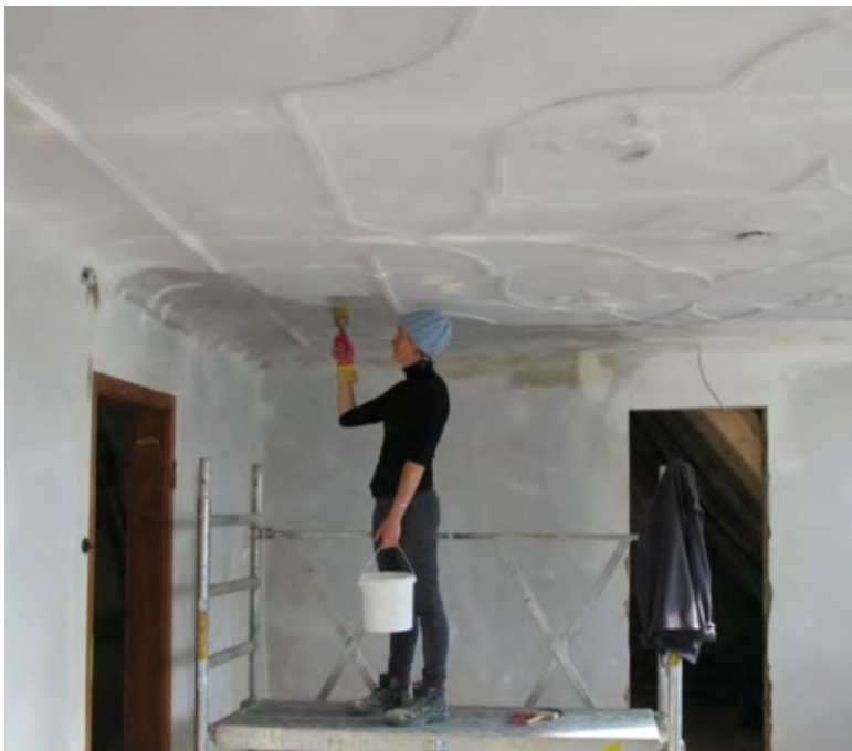
Foto 525: Raum 2.04, Decke; Auftrag Neufassung.
