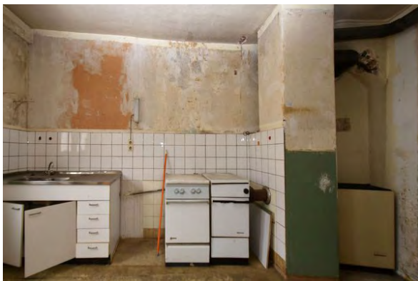
Foto 163: Raum 1.06, Wand c; Zustand vor Baumaßnahme.
