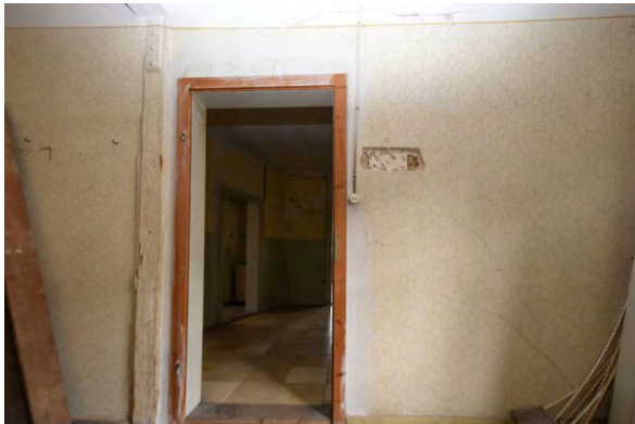
Foto 199: Raum 1.10, Wand c; Zustand vor Baumaßnahme.
