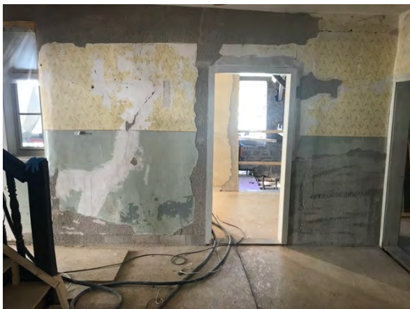
Foto 104: Raum 1.01, Wand a; Zustand vor Restaurierung.
