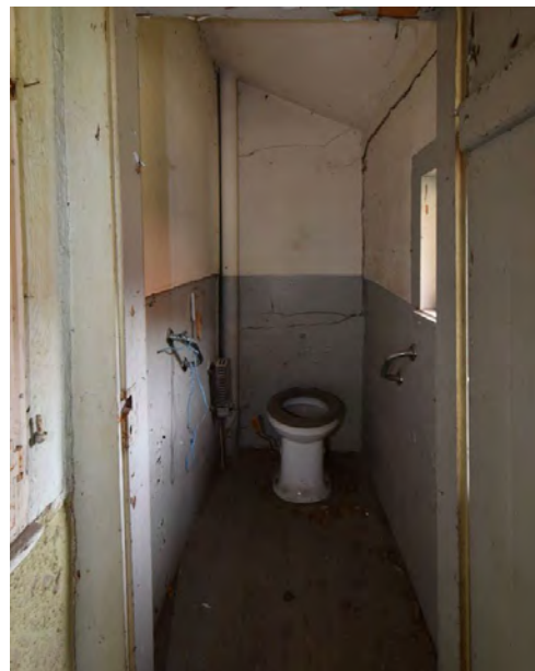
Foto 219: Raum 1.12; Zustand vor Baumaßnahme.
