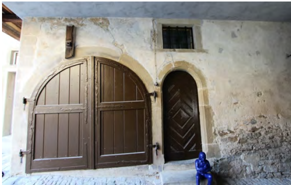
Foto 303: Raum 0.01, Wand b links; Endzustand.
