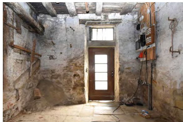
Foto 78: Raum 0.06, Wand d; Zustand vor Baumaßnahme.
