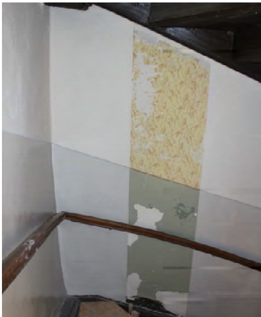
Foto 390: Raum 1.01, Wand d; Endzustand.
