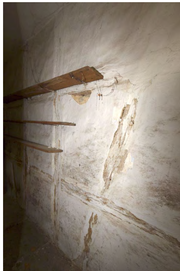
Foto 186: Raum 1.09, Wand b; Zustand vor Baumaßnahme.
