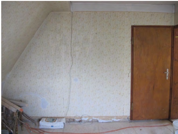
Foto 249: Raum 2.02, Wand b; Zustand vor Restaurierung.
