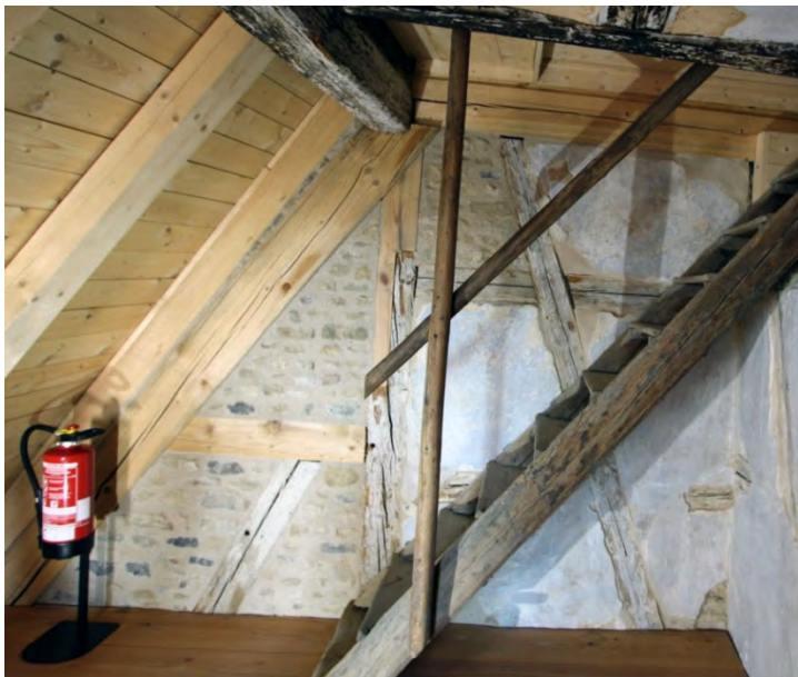
Foto 490: Raum 2.01, Wand a; Endzustand.
