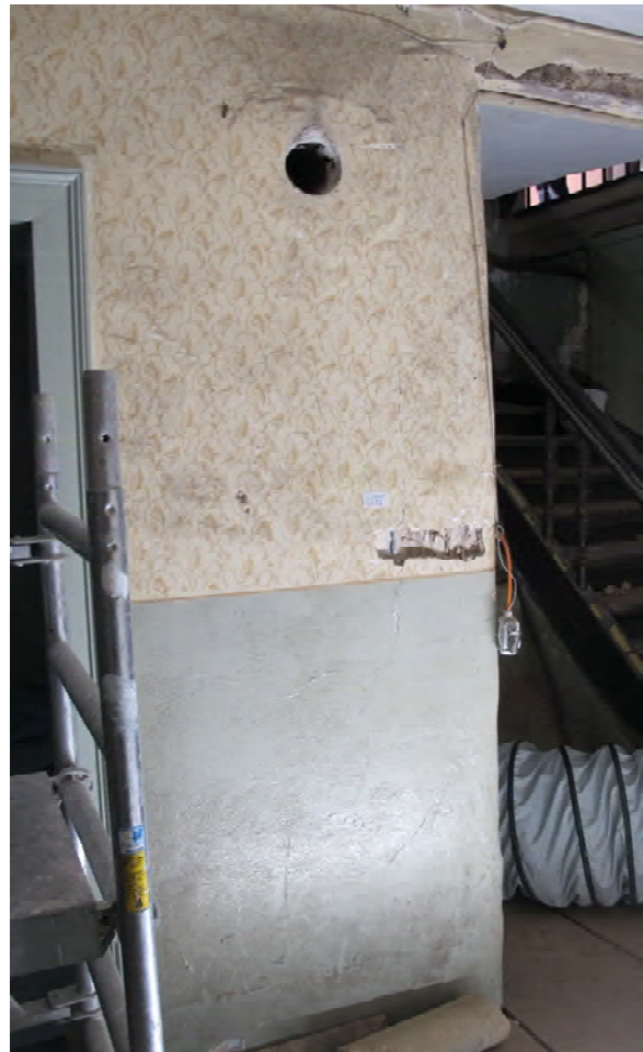
Foto 33: Raum 0.02, Wand d; Zustand vor Restaurierung.
