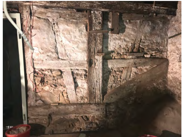
Foto 80: Raum 0.06, Wand c; Zustand vor Restaurierung.
