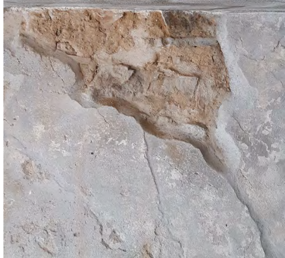
Foto 300: Raum 0.01, Wand b; Randsicherungen des Bestandputzes und Fehlstellenergänzung.
