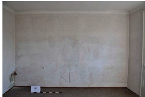
Foto 151: Raum 1.05, Wand b; Zustand vor Baubeginn.
