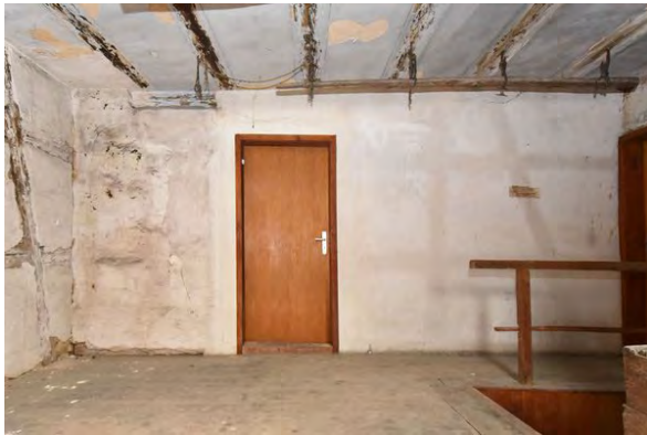
Foto 226: Raum 2.01, Wand c; Zustand vor Baumaßnahme.
