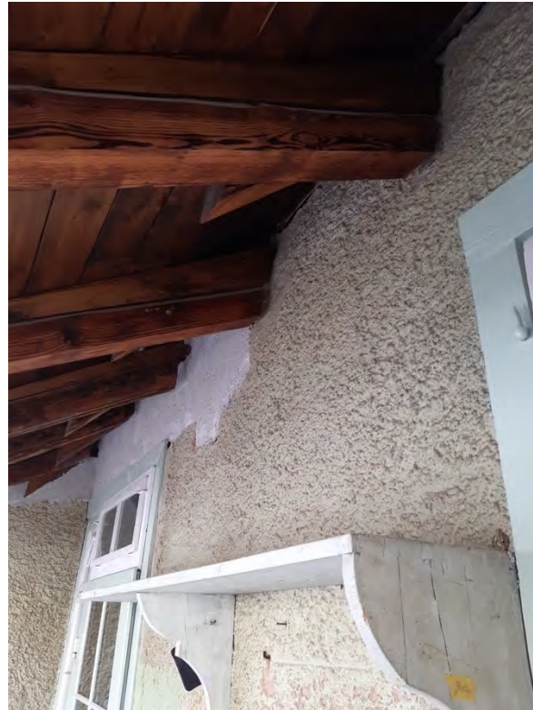
Foto 213: Raum 1.11, Wand c; Zustand vor Restaurierung.
