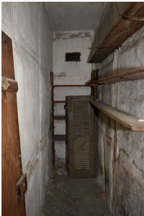
Foto 185: Raum 1.09, Wand a, b und d; Zustand vor Baumaßnahme.
