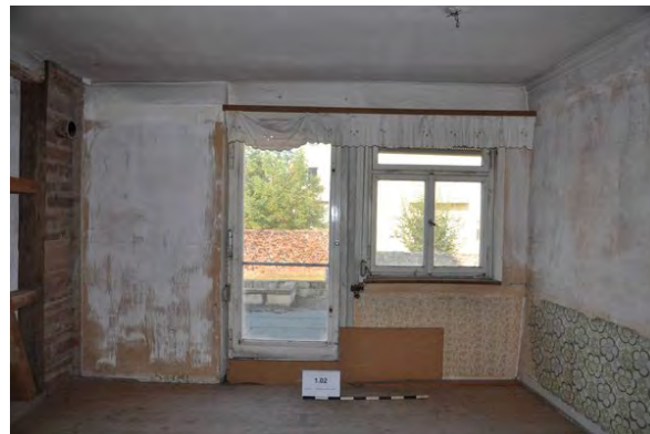
Foto 116: Raum 1.02, Wand d; Zustand vor Baumaßnahme.
