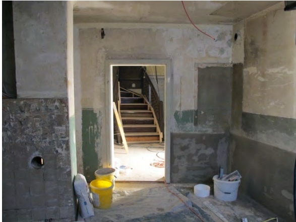
Foto 167: Raum 1.06, Wand d; Zustand vor Restaurierung.
