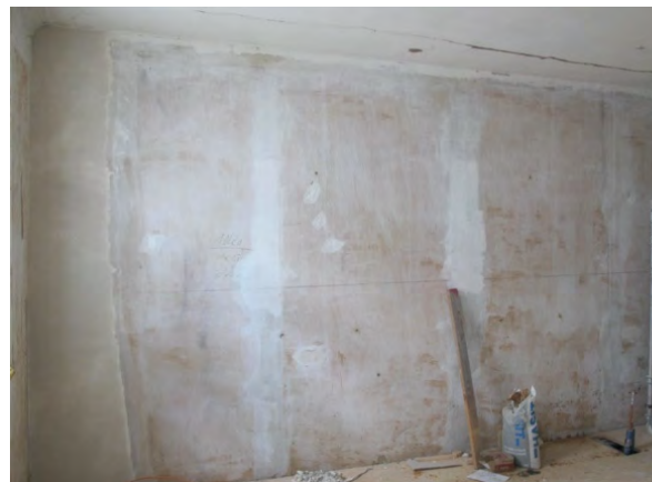
Foto 411: Raum 1.03, Wand d; geglättete Ergänzungen.
