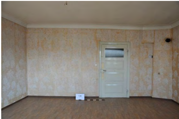
Foto 137: Raum 1.04, Wand a; Zustand vor Baumaßnahme.
