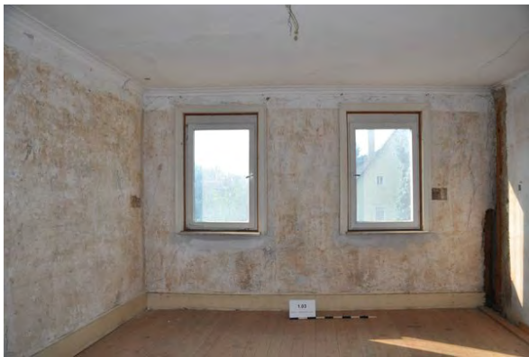
Foto 128: Raum 1.03, Wand c; Zustand vor Baumaßnahme.
