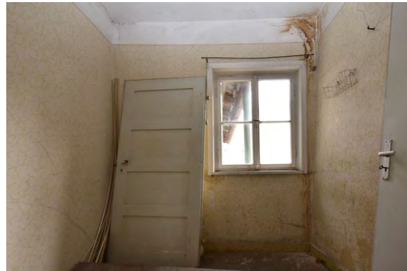
Foto 200: Raum 1.10, Wand d; Zustand vor Baumaßnahme.
