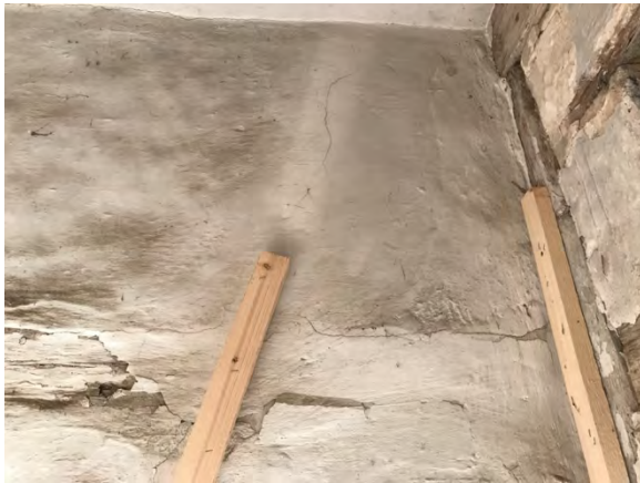
Foto 192: Raum 1.09; Wand b; aufstehende Fassung.
