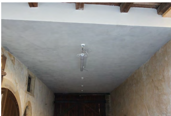
Foto 305: Raum 0.01, Decke; Endzustand.
