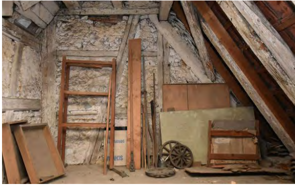
Foto 282: Raum 2.05, Wand a; Zustand vor Baumaßnahme.
