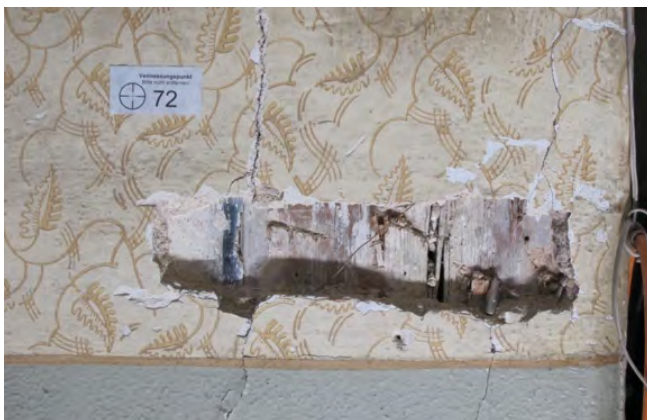
Foto 24: Raum 0.02, Wand d; alte Sondage.
