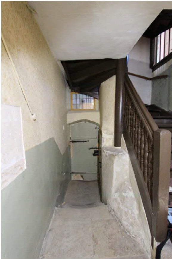
Foto 331: Raum 0.02, Wand a, c und d; Endzustand.
