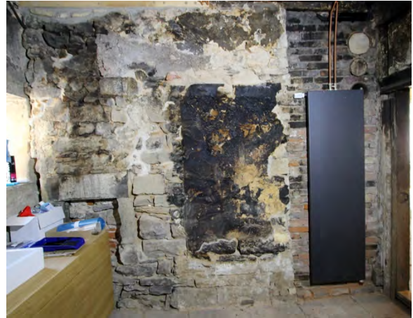
Foto 355: Raum 0.05, Wand c; Endzustand.
