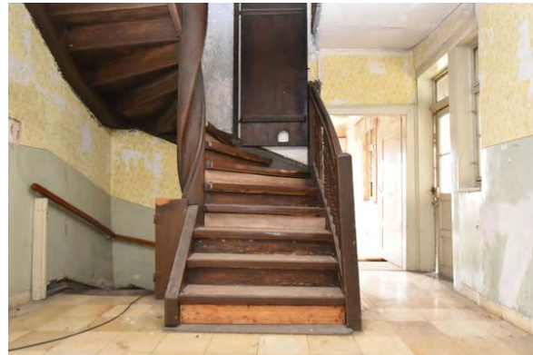
Foto 103: Raum 1.01, Wand d; Zustand vor Baumaßnahme.
