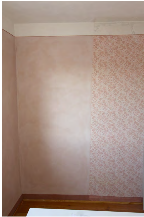
Foto 518: Raum 2.03, Wand a; Endzustand „Fenster in die Vergangenheit“.
