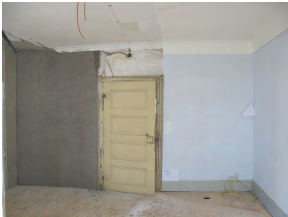
Foto 406: Raum 1.03, Wand a; verputzte Aufmauerung.
