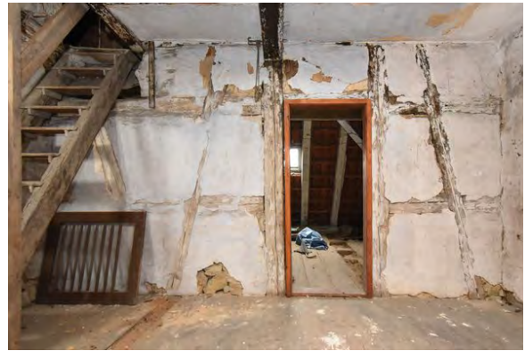
Foto 225: Raum 2.01, Wand b; Vorzustand.
