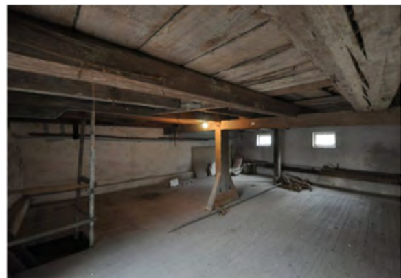
Foto 222: Raum 1.13, Wand c und d; Zustand vor Bau- maßnahmen.
