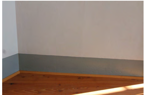
Foto 420: Raum 1.04, Wand b; malerisch ergänzter Sockel.
