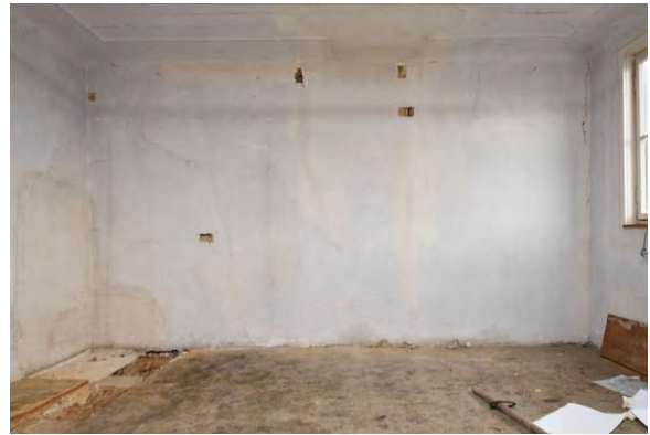
Foto 271: Raum 2.04, Wand b; Zustand vor Baumaßnahme.
