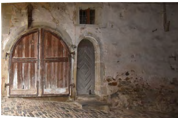
Foto 6: Durchfahrt (Raum 0.01, Wand b); Zustand vor Baumaßnahme.
