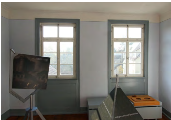
Foto 429: Raum 1.05, Wand b; Endzustand.
