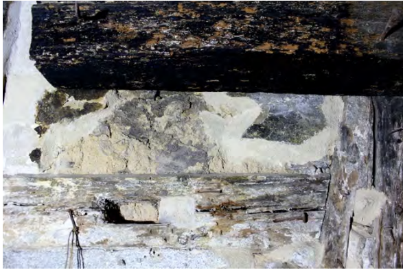
Foto 364: Raum 0.06, Wand c; Randsicherung.
