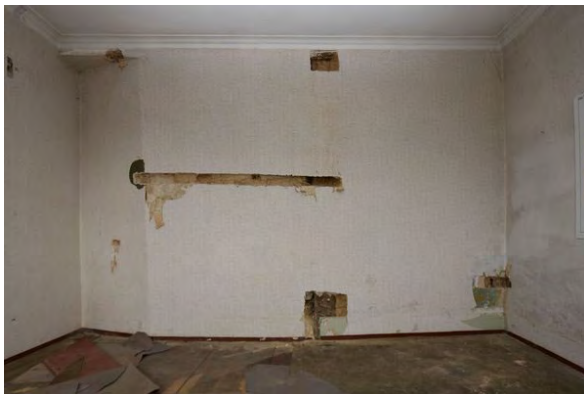
Foto 150: Raum 1.05, Wand a; Zustand vor Baumaßnahme.
