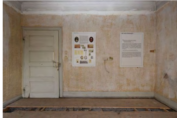
Foto 114: Raum 1.02, Wand b; Zustand vor Baumaßnahme.
