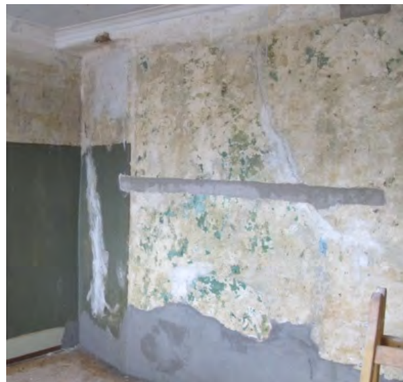
Foto 425: Raum 1.05, Wand a; Putzergänzungen.
