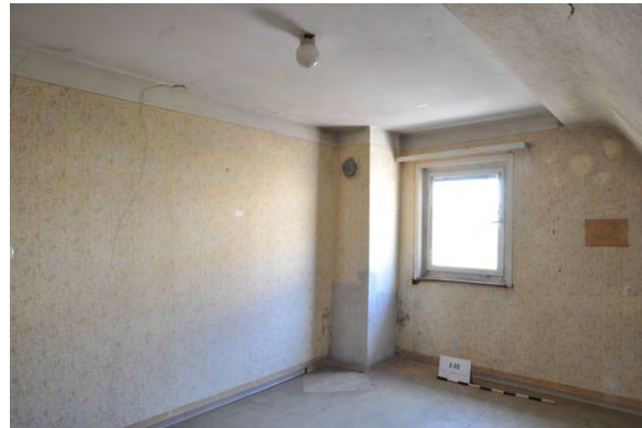
Foto 246: Raum 2.02, Wand d; Zustand vor Baumaßnahme.
