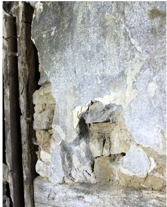
Foto 351: Raum 0.05, Wand a; gesichertes Gefach.
