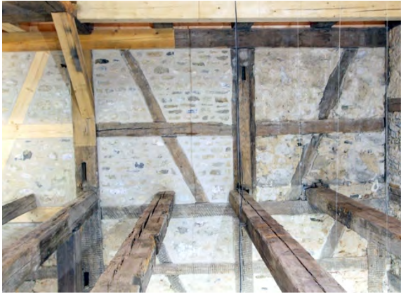
Foto 479: Raum 1.13, Wand b, rechts oben; Endzustand.
