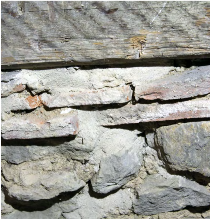
Foto 475: Raum 1.13, Wand a; Sicherung Ausmauerung.
