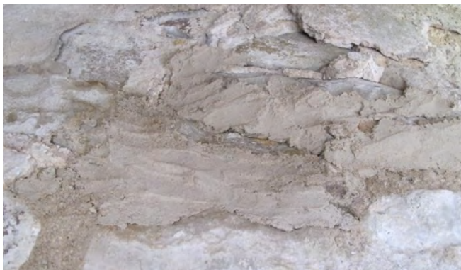
Foto 297: Raum 0.01, Wand d; Ergänzung von Fehlstellen im Mauerwerk.
