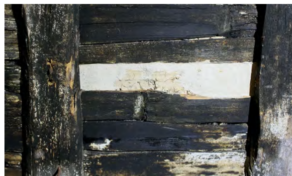
Foto 359: Raum 0.06, Decke; wie Foto 358, Endzustand.
