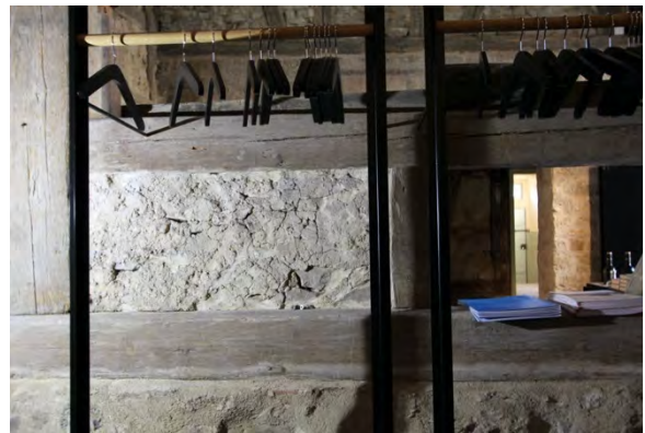
Foto 379: Raum 0.08, Wand c links; Endzustand.
