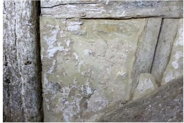
Foto 365: Raum 0.06, Wand c; Sicherung Ausmauerung.
