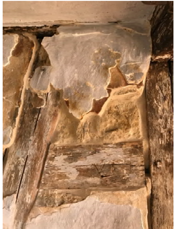
Foto 487: Raum 2.01, Wand b; ergänzte Aufmauerungen, Randsicherungen und Konsolidierung.
