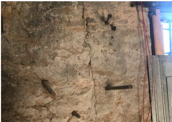
Foto 87: Raum 0.06, Wand d; Rundstäbe in Wand.
