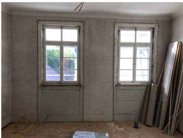
Foto 156: Raum 1.05, Wand c; Zustand vor Restaurierung.
