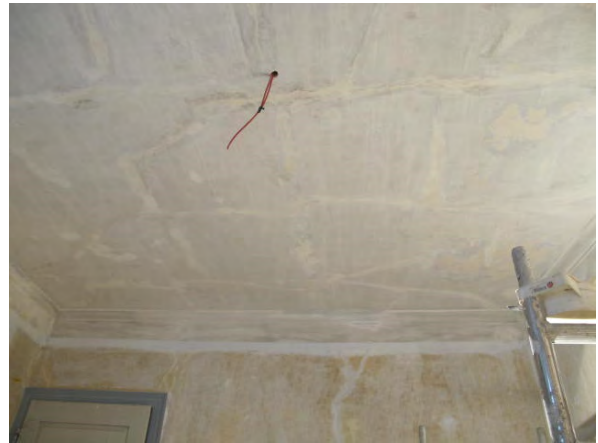
Foto 396: Raum 1.02, Decke; Zwischenzustand.
