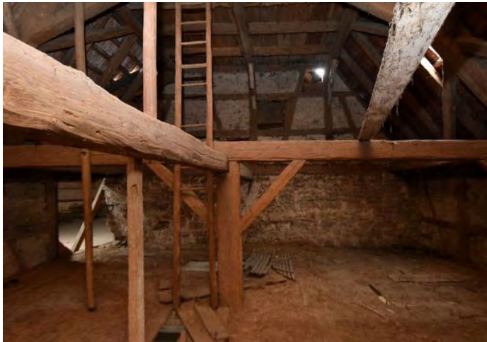
Foto 288: Raum 2.08, Wand a; Zustand vor Baumaßnahme.
