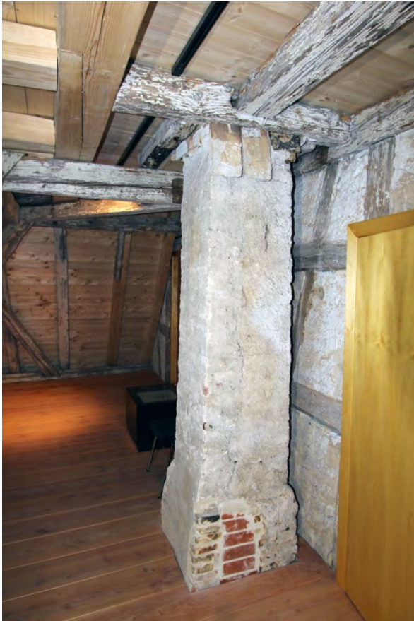
Foto 537: Raum 2.05, Wand d; Endzustand Kamin.
