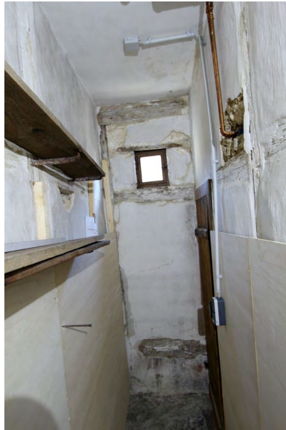
Foto 456: Raum 1.09, Wand b, c und d; Endzustand.
