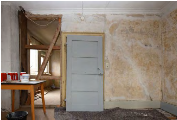
Foto 126: Raum 1.03, Wand a; Zustand vor Baumaßnahme.
