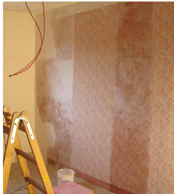
Foto 512: Raum 2.03, Wand a; Anbringen des Japanpapierschutzes.
