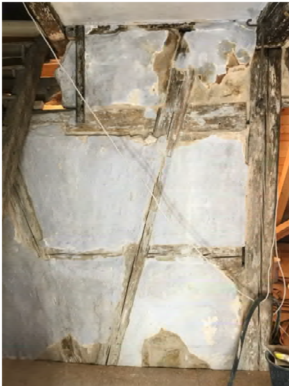
Foto 486: Raum 2.01, Wand b; ergänzte Aufmauerungen, Randsicherungen und Konsolidierung.
