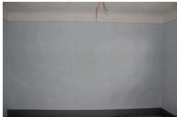
Foto 428: Raum 1.05, Wand b; Endzustand.
