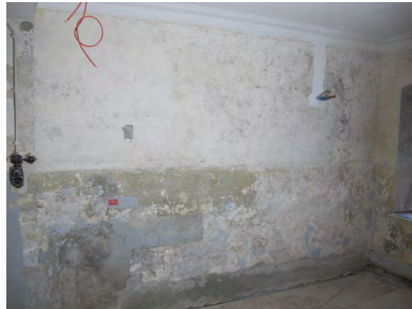
Foto 344: Raum 0.04, Wand b; Ergänzungen mit Kalkputz.
