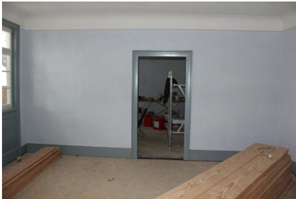
Foto 419: Raum 1.04, Wand d; Endzustand.
