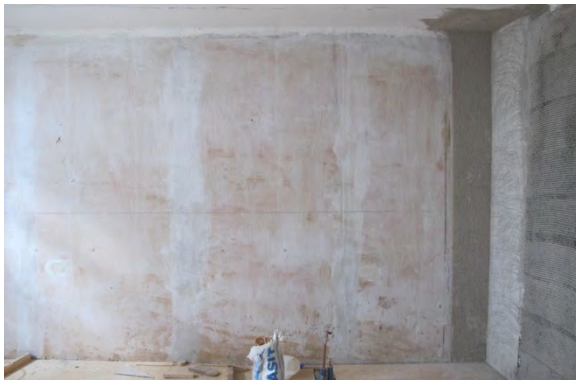
Foto 132: Raum 1.03, Wand d; Zustand vor Restaurierung.
