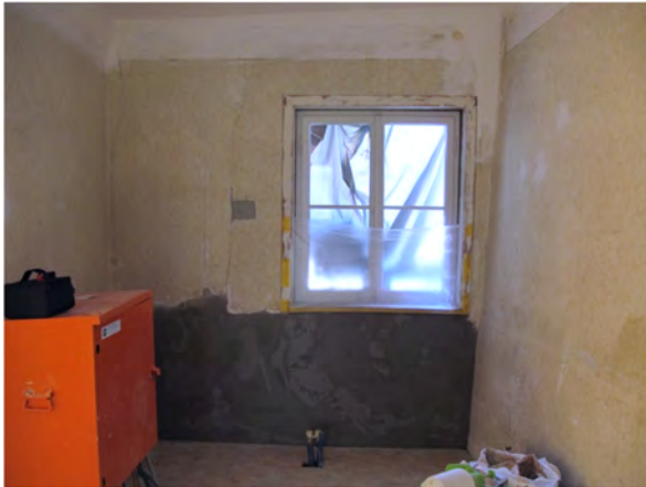
Foto 458: Raum 1.10, Wand d; großflächige Ergänzung.
