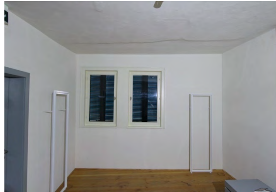
Foto 437: Raum 1.06, Wand c; Endzustand.
