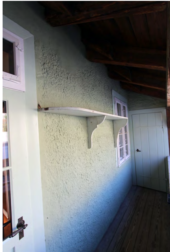
Foto 473: Raum 1.11, Wand c und d; Endzustand.
