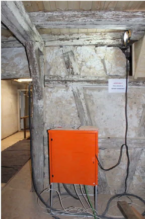
Foto 539: Raum 2.05, Wand d; rechts Endzustand.
