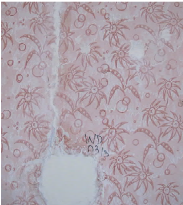
Foto 511: Raum 2.03, Wand a; Rissverdämmung und Fehlstellenergänzung.
