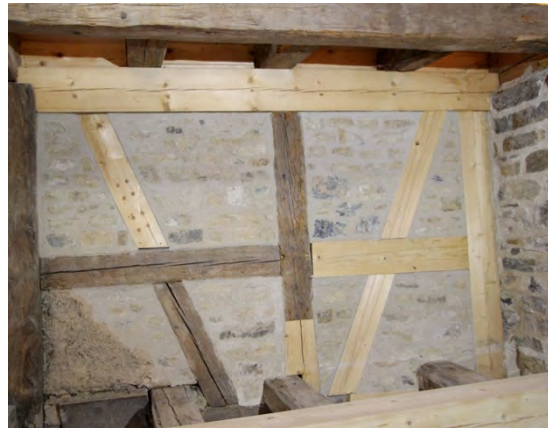
Foto 482: Raum 1.13, Wand d rechts; Endzustand.
