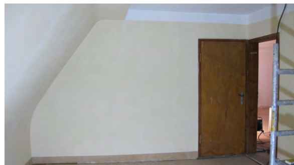
Foto 503: RWie Foto 502; abschließende Neufassung.
