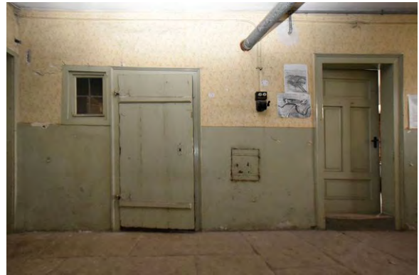
Foto 21: Raum 0.02, Wand b; Zustand vor Baumaßnahme.
