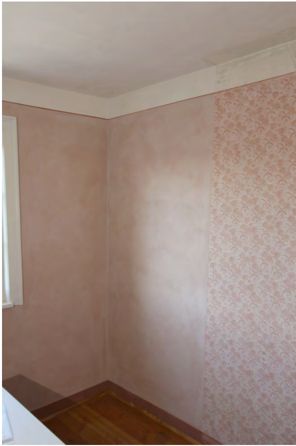
Foto 517: Raum 2.03, Wand a und d; Endzustand.
