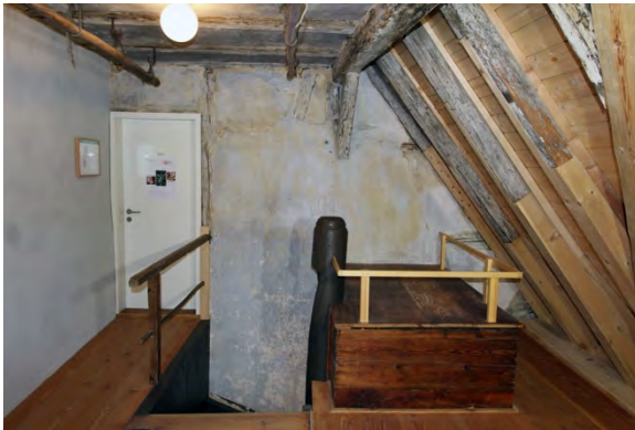
Foto 498: Raum 2.01, Wand c; Endzustand.
