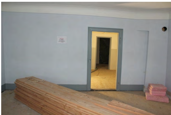
Foto 417: Raum 1.04, Wand a; Endzustand.
