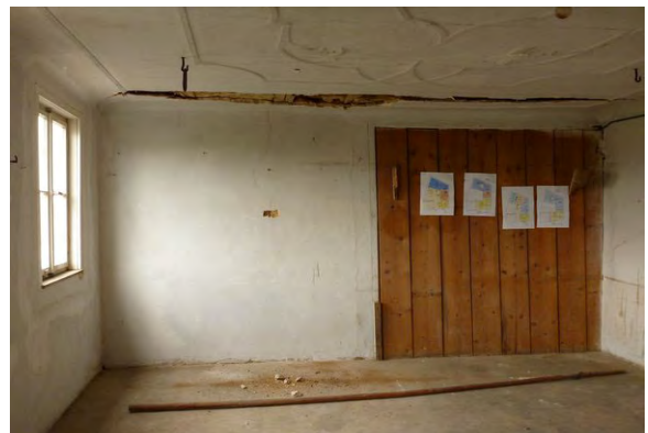
Foto 273: Raum 2.04, Wand d; Zustand vor Baumaßnahme.
