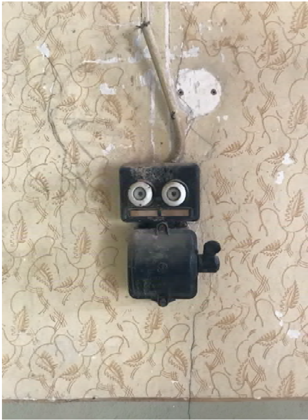
Foto 26: Raum 0.02, Wand b; Sicherungskasten 1930 ff.
