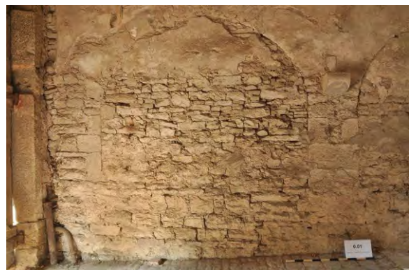
Foto 7: Durchfahrt (Raum 0.01, Wand d); Zustand vor Baumaßnahme.
