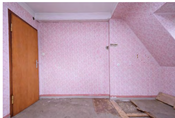
Foto 262: Raum 2.03, Wand b; Zustand vor Baumaßnahme.
