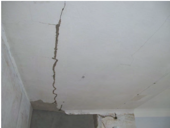
Foto 408: Raum 1.03, Wand a; Putzergänzungen an Decke und Wand.
