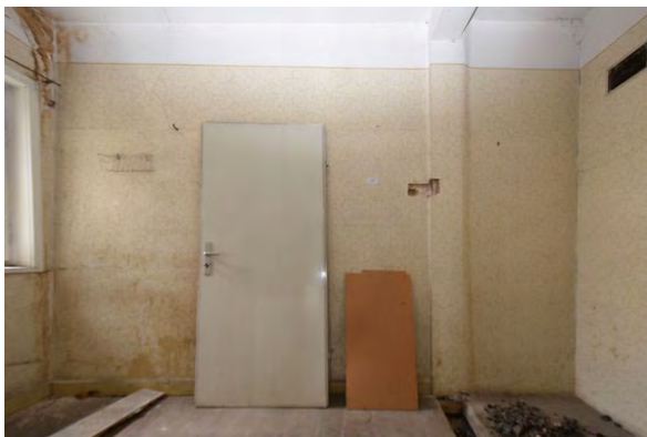
Foto 197: Raum 1.10, Wand a; Zustand vor Baumaßnahme.
