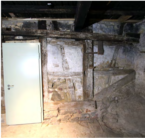
Foto 370: Raum 0.06, Wand c rechts; Endzustand.
