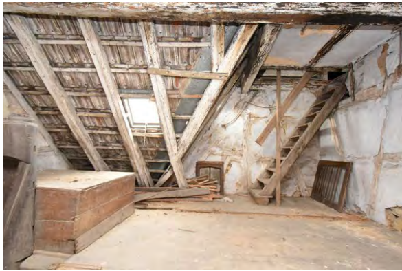
Foto 224: Raum 2.01, Wand a; Zustand vor Baumaßnahme.
