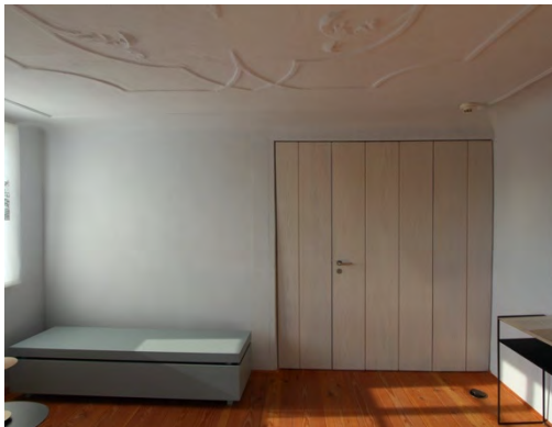
Foto 529: Raum 2.04, Wand d; Endzustand.
