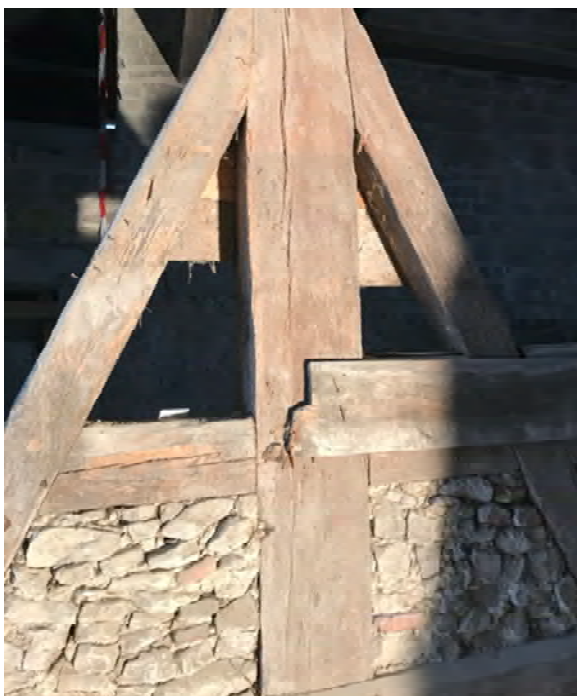
Foto 93: Raum 0.08, Wand d; Zustand vor Restaurierung.
