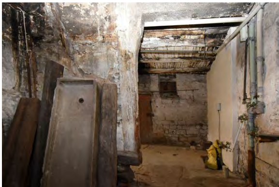
Foto 63: Raum 0.05, Wand a; Zustand vor Baumaßnahme.
