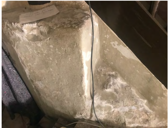
Foto 316: Raum 0.02, Wand a; gesicherte Fassungenlagen.
