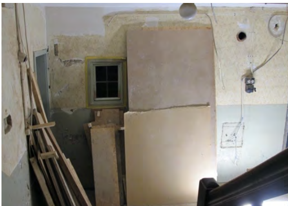
Foto 28: Raum 0.02, Wand b; Zustand vor Restaurierung.
