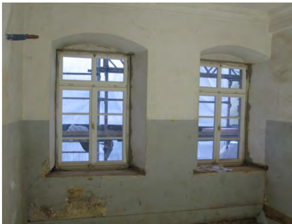
Foto 54: Raum 0.04, Wand c; Zustand vor Restaurierung.
