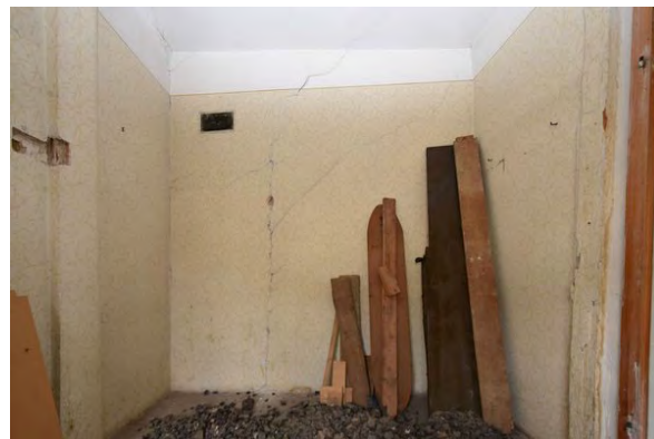
Foto 198: Raum 1.10, Wand b; Zustand vor Baumaßnahme.
