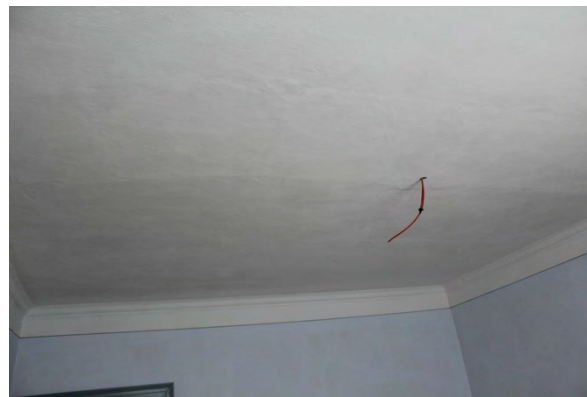
Foto 404: Raum 1.02, Decke; Endzustand.
