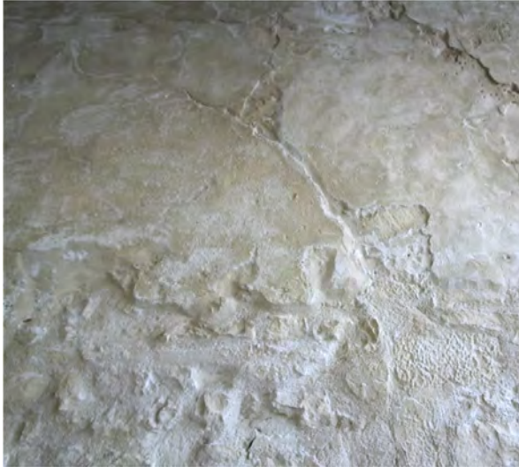
Foto 299: Raum 0.01; Wand d; Wandfläche mit neu aufgebrachtener Kalkschlämme.
