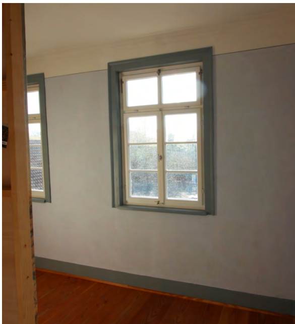
Foto 414: Raum 1.03, Wand c rechts; Endzustand.
