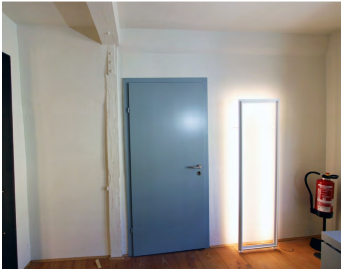
Foto 462: Raum 1.10, Wand c; Endzustand.
