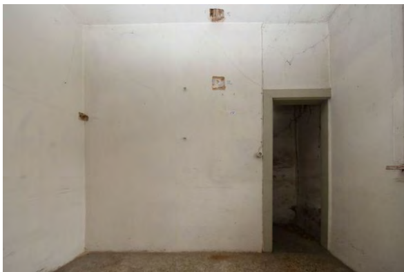
Foto 173: Raum 1.07, Wand a; Zustand vor Baumaßnahme.
