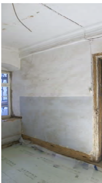
Foto 56: Raum 0.04, Wand d; Zustand vor Restaurierung.
