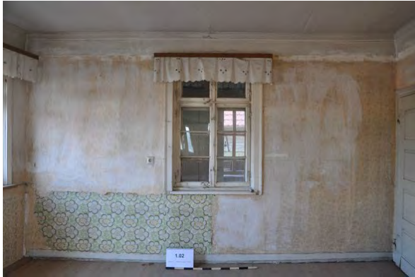
Foto 113: Raum 1.02, Wand a; Zustand vor Baumaßnahme.
