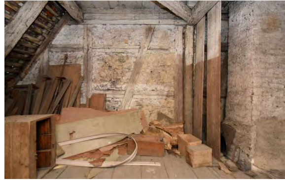
Foto 283: Raum 2.05, Wand d; Zustand vor Baumaßnahme.
