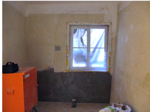
Foto 204: Raum 1.10, Wand d; Zustand vor Restaurierung.
