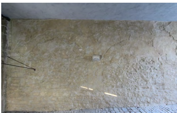
Foto 301: Raum 0.01, Wand d links; Endzustand.
