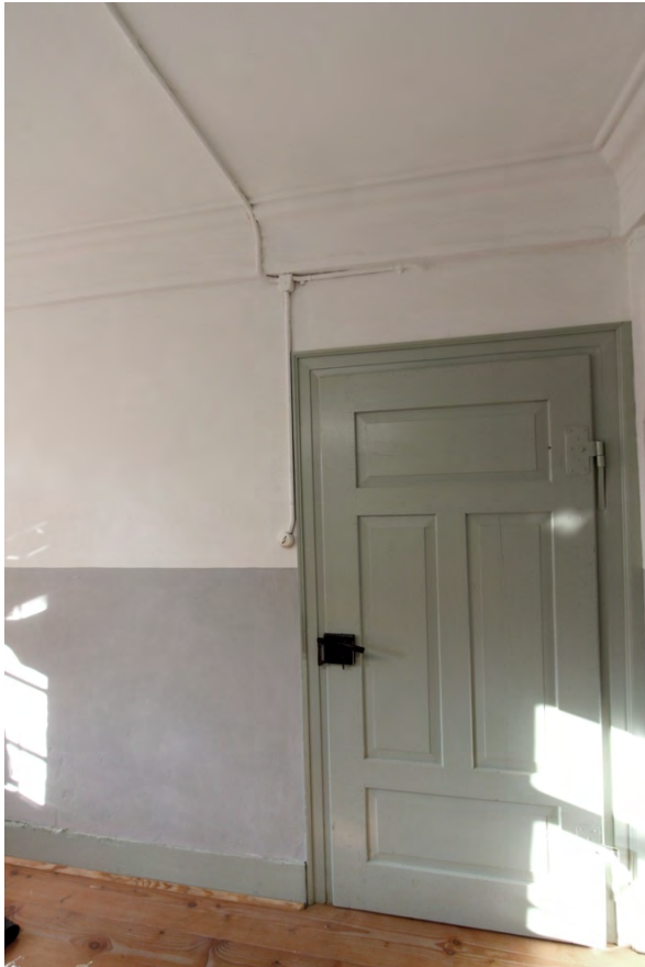
Foto 347: Raum 0.04, Wand d; Endzustand.
