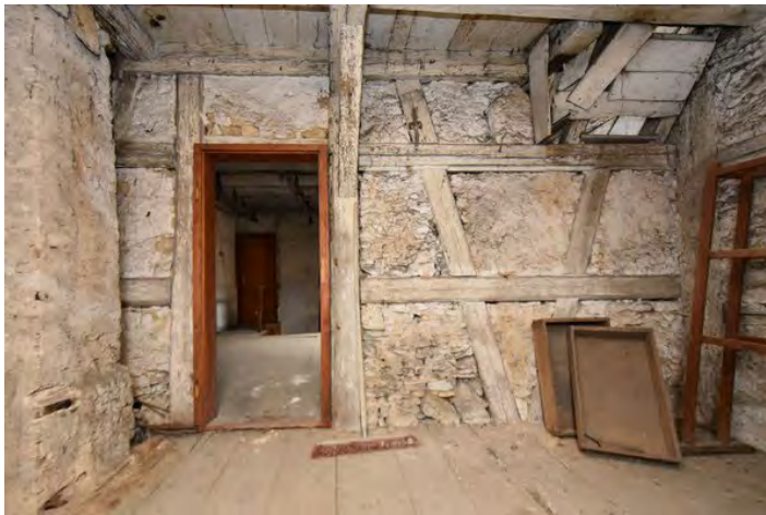
Foto 284: Raum 2.05, Wand d; Zustand vor Baumaßnahme.
