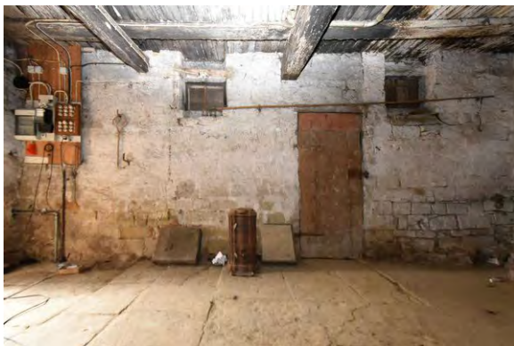
Foto 75: Raum 0.06, Wand a; Zustand vor Baumaßnahme.
