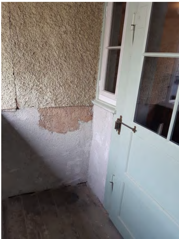
Foto 466: Raum 1.11, Wand b; Grundputz auf Fehlstelle.
