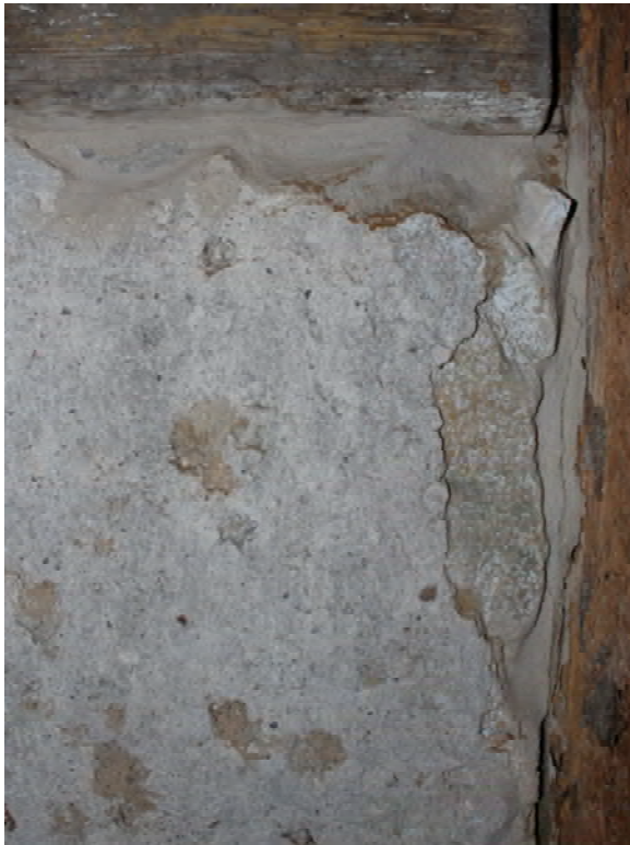
Foto 534: Raum 2.05, Wand d; Randsicherung und Ergänzung.
