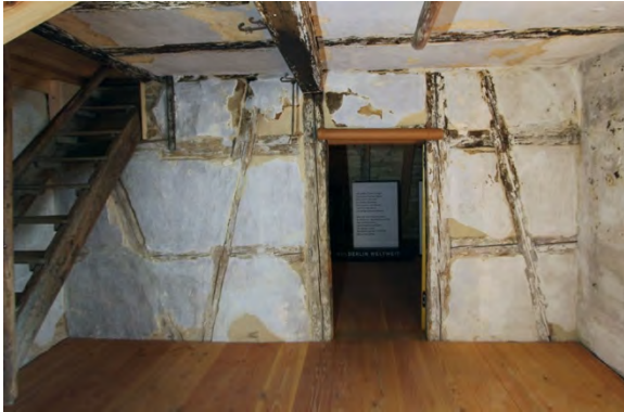
Foto 496: Raum 2.01, Wand b; Endzustand.
