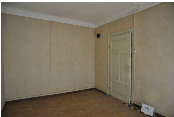
Foto 41: Raum 0.03, Wand a und b; Zustand vor Bau- maßnahme.
