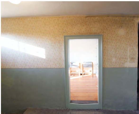
Foto 329: Raum 0.02, Wand d; Endzustand.
