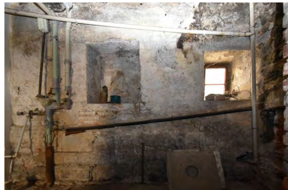
Foto 64: Raum 0.05, Wand b; Zustand vor Baumaßnahme.
