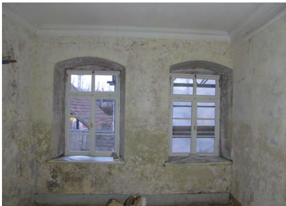
Foto 341: Raum 0.04, Wand c; nach Fassungsabnahme.
