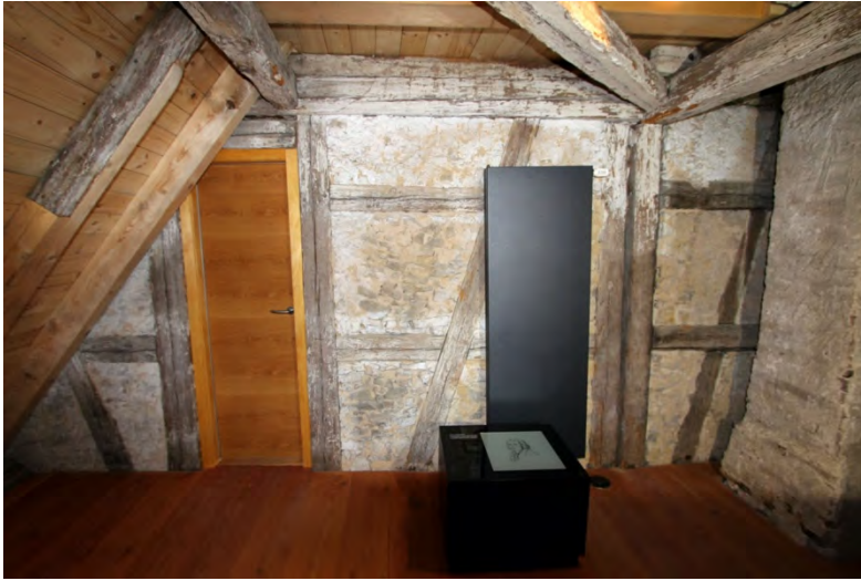
Foto 536: Raum 2.05, Wand d; Endzustand.
