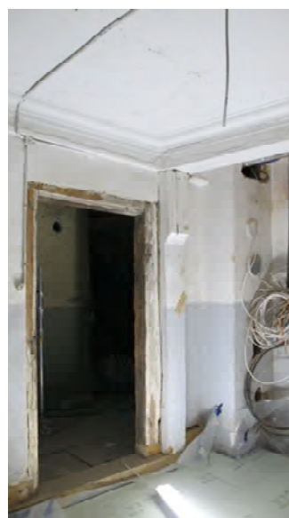
Foto 57: Raum 0.04, Wand d; Zustand vor Restaurierung.
