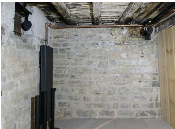
Foto 368: Raum 0.06, Wand b; Endzustand.
