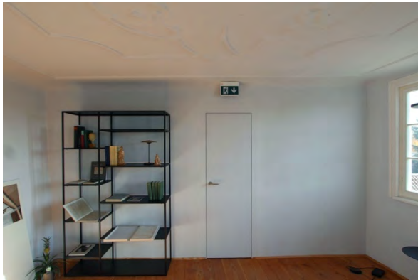
Foto 527: Raum 2.04, Wand b; Endzustand.
