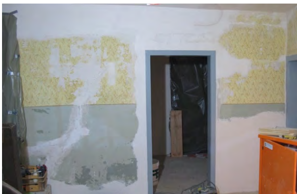
Foto 382: Raum 1.01, Wand a; Zustand nach der Ergänzung der Fehlstellen.
