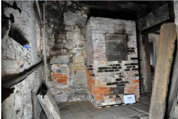
Foto 65: Raum 0.05, Wand c; Zustand vor Baumaßnahme.
