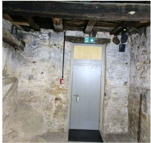
Foto 371: Raum 0.06, Wand d; Endzustand.
