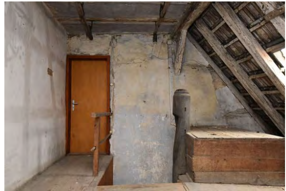
Foto 227: Raum 2.01, Wand d; Zustand vor Baumaßnahme.
