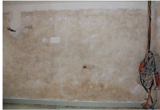
Foto 335: Wand d; Zwischenzustand nach Schimmelbehandlung und Fehlstellenergänzung.
