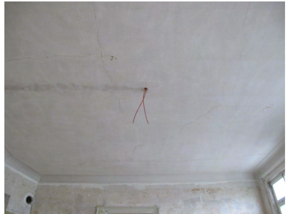
Foto 144: Raum 1.04, Decke; nach Abnahme der Tapete.
