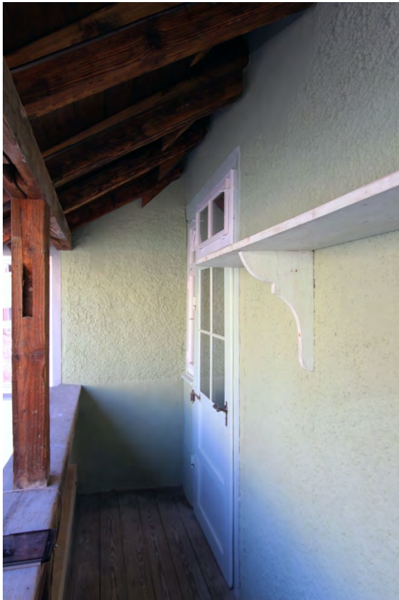
Foto 472: Raum 1.11, Wand b und c; Endzustand.
