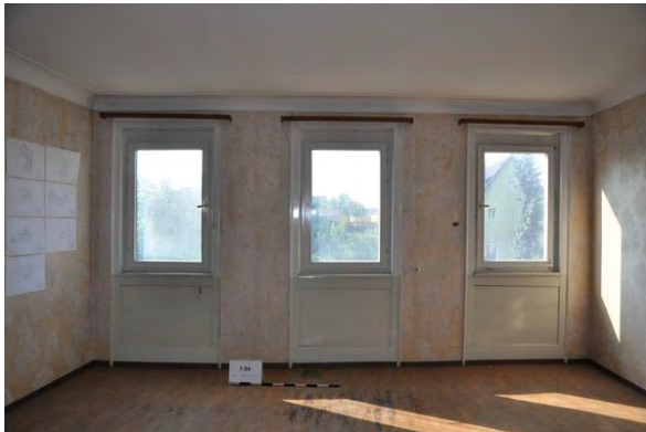
Foto 139: Raum 1.04, Wand c; Zustand vor Baumaßnahme.
