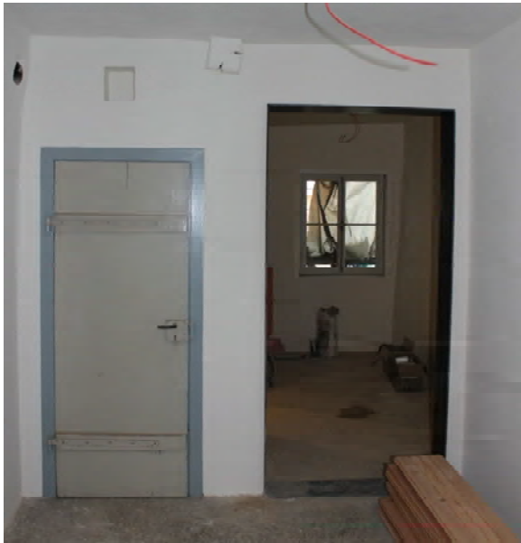
Foto 444: Raum 1.07/1.08, Wand d; Endzustand.
