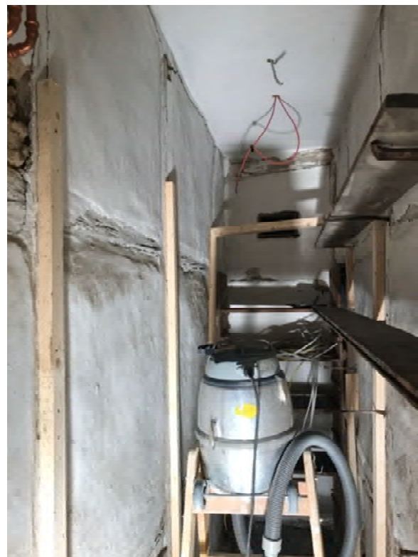
Foto 450: Raum 1.09, Wand a, c und d; Zustand nach der Reinigung.
