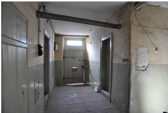
Foto 22: Raum 0.02, Wand c; Zustand vor Baumaßnahme.
