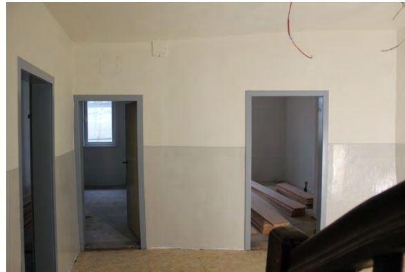
Foto 387: Raum 1.01, Wand b; Endzustand.
