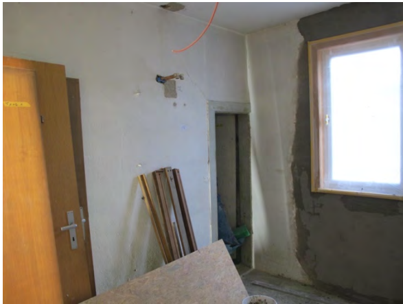
Foto 178: Raum 1.07, Wand b; Zustand vor Restaurierung.
