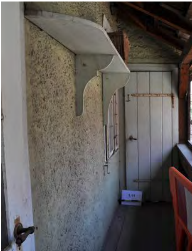
Foto 210: Raum 1.11, Wand c und d; Zustand vor Baumaßnahme.
