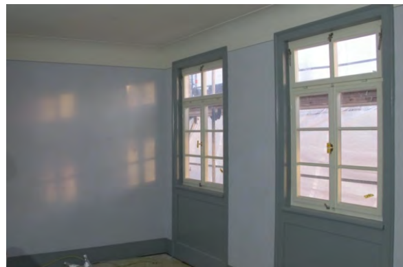
Foto 418: Raum 1.04, Wand b und c; Endzustand.
