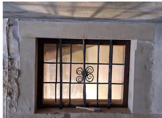
Foto 298: Raum 0.01, Wand b; Fehlstellenergänzung um neu eingesetzten Fenstergewände.
