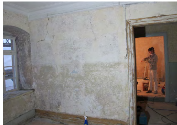
Foto 342: Raum 0.04, Wand d; nach Fassungsabnahme.
