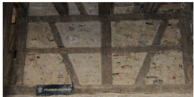
Foto 478: Raum 1.13, Wand b, rechts unten; Endzustand.
