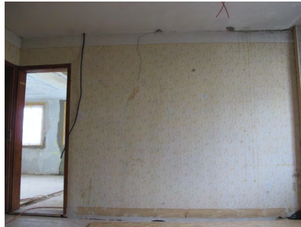
Foto 250: Raum 2.02, Wand c; Zustand vor Restaurierung.
