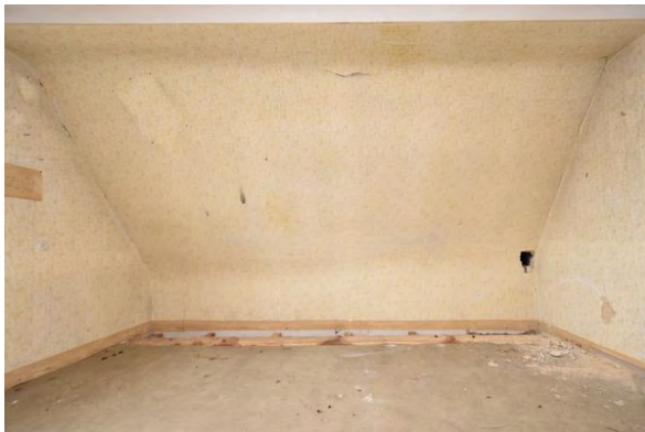
Foto 243: Raum 2.02, Wand a; Zustand vor Baumaßnahme.
