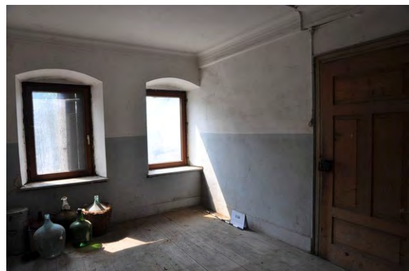
Foto 51: Raum 0.04, Wand c und d; Zustand vor Baumaßnahme.
