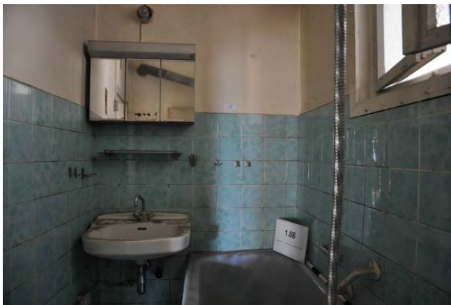
Foto 177: Raum 1.08, Wand a, b und c; Zustand vor Baumaßnahme.
