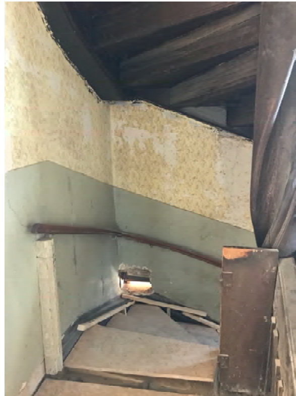
Foto 107: Raum 1.01, Wand d; Zustand vor Restaurierung.
