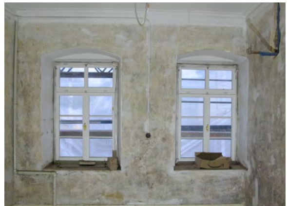
Foto 46: Raum 0.03, Wand c; nach Entfernung der Tapete.
