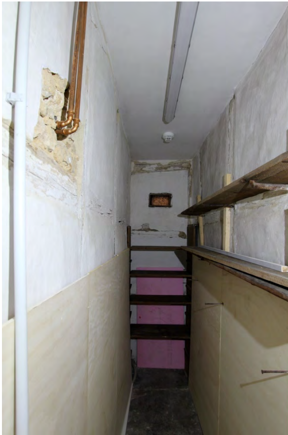
Foto 455: Raum 1.09, Wand a, c und d; Endzustand.
