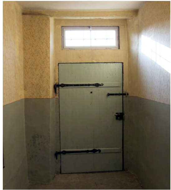
Foto 328: Raum 0.02, Wand c; Endzustand.
