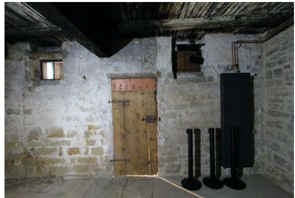
Foto 367: Raum 0.06, Wand a rechts; Endzustand.
