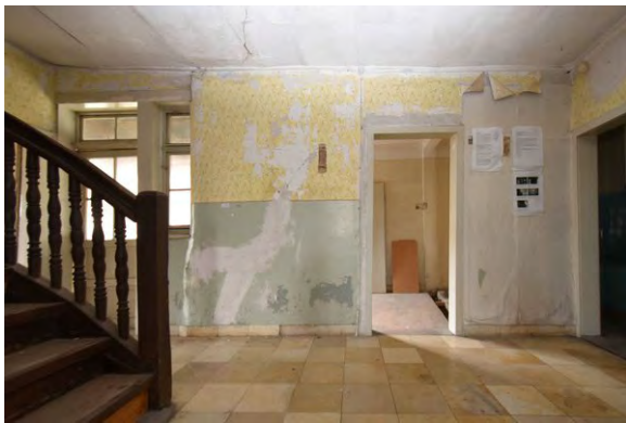
Foto 100: Raum 1.01, Wand a; Zustand vor Baumaßnahme.
