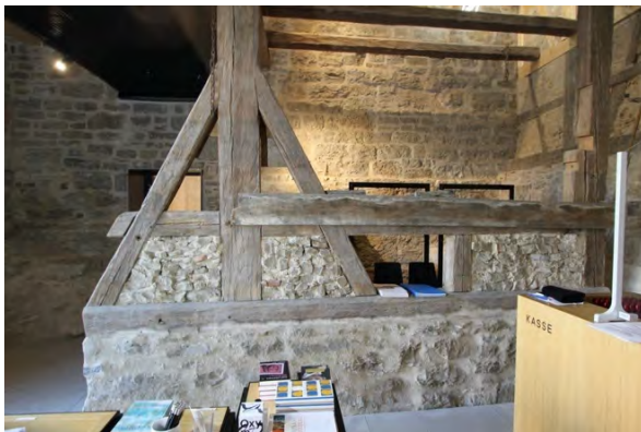
Foto 378: Raum 0.07, Wand a; Endzustand.
