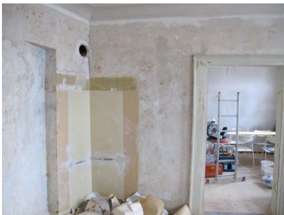
Foto 141: Raum 1.04, Wand a und b; nach Abnahme der Tapete.
