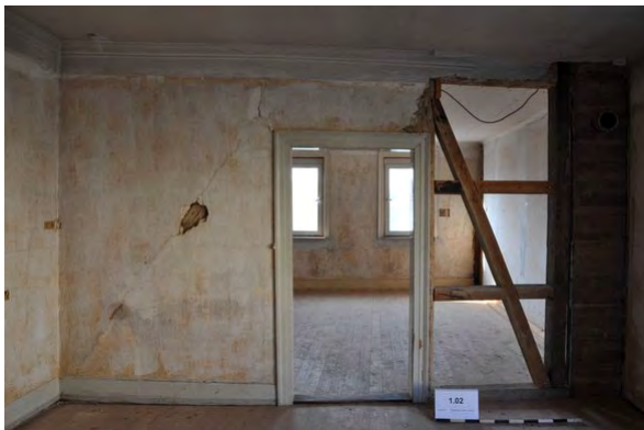
Foto 115: Raum 1.02, Wand c; Zustand vor Baumaßnahme.
