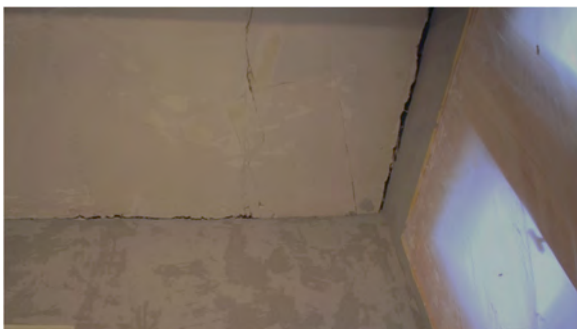
Foto 434: Raum 1.06, Wand b und c; großflächige Neuputzflächen und Vorzustand Decke.
