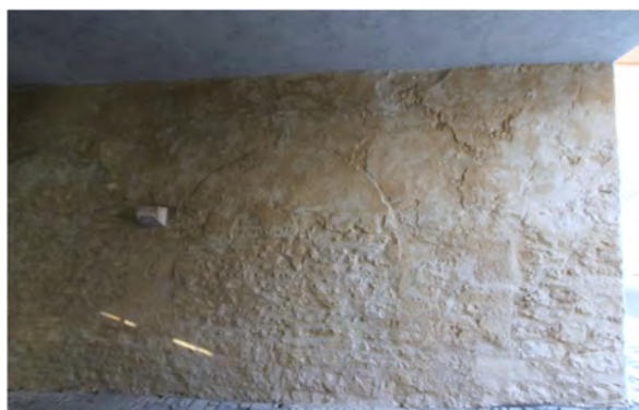
Foto 302: Raum 0.01, Wand d rechts; Endzustand.
