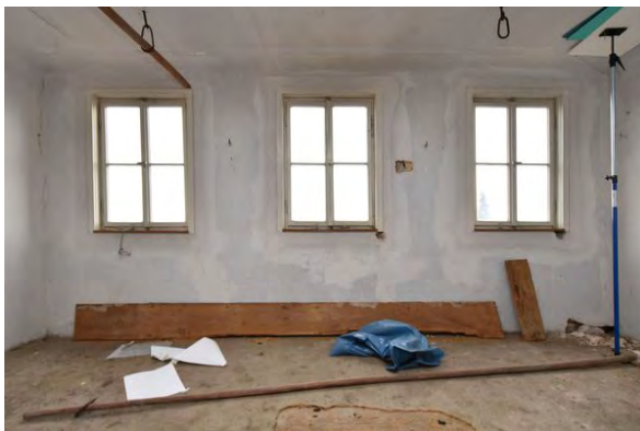
Foto 272: Raum 2.04, Wand c; Zustand vor Baumaßnahme.
