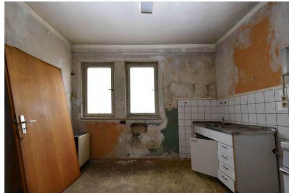
Foto 162: Raum 1.06, Wand b; Zustand vor Baumaßnahme.
