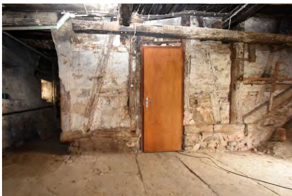
Foto 77: Raum 0.06, Wand c; Zustand vor Baumaßnahme.
