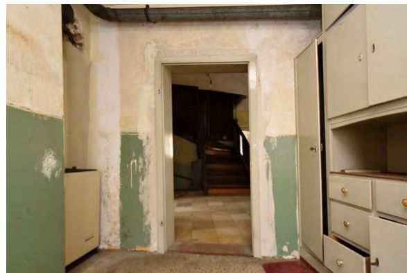
Foto 164: Raum 1.06, Wand d; Zustand vor Baumaßnahme.
