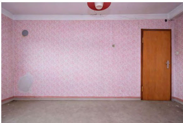
Foto 261: Raum 2.03, Wand a; Zustand vor Baumaßnahme.
