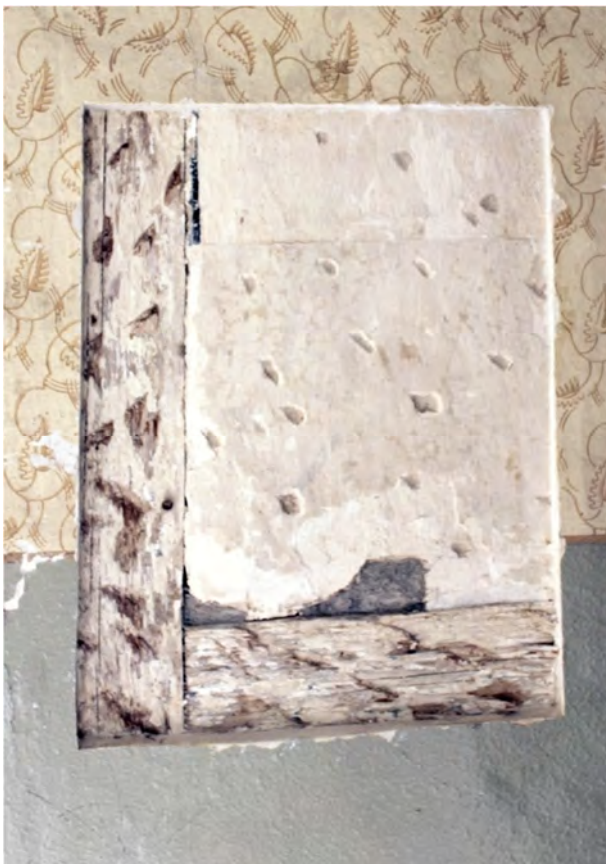
Foto 317: Raum 0.02, Wand c; überarbeitete Sondage, Zwischenzustand.
