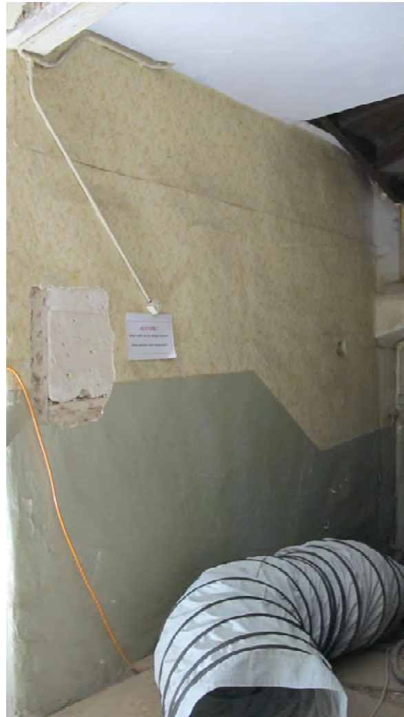
Foto 31: Raum 0.02, Wand c; Zustand vor Restaurierung.
