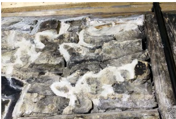
Foto 352: Raum 0.05, Wand a; gesichertes Mauerwerk.
