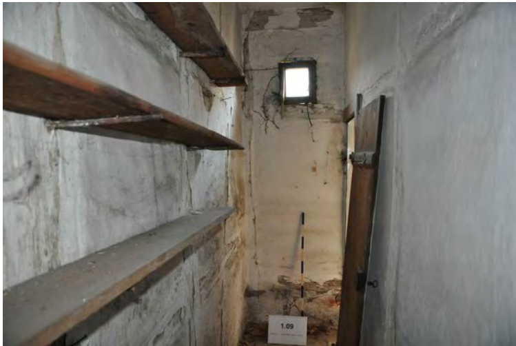
Foto 187: Raum 1.09, Wand b, c und d; Zustand vor Baumaßnahme.
