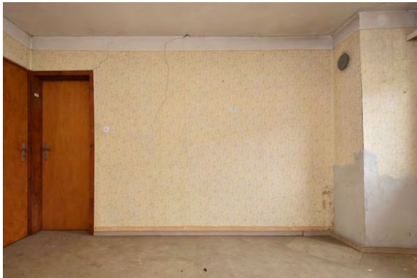
Foto 245: Raum 2.02, Wand c; Zustand vor Baumaßnahme.
