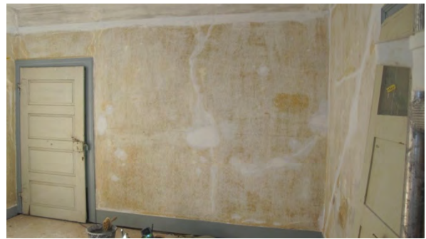
Foto 398: Raum 1.02, Wand b; ergänzte Fehlstellen in Wand und Stuck.
