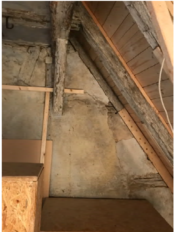
Foto 231: Raum 2.01, Wand d; Zustand vor Restaurierung.
