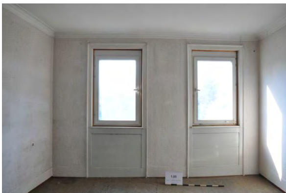
Foto 152: Raum 1.05, Wand c; Zustand vor Baumaßnahme.
