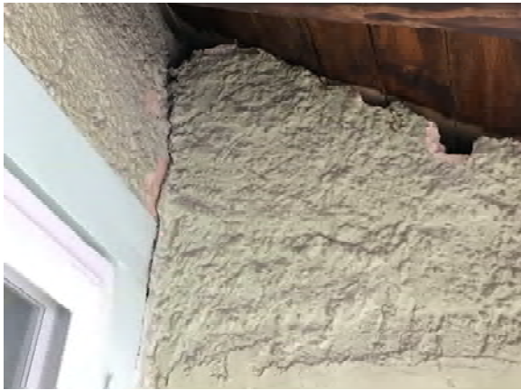
Foto 468: Raum 1.11, Wand c und d; Vorzustand.
