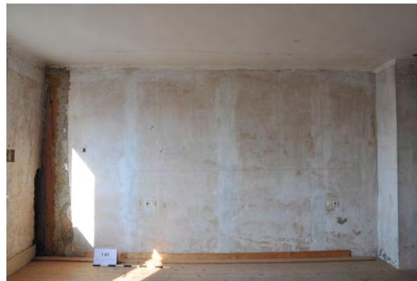
Foto 129: Raum 1.03, Wand d; Zustand vor Baumaßnahme.
