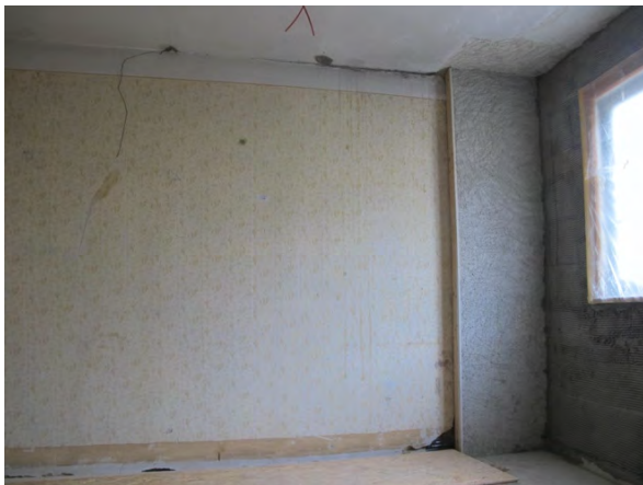
Foto 251: Raum 2.02, Wand c; Zustand vor Restaurierung.
