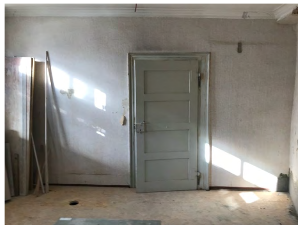
Foto 157: Raum 1.05, Wand d; Zustand vor Restaurierung.
