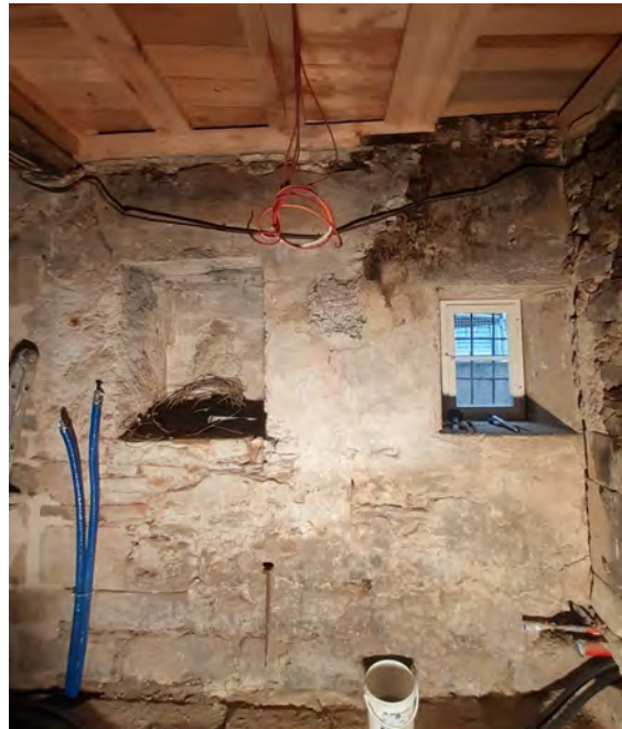
Foto 69: Raum 0.05, Wand b; Vorzustand.
