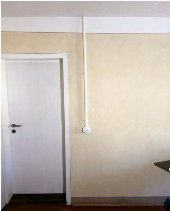
Foto 506: Raum 2.02, Wand b; Endzustand.
