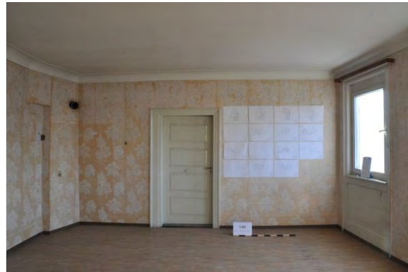
Foto 138: Raum 1.04, Wand b; Zustand vor Baumaßnahme.
