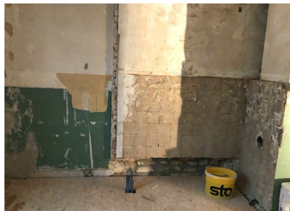
Foto 166: Raum 1.06, Wand c; Zustand vor Restaurierung.
