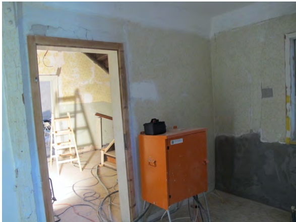
Foto 203: Raum 1.10, Wand c und d; Zustand vor Restaurierung.
