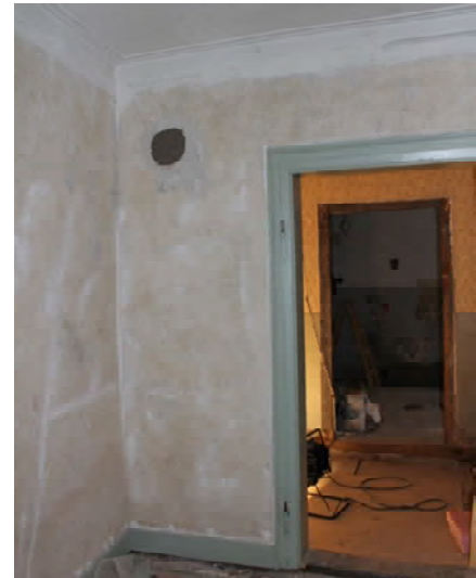
Foto 337: Raum 0.03, Wand b; ergänzte Fehlstellen und Risse.
