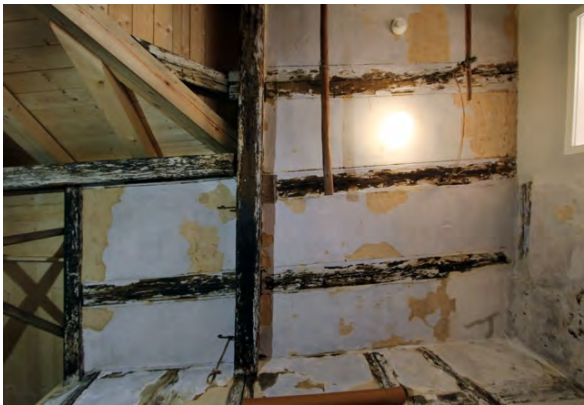
Foto 499: Raum 2.01, Decke; Endzustand.
