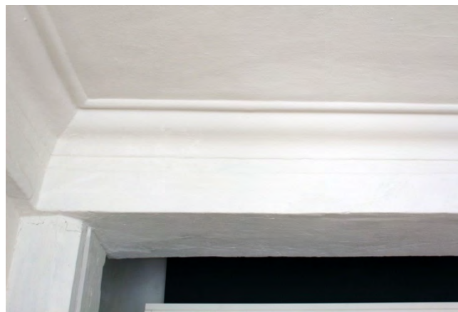
Foto 346: Raum 0.04, Decke; Endzustand.
