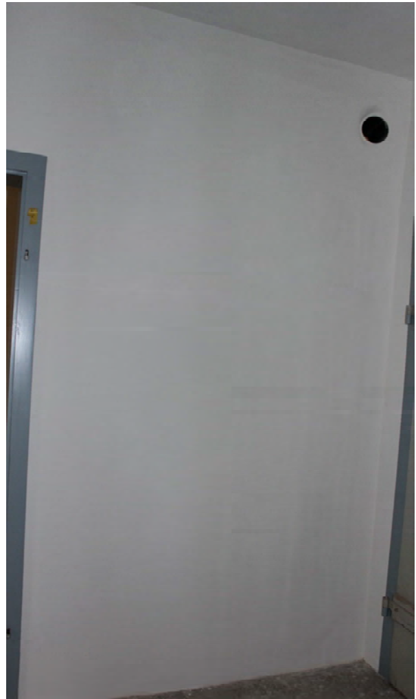
Foto 443: Raum 1.07/1.08, Wand c; Endzustand.
