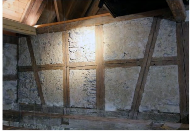
Foto 480: Raum 1.13, Wand d links; Endzustand.
