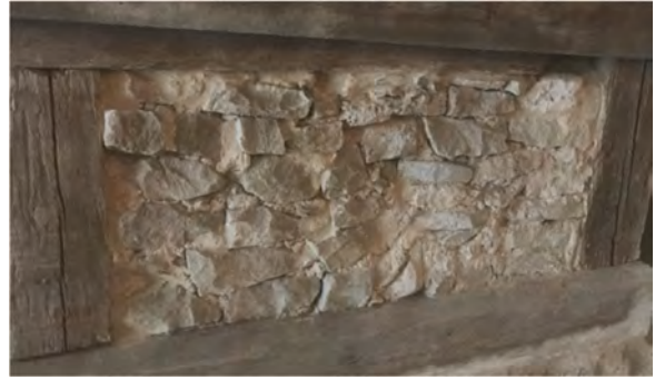
Foto 377: Raum 0.08, Wand a; Endzustand Ausfachung.
