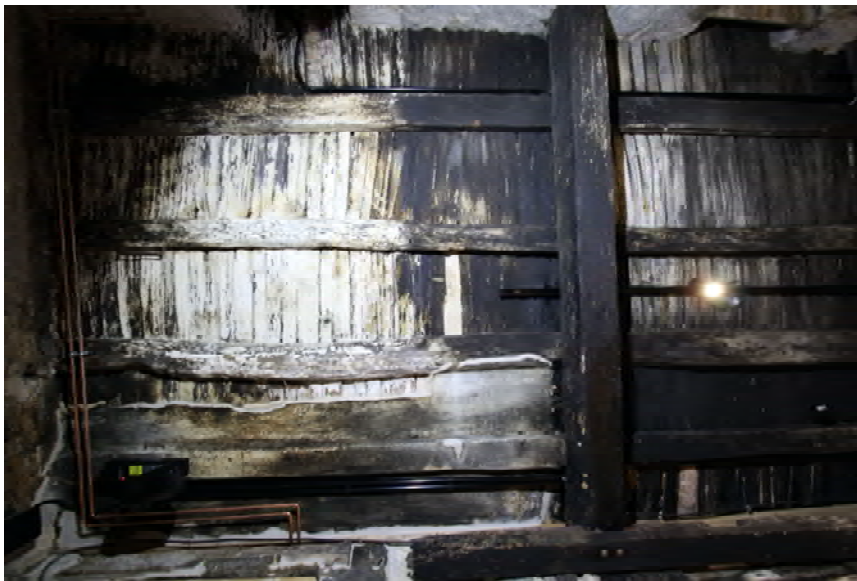
Foto 372: Raum 0.06, Decke; Endzustand.
