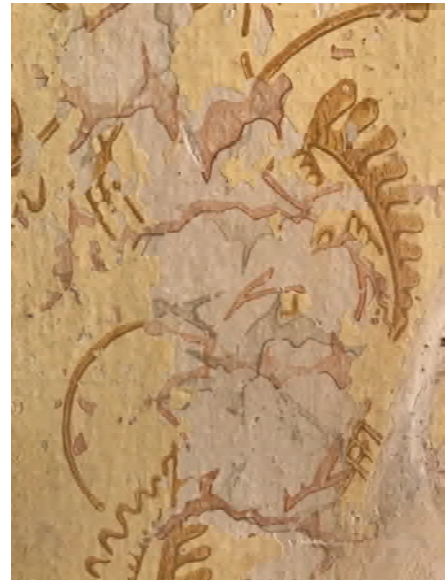
Foto 111: Raum 1.01, Wand b; Befundstelle. Walzendekor unter der jüngeren Sichtfassung.
