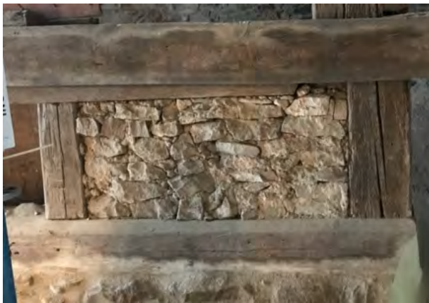
Foto 97: Raum 0.08, Wand d; Gefach mit loser Vermörtelung.
