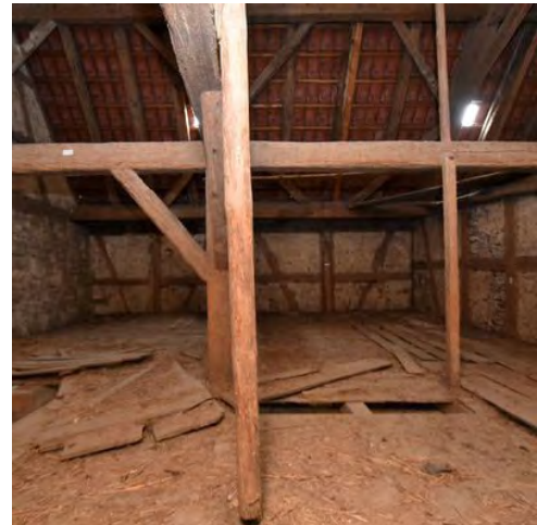
Foto 289: Raum 2.08, Wand b; Zustand vor Baumaßnahme.
