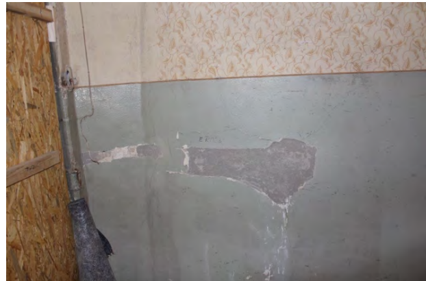
Foto 308: Raum 0.02, Wand d; Fehlstellen mit Grundputz-antragung.
