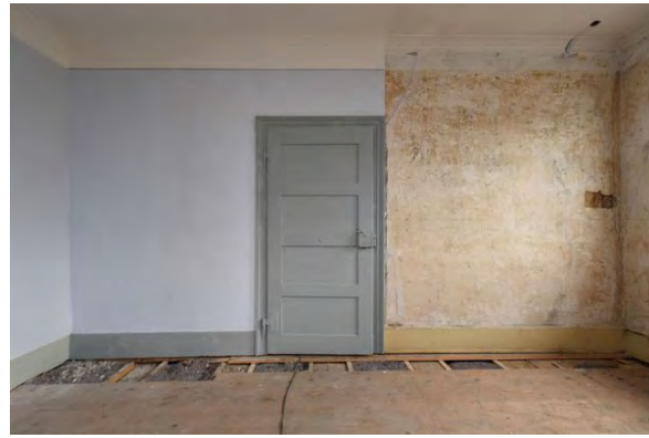
Foto 127: Raum 1.03, Wand b; Zustand vor Baumaßnahme.
