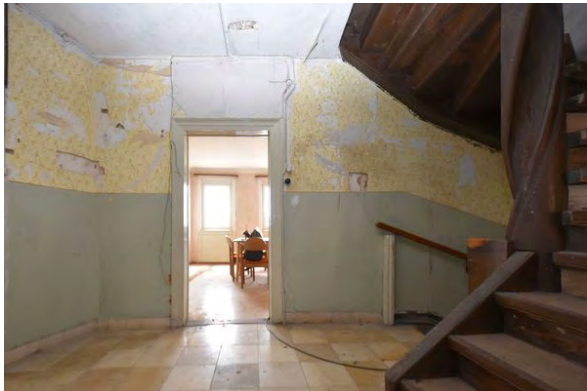
Foto 102: Raum 1.01, Wand c; Zustand vor Baumaßnahme.
