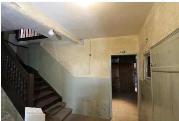
Foto 325: Raum 0.02, Wand a; Endzustand.
