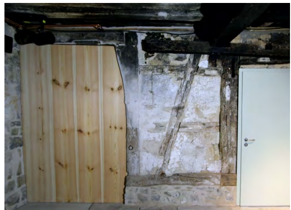
Foto 369: Raum 0.06, Wand c links; Endzustand.
