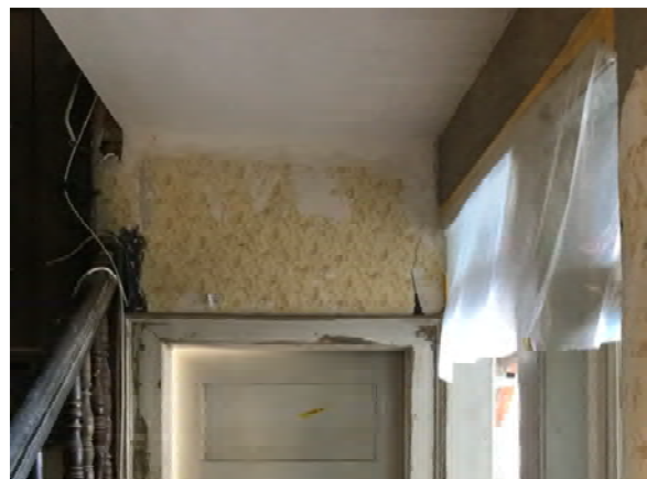
Foto 109: Raum 1.01, Wand d; Zustand vor Restaurierung
