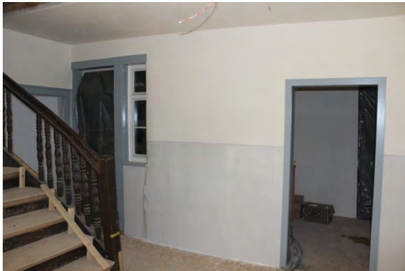
Foto 386: Raum 1.01, Wand a; Endzustand.
