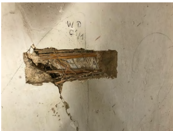
Foto 240: Raum 2.01, Wand c; alte Sondage.
