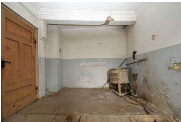
Foto 50: Raum 0.04, Wand a und b; Zustand vor Baumaßnahme.
