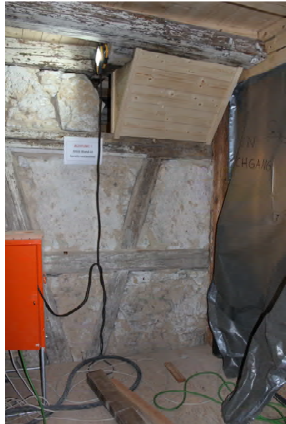
Foto 540: Raum 2.05, Wand d; rechts Endzustand.
