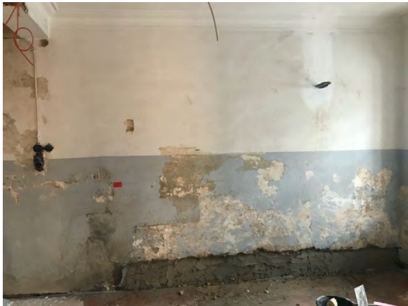
Foto 343: Raum 0.04, Wand b; Entfernte Zementputzfläche mit Grundputzauftrag.
