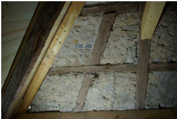
Foto 294: Raum 2.08, Wand d; Zustand vor Restaurierung.
