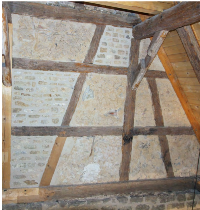
Foto 549: Raum 2.06, Wand a unten rechts; Endzustand.
