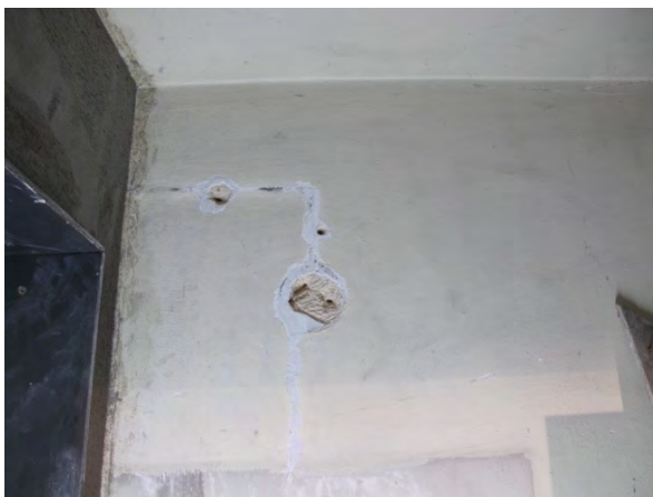
Foto 182: Raum 1.08, Wand b; nach Entfernung alter Elektroleitungen.
