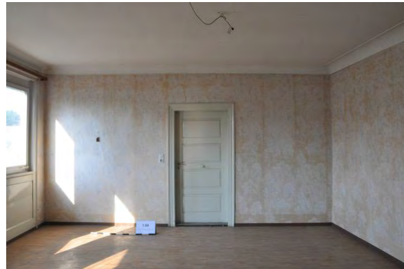
Foto 140: Raum 1.04, Wand d; Zustand vor Baumaßnahme.
