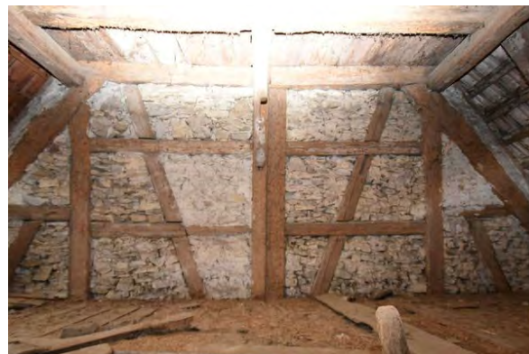
Foto 291: Raum 2.08, Wand c oben; Zustand vor Baumaßnahme.
