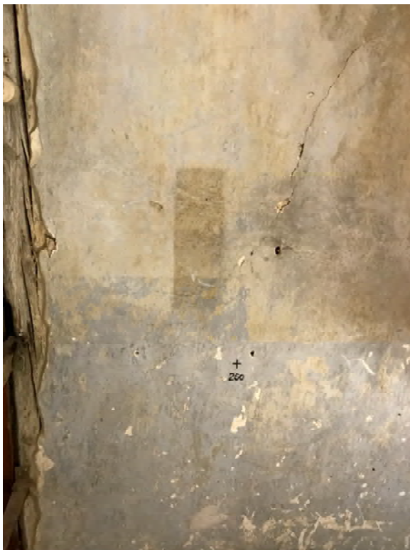
Foto 484: Raum 2.01, Wand d; Reinigungsmuster.
