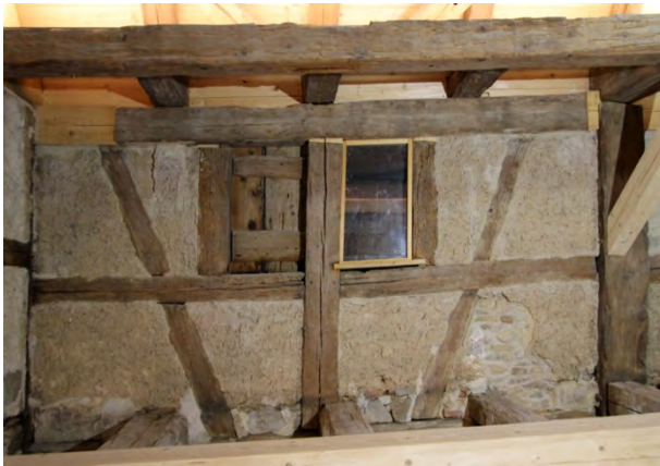
Foto 481: Raum 1.13, Wand d links; Endzustand.
