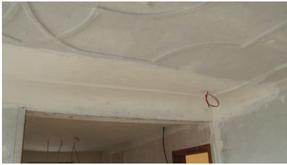
Foto 523: Raum 2.04, Decke; Ergänzung.
