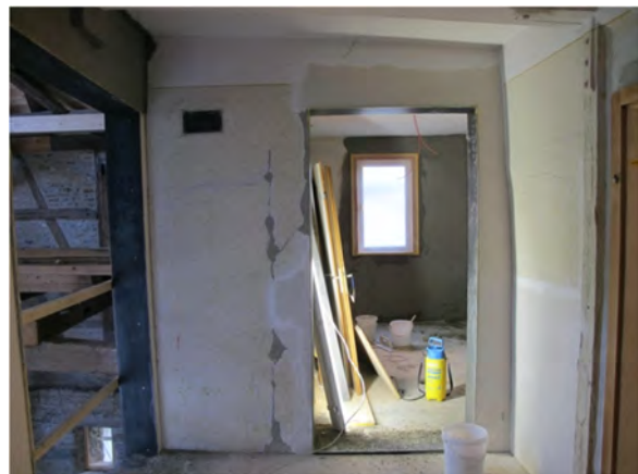
Foto 202: Raum 1.10, Wand b; Zustand vor Restaurierung.
