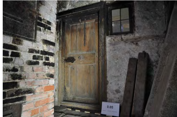
Foto 66: Raum 0.05, Wand d; Zustand vor Baumaßnahme.
