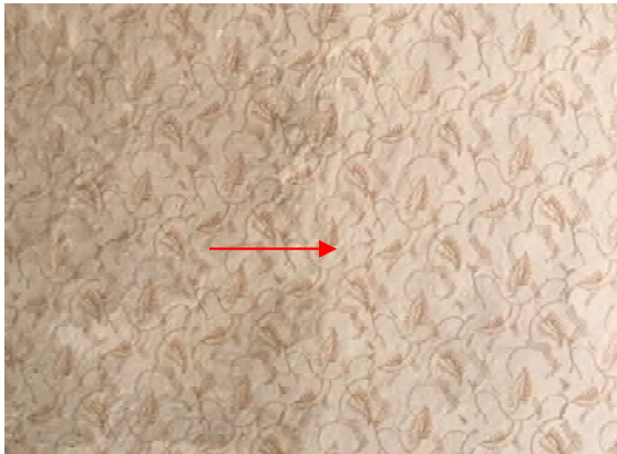
Foto 307: Raum 0.02, Wand d; Reinigungsmuster.
