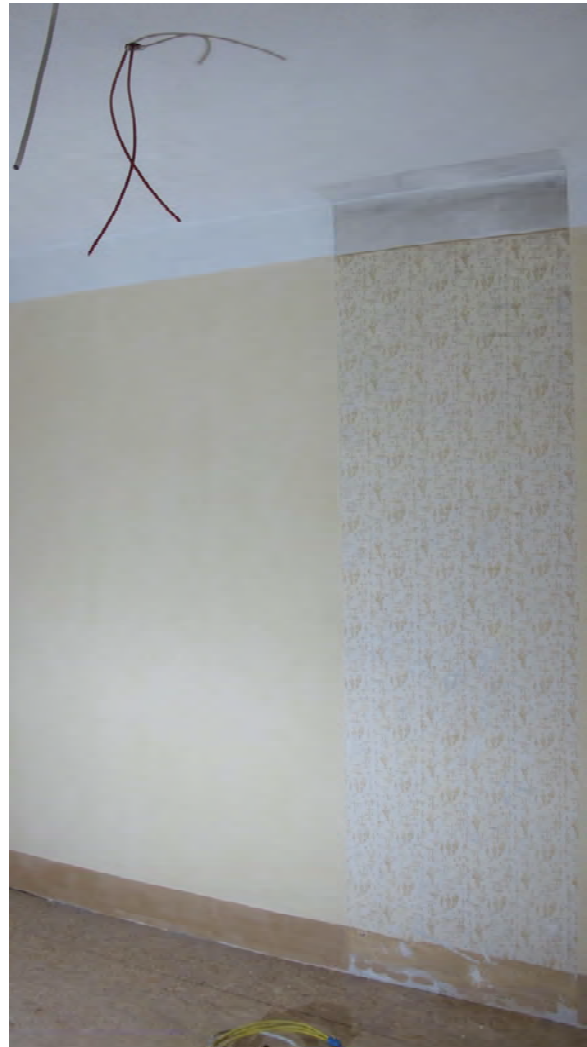
Foto 505: Raum 2.02, Wand c; Neufassung mit "Fenster in die Vergangenheit".
