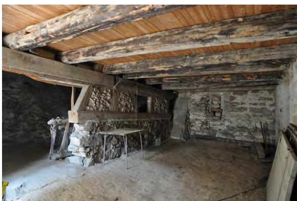
Foto 89: Raum 0.08, Wand a und d; Zustand vor Baumaßnahme.
