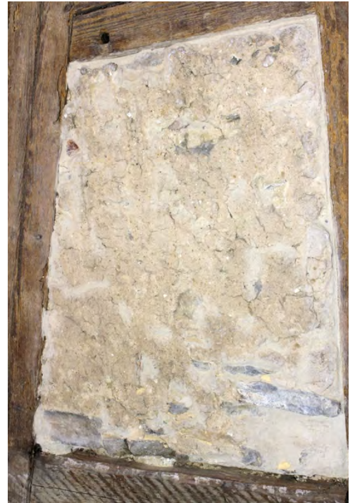
Foto 476: Raum 1.13, Wand a; Randsicherungen.
