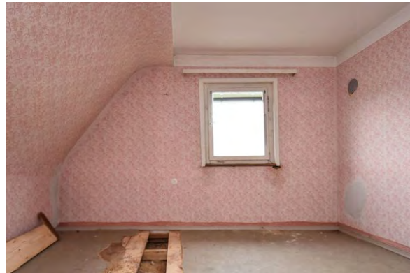
Foto 264: Raum 2.03, Wand d; Zustand vor Baumaßnahme.
