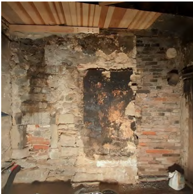
Foto 70: Raum 0.05, Wand c; Zustand vor Restaurierung.
