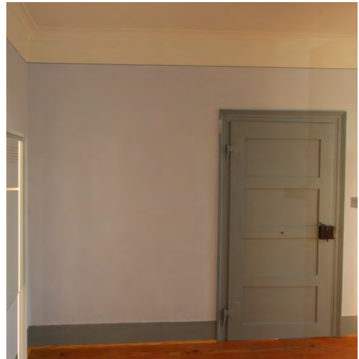
Foto 413: Raum 1.03, Wand b links; Endzustand.
