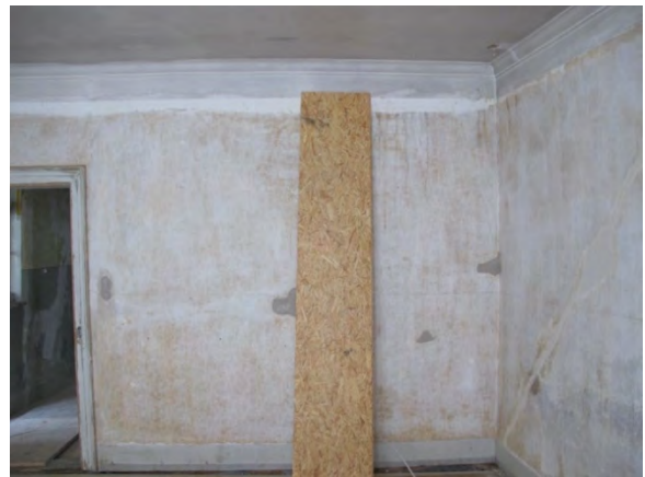
Foto 120: Raum 1.02, Wand b; Zustand vor Restaurierung.
