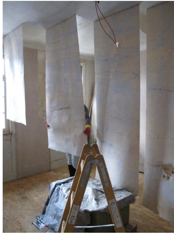
Foto 423: Raum 1.05, Decke; Abnahme der Tapeten.
