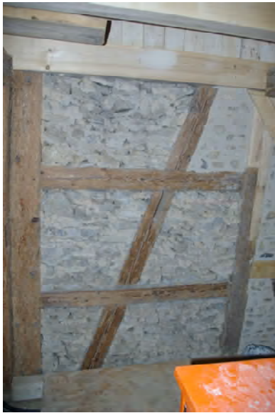
Foto 292: Raum 2.08, Wand c; Zustand vor Restaurierung.
