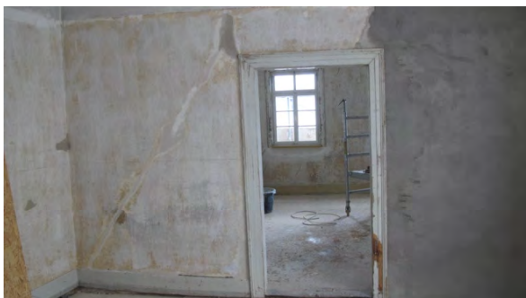
Foto 393: Raum 1.02, Wand c; Verputzte Neuaufmauerung und Putzergänzungen.
