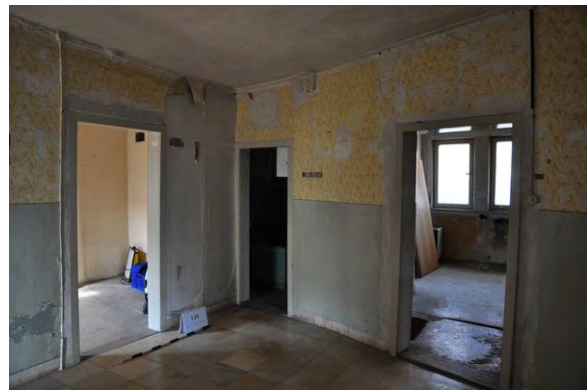
Foto 101: Raum 1.01, Wand b; Vorzustand.
