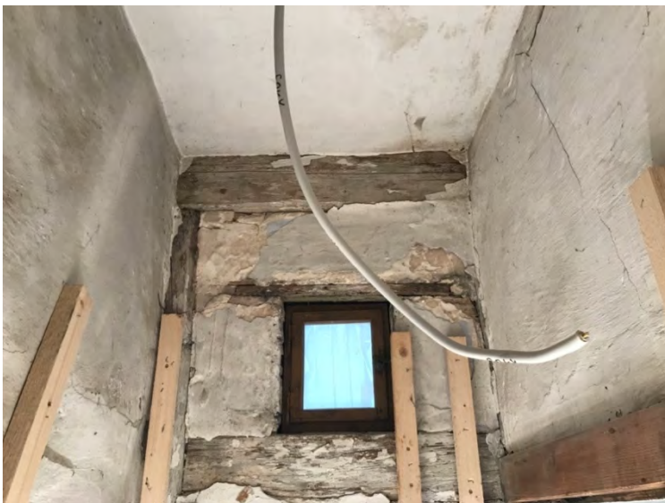
Foto 190: Raum 1.09, Wand b, c und d; Zustand nach Abnahme der Folie und vor Restaurierung.
