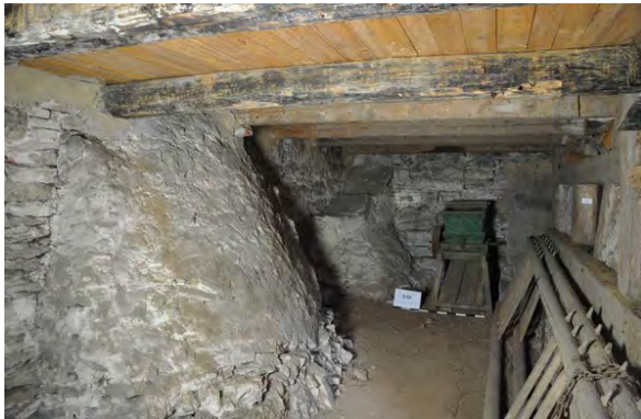
Foto 91: Raum 0.09, Wand a und b; Zustand vor Baumaßnahme.
