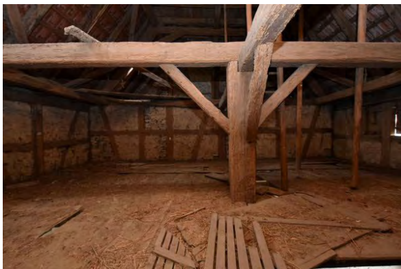
Foto 290: Raum 2.08, Wand c unten; Zustand vor Baumaßnahme.
