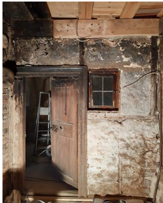
Foto 71: Raum 0.05, Wand d; Vorzustand.
