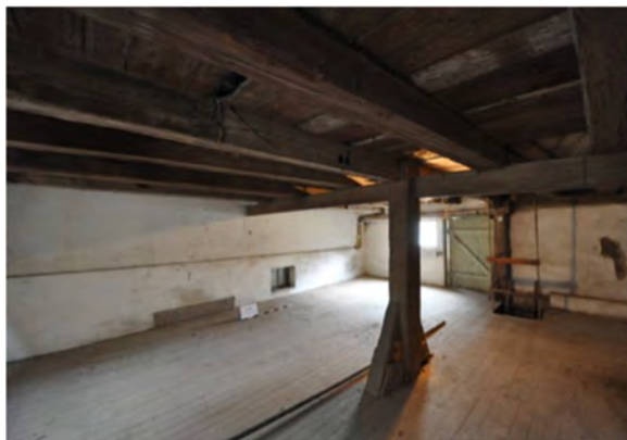
Foto 221: Raum 1.13, Wand a und b; Zustand vor Bau- maßnahmen.
