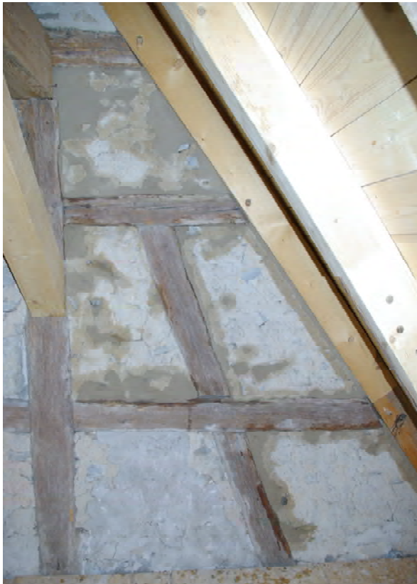
Foto 546: Raum 2.06, Wand a; Zwischenzustand.
