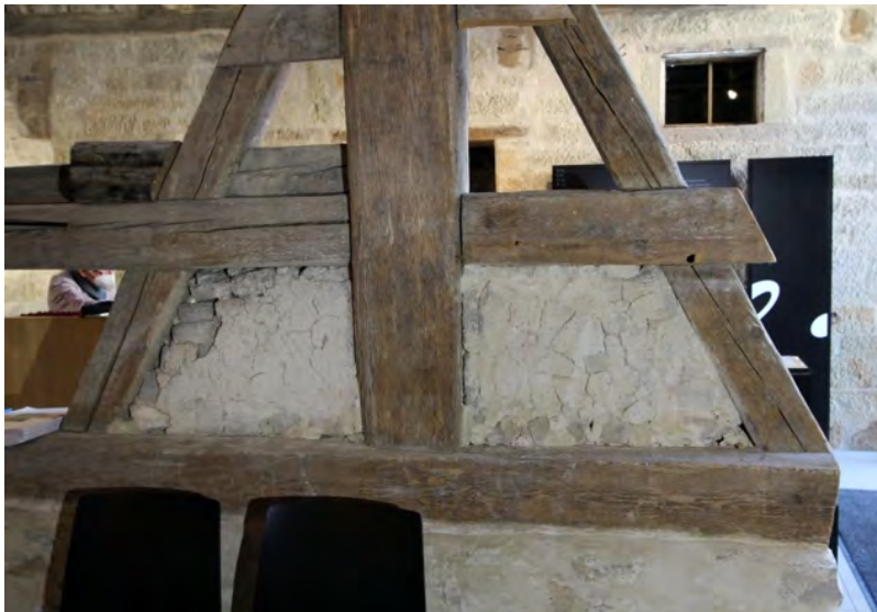
Foto 380: Raum 0.08, Wand c rechts; Endzustand.
