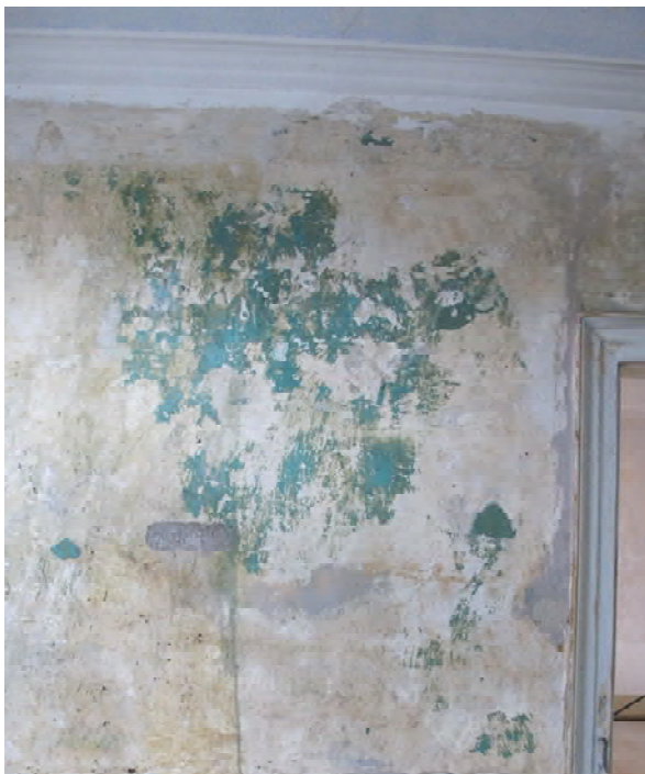
Foto 424: Raum 1.05, Wand d; Teilweise gereinigte Wandfläche mit grünen Fassungsresten und blauer Deckenfassung.
