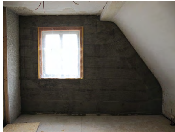
Foto 252: Raum 2.02, Wand d; Zustand vor Restaurierung.
