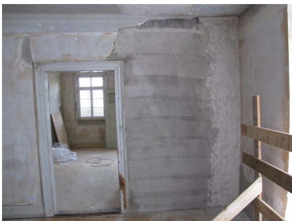
Foto 121: Raum 1.02, Wand c; Zustand vor Restaurierung.
