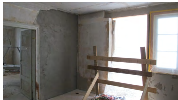
Foto 394: Raum 1.02, Wand c und d; Verputzte Neuaufmauerungen.
