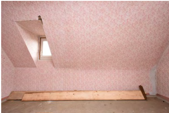
Foto 263: Raum 2.03, Wand c; Zustand vor Baumaßnahme.
