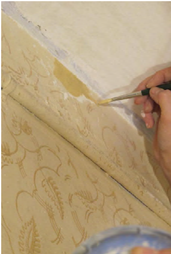
Foto 323: Raum 0.02; Zwischenzustand (Retusche).
