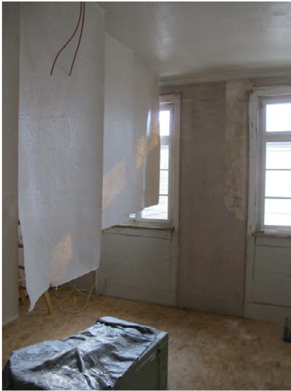
Foto 422: Raum 1.05, Decke; Zwischenzustand.
