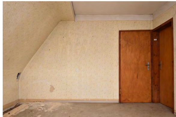
Foto 244: Raum 2.02, Wand b; Zustand vor Baumaßnahme.
