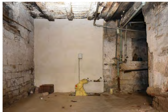
Foto 76: Raum 0.06, Wand b; Zustand vor Baumaßnahme.
