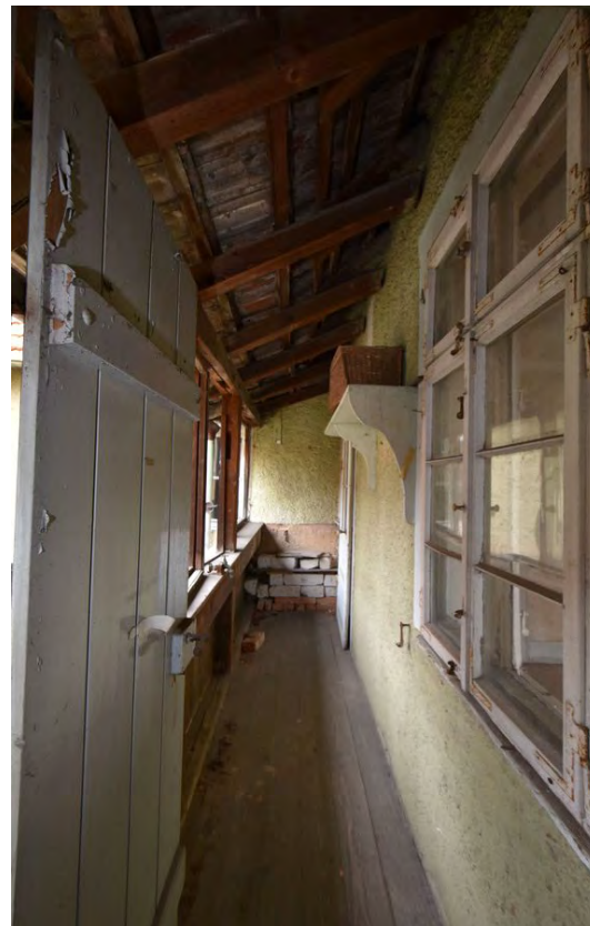
Foto 211: Raum 1.11, Wand b und c; Zustand vor Baumaßnahme.
