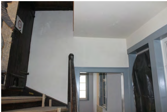
Foto 388: Raum 1.01, Wand d; Endzustand.
