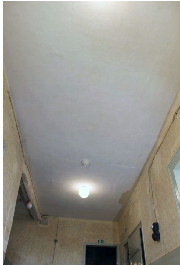
Foto 332: Raum 0.02, Decke; Endzustand.
