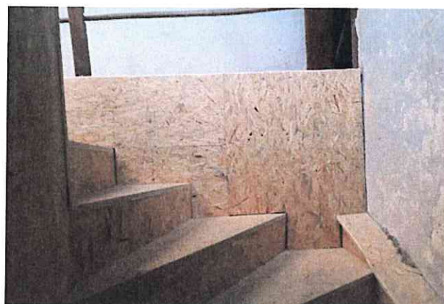
Treppenhaus mit OSB verkleidet
