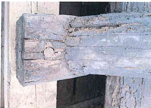
Deckenbalken sichern mit Holzdübel
