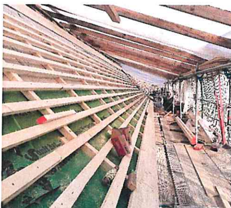
Dampfsperre, Konterlattung und Traglattung
