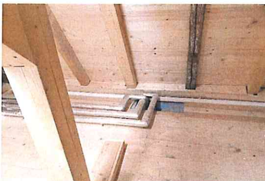
2. Lage Wechselfalz mit Folie
