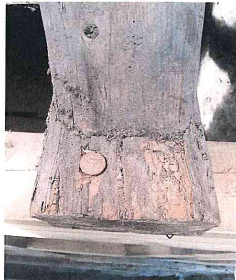
Deckenbalken sichern mit Holzdübel
