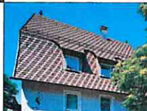
Ortgangausbildung der Kronendeckung mit „KLASSIK“ Ortgängen ¾ und 1 ¼. Max. Latsmaß hierbei 30 cm.
