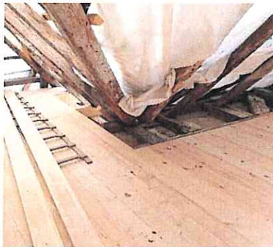
1. Lage Wechselfalz-Schalung
