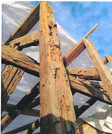
Deckenbalken sichern mit Holzdübel
