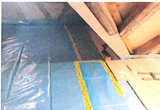
2. Lage Wechselfalz mit Folie
