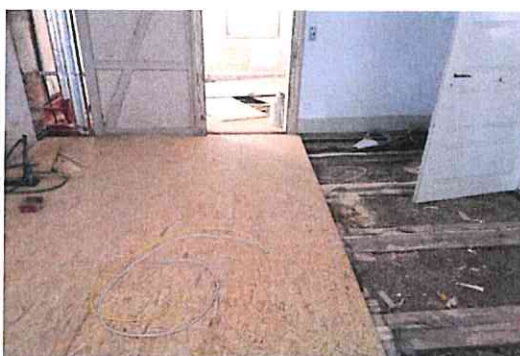
OSB-Platten 25 mm
