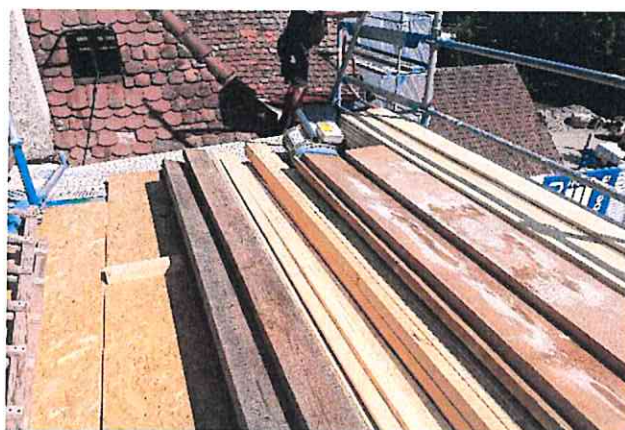
Herstellen eines Interimspodestes zum Material lagern
