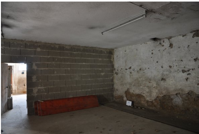
Raum 0.12cd, Diagonalaufnahme mit Blickrichtung Südwesten (strebewerk. 12.08.2015)
