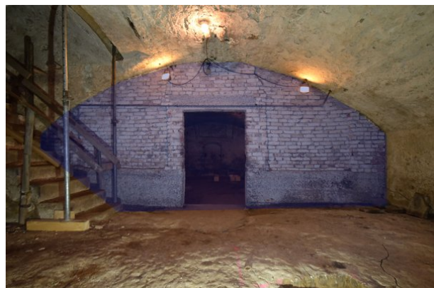
Frontalansicht Wand a, Raum -1.01, mit Blickrichtung Norden;
