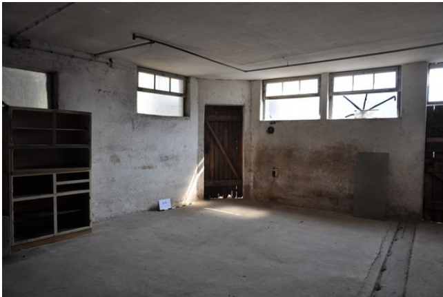
Raum 0.13bc, Diagonalaufnahme mit Blickrichtung Südosten (streberwerk. 12.08.2015)
