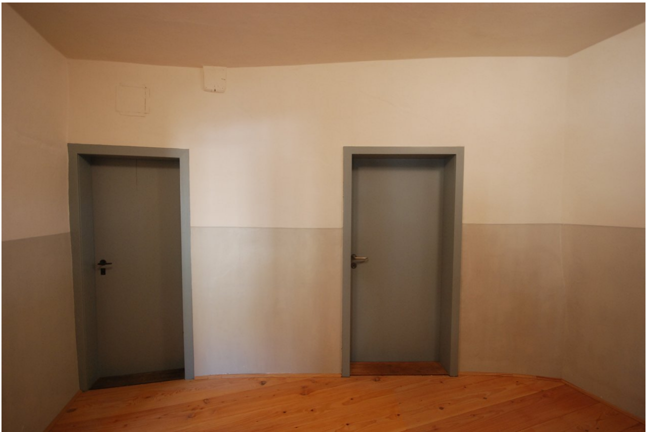
Ansicht fertig sanierte Wand
