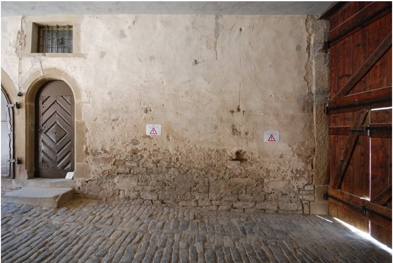
Ansicht der fertig sanierten Wand
