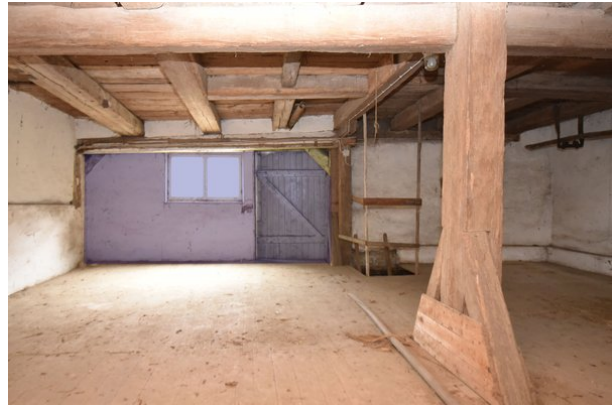
Frontalansicht Wand d, Raum 1.13, mit Blickrichtung Westen; Kartierung der zur Veränderung vorgesehenen Bereiche in blau;
