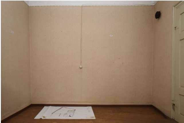
Frontalansicht Wand a, Raum 0.03, mit Blickrichtung Norden;
