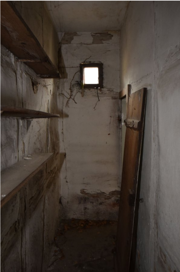
Frontalansicht Wand b, Raum 1.09, mit Blickrichtung Osten;
