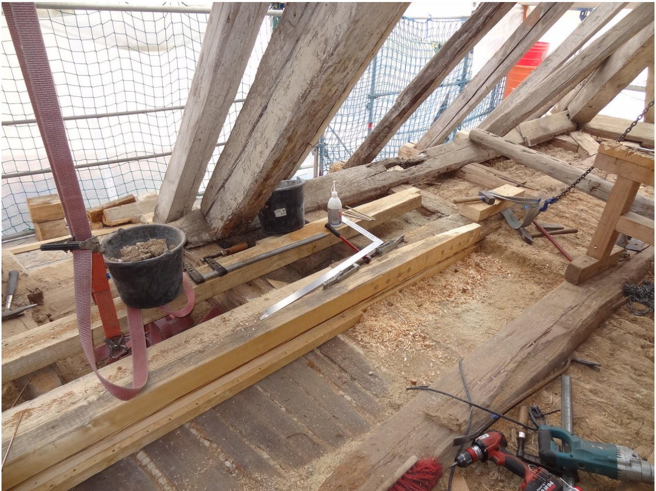
Decken- und Stichbalken während der Sanierung
