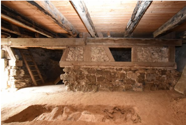
Frontalansicht Wand a, Raum 0.08, mit Blickrichtung Norden;
