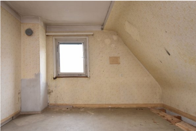
Frontalansicht Wand d, Raum 2.02, mit Blickrichtung Westen;
