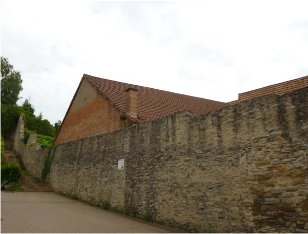
Aussenansicht Mauer West (strebewerk. 29.06.2015)
