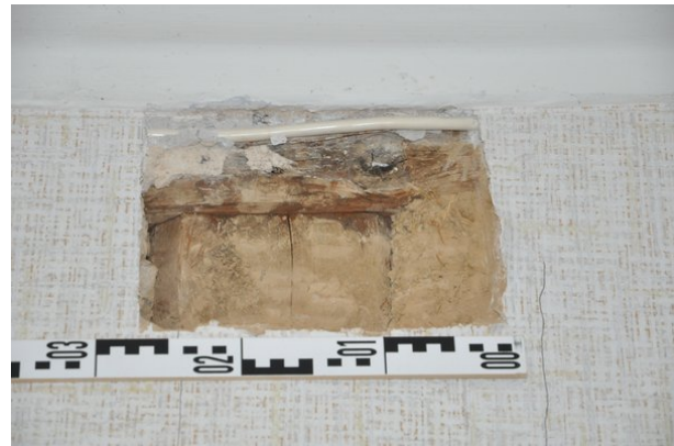
Raum 1.05 Wand a Abb.20: Befundöffnung in der Nordwand von Raum 1.05 im Bereich des Rähms (oberer Wandabschluss), Blickrichtung Norden; (Feldtkeller, 02.08.2016)
