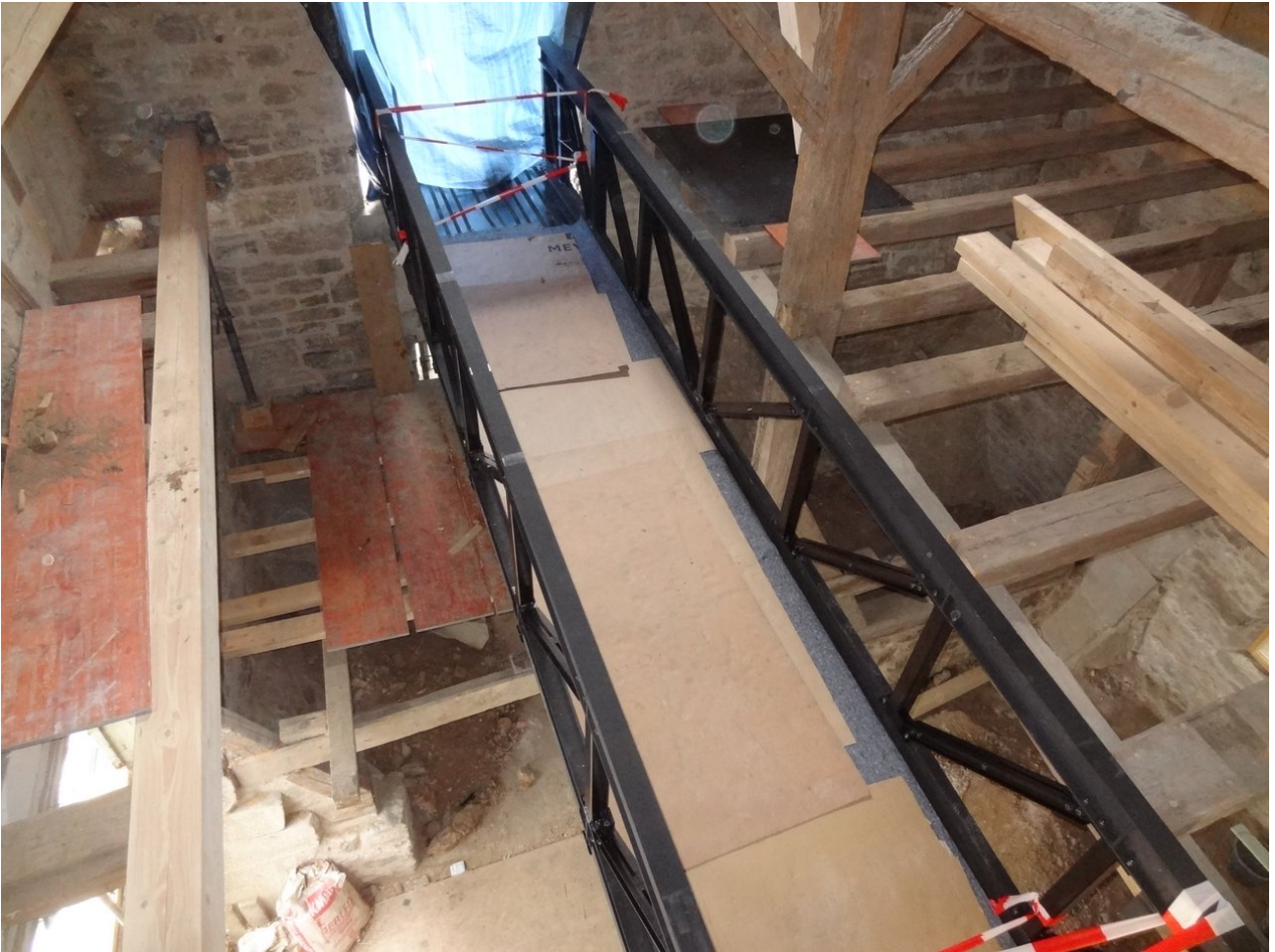
Stahlsteg Obergeschoss
