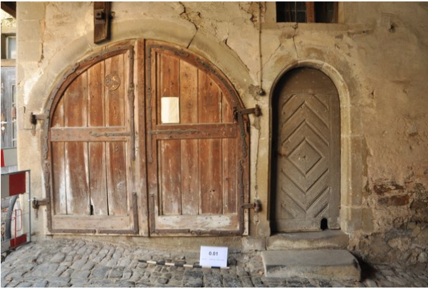
Raum 0.01b, Detailsicht des Tors zum Kellerhals und der rundbogigen Tür mit Blickrichtung Osten (strebewerk. 13.08.2015)
