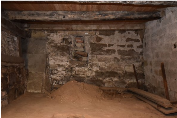
Frontalansicht Wand b, Raum 0.08, mit Blickrichtung Osten;
