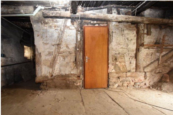
Frontalansicht Wand c, Raum 0.06, mit Blickrichtung Süden;
