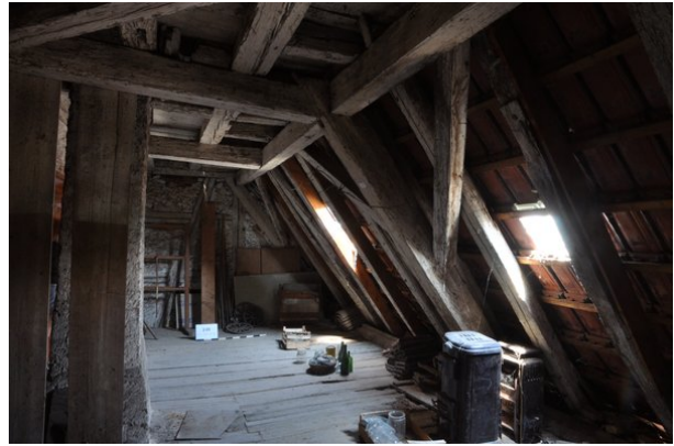
Dachraum R205ab (strebeverk. 13.08.2015)
