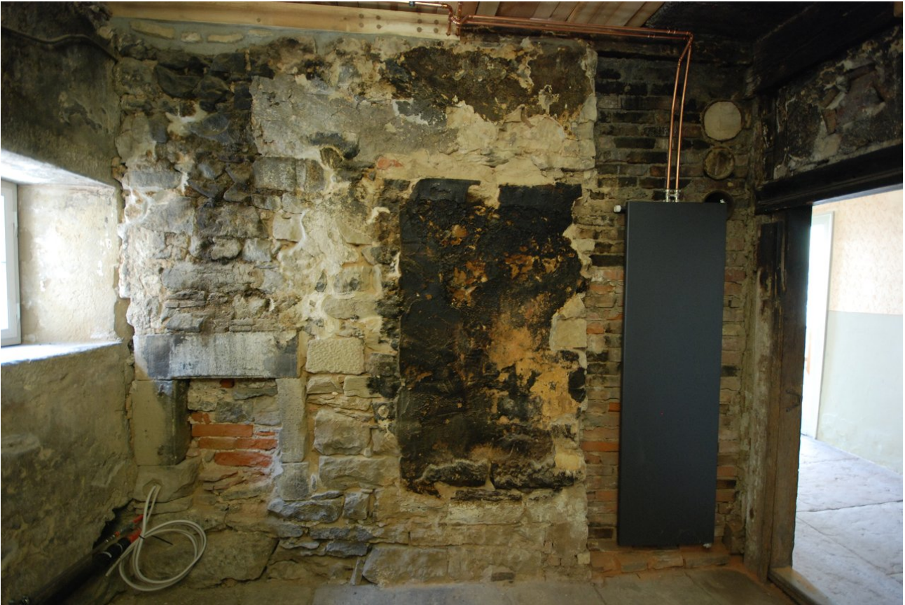
Ansicht der fertig sanierten Wand
