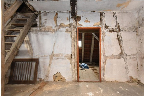
Frontalansicht Wand b, Raum 2.01, mit Blickrichtung Osten;
