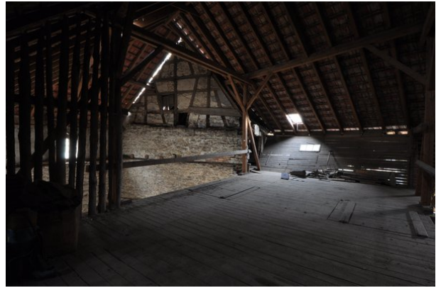
Dachraum Scheune R207bc (streberwerk. 05.10.2015)
