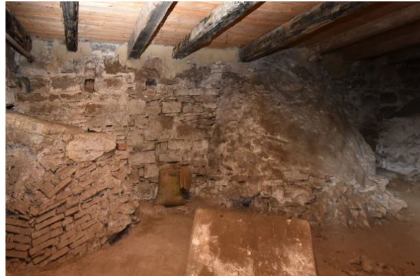
Frontalansicht Wand a, Raum 0.09, mit Blickrichtung Norden;
