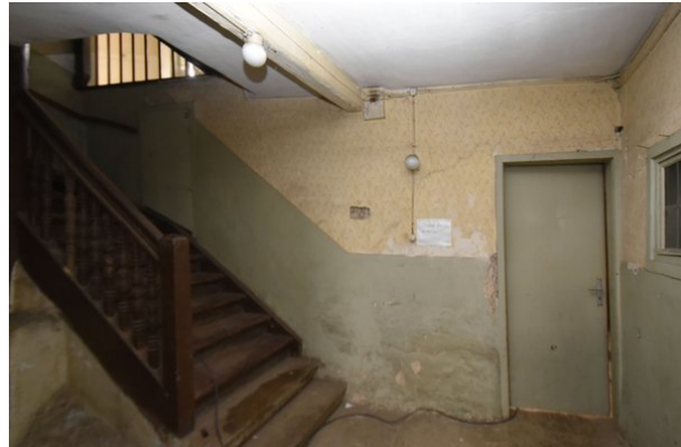
Frontalansicht Wand a, Raum 0.02, mit Blickrichtung Norden;
