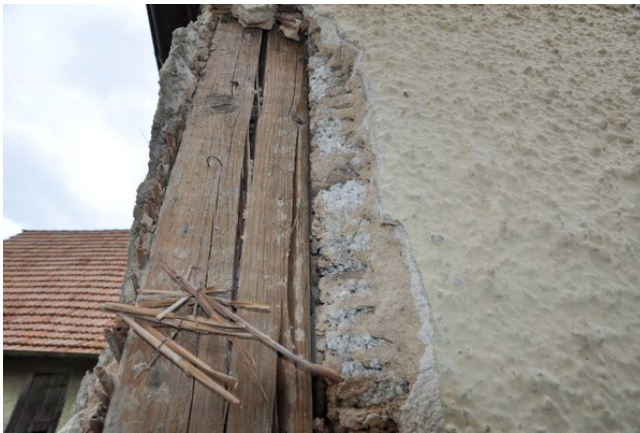
Wohnhaus Westfassade Öffnung 1 (Bereich der Gebäudeecke im 1. OG) Abb. 15:
