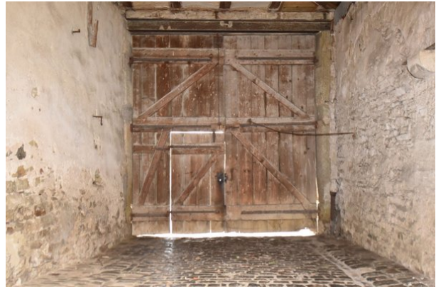
Frontalansicht Wand c, Raum 0.01, mit Blickrichtung Süden;
