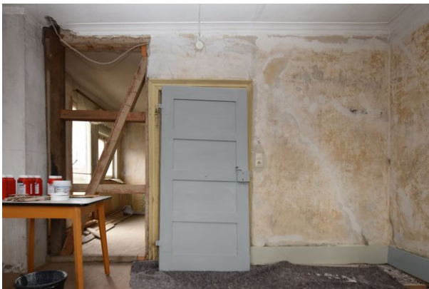
Frontalansicht Wand a, Raum 1.03, mit Blickrichtung Norden;
