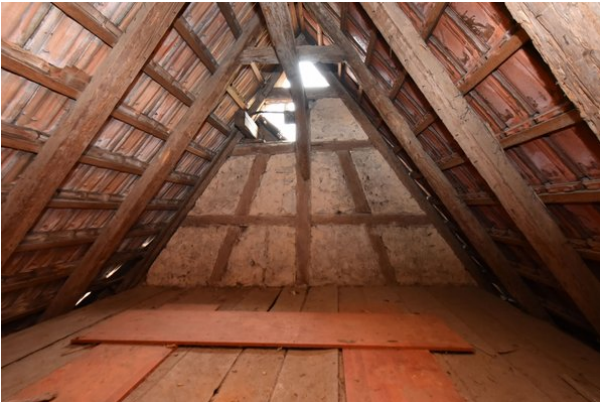
Frontalansicht Wand a, Raum 3.02, mit Blickrichtung Norden;
