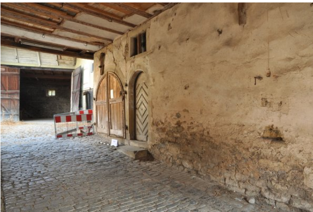
Raum 0.01ab, Diagonalaufnahme mit Blickrichtung Nordosten (strebewerk. 13.08.2015)
