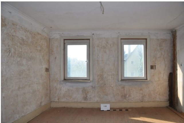
Raum 1.03c, Frontalansicht Wand c mit Blickrichtung Süden (streberwerk. 13.08.2015)
