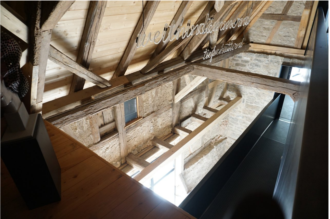
Ansicht Sparren Bestand mit neuer Schalung
