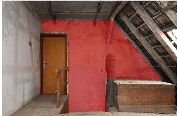
Frontalansicht Wand d, Raum 2.01, mit Blickrichtung Westen; Kartierung der im Original zu erhaltenden Bereiche in dunkelrot;
