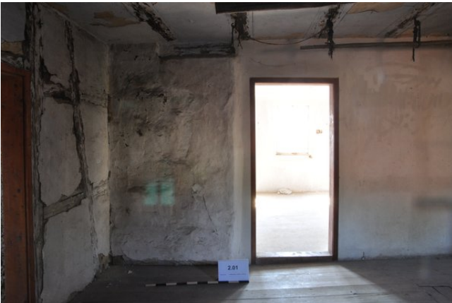
Raum 2.01c, Detailansicht der Tür zu Raum 2.04 mit Blickrichtung Süden (streberwerk. 13.08.2015)
