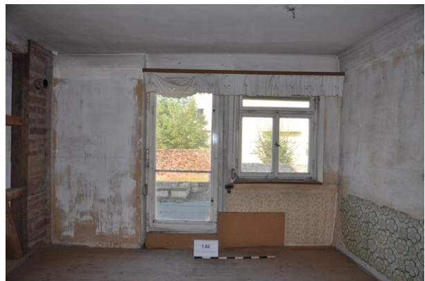
Raum 1.02d, Frontalansicht Wand d mit Blickrichtung Westen
