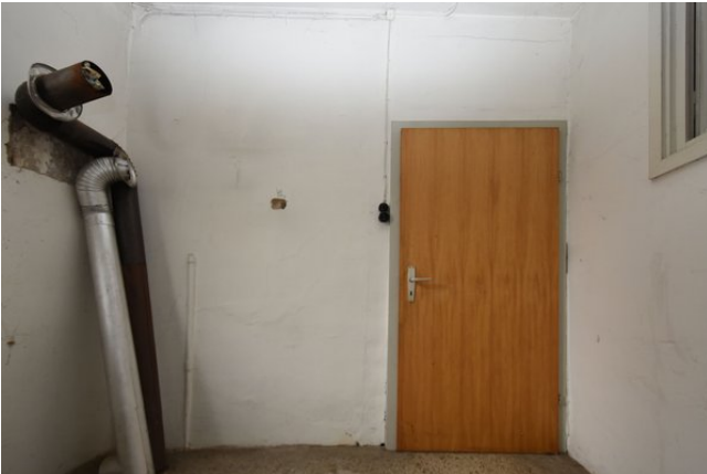
Frontalansicht Wand c, Raum 1.07, mit Blickrichtung Süden;
