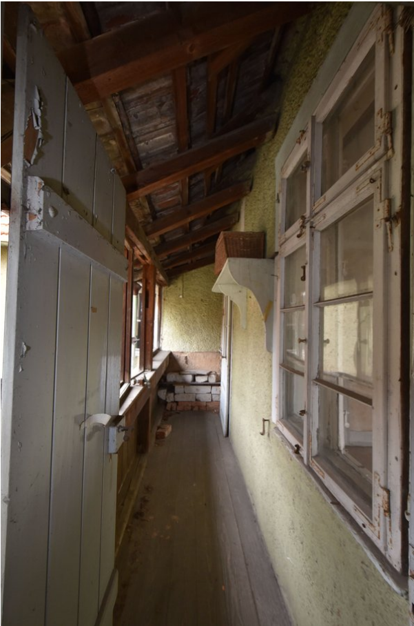
Frontalansicht Wand b, Raum 1.11, mit Blickrichtung Osten und Schrägansicht von Wand c;
