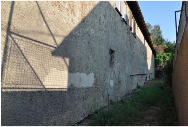
Ansicht Ostfassade (strebewerk. 13.08.2015)
