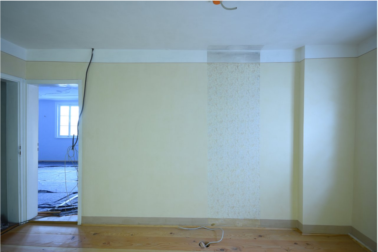
Ansicht der fertig sanierten Wand während der Bauarbeiten
