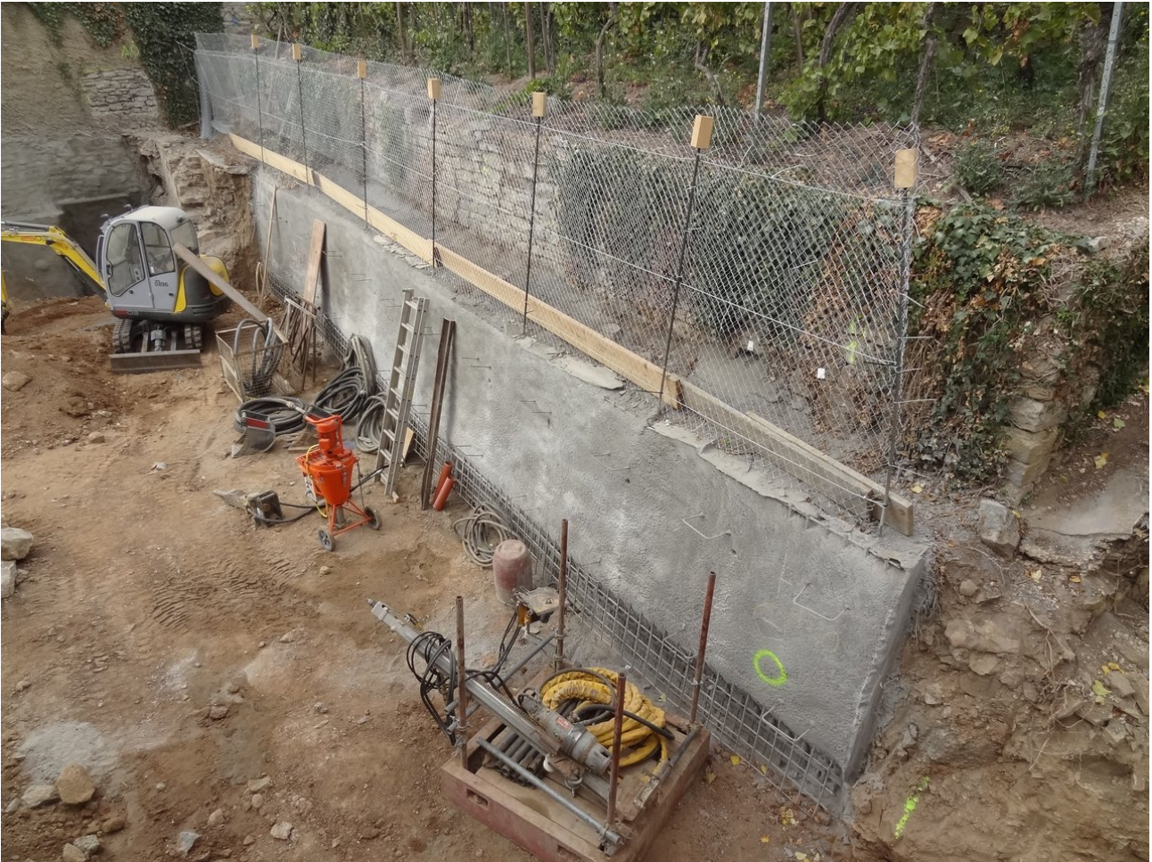
Herstellen des Baugrubenverbau: Bodenvernagelung mit Spritzbetonschale
