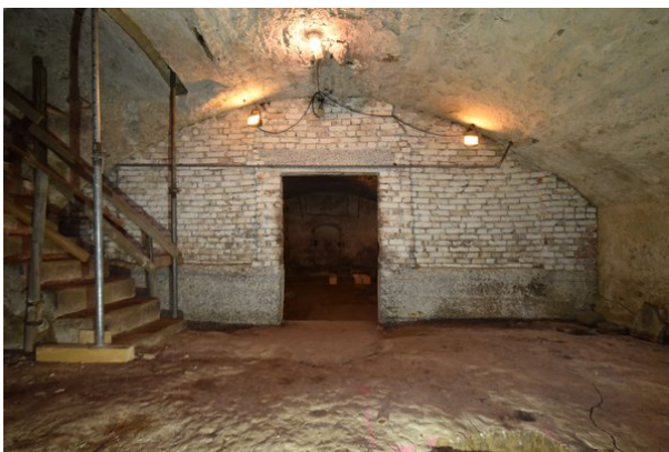
Frontalansicht Wand a, Raum -1.01, mit Blickrichtung Norden;
