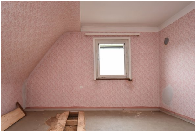
Frontalansicht Wand d, Raum 2.03, mit Blickrichtung Westen;
