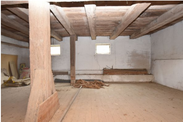
Frontalansicht Wand b, Raum 1.13, mit Blickrichtung Osten;
