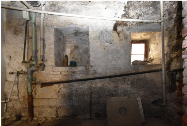
Frontalansicht Wand b, Raum 0.05, mit Blickrichtung Osten;
