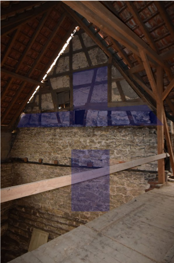
Frontalansicht der Außenseite von Wand a, Raum 2.06, mit Blickrichtung Süden; Kartierung der zur Veränderung vorgesehenen Bereiche in blau;
