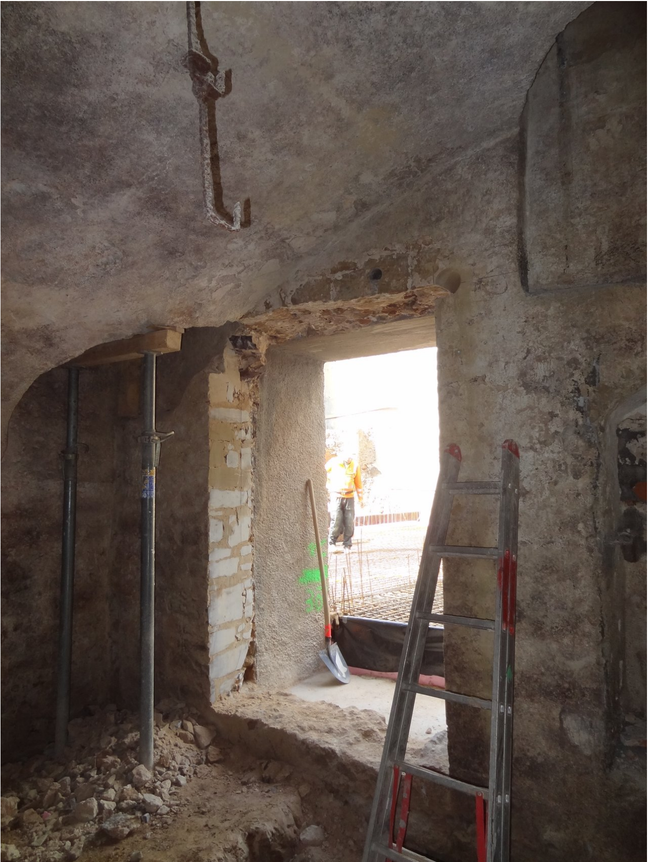
Durchbruch Schildwand; Ansicht vom Keller
