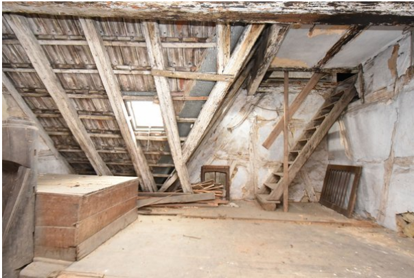
Frontalansicht Wand a, Raum 2.01, mit Blickrichtung Norden;
