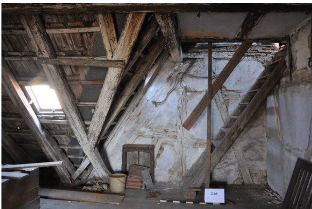
Raum 2.01a, Frontalansicht Wand a und Treppe mit Blickrichtung Norden (strebewerk. 13.08.2015)
