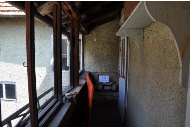
Raum 1.11abc, Diagonalaufnahme mit Blickrichtung Nordosten (strebewerk. 13.08.2015)
