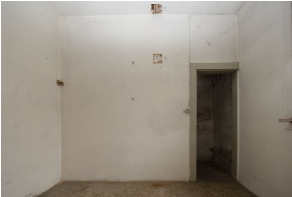
Frontalansicht Wand a, Raum 1.07, mit Blickrichtung Norden;
