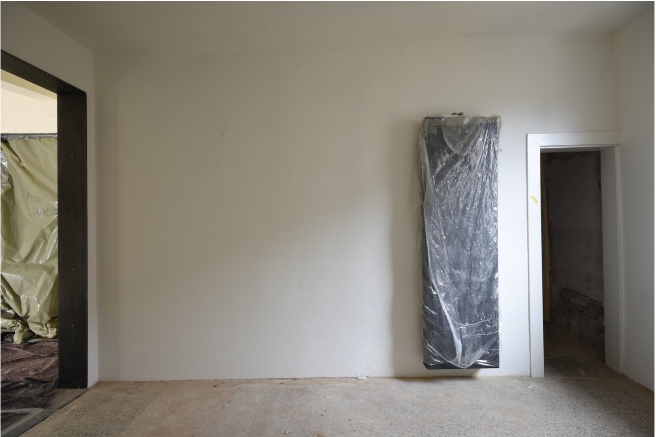
Ansicht fertig sanierte Wand
