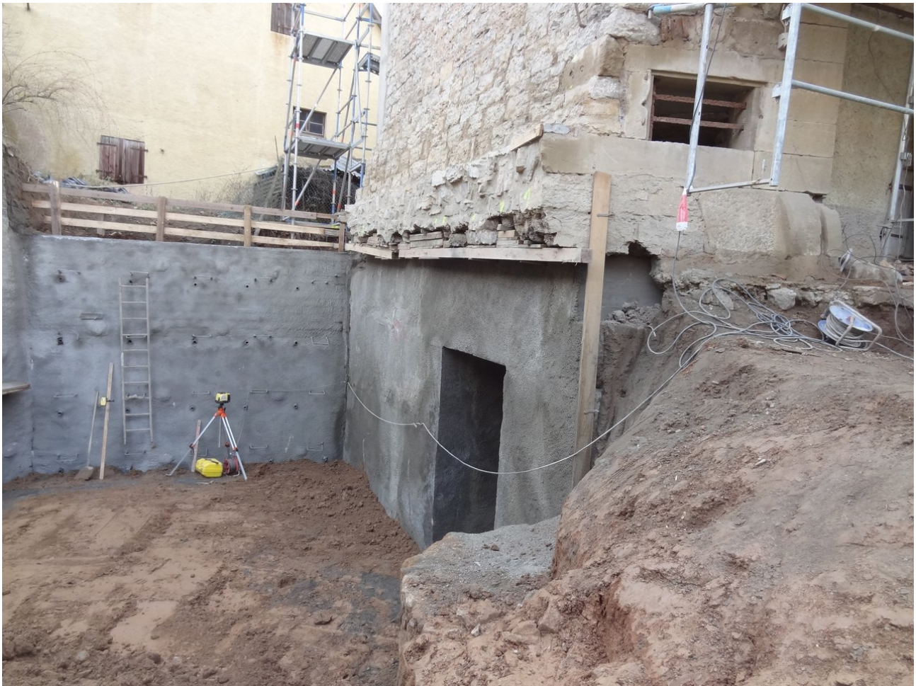
Unterfangung der Giebelwand mit Durchgang zum Gewölbekeller; Baugrubenverbau
