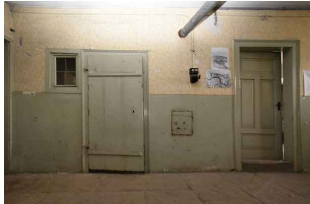
Frontalansicht Wand b (nördlicher Teil), Raum 0.02, mit Blickrichtung Osten;
