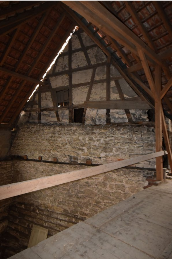
Frontalansicht der Außenseite von Wand a, Raum 2.06, mit Blickrichtung Süden;
