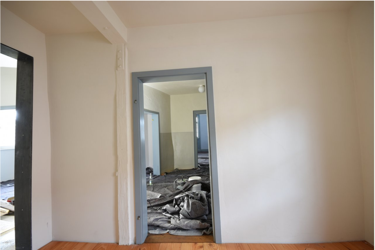
Ansicht fertig sanierte Wand während der Bauarbeiten
