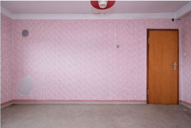
Frontalansicht Wand a, Raum 2.03, mit Blickrichtung Norden;
