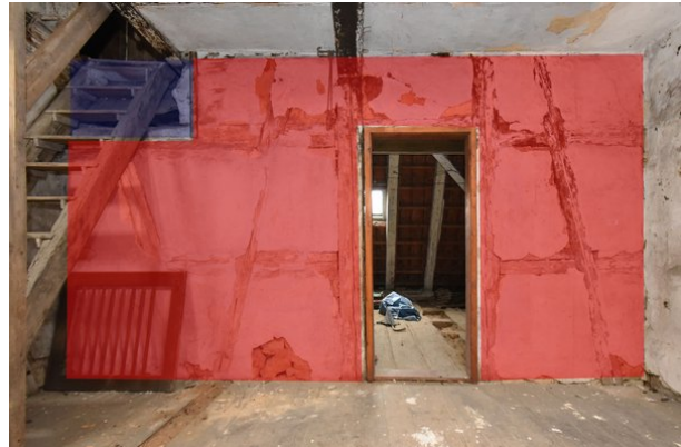
Frontalansicht Wand b, Raum 2.01, mit Blickrichtung Osten; Kartierung der im Original zu erhaltenden Bereiche in dunkelrot;
