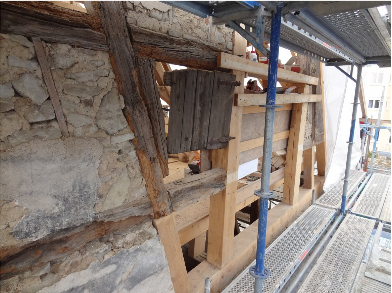
Sanierung Fachwerk der Giebelwand
