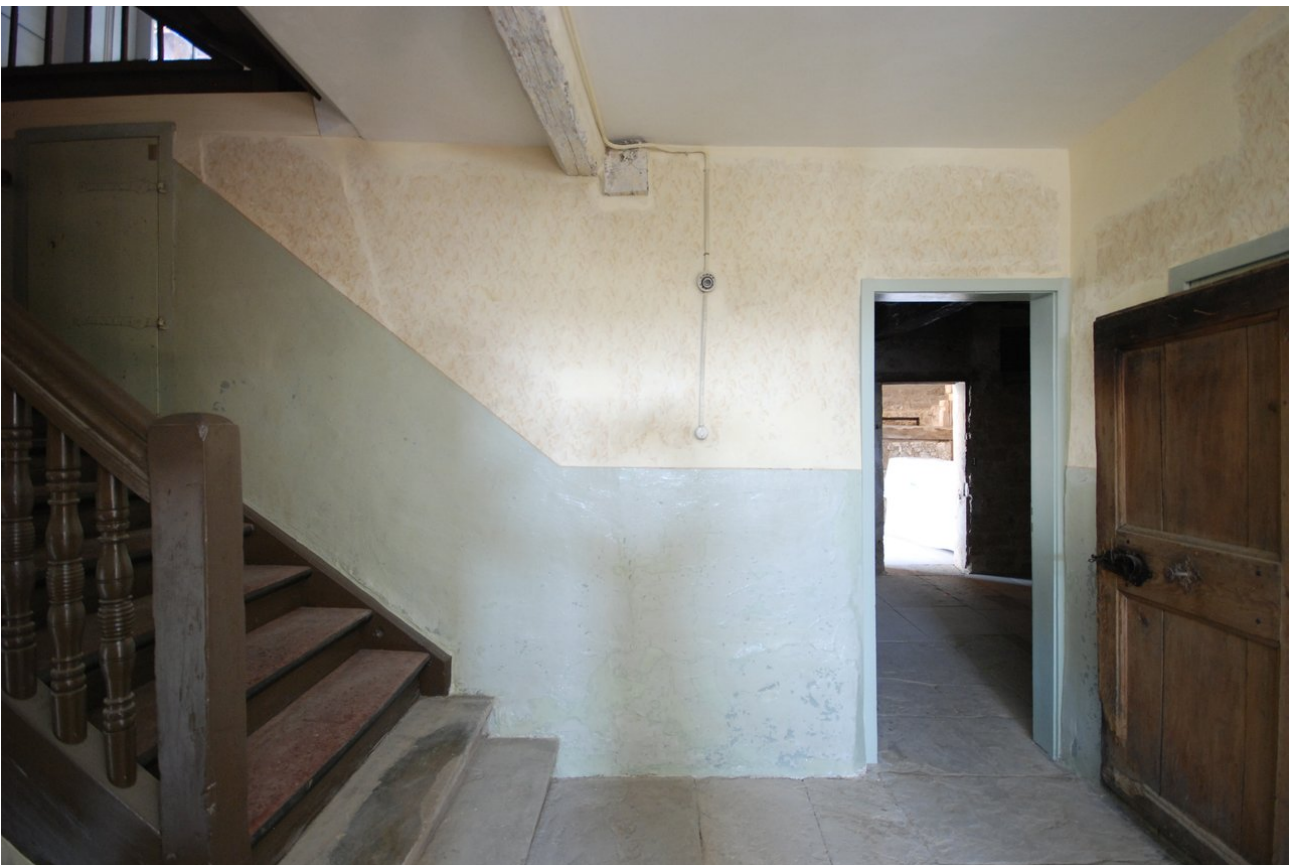
Ansicht der fertig sanierten Wand
