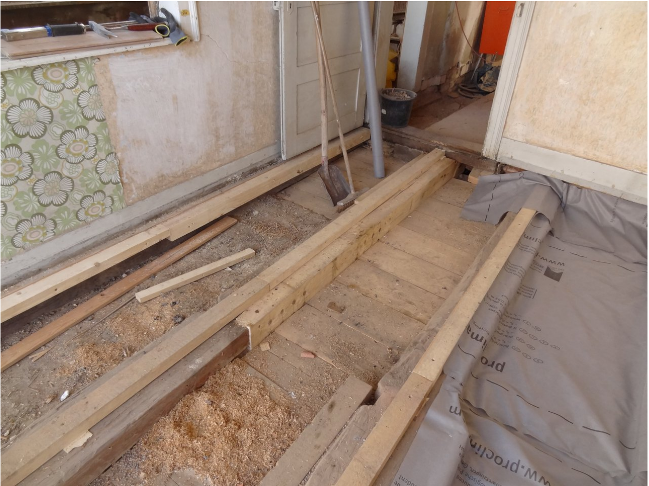
Decke über Durchfahrt (Draufsicht Raum 1.03, OG): Sanierung Deckenbalken mittels Blattstoß
