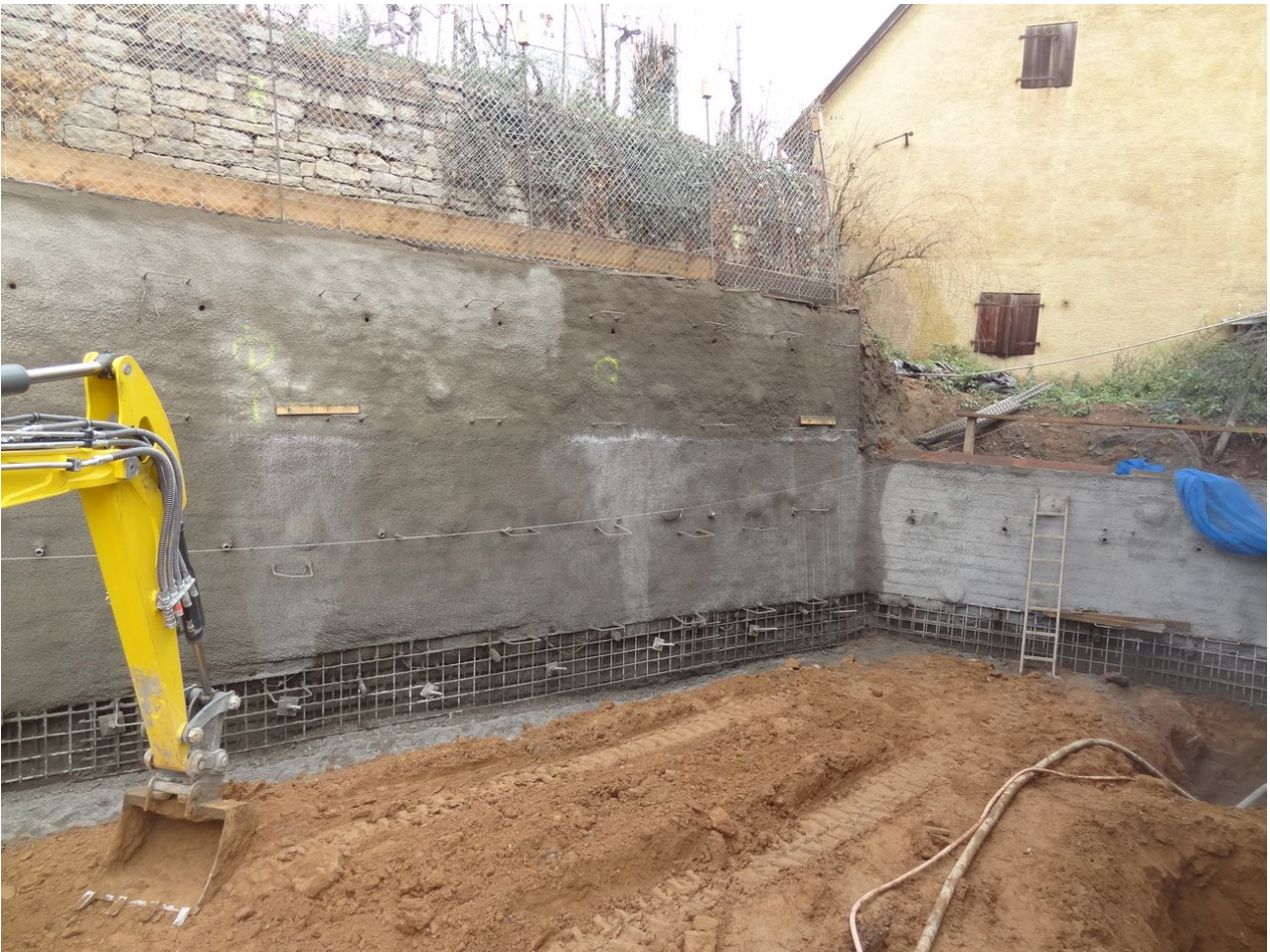
Herstellen des Baugrubenverbau: Bodenvernagelung mit Spritzbetonschale
