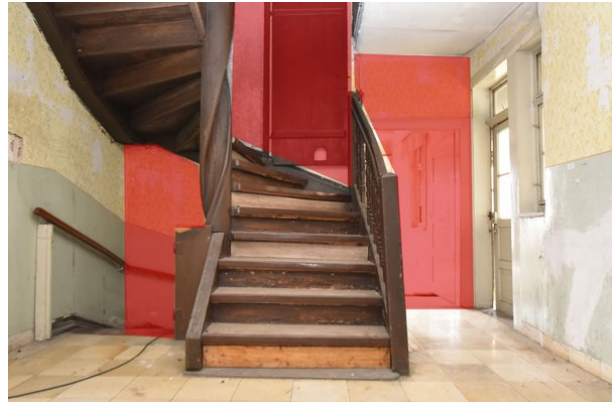
Frontalansicht Wand d, Raum 1.01, mit Blickrichtung Westen; Kartierung der im Original zu erhaltenden Bereiche in dunkelrot;
