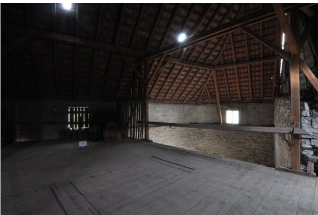
Dachraum Scheune R207ab (streberwerk. 05.10.2015)
