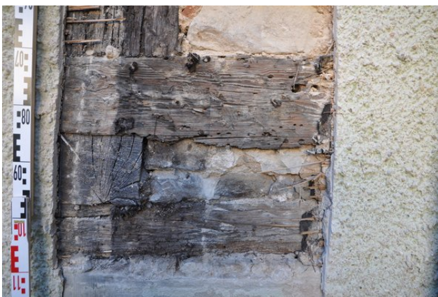
Hof Westfassade Öffnung 1 (Bereich um Schwelle des 1. OG) Abb. 11: Befundöffnung 1 Westfassade Scheune (Hof), unterer Teil mit Auflager auf Werksteinquadern; (Feldtkeller, 02.08.2016)
