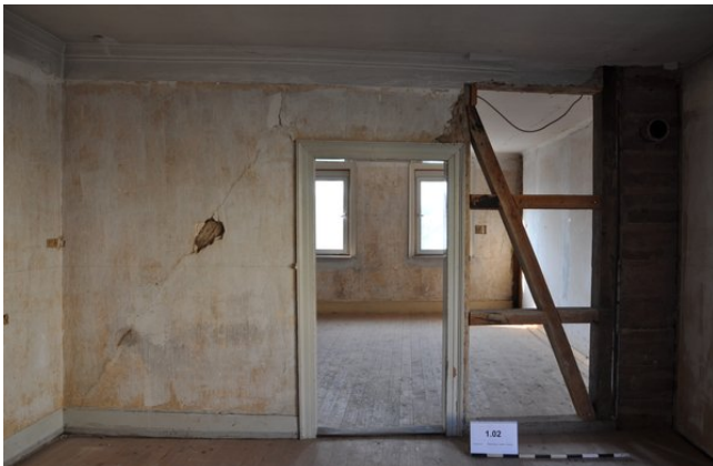
Raum 1.02c, Frontalansicht Wand c mit Blickrichtung Süden (streberwerk. 13.08.2015)
