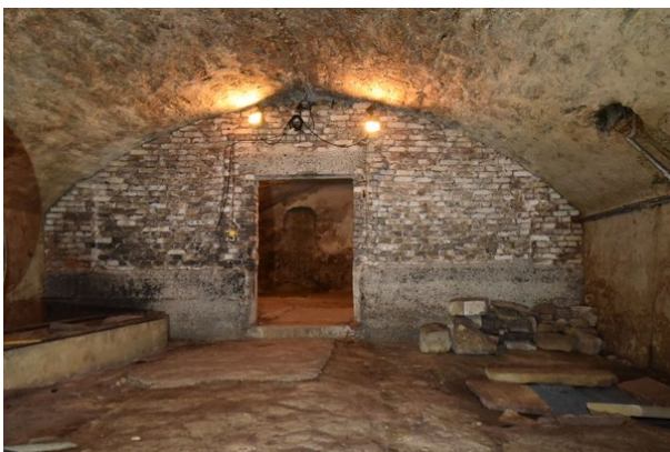
Frontalansicht Wand c, Raum -1.02, mit Blickrichtung Süden;
