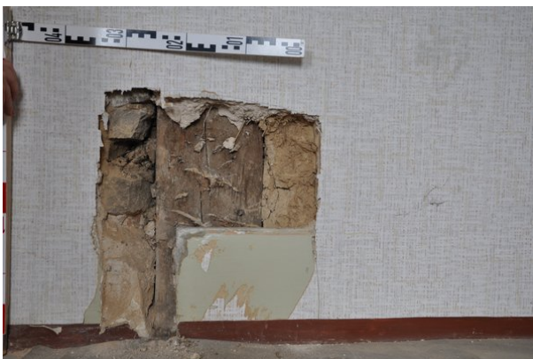
Raum 1.05 Wand a Abb.21: Befundöffnung in der Nordwand von Raum 1.05 im Bereich des unteren Wandabschlusses (Schwelle fehlt), Blickrichtung Norden; (Feldtkeller, 02.08.2016)
