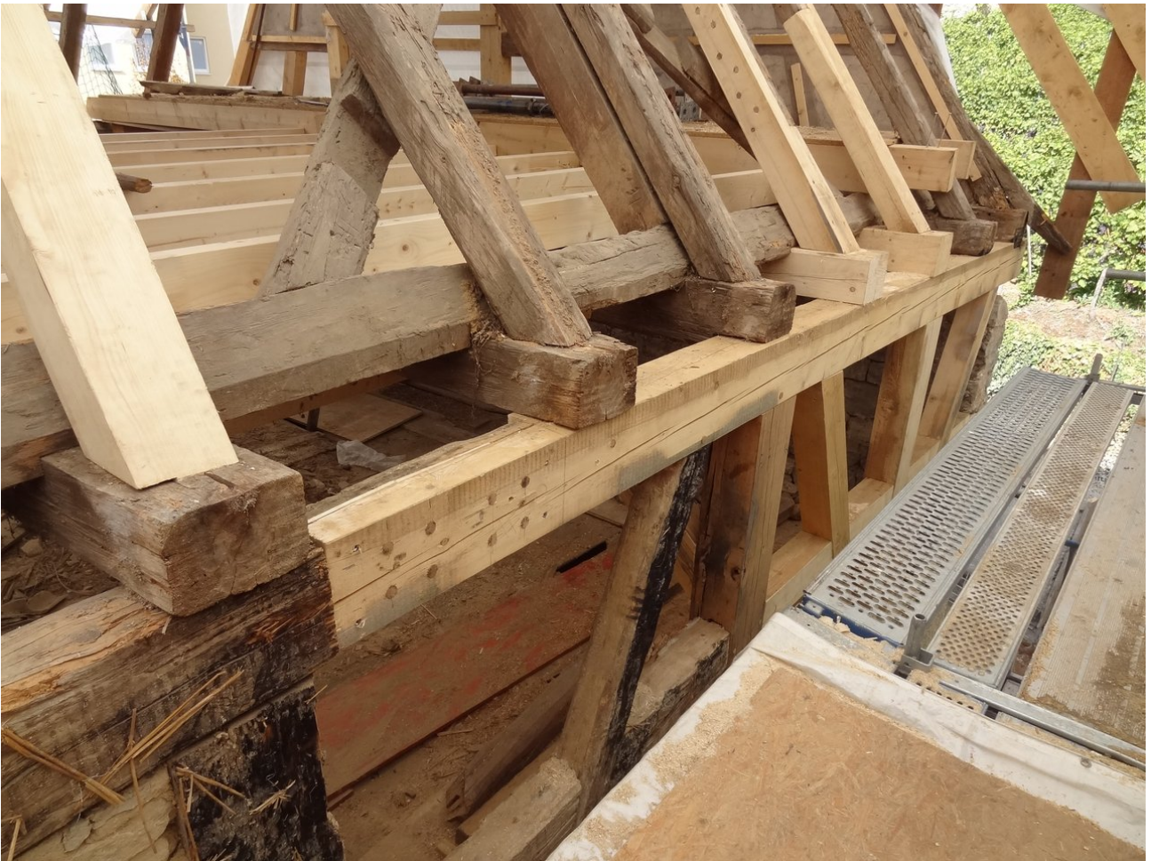
Sanierung Traufe Ost
