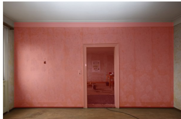
Frontalansicht Wand d, Raum 1.04, mit Blickrichtung Westen; Kartierung der besonders sensiblen Bereiche in rot;
