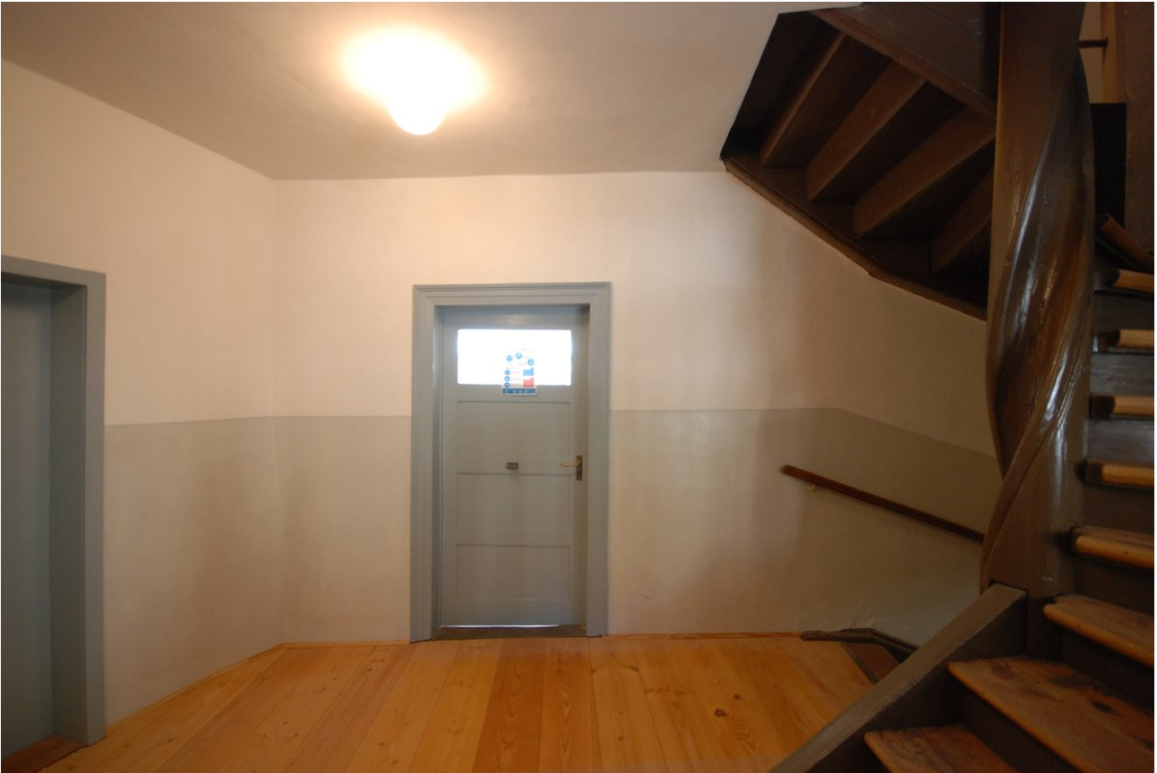
Ansicht fertig sanierte Wand
