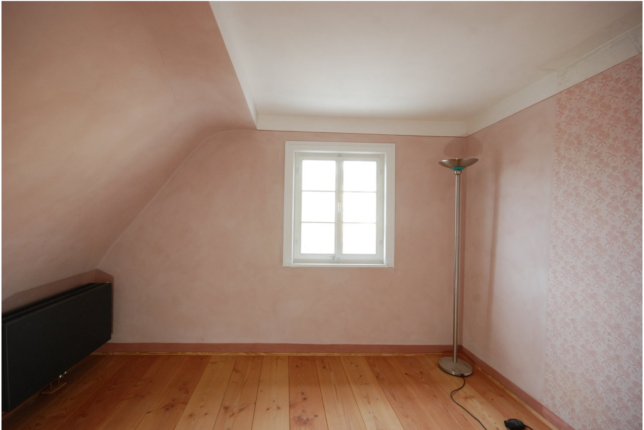
Ansicht der fertig sanierten Wand vor Einbau Mobiliar
