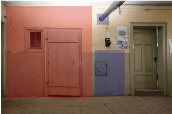
Frontalansicht Wand b (nördlicher Teil), Raum 0.02, mit Blickrichtung Osten; Kartierung der besonders sensiblen Bereiche in rot; Kartierung der zur Veränderung vorgesehenen Bereiche in blau;
