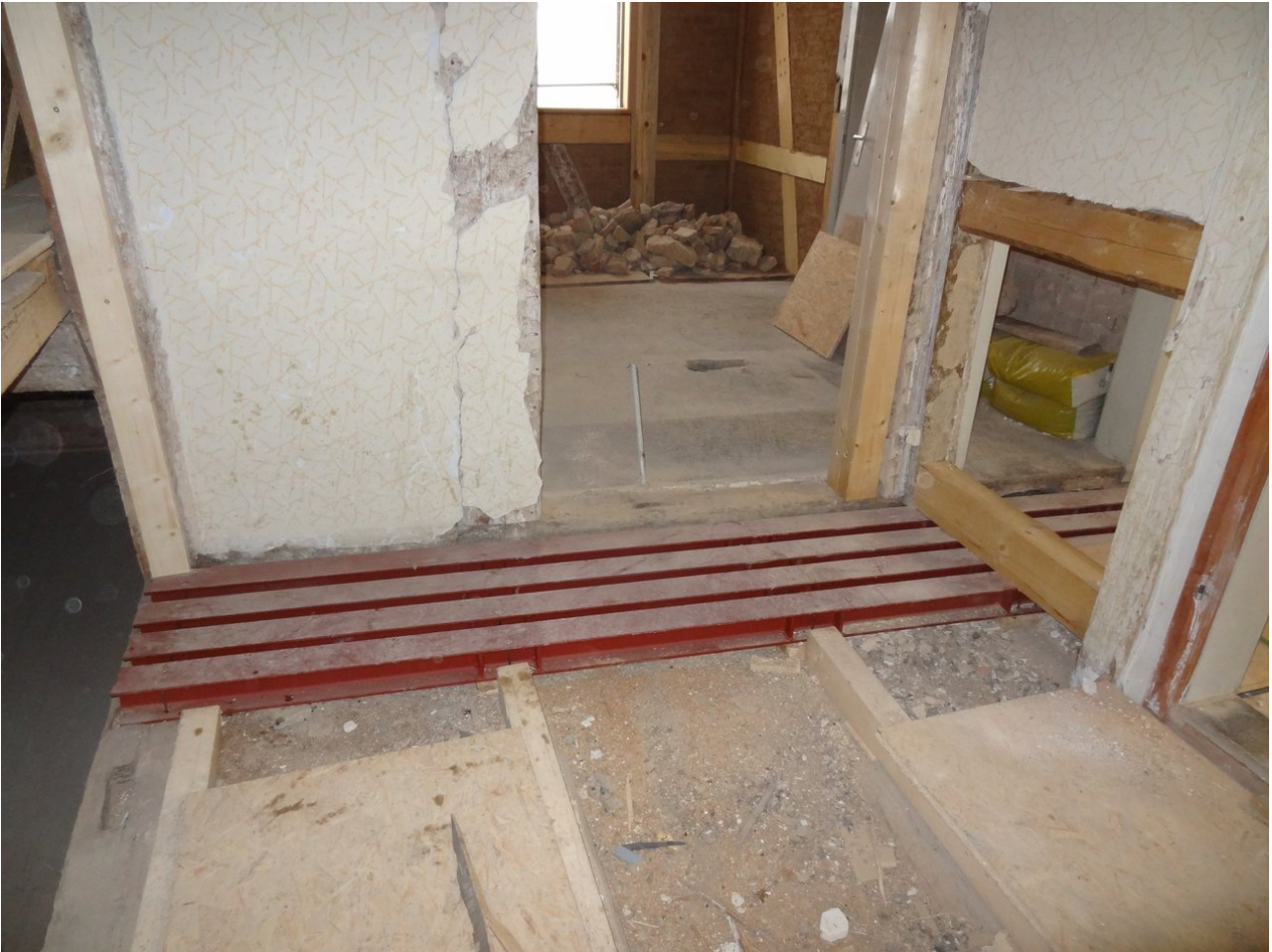
Statische Verstärkung der Decke
