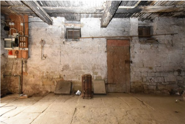
Frontalansicht Wand a, Raum 0.06, mit Blickrichtung Norden;
