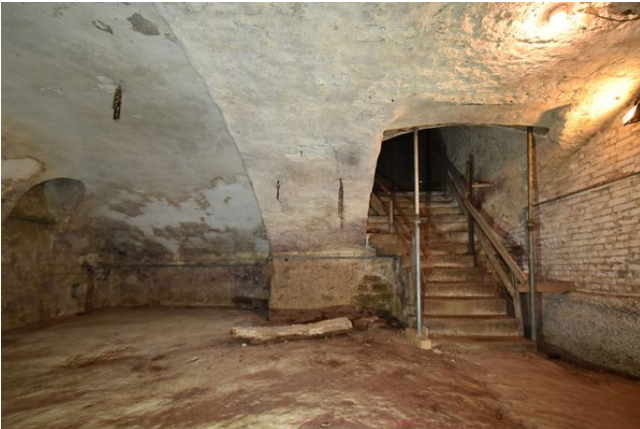
Frontalansicht Wand d, Raum -1.01, mit Blickrichtung Westen;
