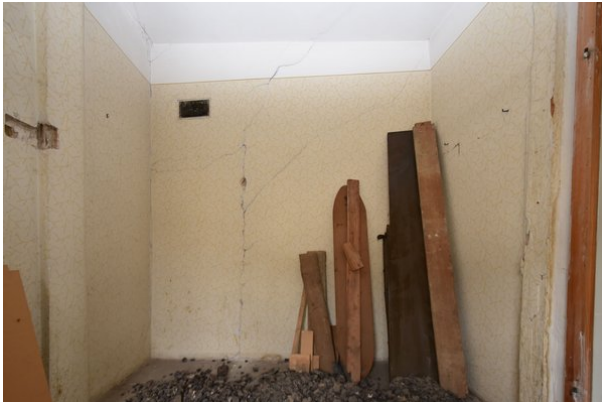
Frontalansicht Wand b, Raum 1.10, mit Blickrichtung Osten;
