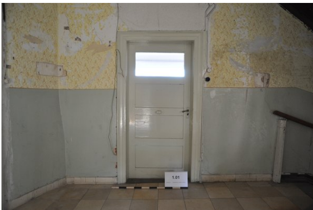
Raum 1.01c, Detailansicht der Tür zu Raum 1.04 mit Blickrichtung Süden (strebewerk. 13.08.2015)
