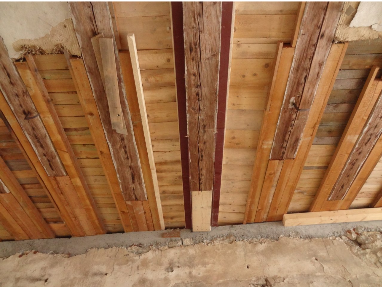
Ansicht Decke über Durchfahrt
