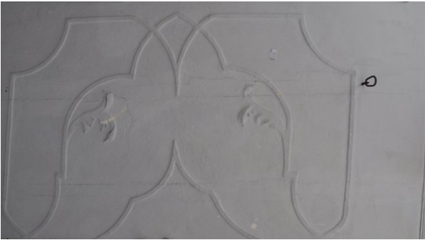
Stuckdecke Detail Westteil (strebewerk. 13.08.2015)
