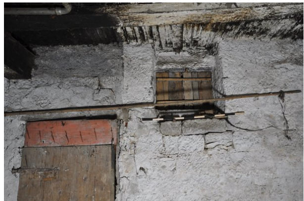
Raum 0.06a, Detailansicht des Fensters zu Raum 0.08 mit Blickrichtung Norden (strebewerk. 13.08.2015)
