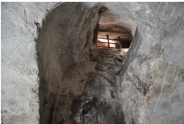
Raum -1.02d, Detailansicht des nördlichen Lichtschachts an Wand d mit Blickrichtung Westen (streberwerk. 13.08.2015)
