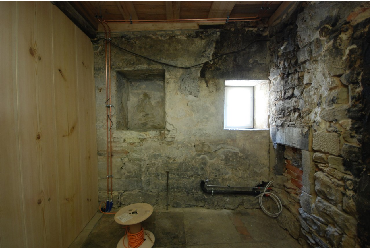
Ansicht der fertig sanierten Wand
