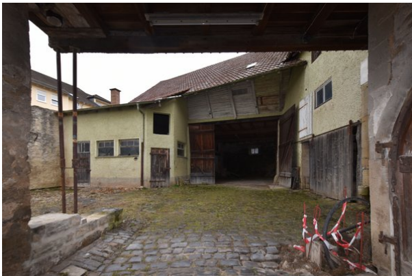
Frontalansicht Wand a, Raum 0.01, mit Blickrichtung Norden;
