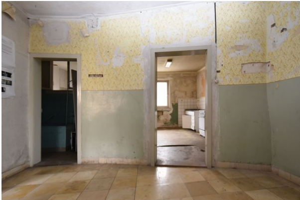
Frontalansicht Wand b, Raum 1.01, mit Blickrichtung Osten;
