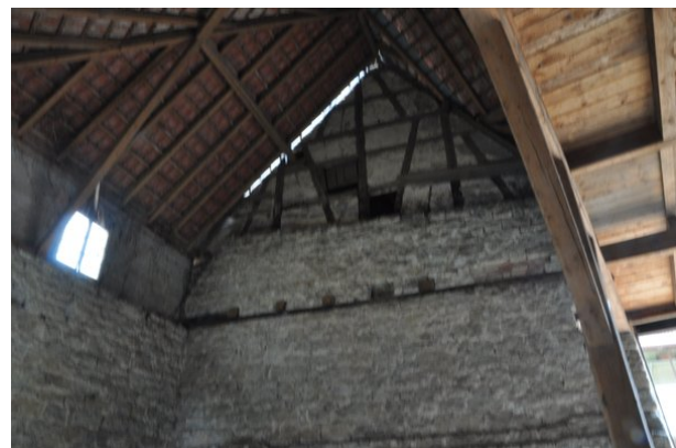
Raum 0.10bc, Diagonalaufnahme mit Blickrichtung Südosten (streberwerk. 13.08.2015)
