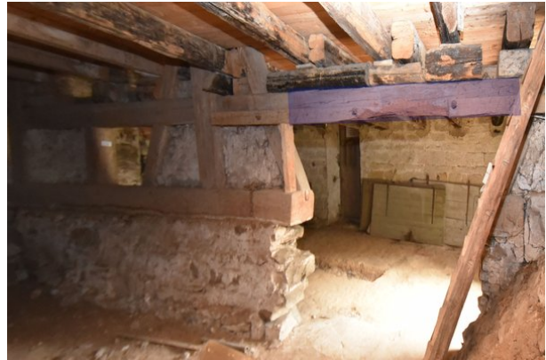
Frontalansicht Wand c, Raum 0.09, mit Blickrichtung Süden;
