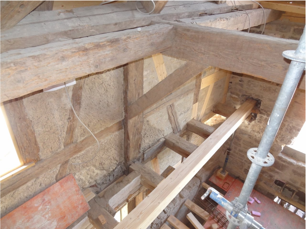
Wechselbalken zur Sicherung der Deckenbalken
