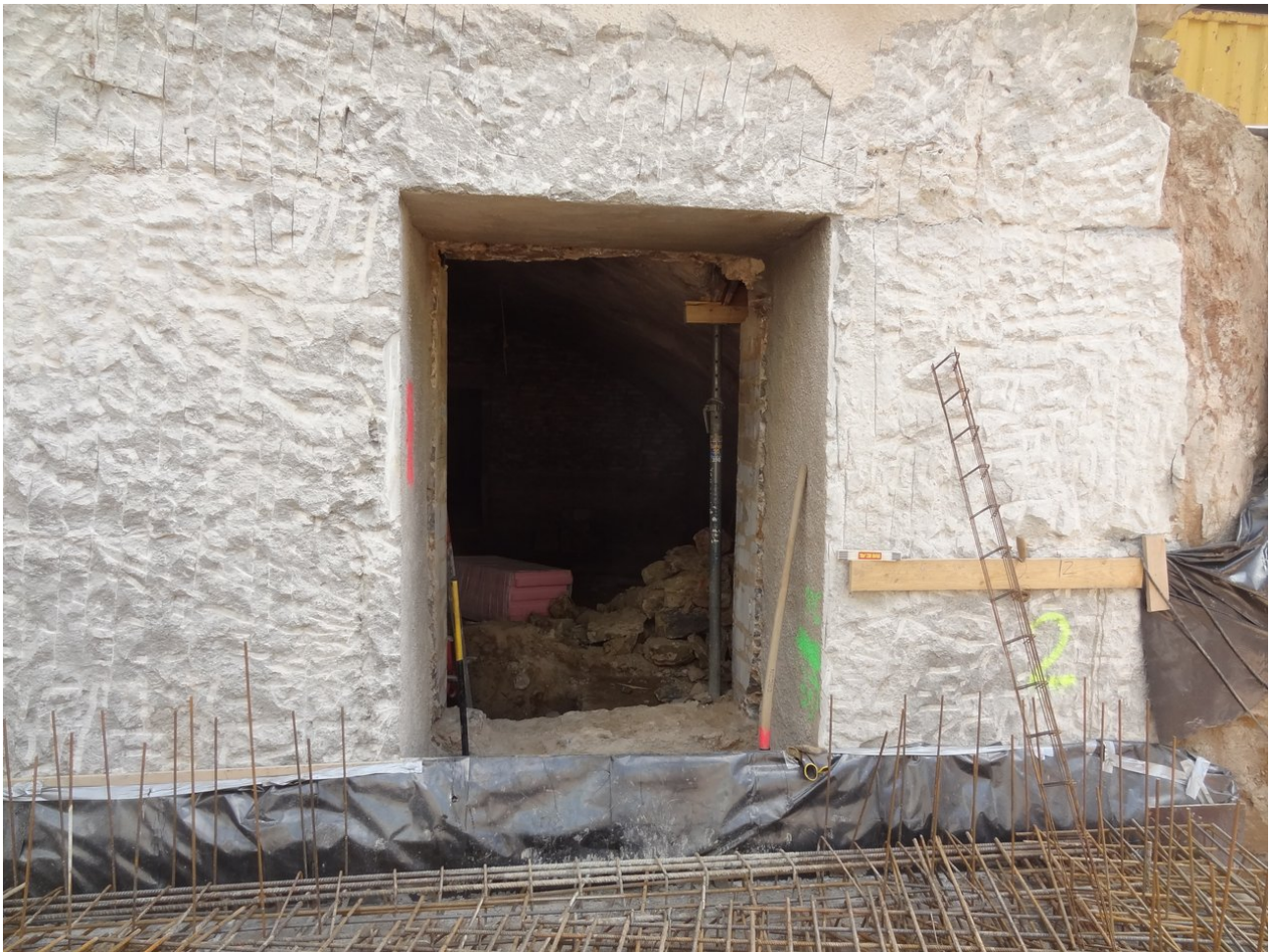
Durchbruch Schildwand; Ansicht vom Neubau
