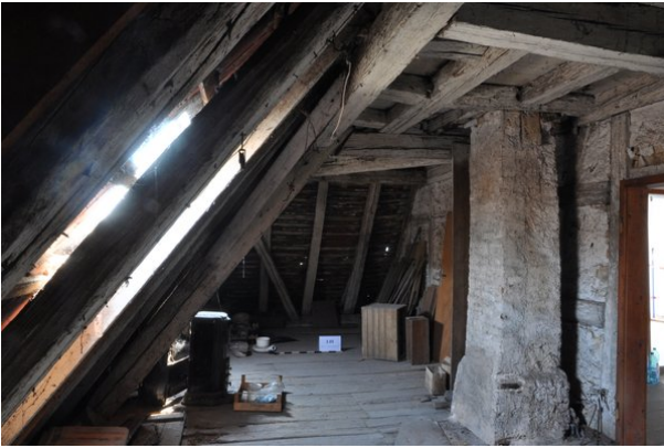
Dachraum R205cd (strebeverk. 13.08.2015)
