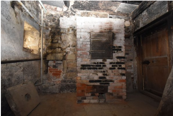
Frontalansicht Wand c, Raum 0.05, mit Blickrichtung Süden;
