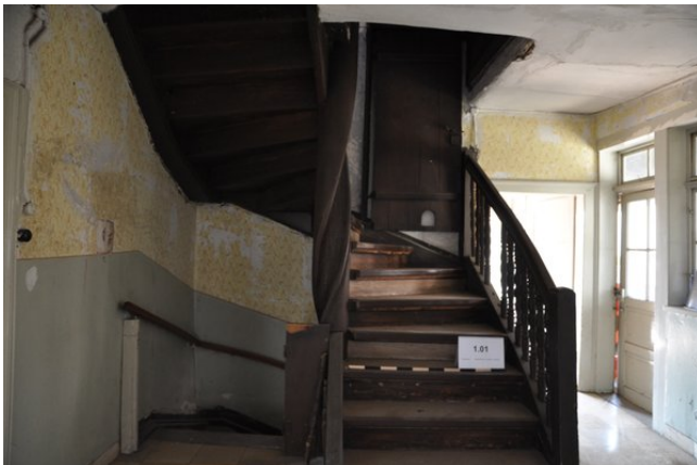
Raum 1.01d, Frontalansicht Wand d und Treppe mit Blickrichtung Westen (strebewerk. 13.08.2015)
