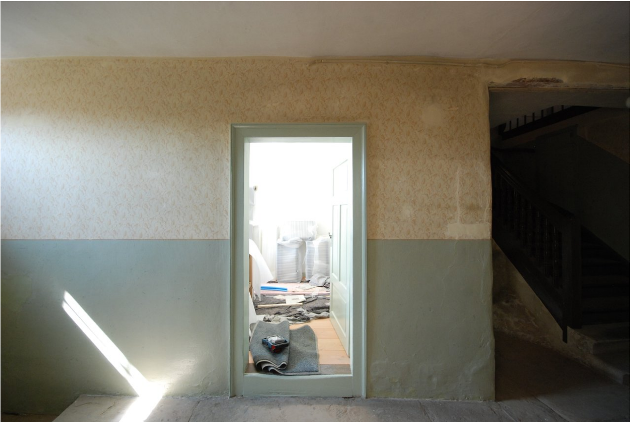
Ansicht der fertig sanierten Wand
