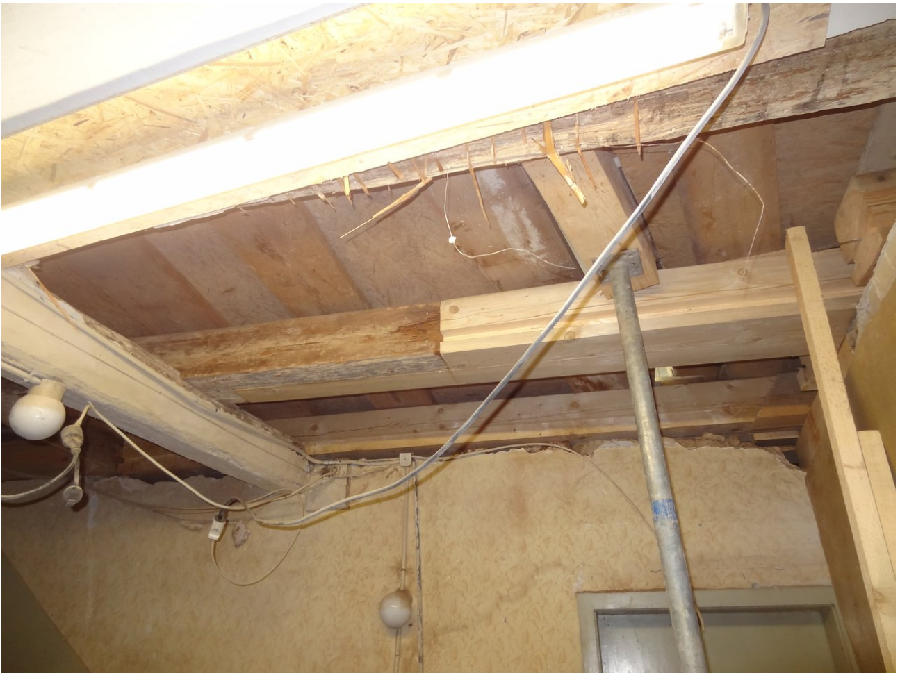
Ansicht Decke Raum EG0.02 während der Sanierungsmaßnahmen
