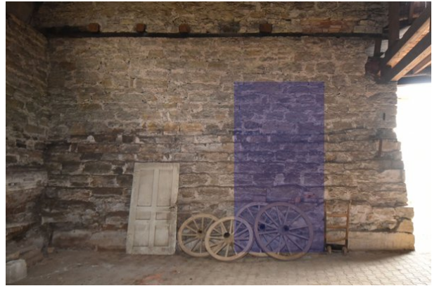
Frontalansicht der Außenseite von Wand a, Raum 0.09, mit Blickrichtung Süden; Kartierung der zur Veränderung vorgesehenen Bereiche in blau;
