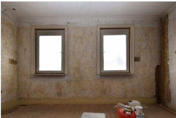
Frontalansicht Wand c, Raum 1.03, mit Blickrichtung Süden;
