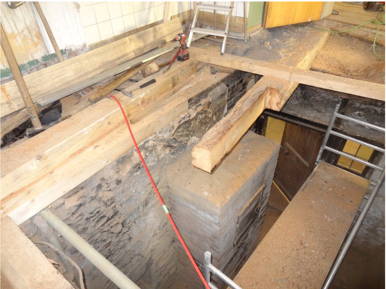
Aufnahme der Decke während den Sanierungsmaßnahmen
