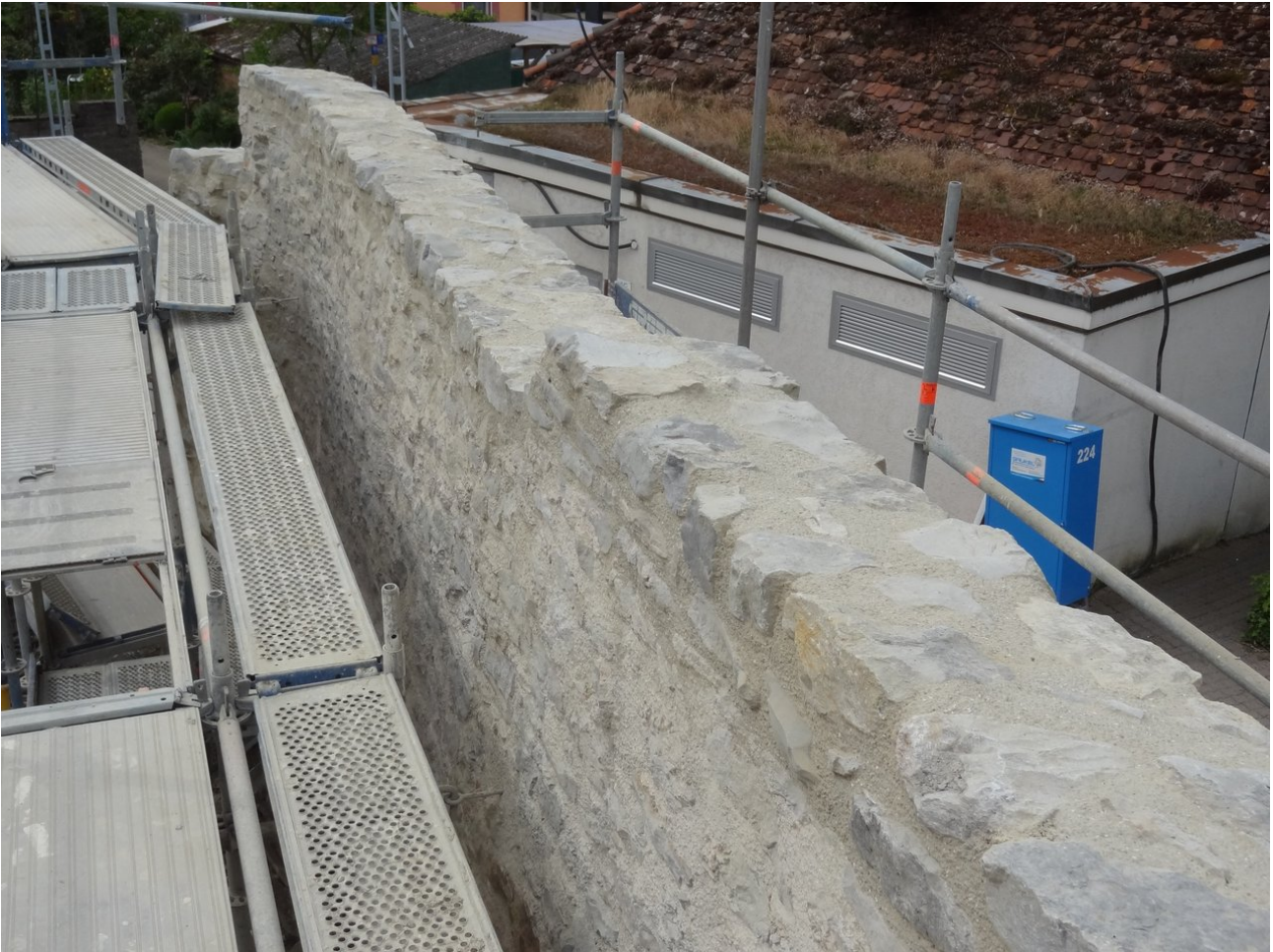
Mauerkrone Klostermauer nach der Sanierung
