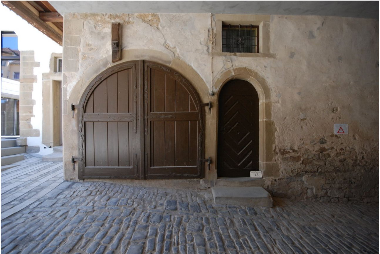
Ansicht fertig sanierte Wand
