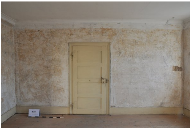
Raum 1.03b, Frontalansicht Wand b mit Blickrichtung Osten (streberwerk. 13.08.2015)
