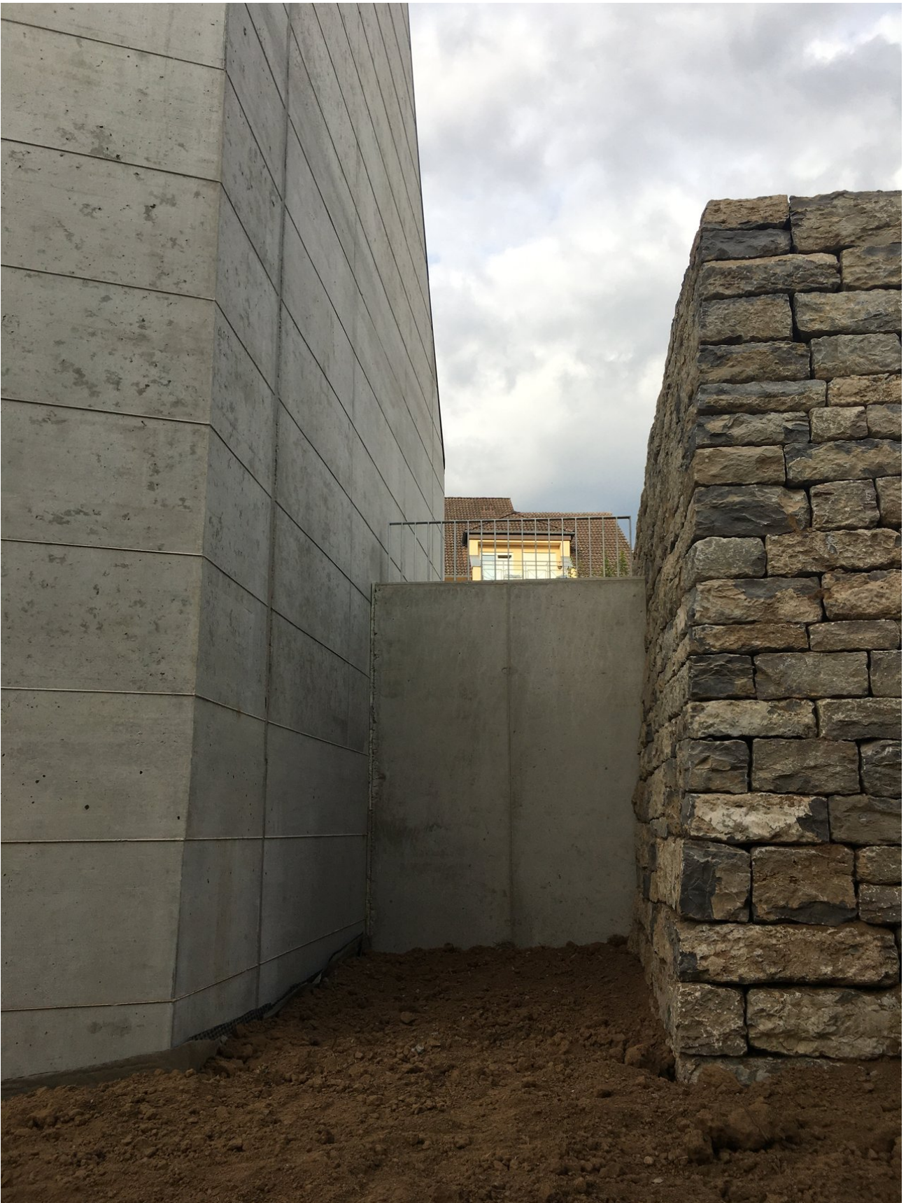
Ansicht Zwischenraum Treppenanbau / Weinbergsmauer
