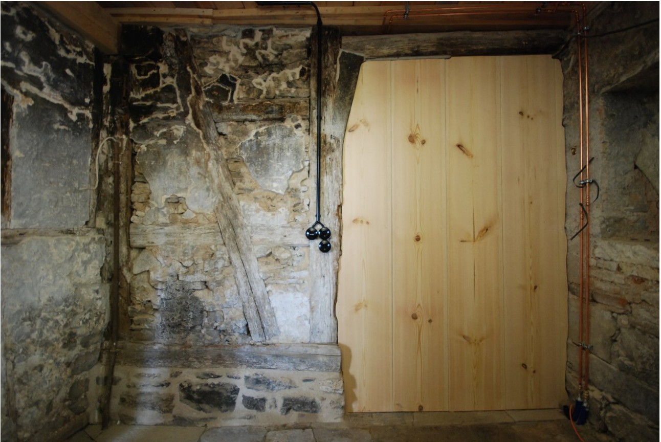
Ansicht der fertig sanierten Wand
