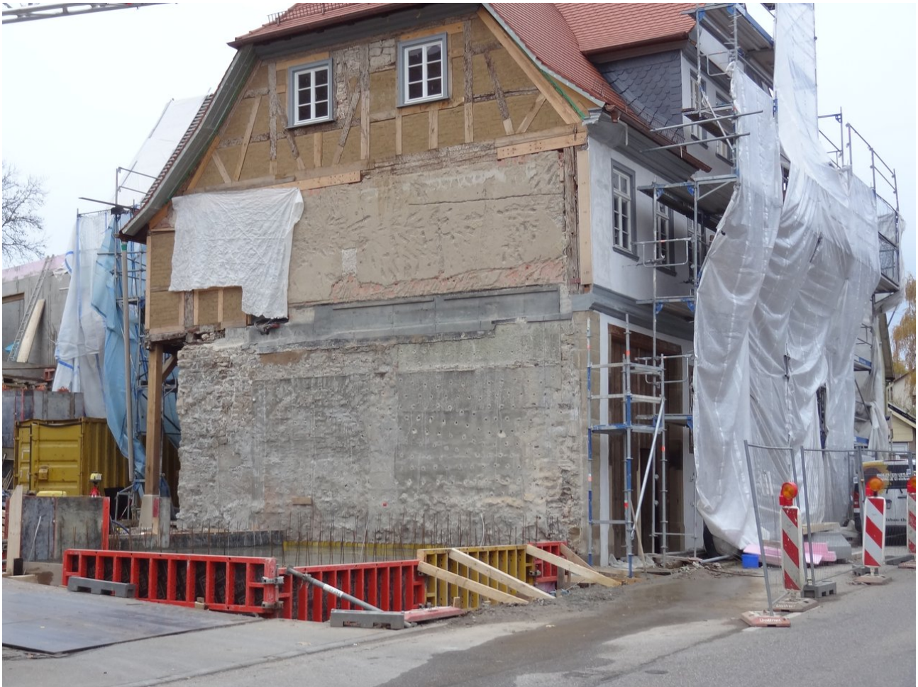
Mauerflächen maschinell verfugt und verpresst
