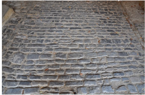
Naturstein-Bodenbelag der Durchfahrt (strebewerk. 13.08.2015)
