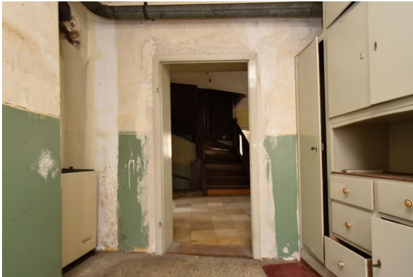
Frontalansicht Wand d, Raum 1.06, mit Blickrichtung Westen;
