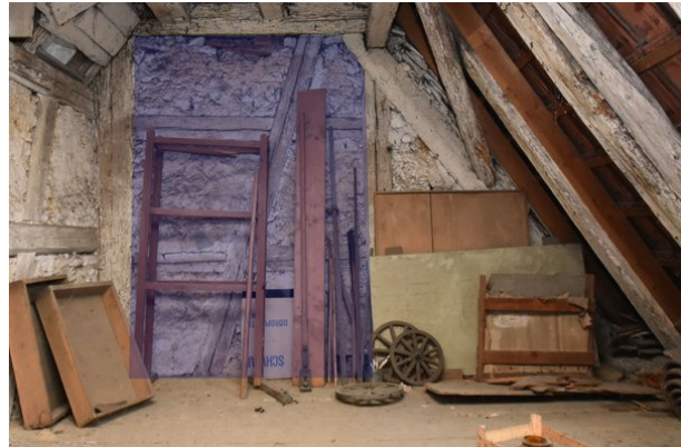
Frontalansicht Wand a, Raum 2.05, mit Blickrichtung Norden; Kartierung der zur Veränderung vorgesehenen Bereiche in blau;
