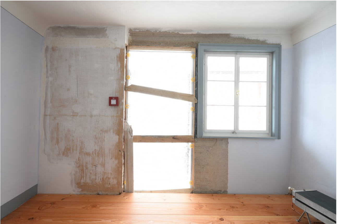
Ansicht während der Sanierung
