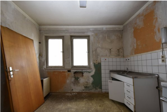
Frontalansicht Wand b, Raum 1.06, mit Blickrichtung Osten;
