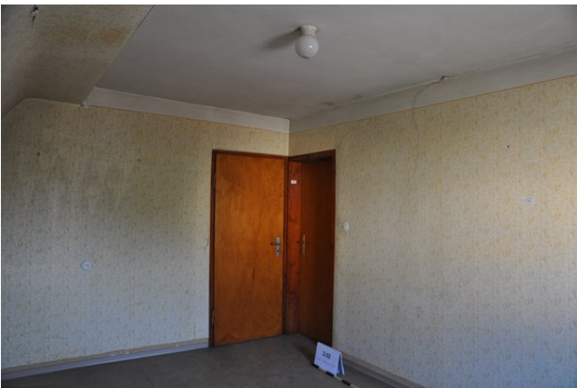
Raum 2.02bc, Diagonalaufnahme mit Blickrichtung Südosten (strebewerk. 13.08.2015)
