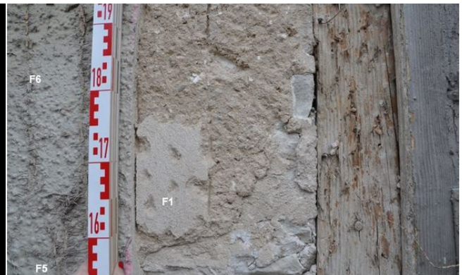
Ostfassade, Öffnung 2 (Bereich unterhalb Fenster des 1. OG) Abb.6:
