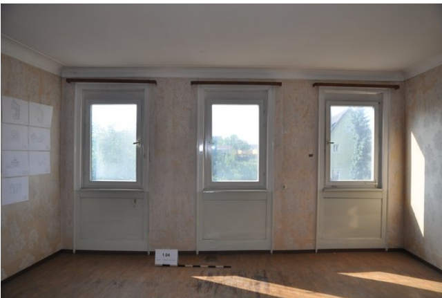
Raum 1.04c, Frontalansicht Wand c mit Blickrichtung Süden (streberwerk. 13.08.2015)
