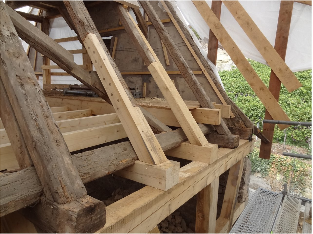
Sanierung Traufe Ost
