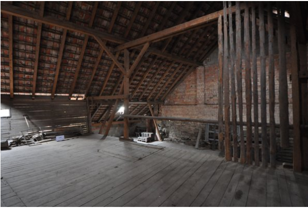
Dachraum Scheune R207cd (streberwerk. 05.10.2015)
