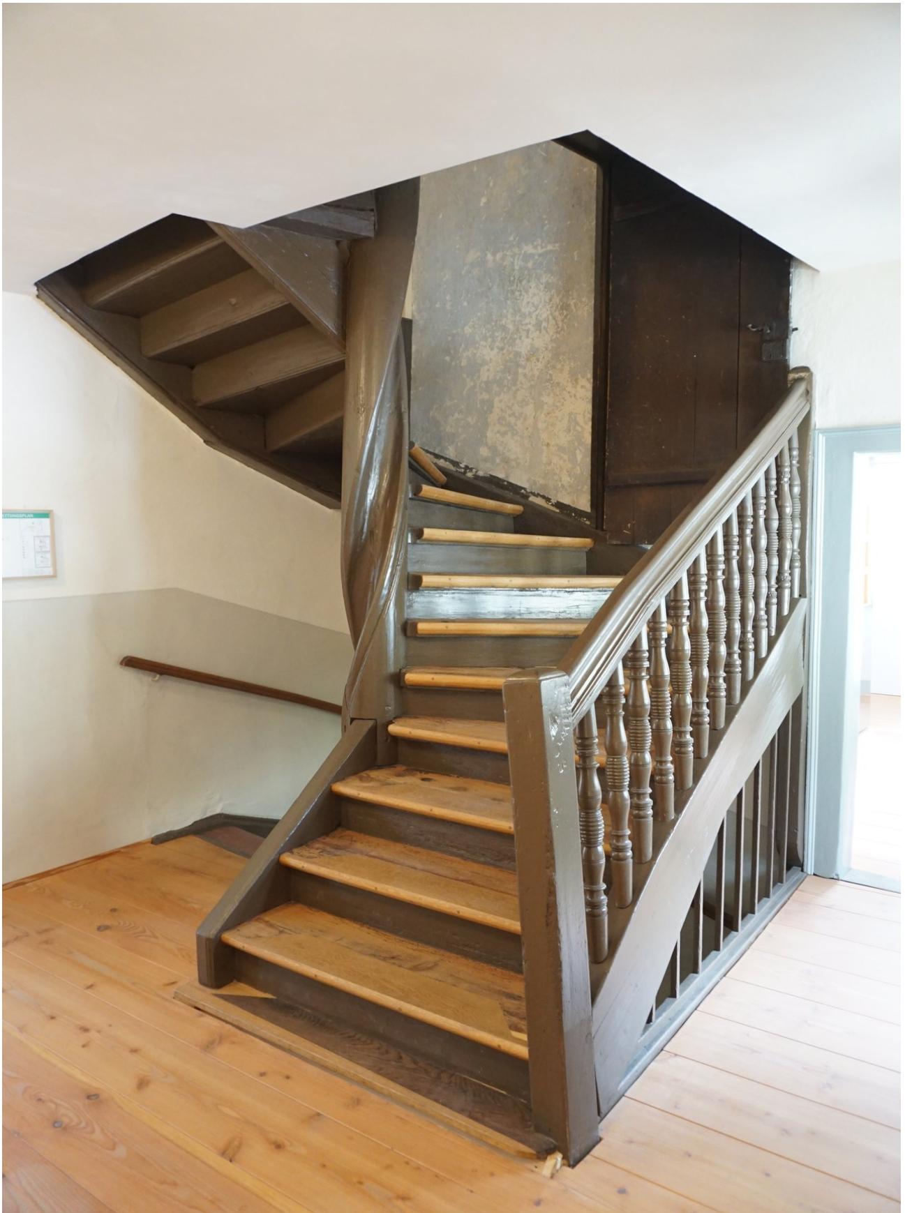
Ansicht sanierte Treppe von NW
