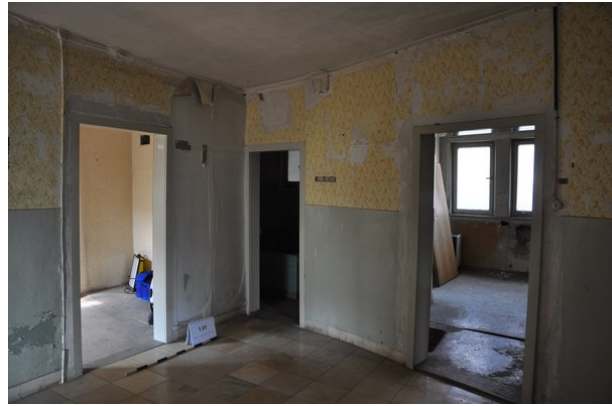
Raum 1.01ab, Diagonalaufnahme mit Blickrichtung Nordosten (strebewerk. 13.08.2015)
