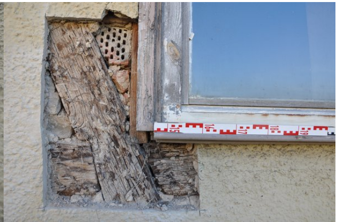
Wohnhaus Westfassade, Öffnung 2 (Bereich unterhalb Fenster im 1. DG) Abb. 17:
