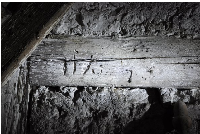
Raum 2.05d, Detailansicht der Abbundzeichen an Wand d mit Blickrichtung Westen (streberwerk. 13.08.2015)
