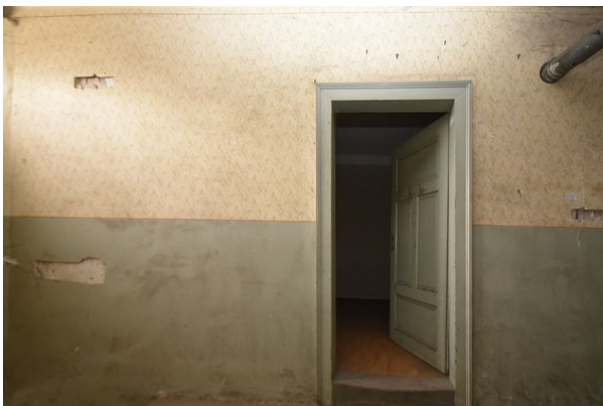
Frontalansicht Wand d (südlicher Teil), Raum 0.02, mit Blickrichtung Westen;
