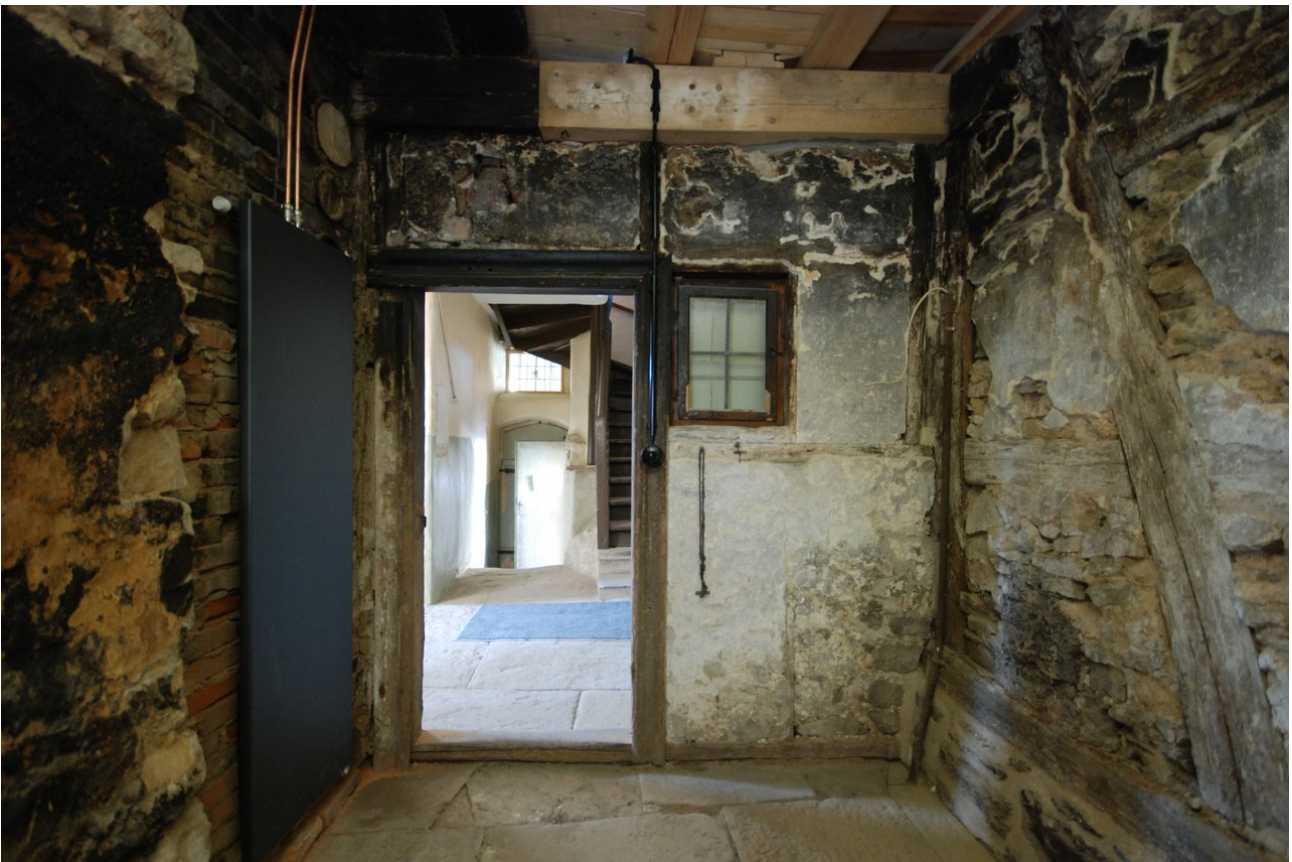
Ansicht der fertig sanierten Wand
