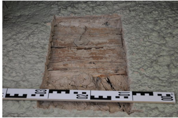
Hof Nordfassade Öffnung 1 (Bereich um Rahmenbalken des 1. OG) Abb.14:
