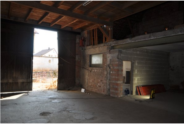
Wände cd (streberwerk. 13.08.2015)
