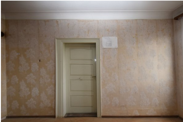
Frontalansicht Wand b, Raum 1.04, mit Blickrichtung Osten;
