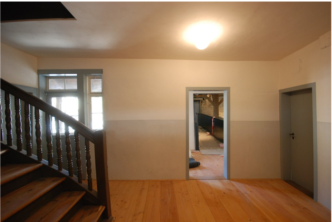
Ansicht fertig sanierte Wand
