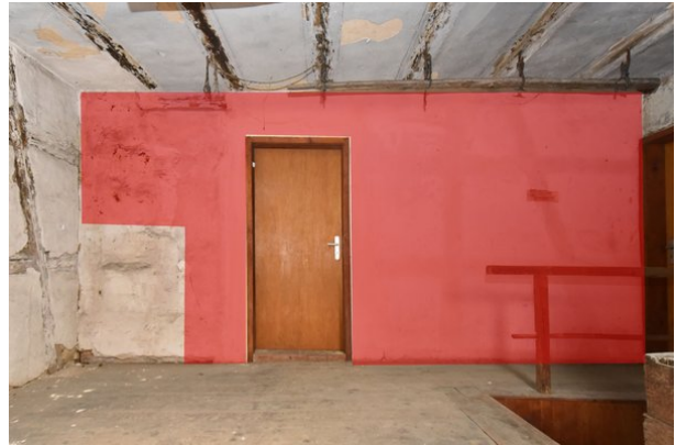
Frontalansicht Wand c, Raum 2.01, mit Blickrichtung Süden; Kartierung der im Original zu erhaltenden Bereiche in dunkelrot;
