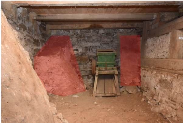
Frontalansicht Wand b, Raum 0.09, mit Blickrichtung Osten; Kartierung der besonders sensiblen Bereiche in rot;
