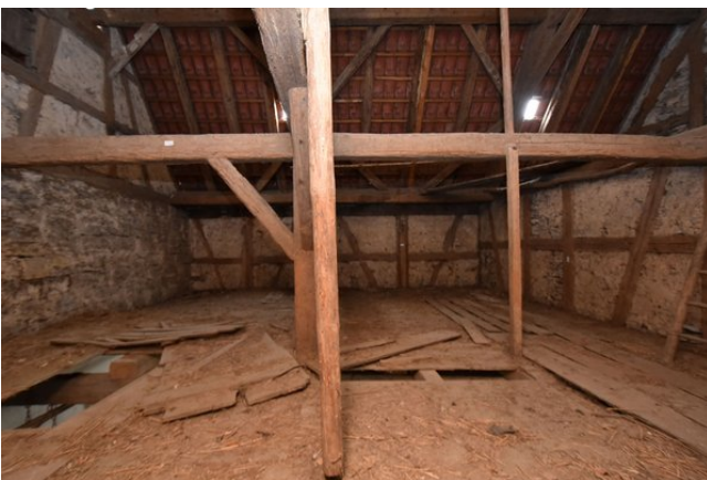
Frontalansicht Wand b, Raum 2.06, mit Blickrichtung Osten;
