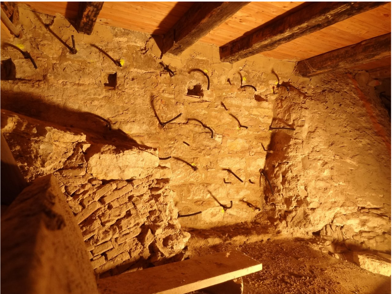
Sanierung und Sicherung Natursteinmauerwerk der Giebelwand
