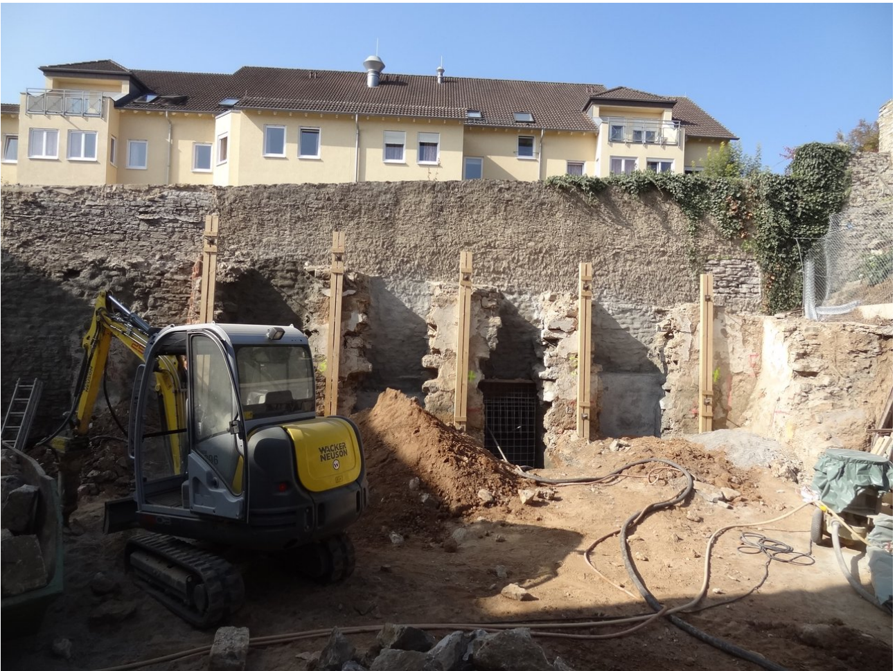
Herstellen der Unterfangungsabschnitte
