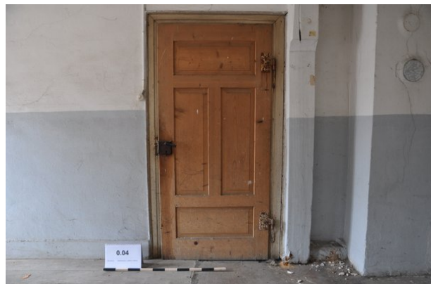
Raum 0.04d, Detailansicht der Tür zu Raum 0.02 mit Blickrichtung Westen (streberwerk. 13.08.2015)
