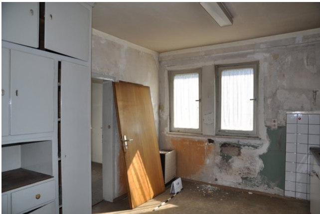
Raum 1.06ab, Diagonalaufnahme mit Blickrichtung Nordosten (strebewerk. 13.08.2015)
