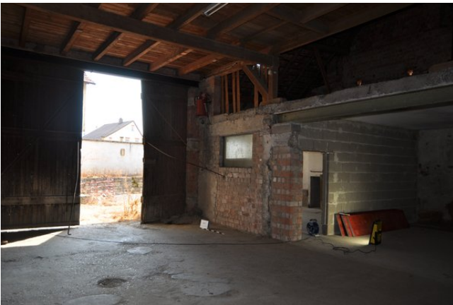
Raum 0.11cd, Diagonalaufnahme mit Blickrichtung Südwesten (strebewerk. 12.08.2015)
