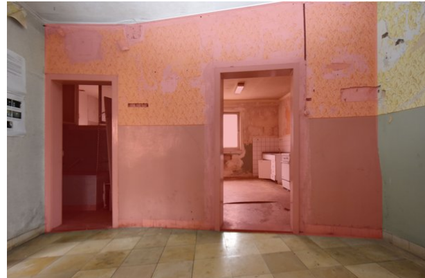
Frontalansicht Wand b, Raum 1.01, mit Blickrichtung Osten; Kartierung der besonders sensiblen Bereiche in rot;
