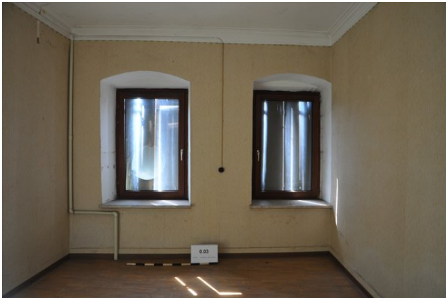
Raum 0.03c, Frontalansicht Wand c mit Blickrichtung Süden (streberwerk. 13.08.2015)
