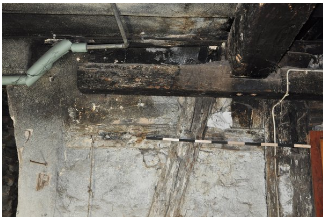
Raum 0.06c, Detailansicht des Unterzugs an Wand c mit Blickrichtung Süden (streberwerk. 13.08.2015)
