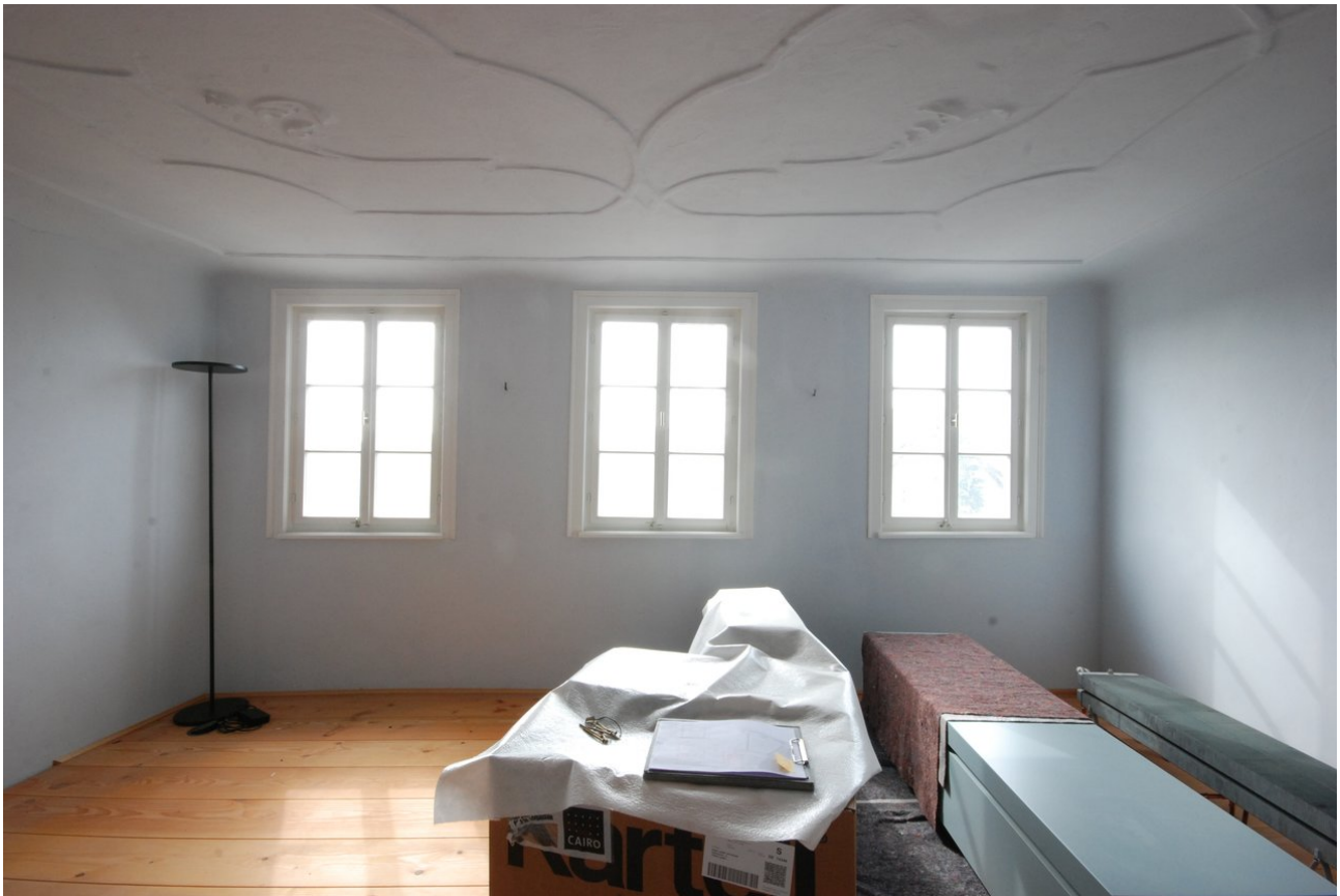
Ansicht der fertig sanierten Wand vor Einbau Ausstellungsmobiliar
