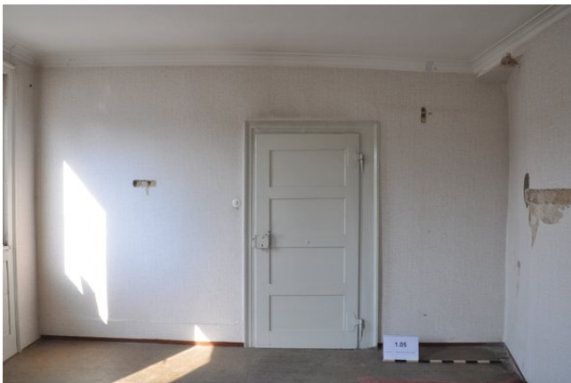
Raum 1.05d, Frontalansicht Wand d mit Blickrichtung Süden (streberwerk. 13.08.2015)
