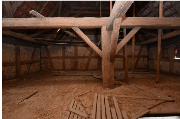
Frontalansicht Wand c, Raum 2.06, mit Blickrichtung Süden;
