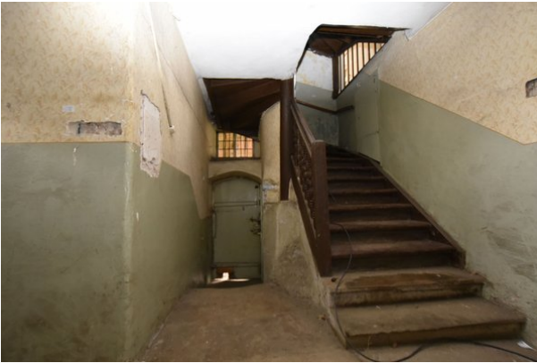
Frontalansicht Wand d (nördlicher Teil), Raum 0.02, mit Blickrichtung Westen;
