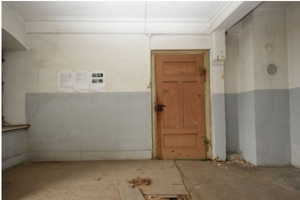
Frontalansicht Wand d, Raum 0.04, mit Blickrichtung Westen;
