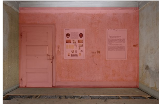
Frontalansicht Wand b, Raum 1.02, mit Blickrichtung Osten; Kartierung der besonders sensiblen Bereiche in rot;
