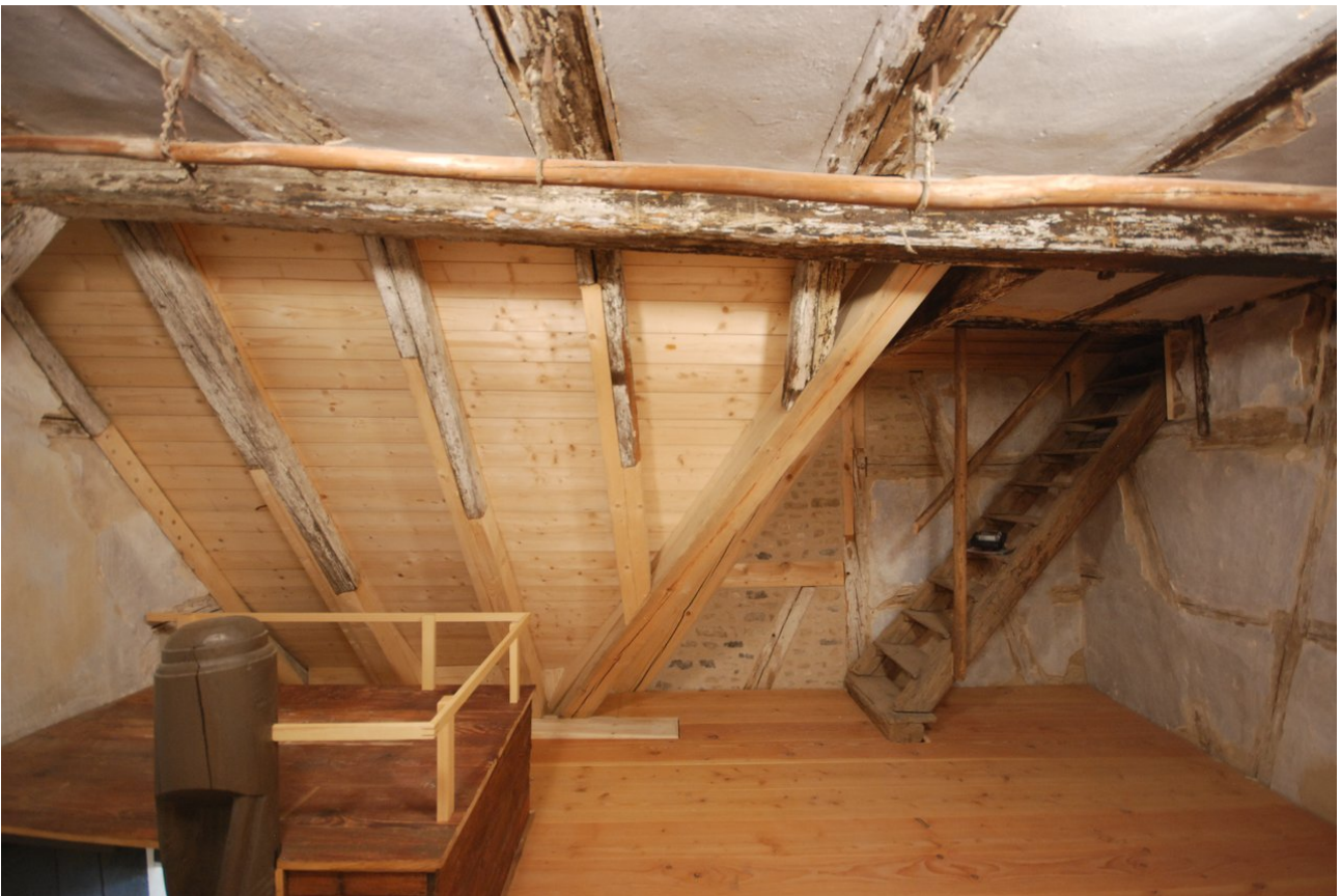
Ansicht fertig sanierte Wand
