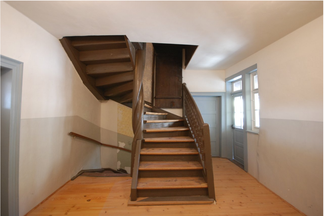
Ansicht fertig sanierte Wand
