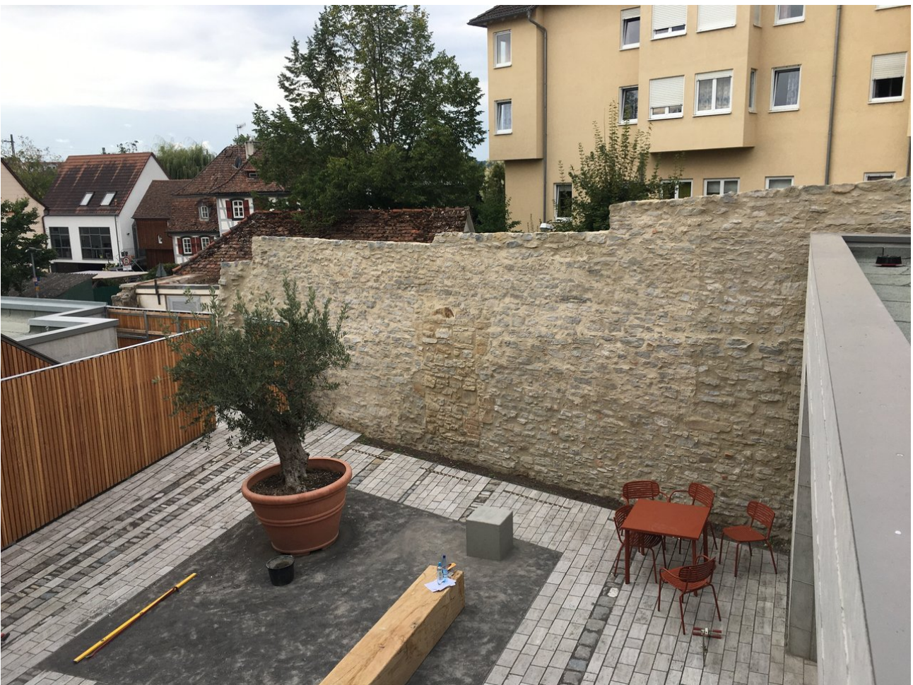
Ansicht sanierte Klostermauer
