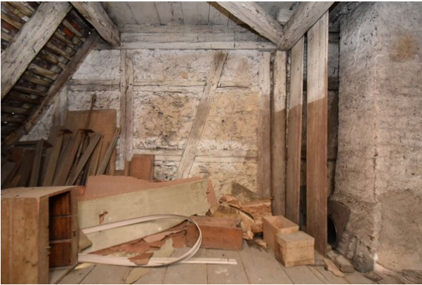
Frontalansicht Wand d (südlicher Teil), Raum 2.05, mit Blickrichtung Westen;
