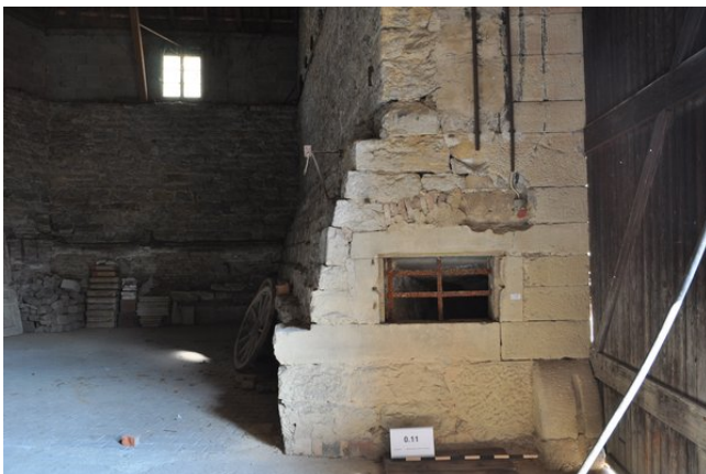
Raum 0.11ab, Detailansicht des Kellerfensters zu Raum -1.02 mit Blickrichtung Osten (strebewerk. 12.08.2015)
