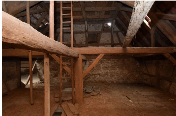
Frontalansicht Wand a, Raum 2.06, mit Blickrichtung Norden;
