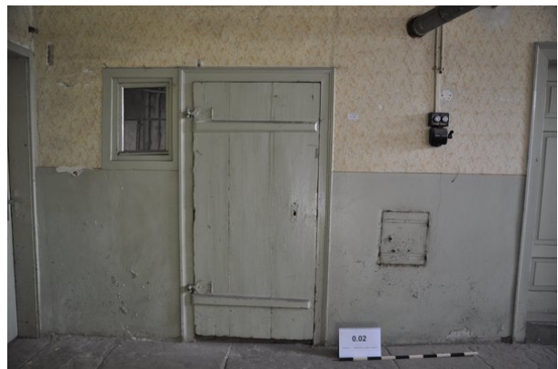
Raum 0.02b, Detailansicht der nördlichen Tür der Ostwand zu Raum 0.05 mit Blickrichtung Osten (strebewerk. 12.08.2015)
