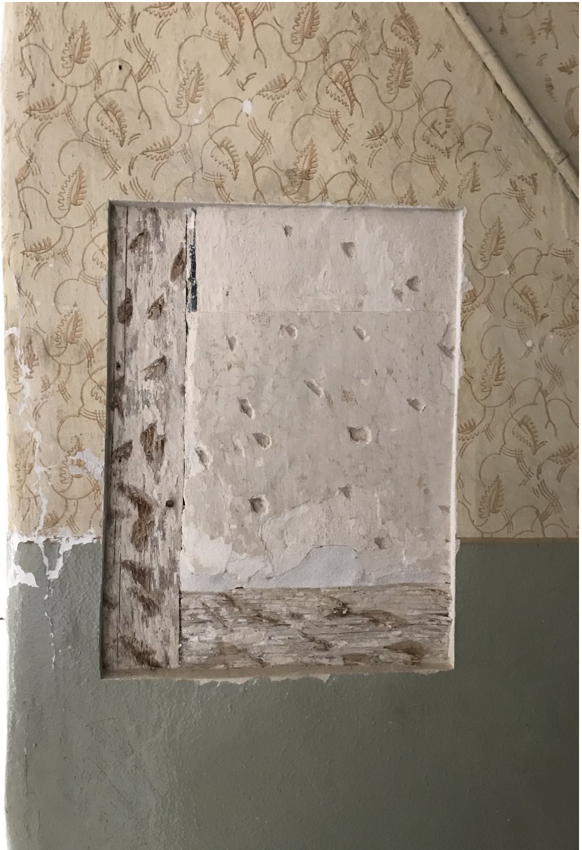
Bauarchäologisches Fenster mit Fachwerkkonstruktion
