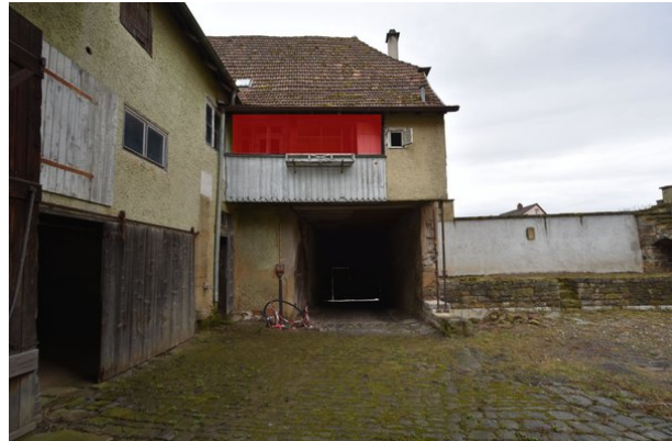
Frontalansicht der Außenseite von Wand a, Raum 1.02, mit Blickrichtung Süden; Kartierung der im Original zu erhaltenden Bereiche in dunkelrot;
