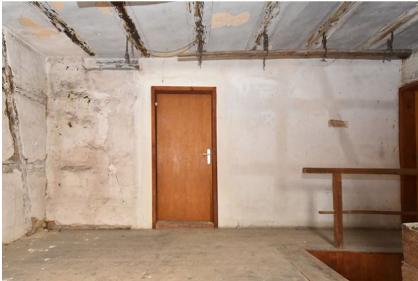
Frontalansicht Wand c, Raum 2.01, mit Blickrichtung Süden;
