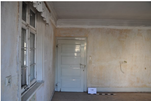
Raum 1.02b, Detailansicht der Tür zu Raum 1.01 mit Blickrichtung Osten (strebewerk. 13.08.2015)
