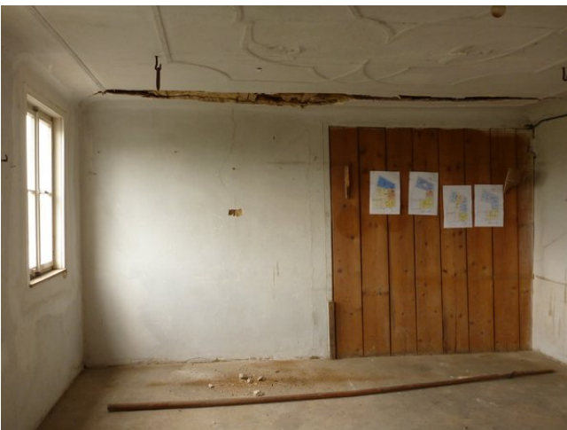
Raum 2.04d, Frontalansicht Wand d mit Blickrichtung Westen (streberwerk. 13.08.2015)
