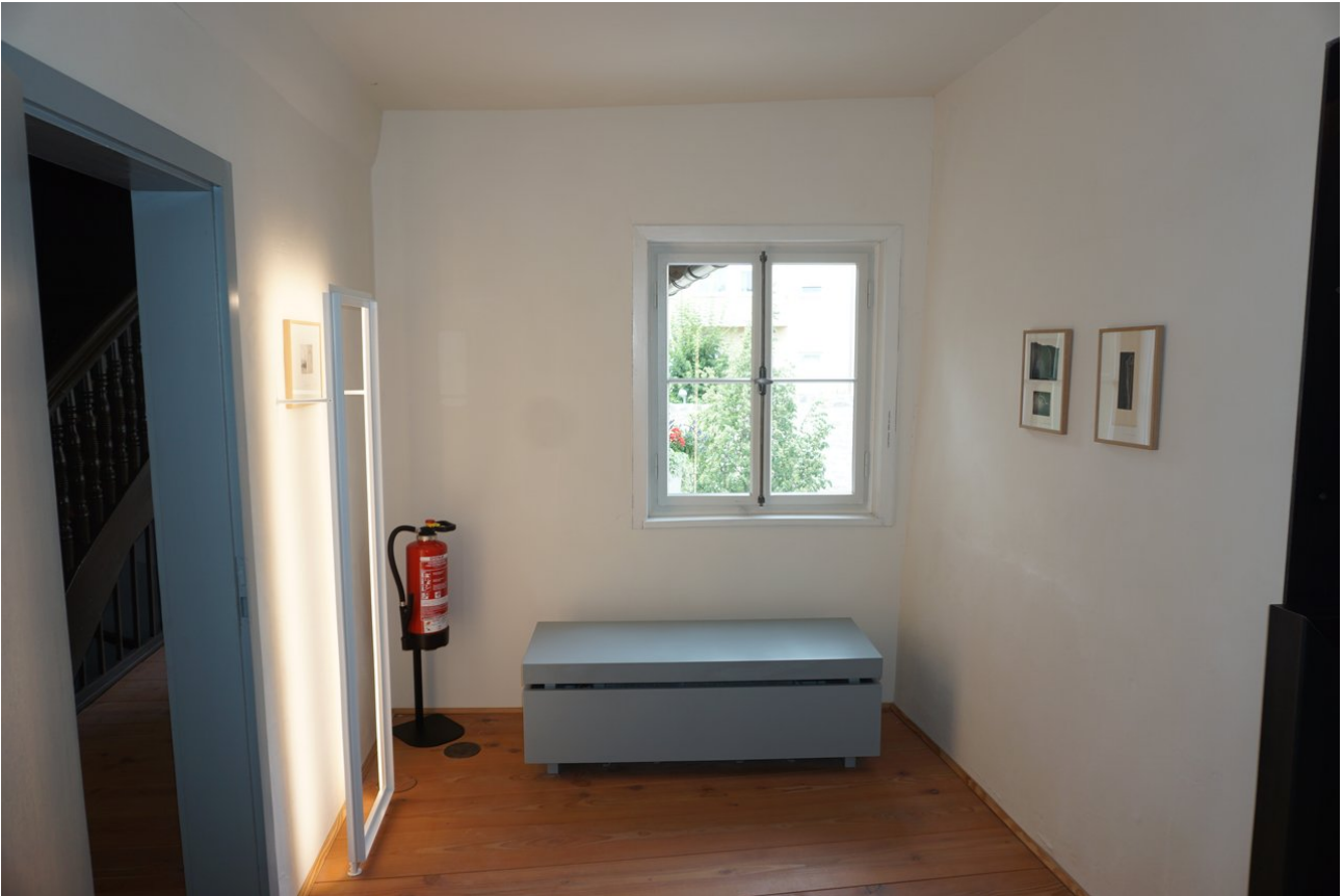
Ansicht fertig sanierte Wand
