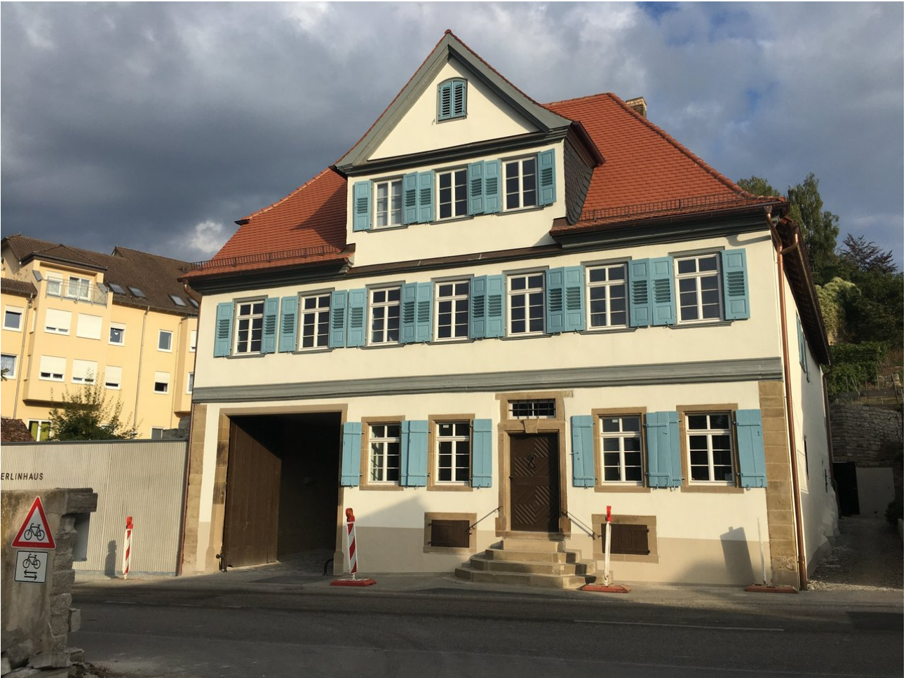
Ansicht der fertig sanierten Fassade
