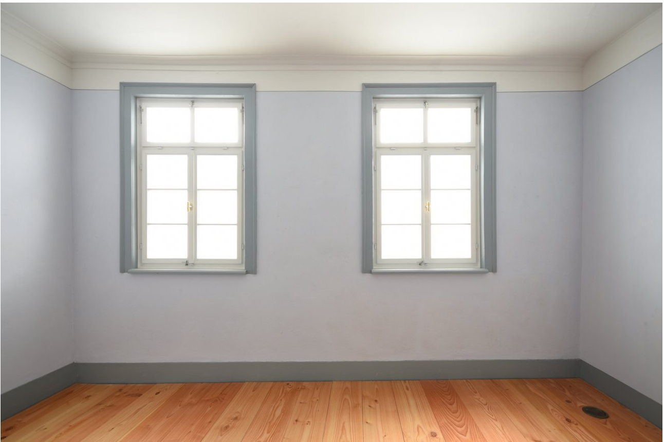
Ansicht fertig sanierte Wand vor Einbau Ausstellungsmobiliar
