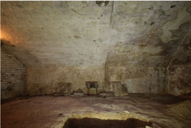
Frontalansicht Wand b, Raum -1.01, mit Blickrichtung Osten;
