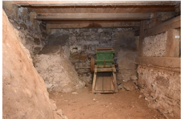
Frontalansicht Wand b, Raum 0.09, mit Blickrichtung Osten;
