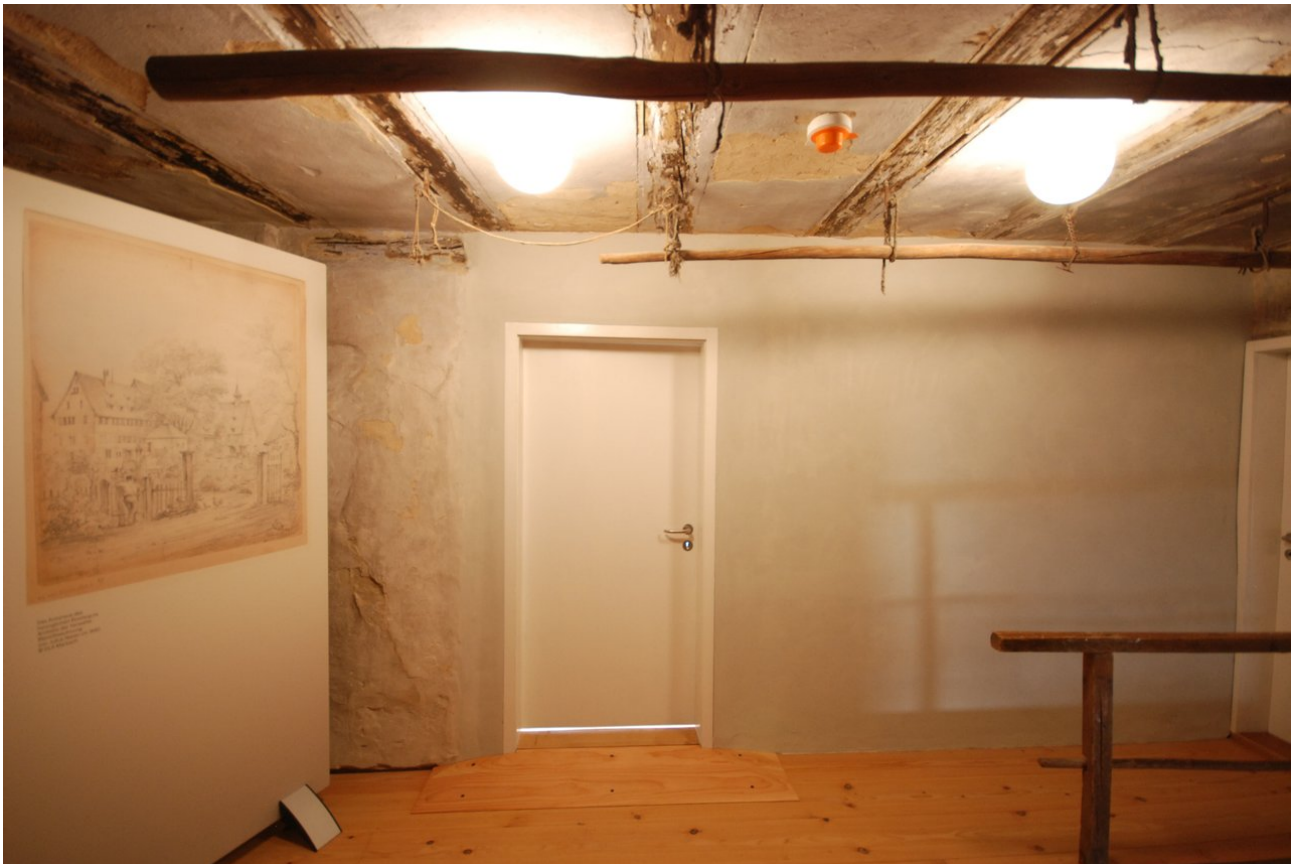
Ansicht fertig sanierte Wand
