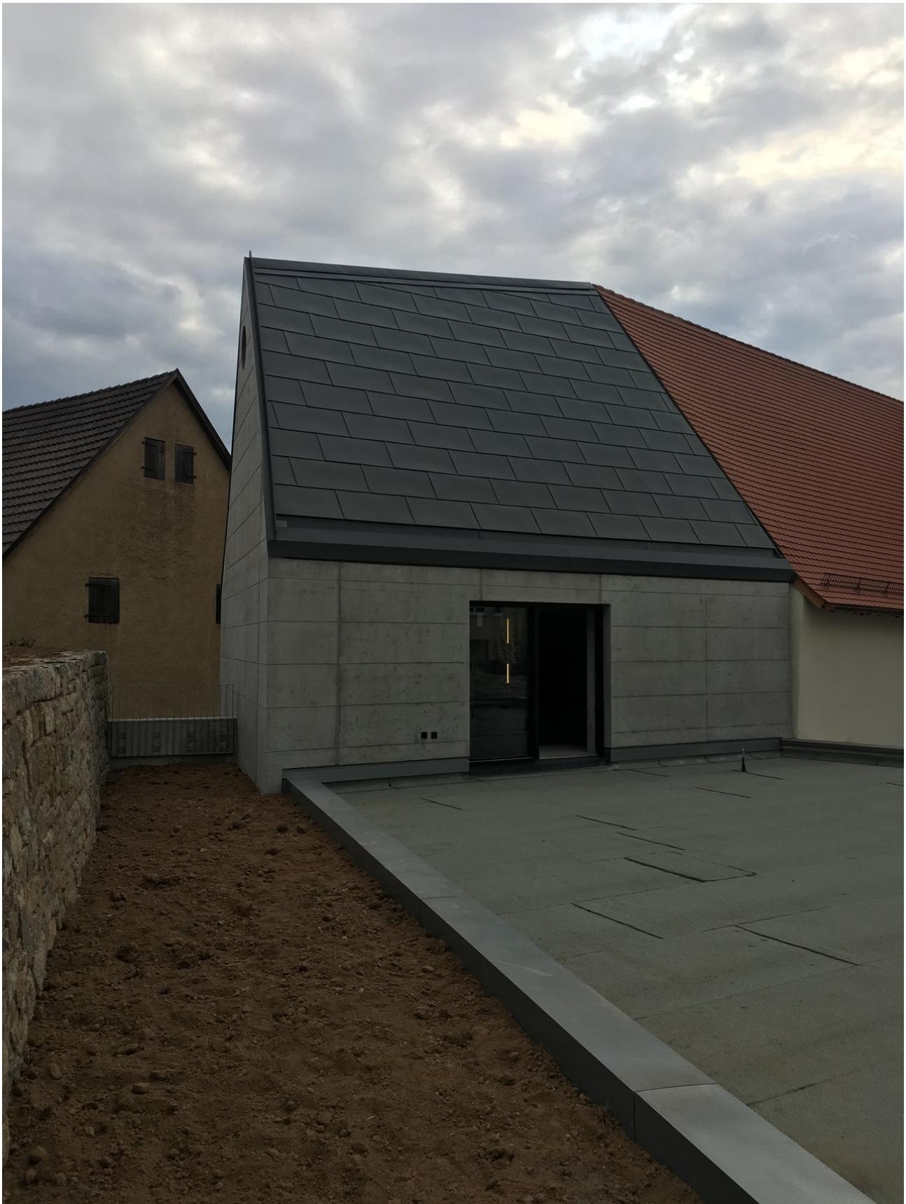
Neubau / Anbau von Westen
