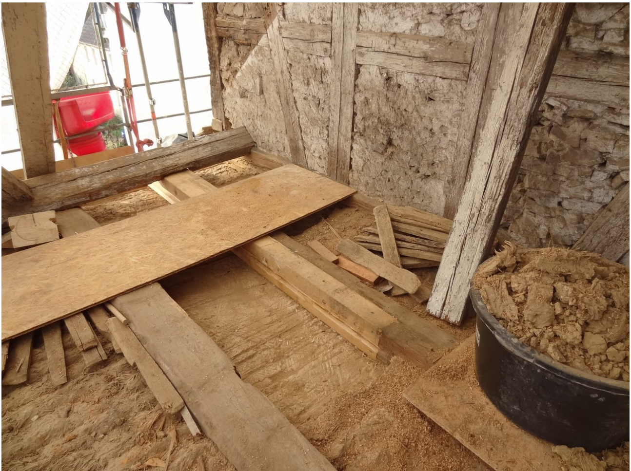
Sanierung Deckenbalken
