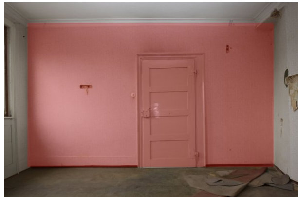
Frontalansicht Wand d, Raum 1.05, mit Blickrichtung Westen; Kartierung der besonders sensiblen Bereiche in rot;
