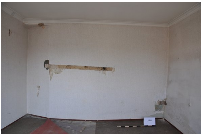
Raum 1.05a, Frontalansicht Wand a mit Blickrichtung Süden (strebewerk. 13.08.2015)
