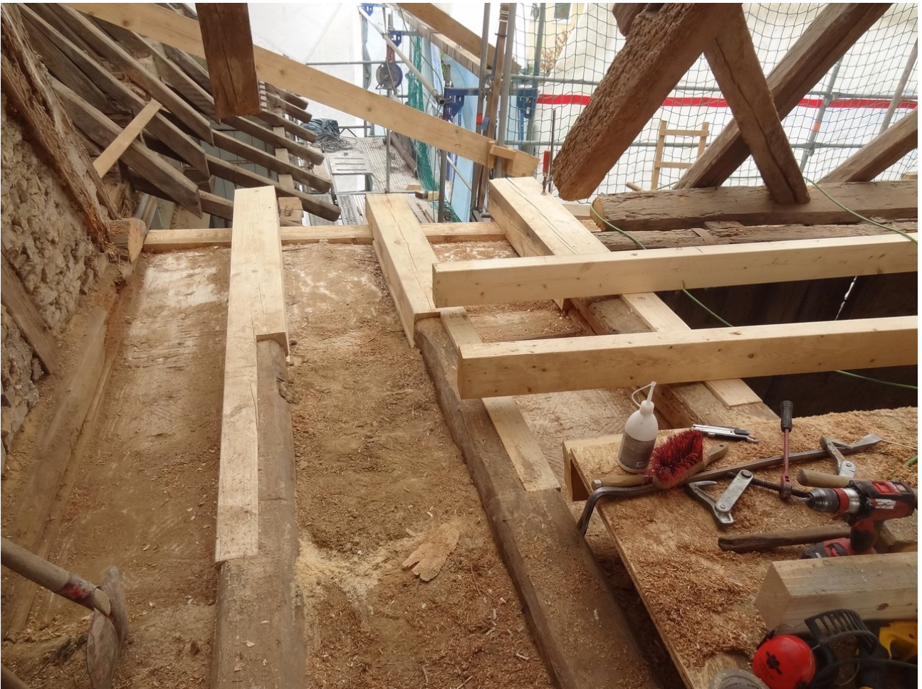
Sanierte Deckenbalken
