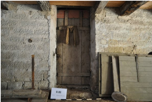
Raum 0.08c, Detailansicht der Tür zu Raum 0.06 mit Blickrichtung Süden (streberwerk. 13.08.2015)
