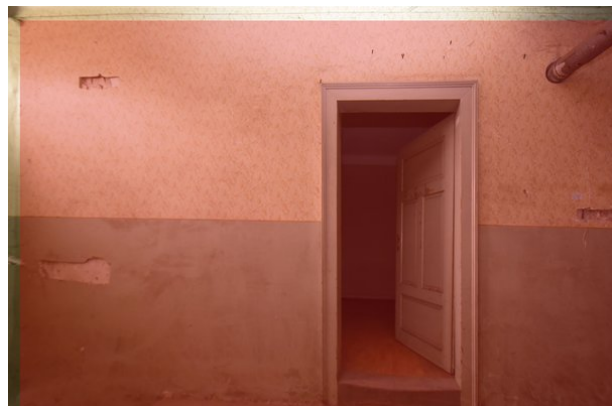
Frontalansicht Wand d (südlicher Teil), Raum 0.02, mit Blickrichtung Westen; Kartierung der besonders sensiblen Bereiche in rot;
