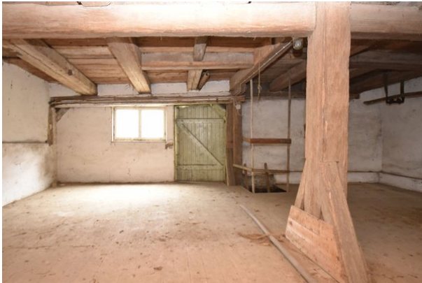
Frontalansicht Wand d, Raum 1.13, mit Blickrichtung Westen;
