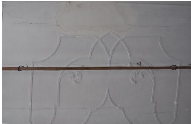
Stuckdecke Detail Ostteil (strebewerk. 13.08.2015)
