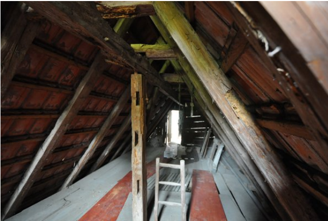
Spitzboden R302c (streberwerk. 05.10.2015)
