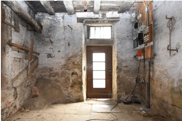
Frontalansicht Wand d, Raum 0.06, mit Blickrichtung Westen;
