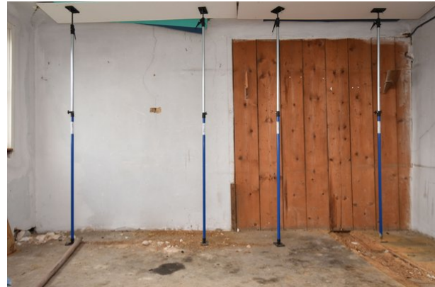
Frontalansicht Wand d, Raum 2.04, mit Blickrichtung Westen;
