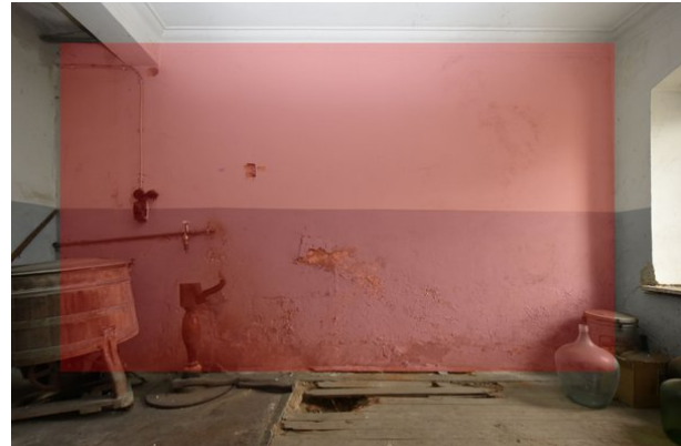
Frontalansicht Wand b, Raum 0.04, mit Blickrichtung Osten; Kartierung der besonders sensiblen Bereiche in rot;
