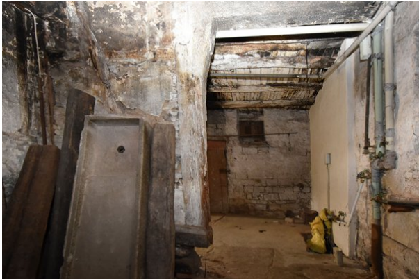
Frontalansicht Wand a, Raum 0.05, mit Blickrichtung Norden;
