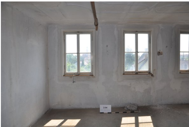
Raum 2.04c, Detailansicht der Fenster in Wand c mit Blickrichtung Süden (streberwerk. 13.08.2015)
