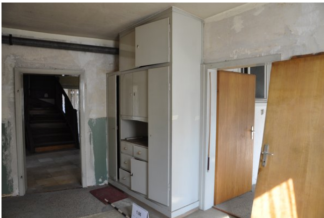
Raum 1.06da, Diagonalaufnahme mit Blickrichtung Nordwesten (streberwerk. 13.08.2015)
