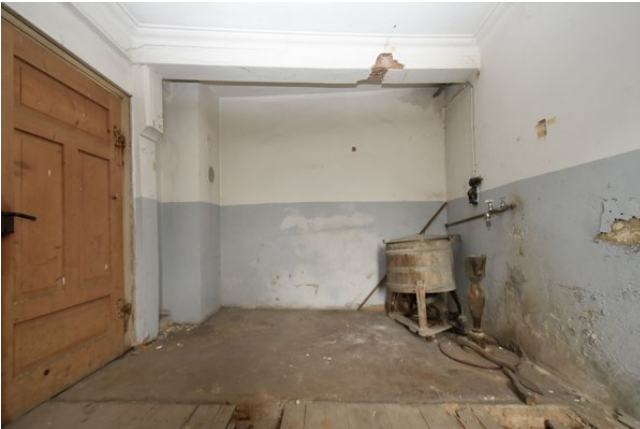
Frontalansicht Wand a, Raum 0.04, mit Blickrichtung Norden;
