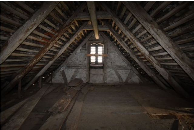
Frontalansicht Wand c, Raum 3.01, mit Blickrichtung Süden;
