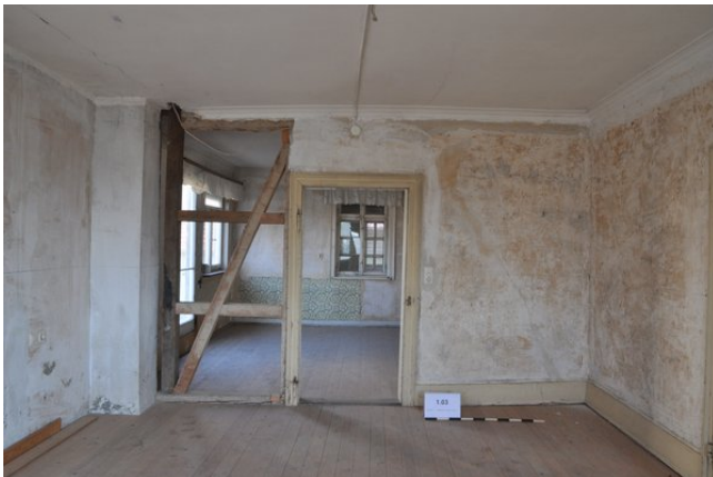
Raum 1.03a, Frontalansicht Wand a mit Blickrichtung Norden (strebewerk. 13.08.2015)
