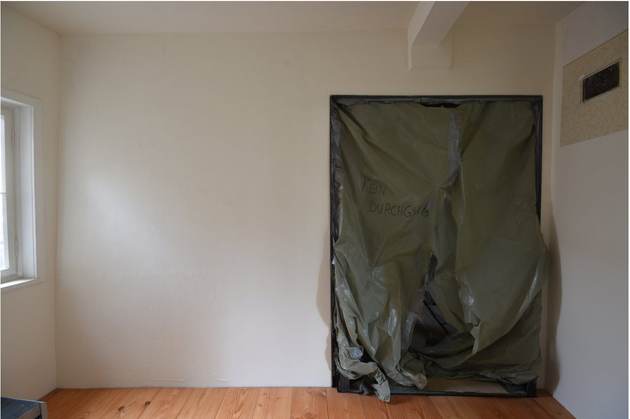
Ansicht fertig sanierte Wand während der Bauarbeiten
