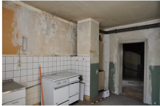
Wände cd (streberwerk. 13.08.2015)
