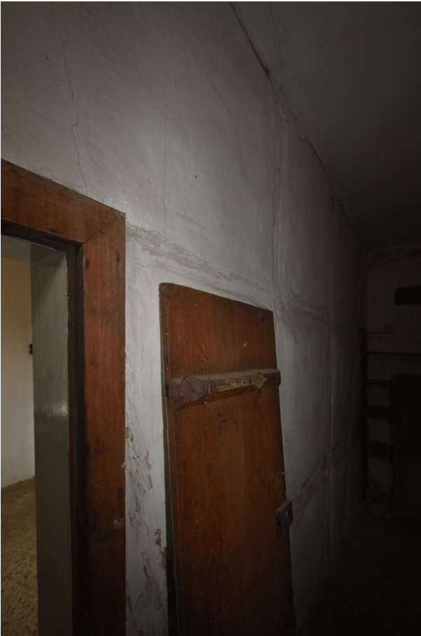
Frontalansicht Wand c, Raum 1.09, mit Blickrichtung Süden;
