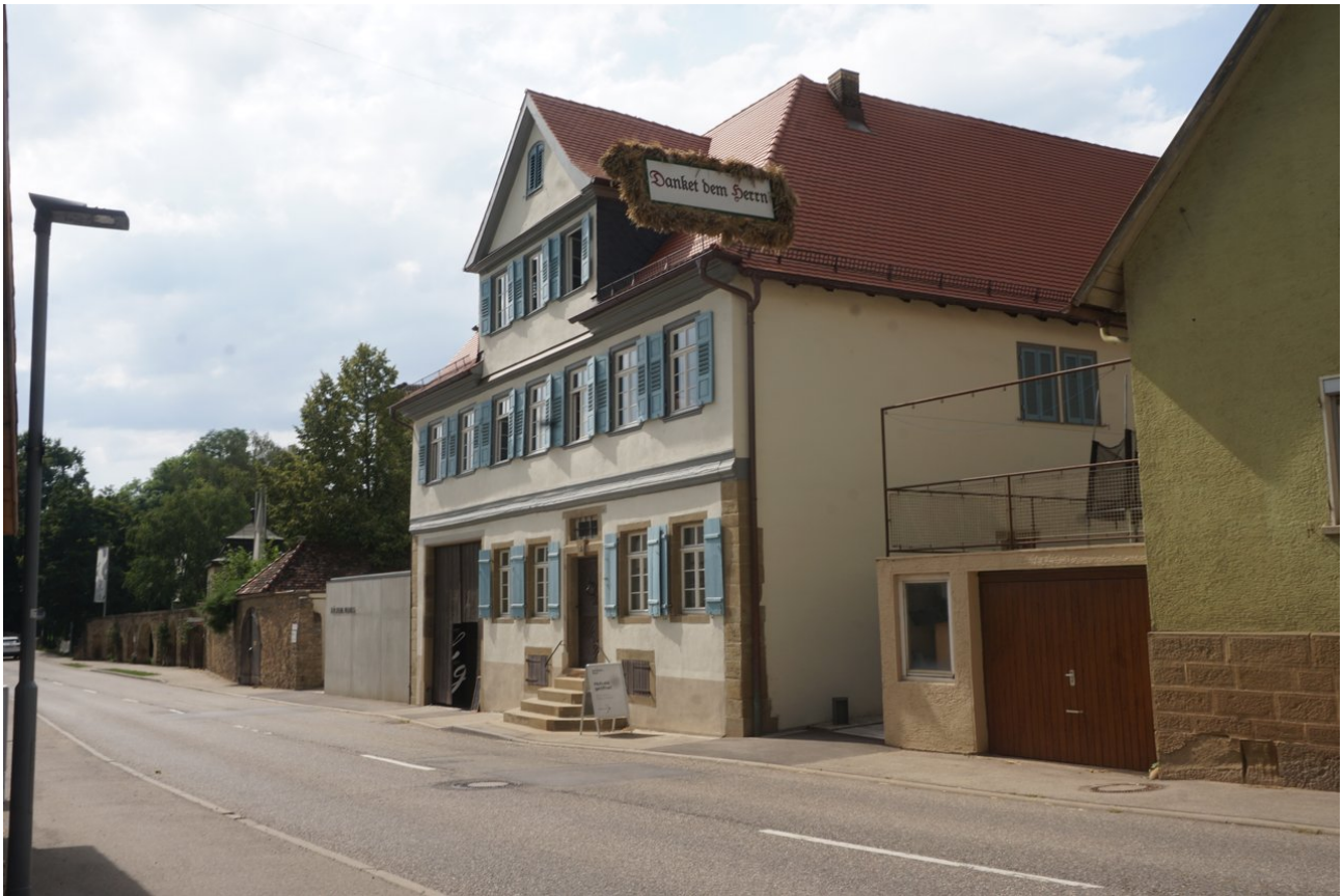
Ansicht von SO
