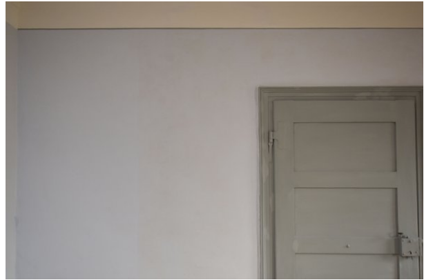
Detailansicht Wand b, Raum 1.03, mit Blickrichtung Osten; Wand mit Bemusterungsflächen (blaugrau)
