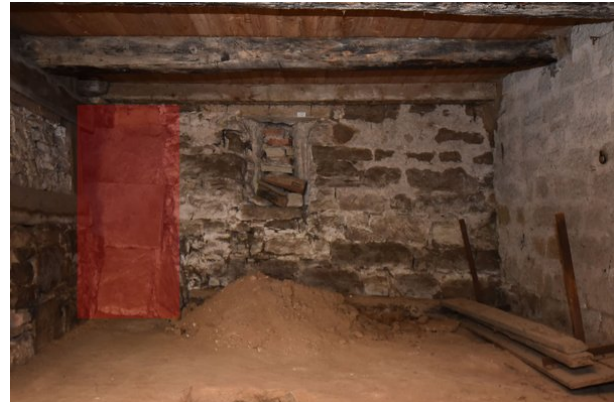
Frontalansicht Wand b, Raum 0.08, mit Blickrichtung Osten; Kartierung der besonders sensiblen Bereiche in rot;
