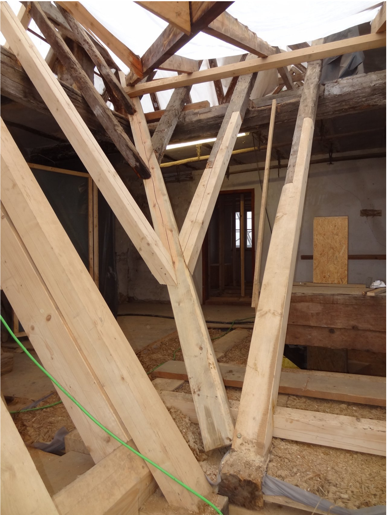
Sanierung Kehlsparren, Sparren und Sparrenschifter
