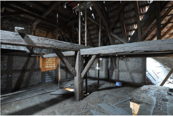
Dachraum Scheune R206cd (streberwerk. 05.10.2015)
