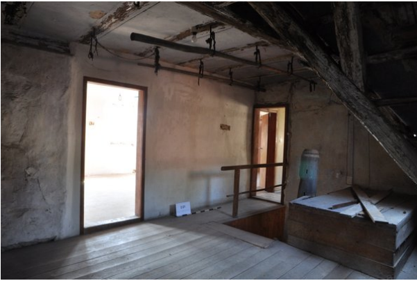
Wände cd (streberwerk. 13.08.2015)
