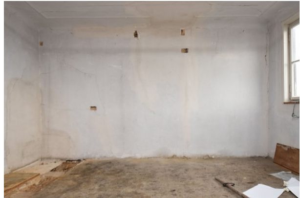
Frontalansicht Wand b, Raum 2.04, mit Blickrichtung Osten;
