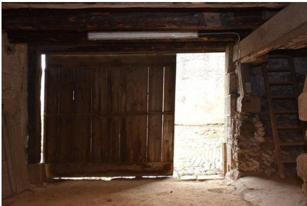
Frontalansicht Wand d, Raum 0.08, mit Blickrichtung Westen;
