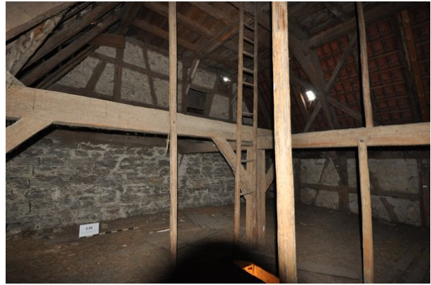
Dachraum Scheune R206ab (streberwerk. 05.10.2015)
