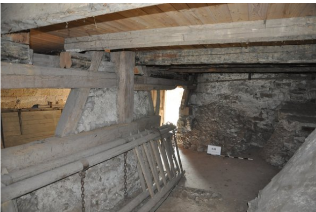
Raum 0.09cd, Diagonalaufnahme mit Blickrichtung Südwesten (strebewerk. 13.08.2015)
