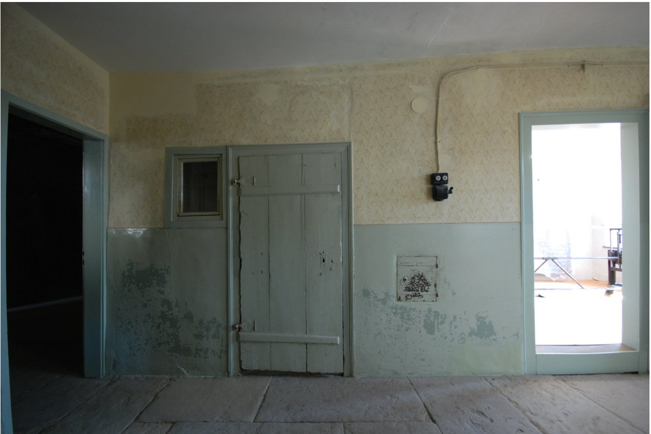
Ansicht der fertig sanierten Wand
