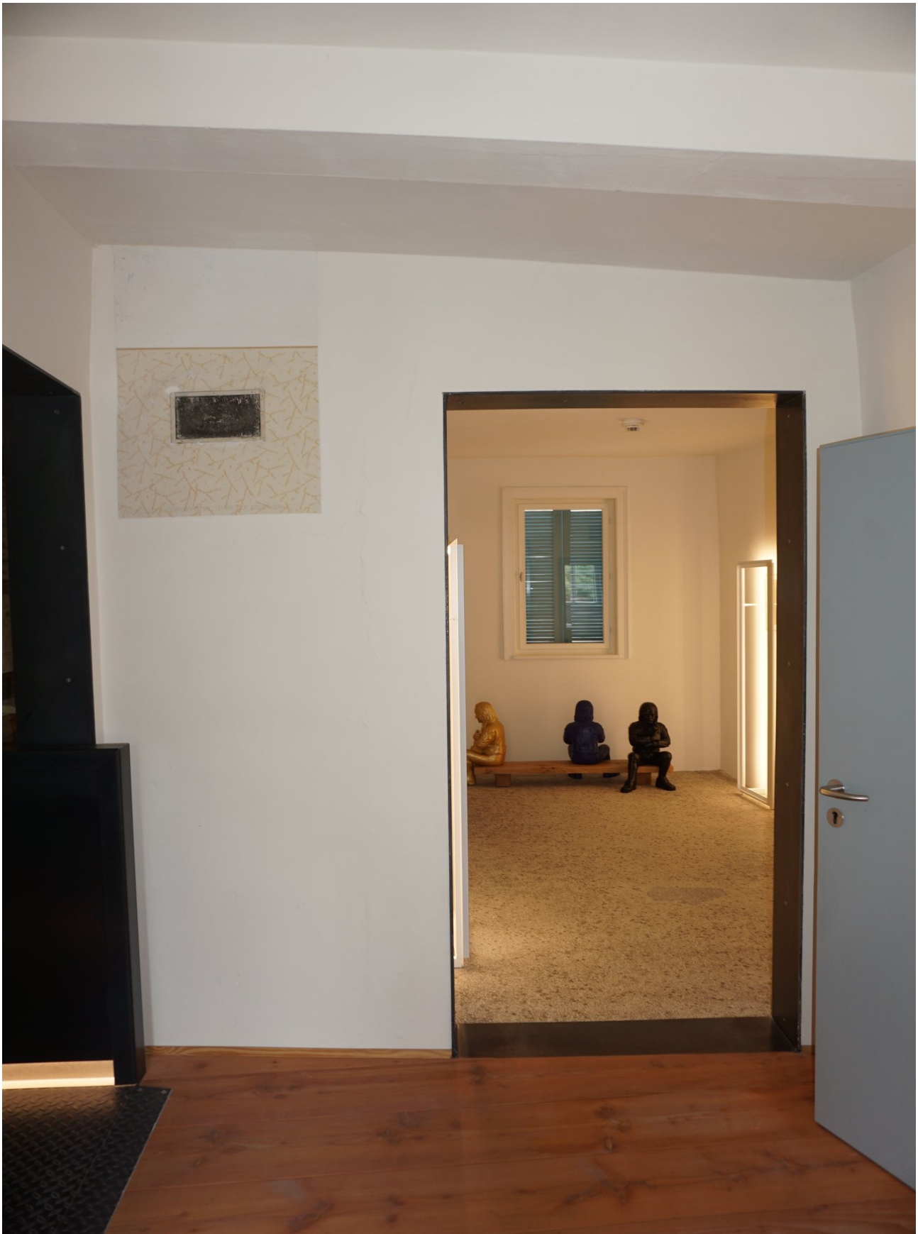
Ansicht fertig sanierte Wand
