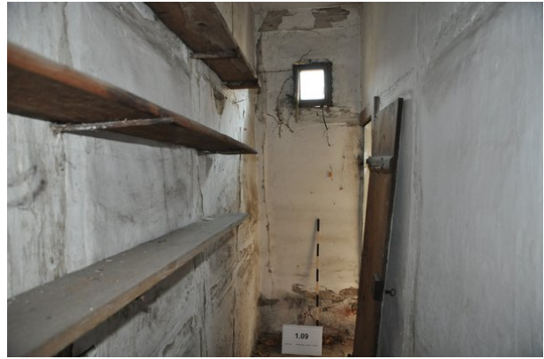
Wände abc (streberwerk. 13.08.2015)
