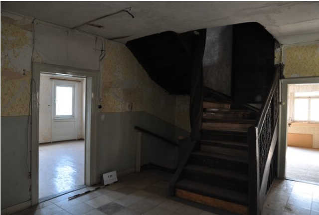
Raum 1.01cd, Diagonalaufnahme mit Blickrichtung Südwesten (strebewerk. 13.08.2015)
