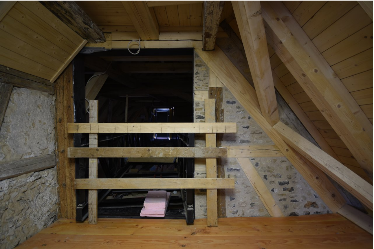
Ansicht während der Sanierung
