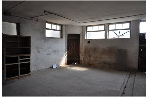
Wände bc (streberwerk. 13.08.2015)
