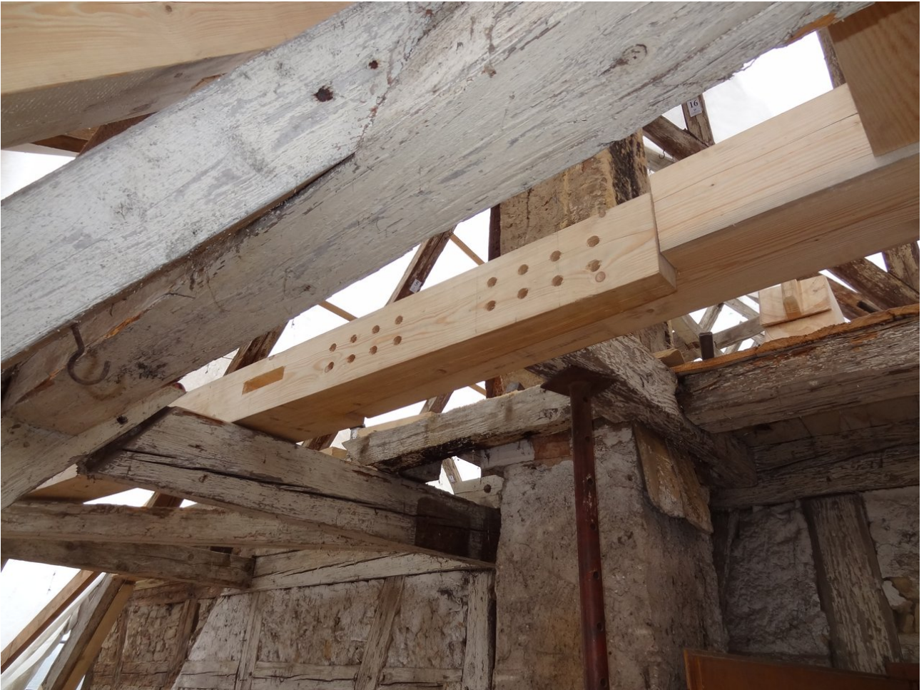
Sanierung des Kehlbalkenwechsels. Vorbereitung des stehenden Blattstoßes
