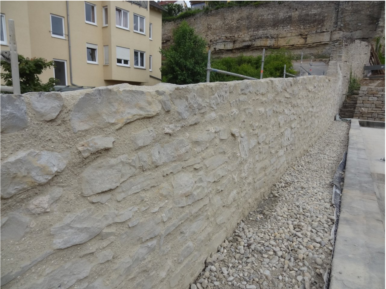
Klostermauer nach der Sanierung
