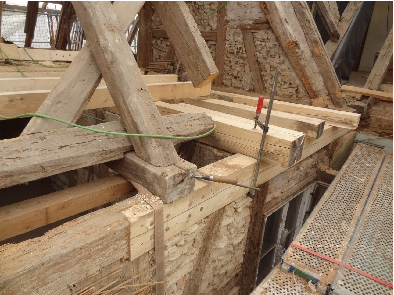
Sanierte Deckenbalken und Wandrähm. Hölzer des Dachtragwerks für die Sanierung vorbereitet.
