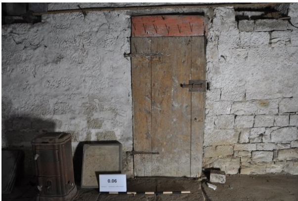
Raum 0.06a, Detailansicht der Tür zu Raum 0.08 mit Blickrichtung Norden (strebewerk. 13.08.2015)
