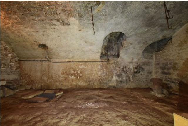
Frontalansicht Wand d, Raum -1.02, mit Blickrichtung Westen;
