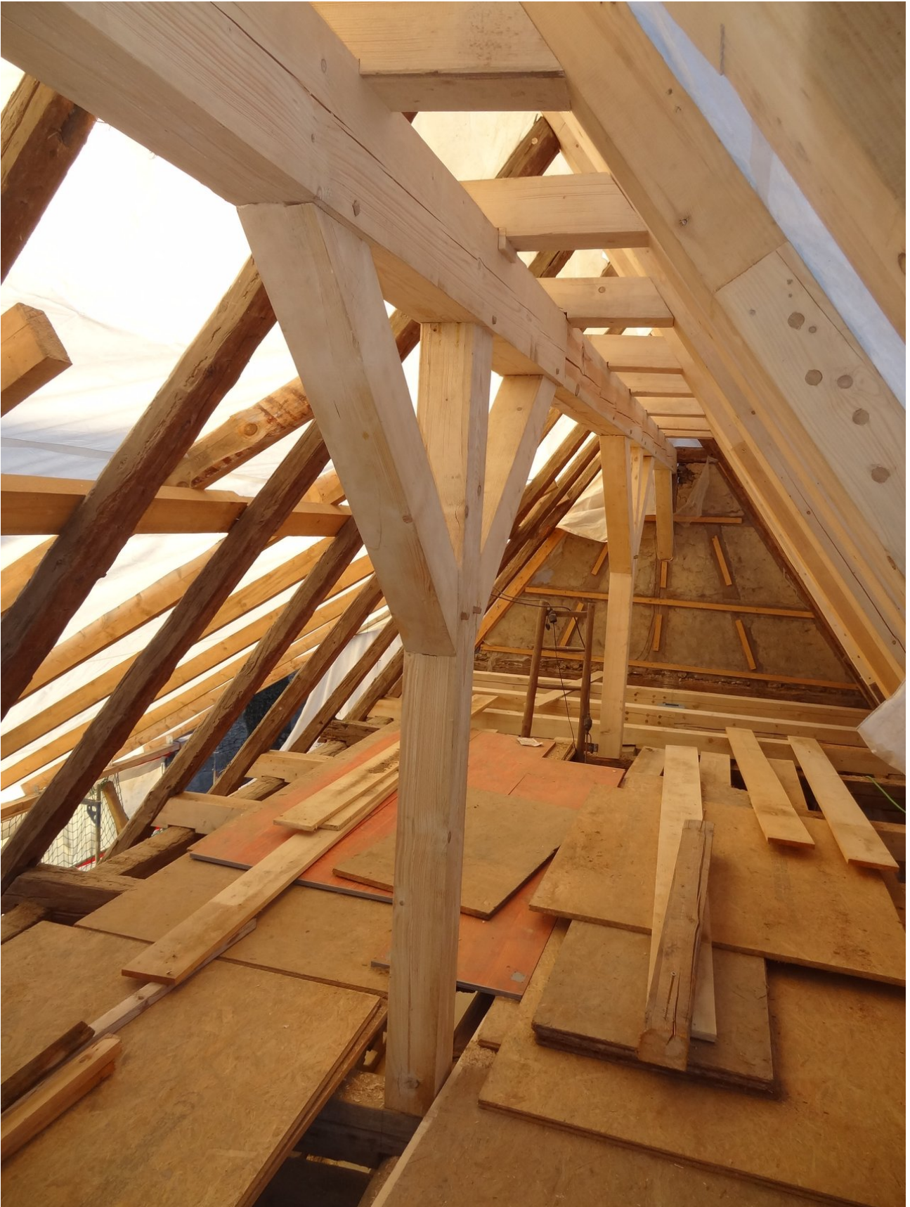
Sanierung Dachtragwerk
