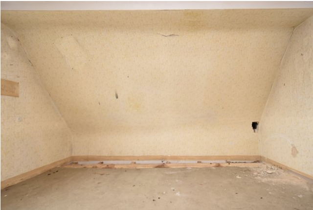
Frontalansicht Wand a, Raum 2.02, mit Blickrichtung Norden;
