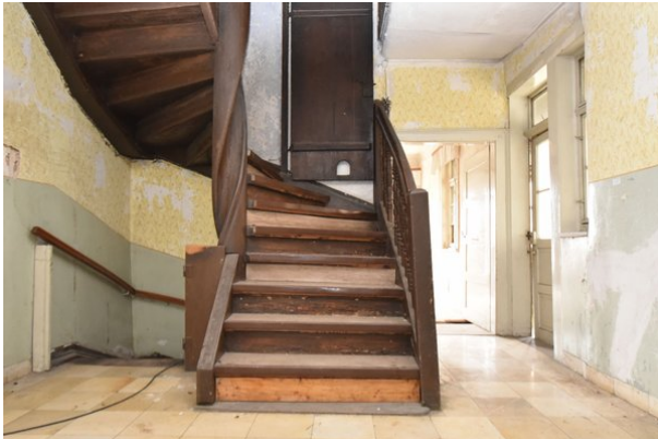
Frontalansicht Wand d, Raum 1.01, mit Blickrichtung Westen;
