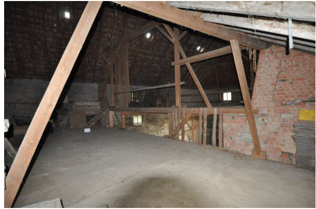
Stalleinbau, Wände ab (strebewerk. 05.10.2015)
