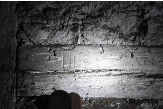
Raum 2.05a, Detailansicht der Abbundzeichen an Wand a mit Blickrichtung Norden (streberwerk. 13.08.2015)
