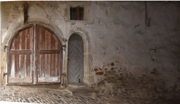
Frontalansicht Wand b, Raum 0.01, mit Blickrichtung Osten;
