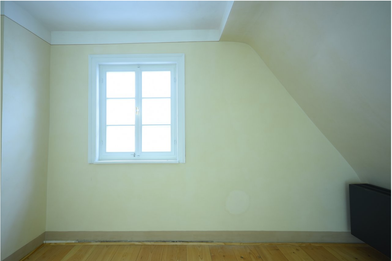
Ansicht fertig sanierte Wand
