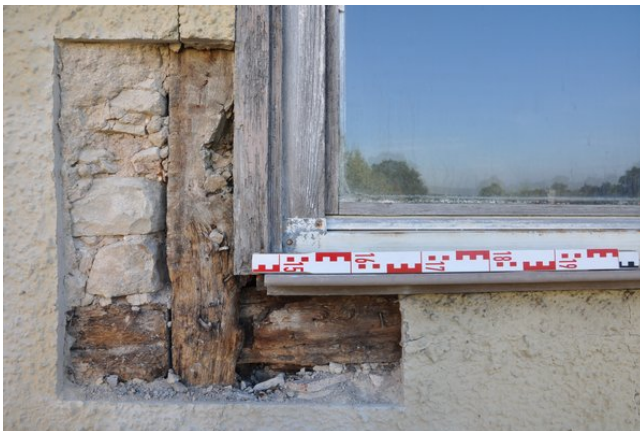
Wohnhaus Westfassade, Öffnung 2 (Bereich unterhalb Fenster im 1. DG) Abb. 18:
