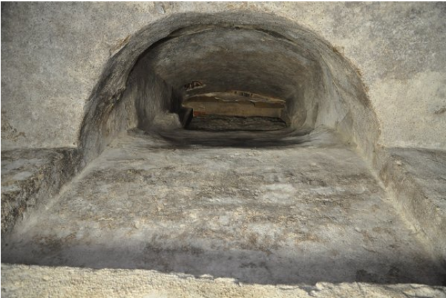
Raum -1.02a, Detailansicht des Lichtschachts an Wand a mit Blickrichtung Norden (streberwerk. 13.08.2015)
