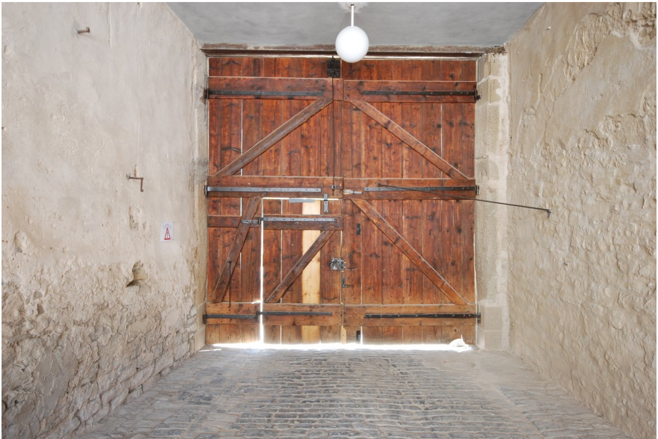
Innenansicht des fertig sanierten Tors
