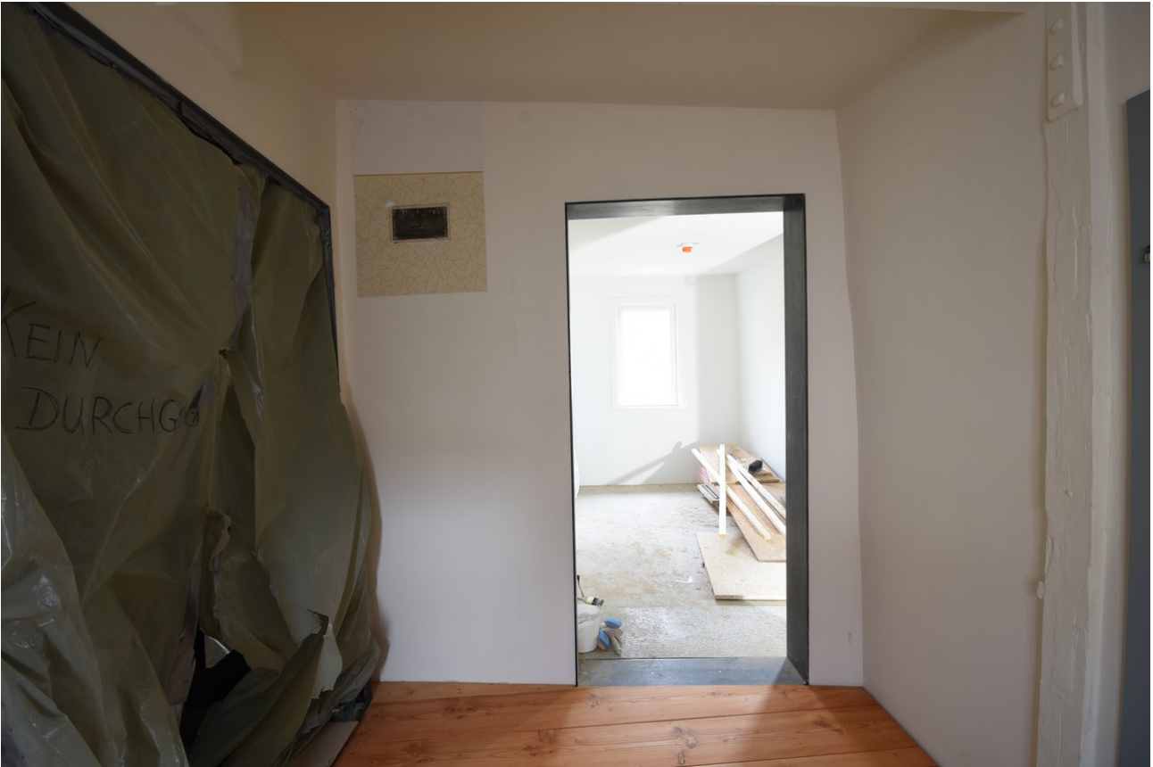
Ansicht fertig sanierte Wand während der Bauarbeiten
