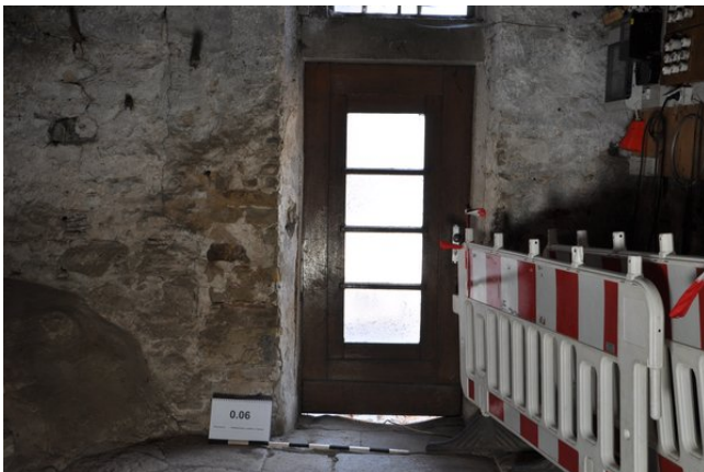
Raum 0.06d, Detailansicht der Tür zum Innenhof mit Blickrichtung Westen (strebewerk. 13.08.2015)
