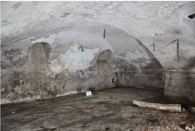
Raum -1.01cd, Diagonalaufnahme mit Blickrichtung Südwesten (streberwk. 13.08.2015)
