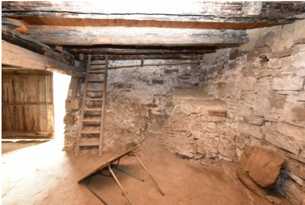
Frontalansicht Wand d, Raum 0.09, mit Blickrichtung Westen;
