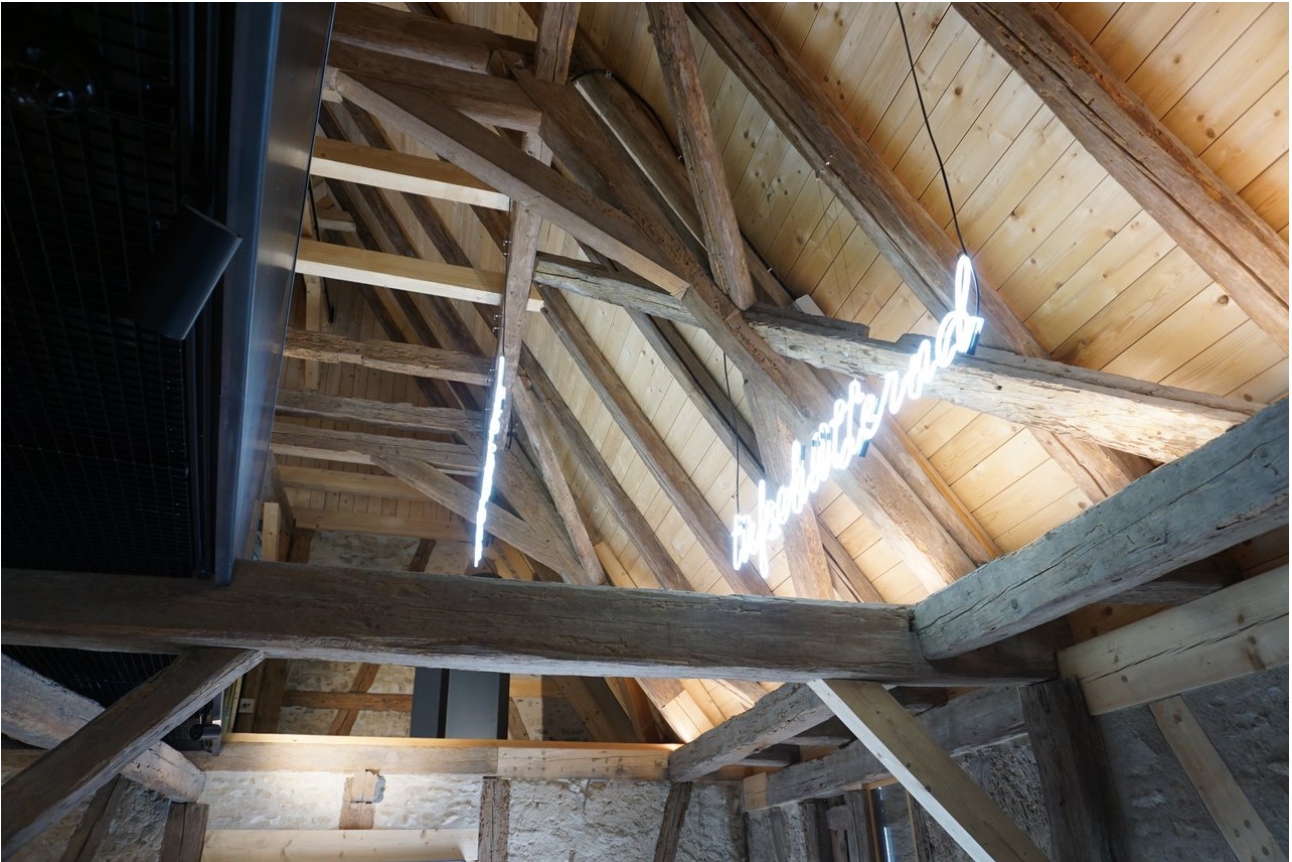
Ansicht Sparren Bestand mit neuer Schalung
