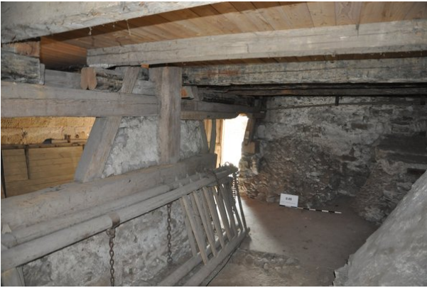
Wände cd (streberwerk. 13.08.2015)
