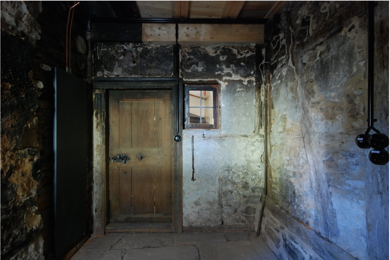
Ansicht der fertig sanierten Wand
