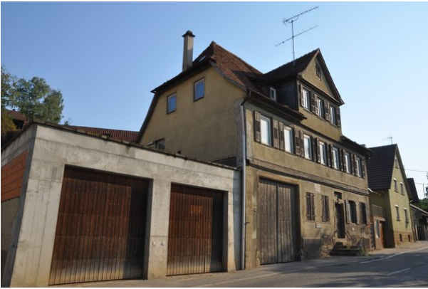
Straßenansicht der Südfassade mit moderner Garage von Westen kommend (strebewerk. 13.08.2015)
