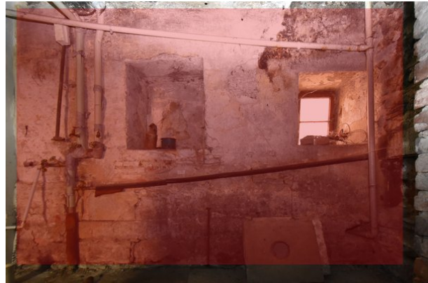
Frontalansicht Wand b, Raum 0.05, mit Blickrichtung Osten; Kartierung der besonders sensiblen Bereiche in rot;
