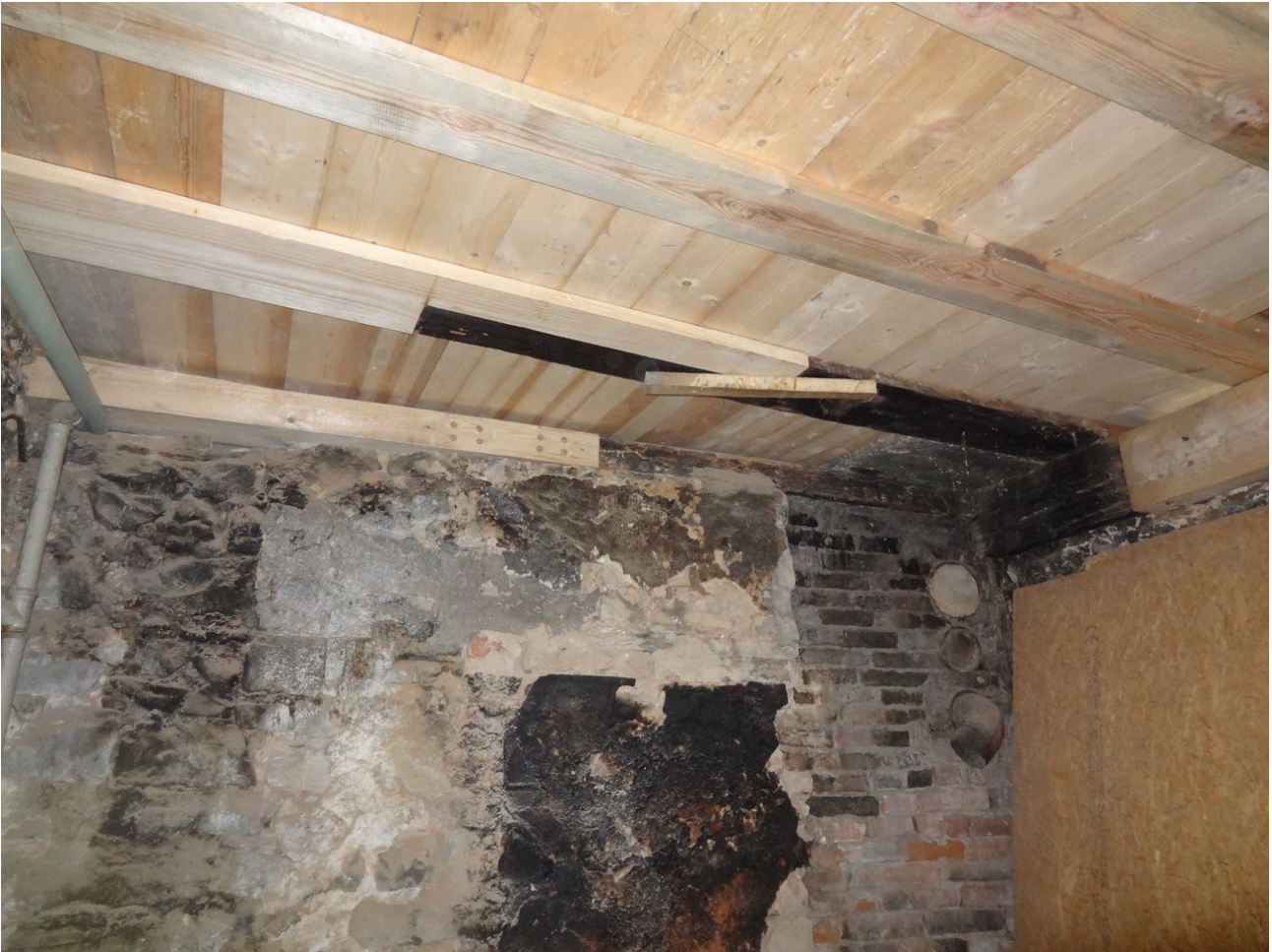
Untersicht der Decke nach Abschluss der Sanierungsmaßnahmen
