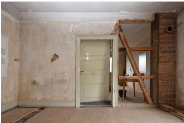
Frontalansicht Wand c, Raum 1.02, mit Blickrichtung Süden;
