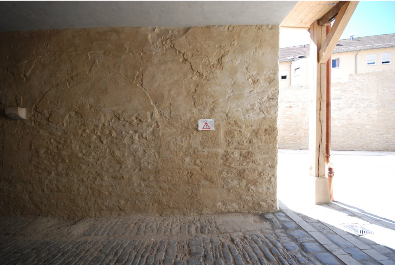
Ansicht fertig sanierte Wand
