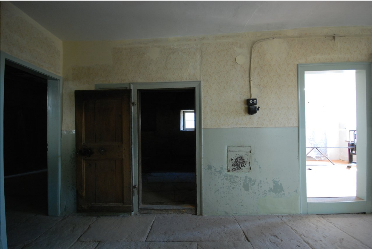
Ansicht der fertig sanierten nördlichen Hälfte
