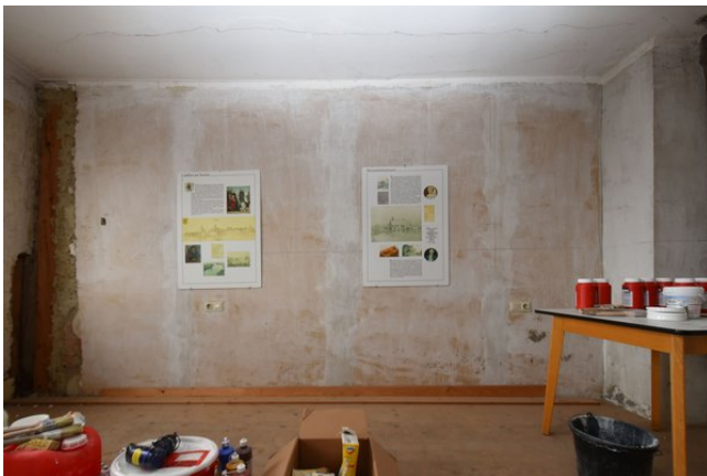
Frontalansicht Wand d, Raum 1.03, mit Blickrichtung Westen;
