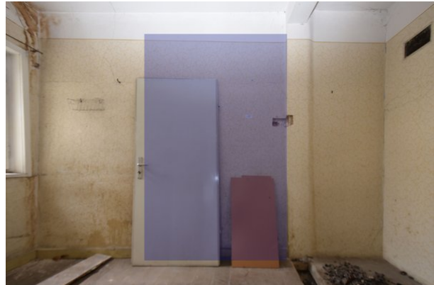
Frontalansicht Wand a, Raum 1.10, mit Blickrichtung Norden; Kartierung der zur Veränderung vorgesehenen Bereiche in blau;
