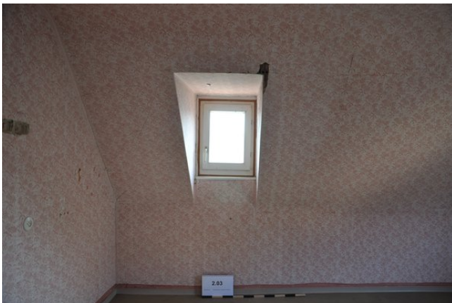
Raum 2.03c, Detailansicht des Fensters in Wand c mit Blickrichtung Süden (strebewerk. 13.08.2015)
