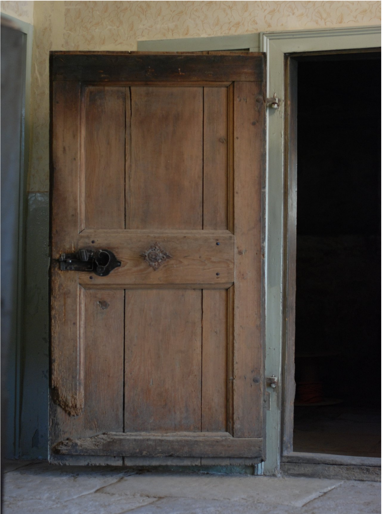
Ansicht der Innenseite des sanierten Türblatts der Zugangstür.
