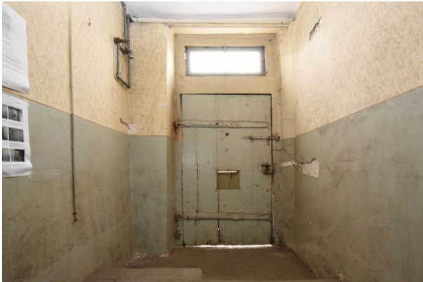
Frontalansicht Wand c, Raum 0.02, mit Blickrichtung Süden;
