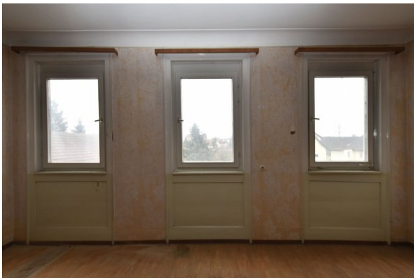
Frontalansicht Wand c, Raum 1.04, mit Blickrichtung Süden;
