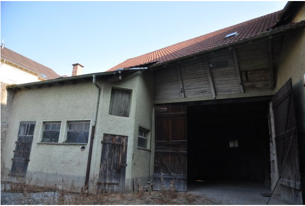
Ansicht Hoffassade Nord mit Scheunentor (streberwerk. 13.08.2015)
