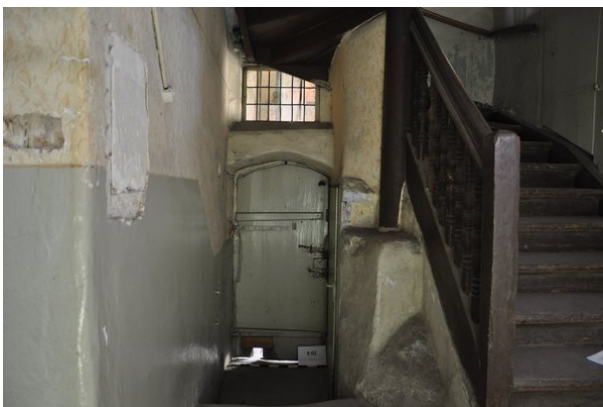
Raum 0.02d, Detailansicht der Tür zu Raum 0.01 mit Blickrichtung Westen (strebewerk. 13.08.2015)
