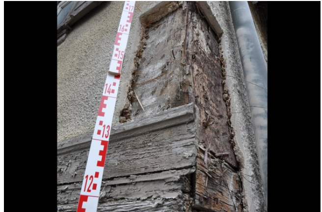
Ostfassade Öffnung 1 (Gebäudeecke) Abb.3:
