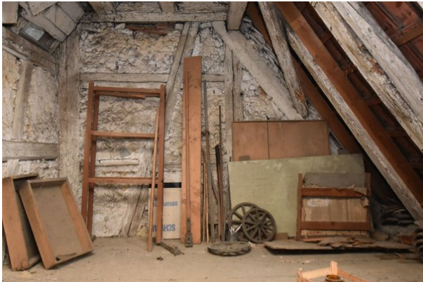
Frontalansicht Wand a, Raum 2.05, mit Blickrichtung Norden;
