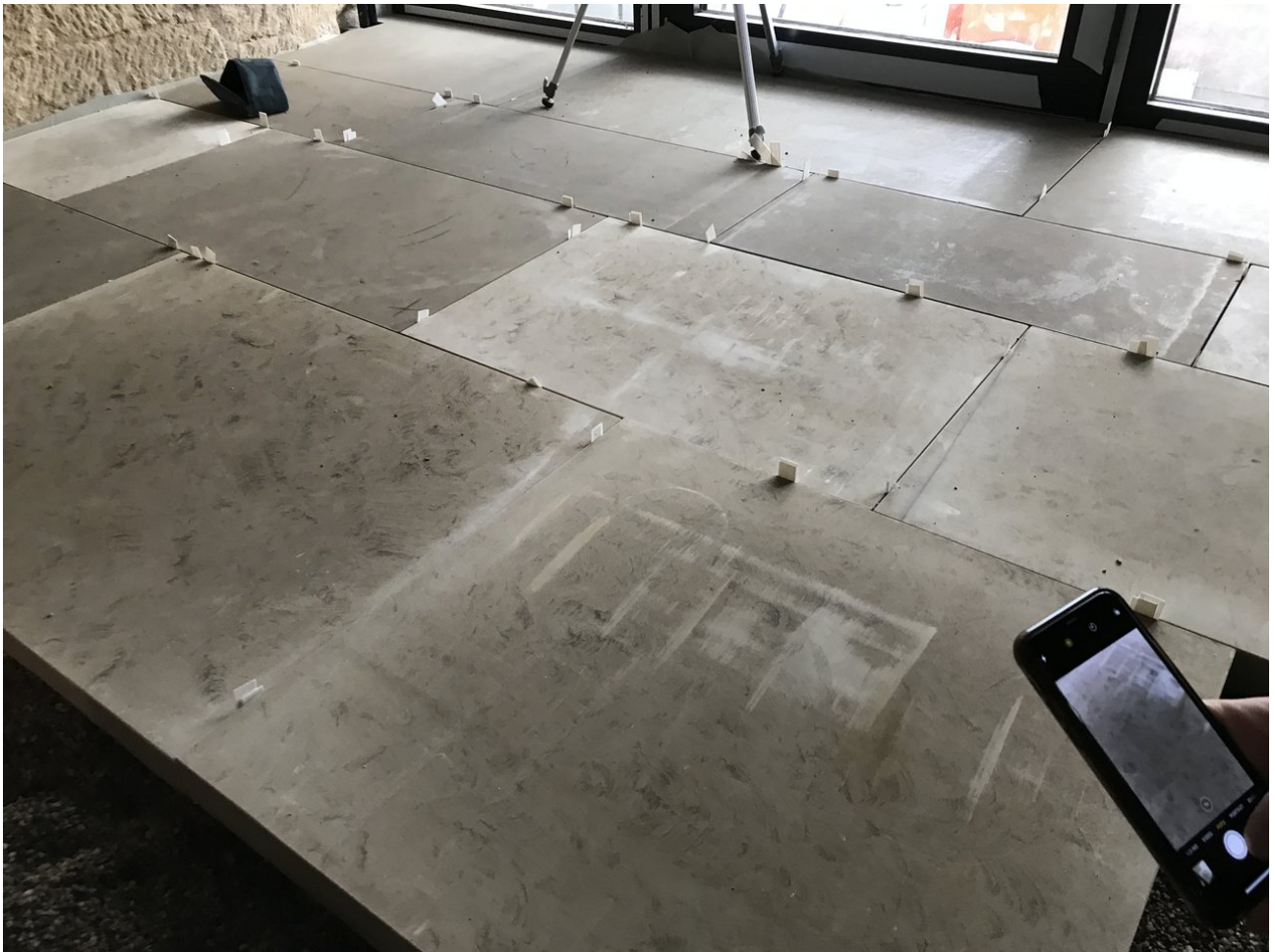
Neuer Sandsteinboden während des Einbaus
