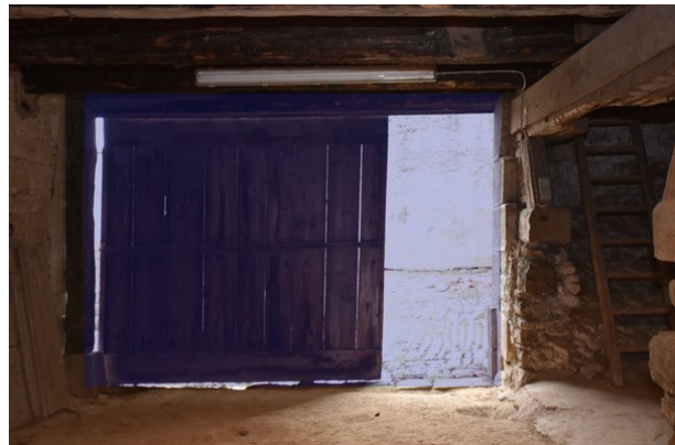
Frontalansicht Wand d, Raum 0.08, mit Blickrichtung Westen; Kartierung der zur Veränderung vorgesehenen Bereiche in blau;
