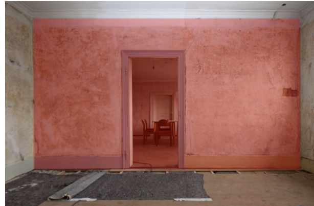
Frontalansicht Wand b, Raum 1.03, mit Blickrichtung Osten; Kartierung der besonders sensiblen Bereiche in rot;
