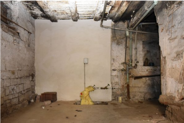
Frontalansicht Wand b, Raum 0.06, mit Blickrichtung Osten;
