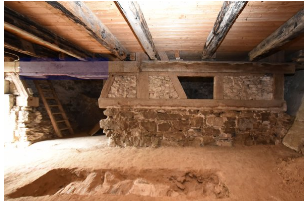
Frontalansicht Wand a, Raum 0.08, mit Blickrichtung Norden; Kartierung der zur Veränderung vorgesehenen Bereiche in blau;
