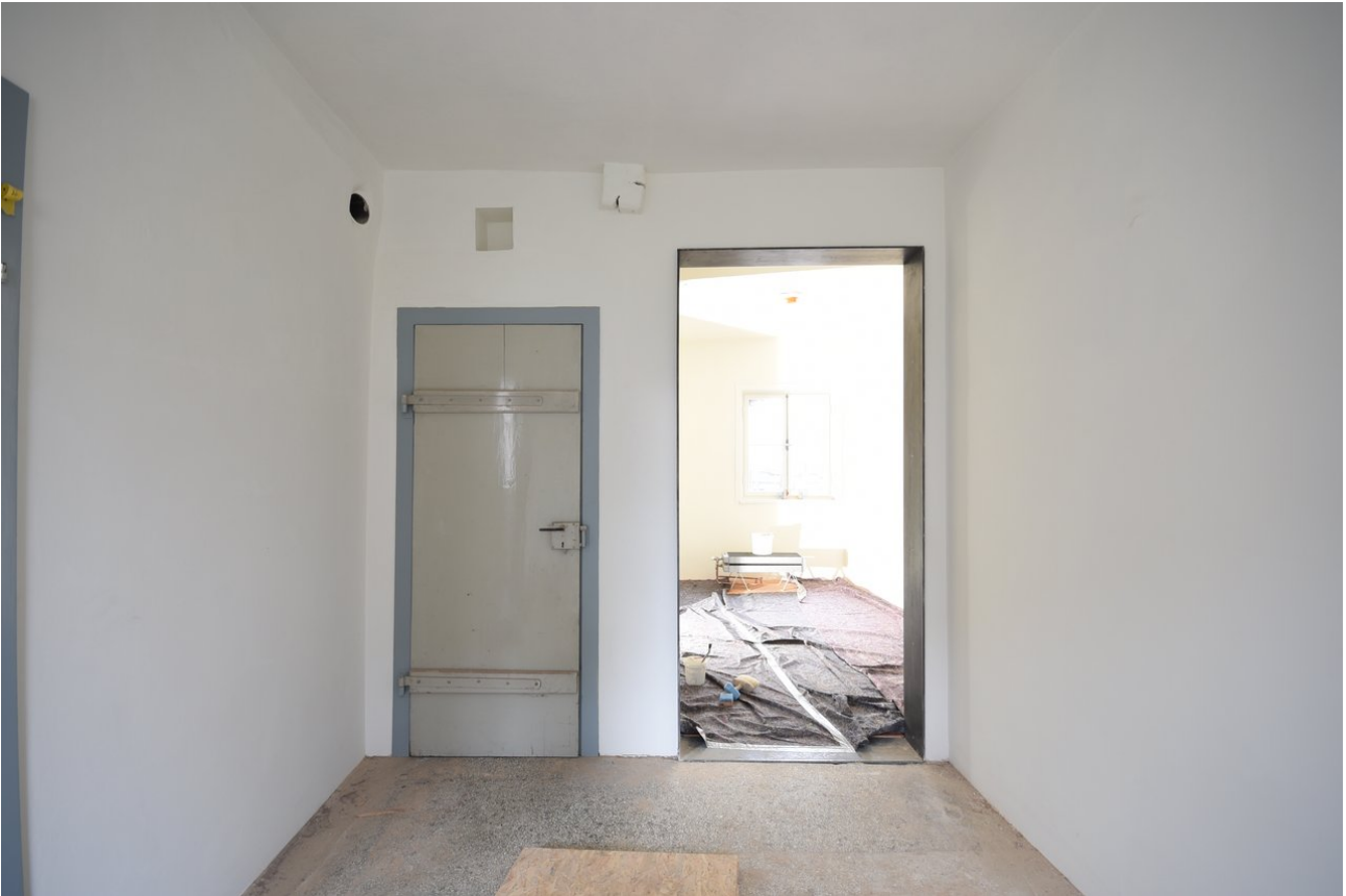
Ansicht sanierte Wand während der Bauarbeiten
