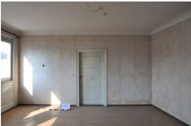
Raum 1.04d, Frontalansicht Wand d mit Blickrichtung Westen (streberwerk. 13.08.2015)
