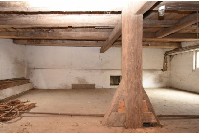
Frontalansicht Wand c, Raum 1.13, mit Blickrichtung Süden;
