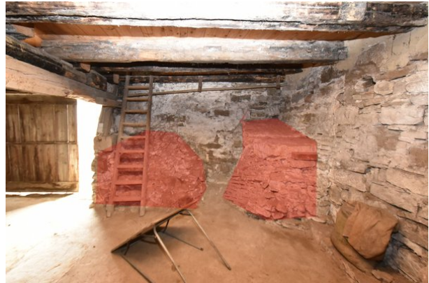
Frontalansicht Wand d, Raum 0.09, mit Blickrichtung Westen; Kartierung der besonders sensiblen Bereiche in rot;
