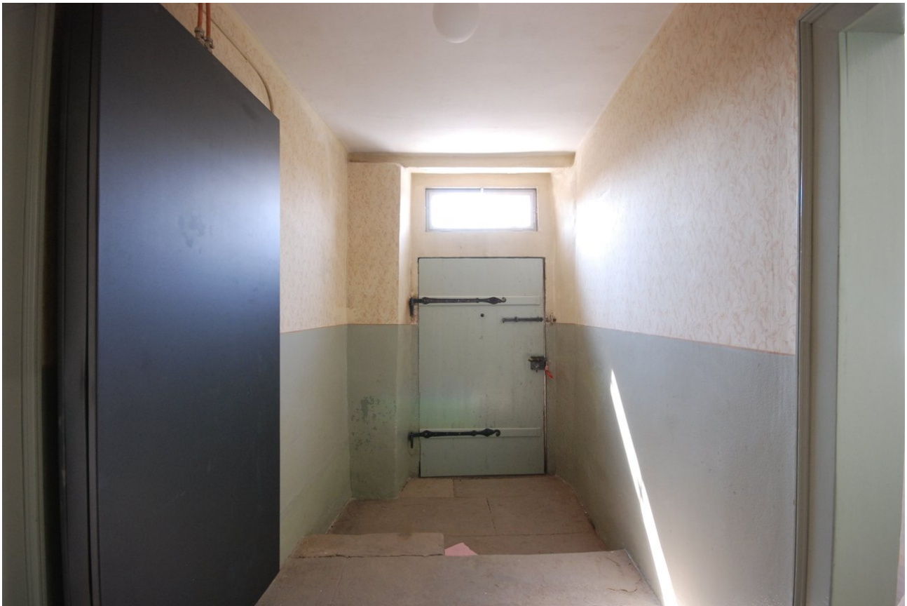
Ansicht der fertig sanierten Wand
