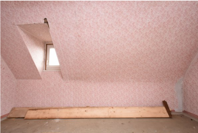
Frontalansicht Wand c, Raum 2.03, mit Blickrichtung Süden;
