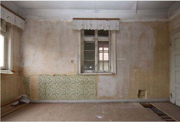
Frontalansicht Wand a, Raum 1.02, mit Blickrichtung Norden;
