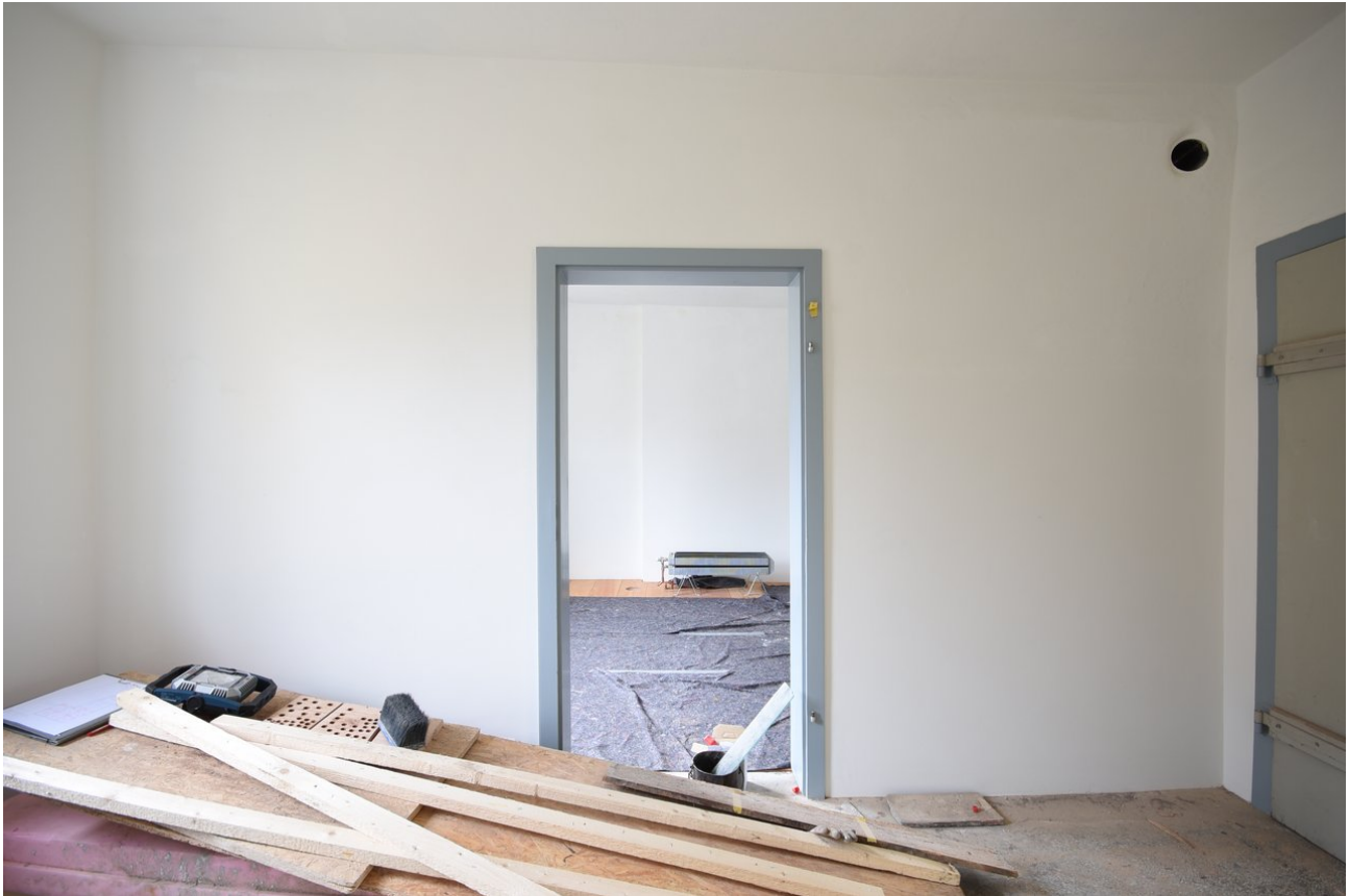
Ansicht fertig sanierte Wand
