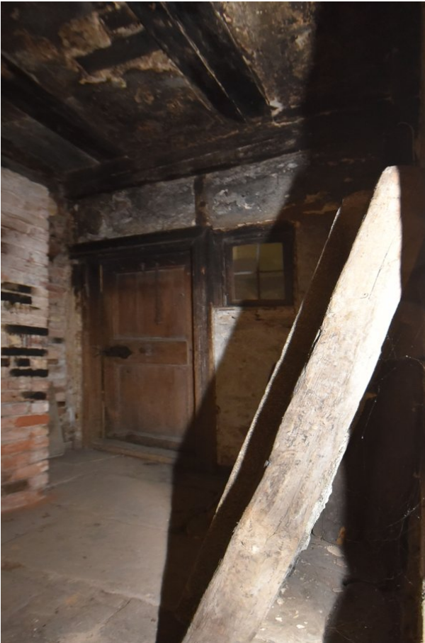
Frontalansicht Wand d, Raum 0.05, mit Blickrichtung Westen;
