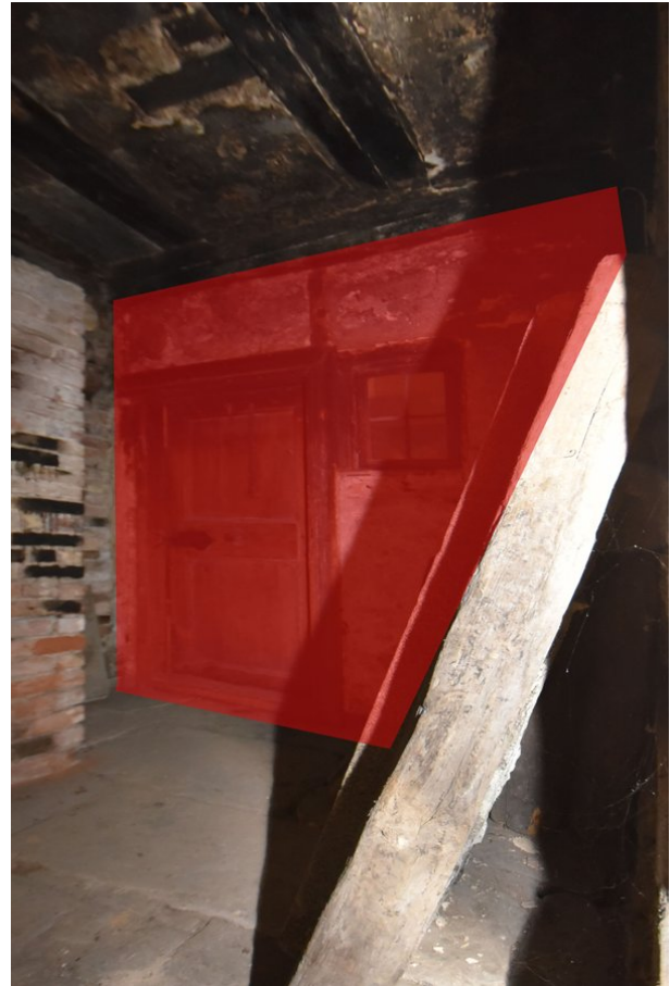
Frontalansicht Wand d, Raum 0.05, mit Blickrichtung Westen; Kartierung der im Original zu erhaltenden Bereiche in dunkelrot;
