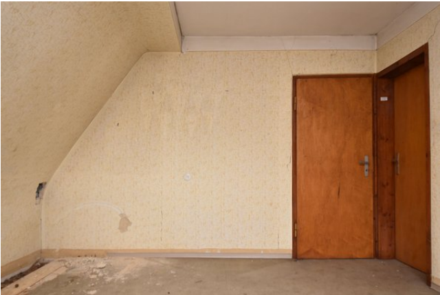
Frontalansicht Wand b, Raum 2.02, mit Blickrichtung Osten;
