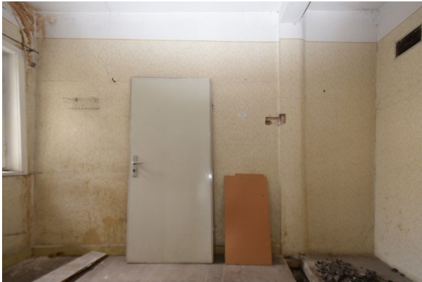
Frontalansicht Wand a, Raum 1.10, mit Blickrichtung Norden;
