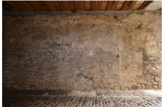
Frontalansicht Wand d, Raum 0.01, mit Blickrichtung Westen;
