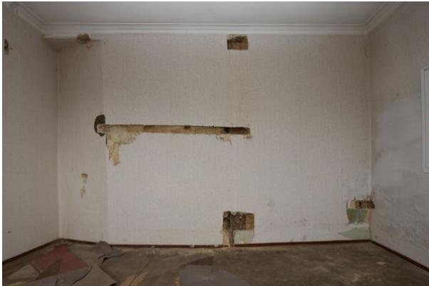
Frontalansicht Wand a, Raum 1.05, mit Blickrichtung Norden;
