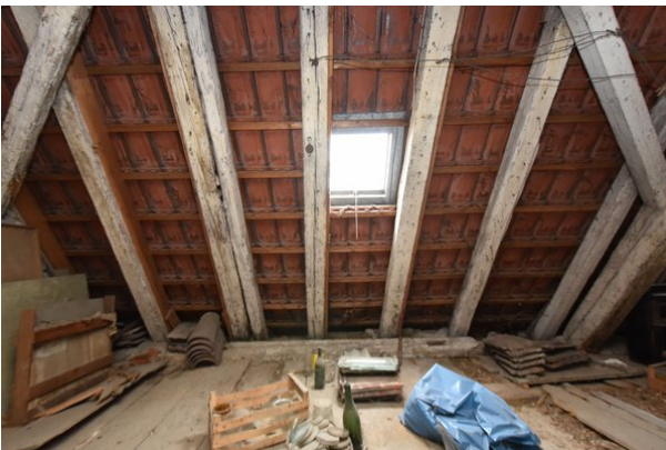
Frontalansicht Wand b (nördlicher Teil), Raum 2.05, mit Blickrichtung Osten;
