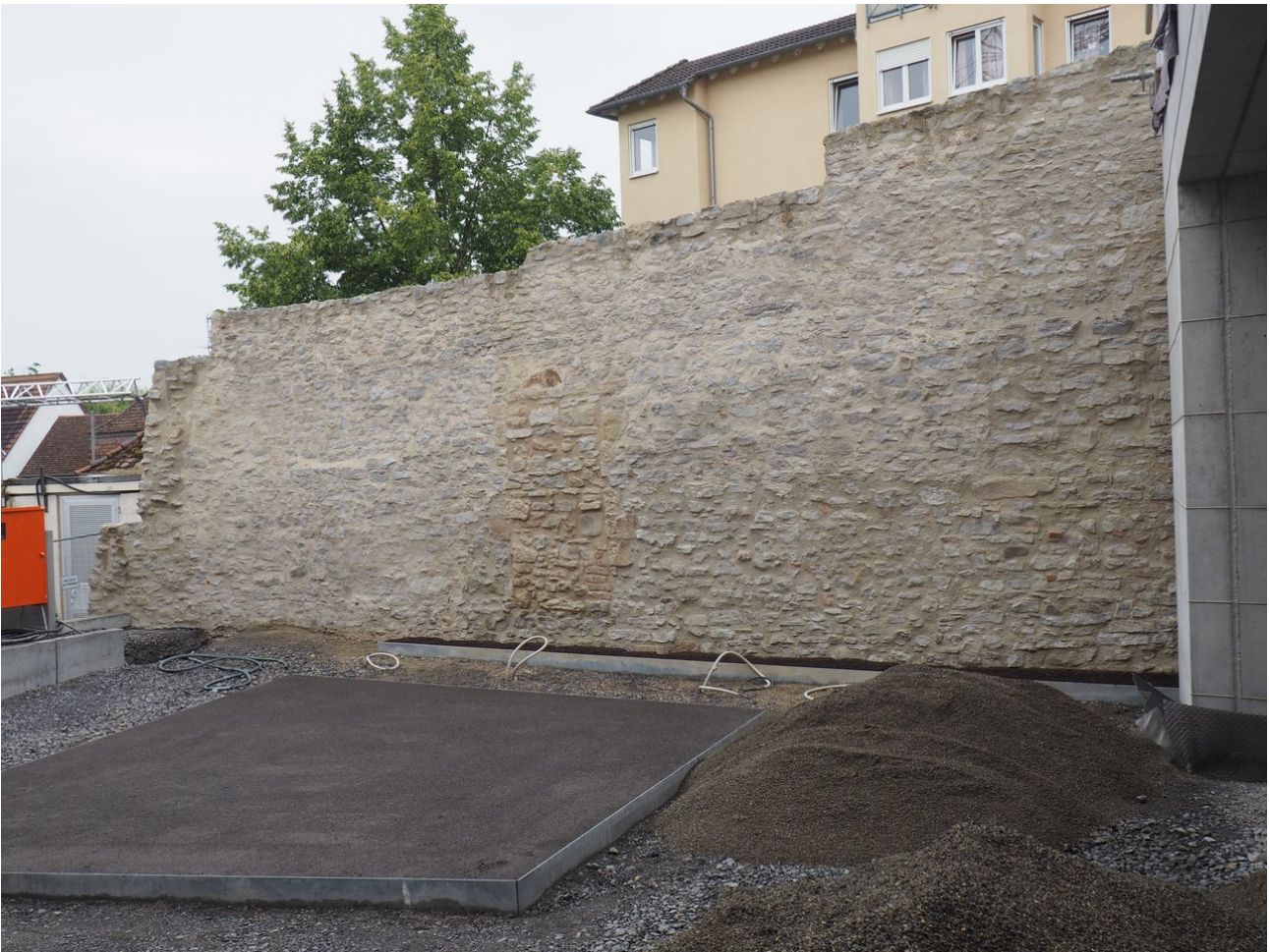
Klostermauer nach der Sanierung
