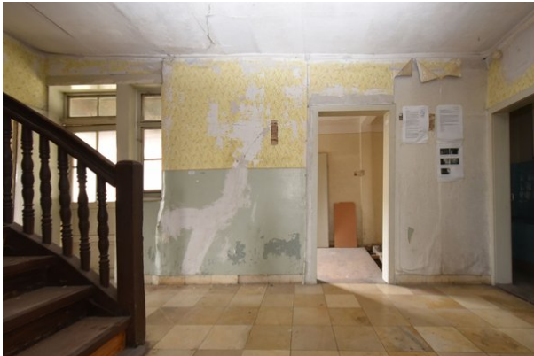
Frontalansicht Wand a, Raum 1.01, mit Blickrichtung Norden;
