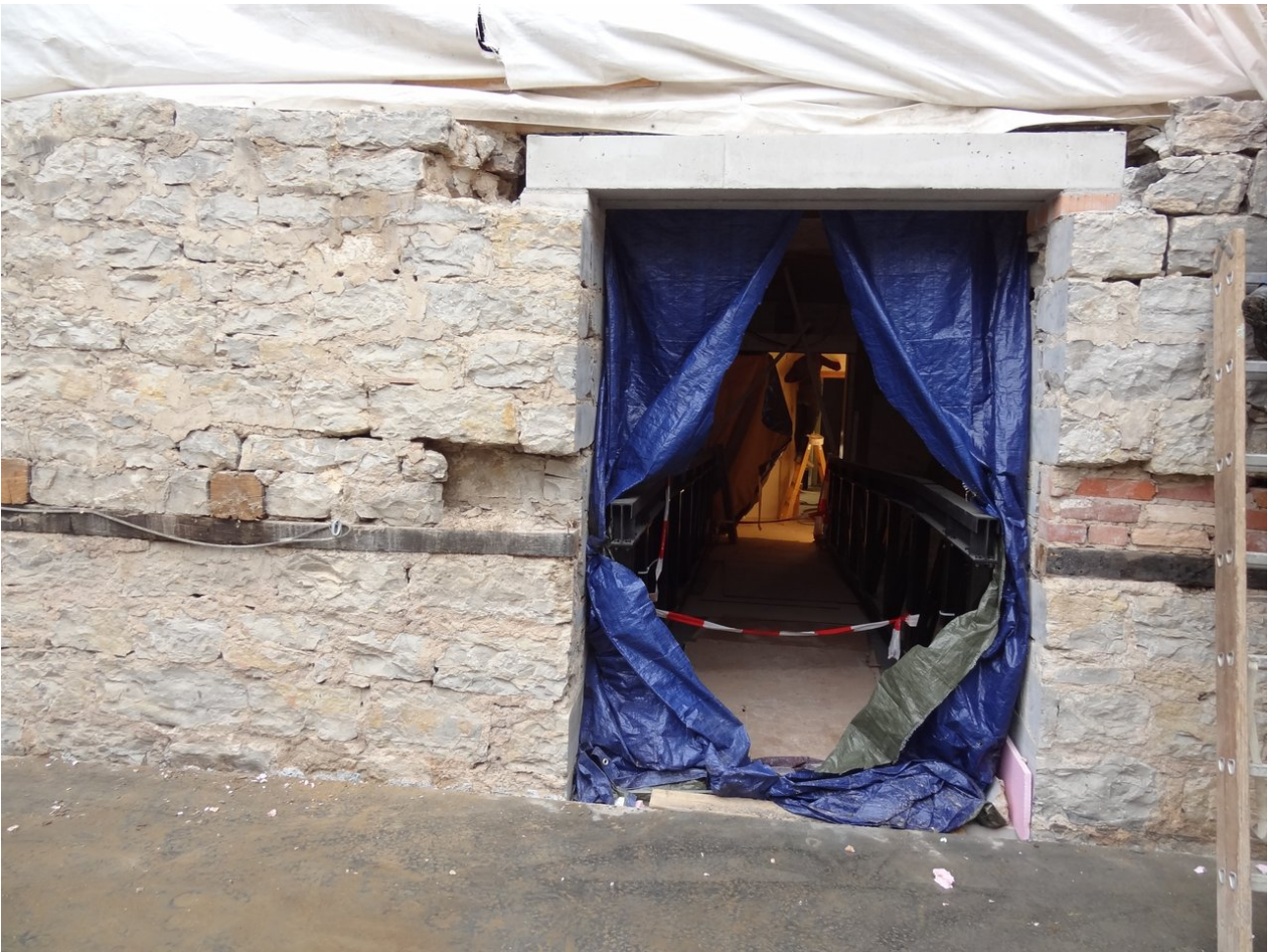
Durchbruch Giebelwand als Verbindung vom Neubau zur Scheune
