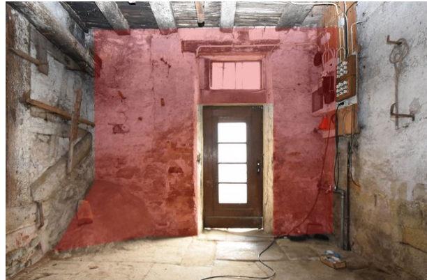
Frontalansicht Wand d, Raum 0.06, mit Blickrichtung Westen; Kartierung der besonders sensiblen Bereiche in rot;
