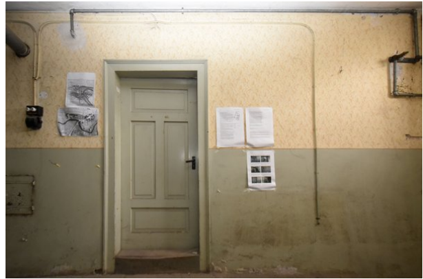
Frontalansicht Wand b (südlicher Teil), Raum 0.02, mit Blickrichtung Osten;
