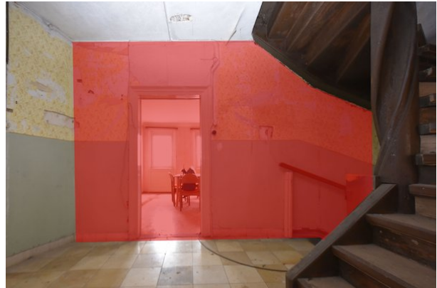
Frontalansicht Wand c, Raum 1.01, mit Blickrichtung Süden; Kartierung der im Original zu erhaltenden Bereiche in dunkelrot;
