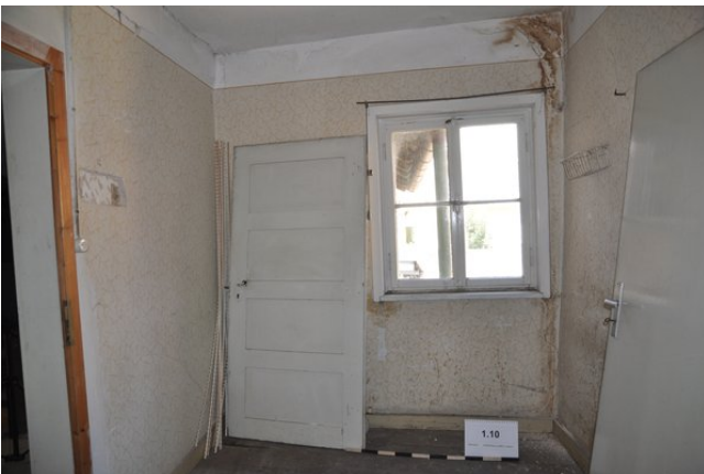
Raum 1.10d, Frontalansicht Wand d mit Blickrichtung Westen (streberwerk. 13.08.2015)
