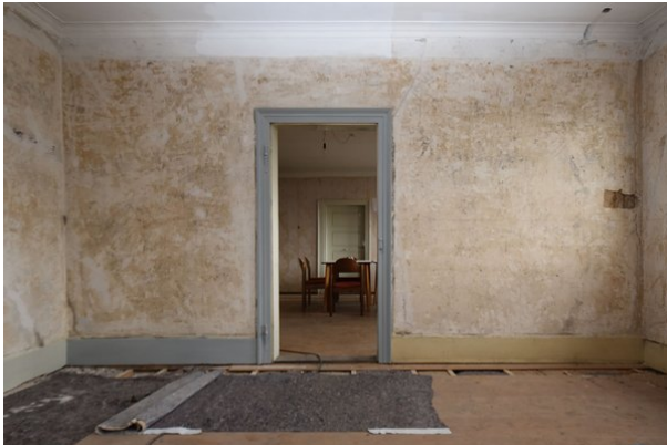
Frontalansicht Wand b, Raum 1.03, mit Blickrichtung Osten;
