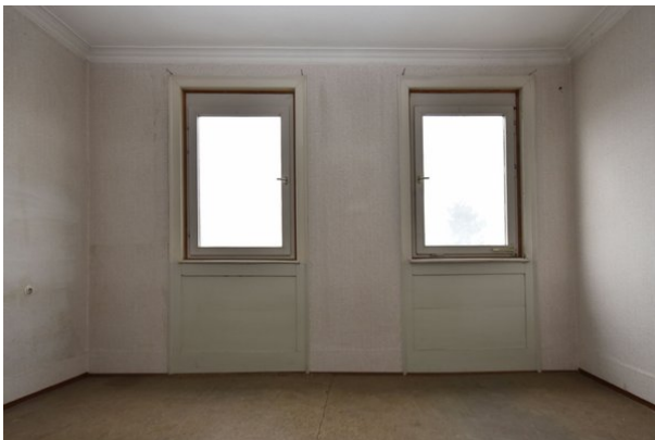
Frontalansicht Wand c, Raum 1.05, mit Blickrichtung Süden;
