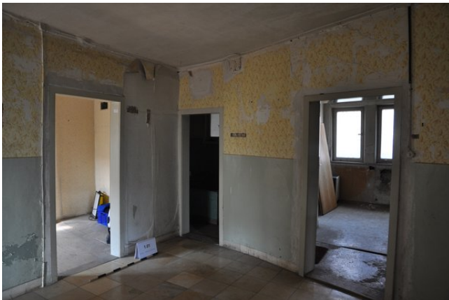
Raum 1.01ab, Diagonalaufnahme mit Blickrichtung Nordosten (strebewerk. 13.08.2015)
