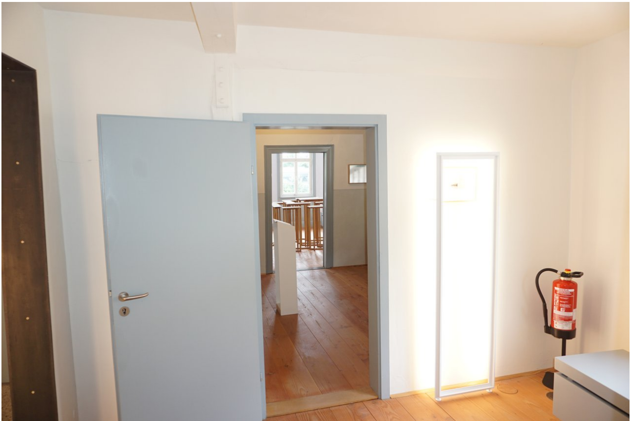
Ansicht fertig sanierte Wand
