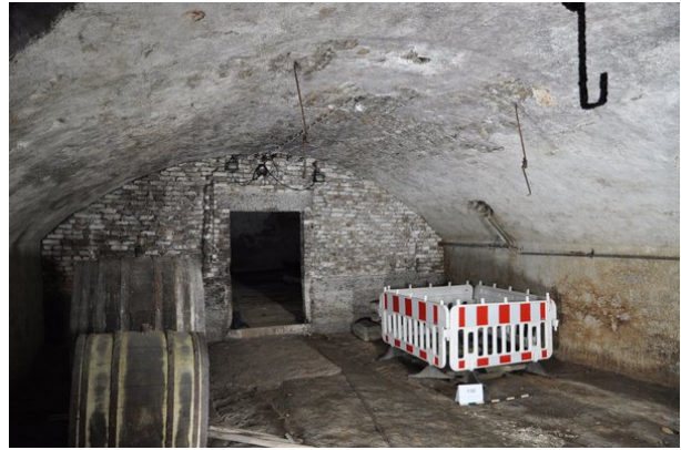
Kellerraum R102cd (strebewerk. 13.08.2015)
