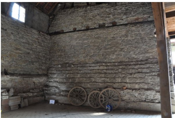
Raum 0.10bc, Diagonalaufnahme mit Blickrichtung Südosten (streberwerk. 13.08.2015)
