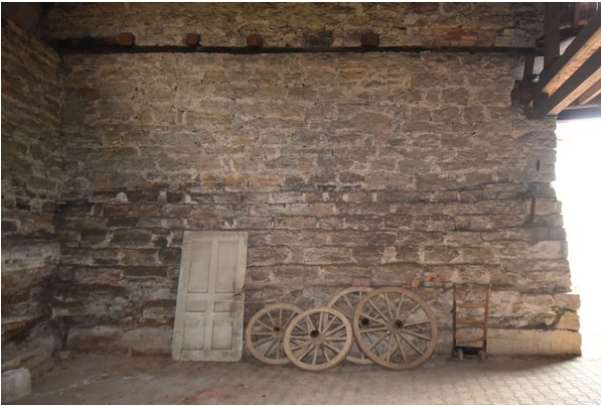
Frontalansicht der Außenseite von Wand a, Raum 0.09, mit Blickrichtung Süden;
