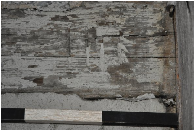
Raum 2.01b, Detailansicht der Abbundzeichen an Wand b mit Blickrichtung Osten (streberwerk. 13.08.2015)
