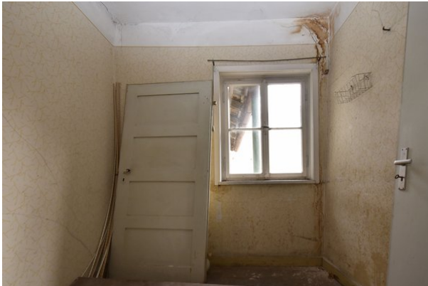
Frontalansicht Wand d, Raum 1.10, mit Blickrichtung Osten;
