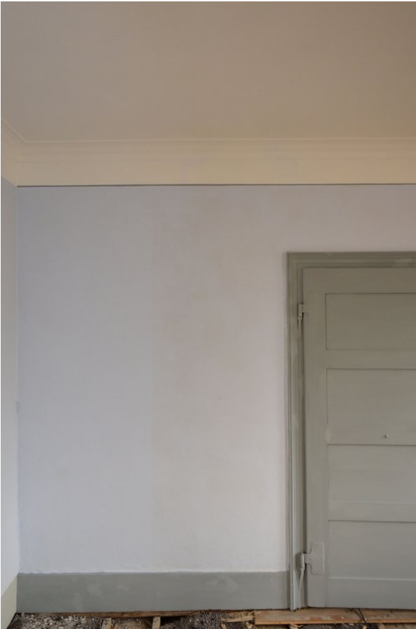
Detailansicht Wand b, Raum 1.03, mit Blickrichtung Osten; Wand mit Bemusterungsflächen (blaugrau)
