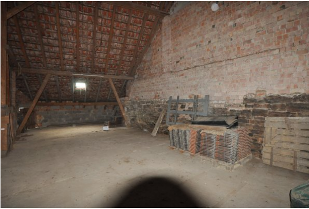
Stalleinbau, Wände cd (strebewerk. 05.10.2015)
