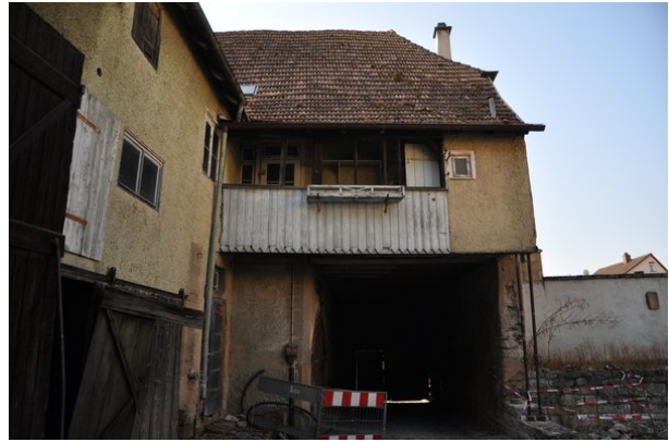
Ansicht Hoffassade Süd mit Einfahrt (strebewerk. 13.08.2015)
