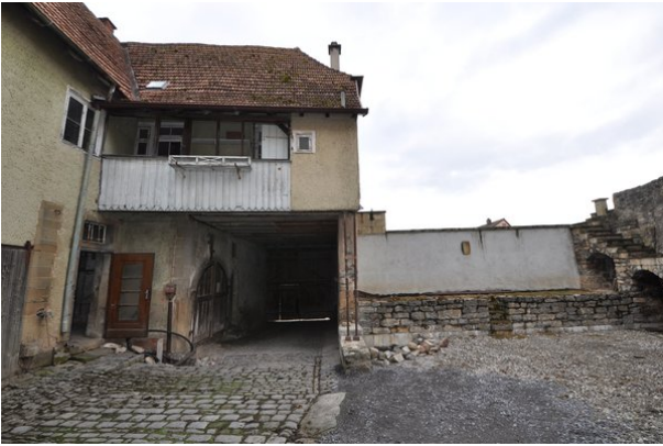
Ansicht Hoffassade Süd mit Einfahrt (strebewerk. 05.10.2015)
