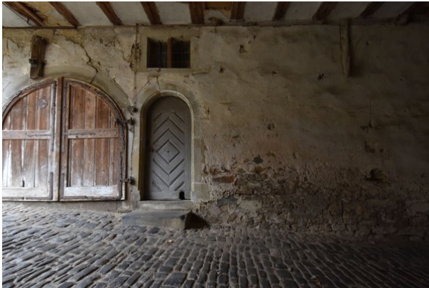
Frontalansicht Wand b, Raum 0.01, mit Blickrichtung Osten
