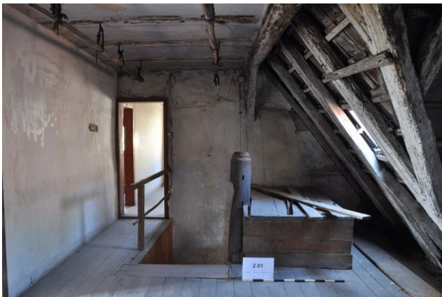
Raum 2.01d, Frontalansicht Wand d und Treppenöffnung mit Blickrichtung Westen (streberwerk. 13.08.2015)
