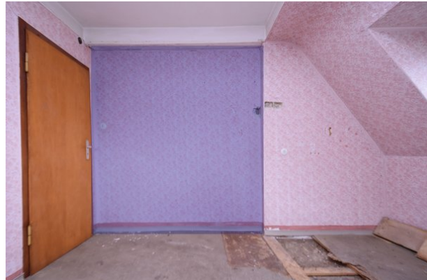
Frontalansicht Wand b, Raum 2.03, mit Blickrichtung Osten; Kartierung der zur Veränderung vorgesehenen Bereiche in blau;
