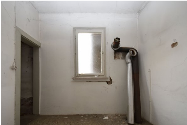
Frontalansicht Wand b, Raum 1.07, mit Blickrichtung Osten;
