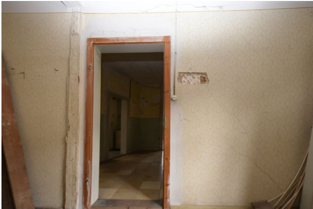
Frontalansicht Wand c, Raum 1.10, mit Blickrichtung Süden;
