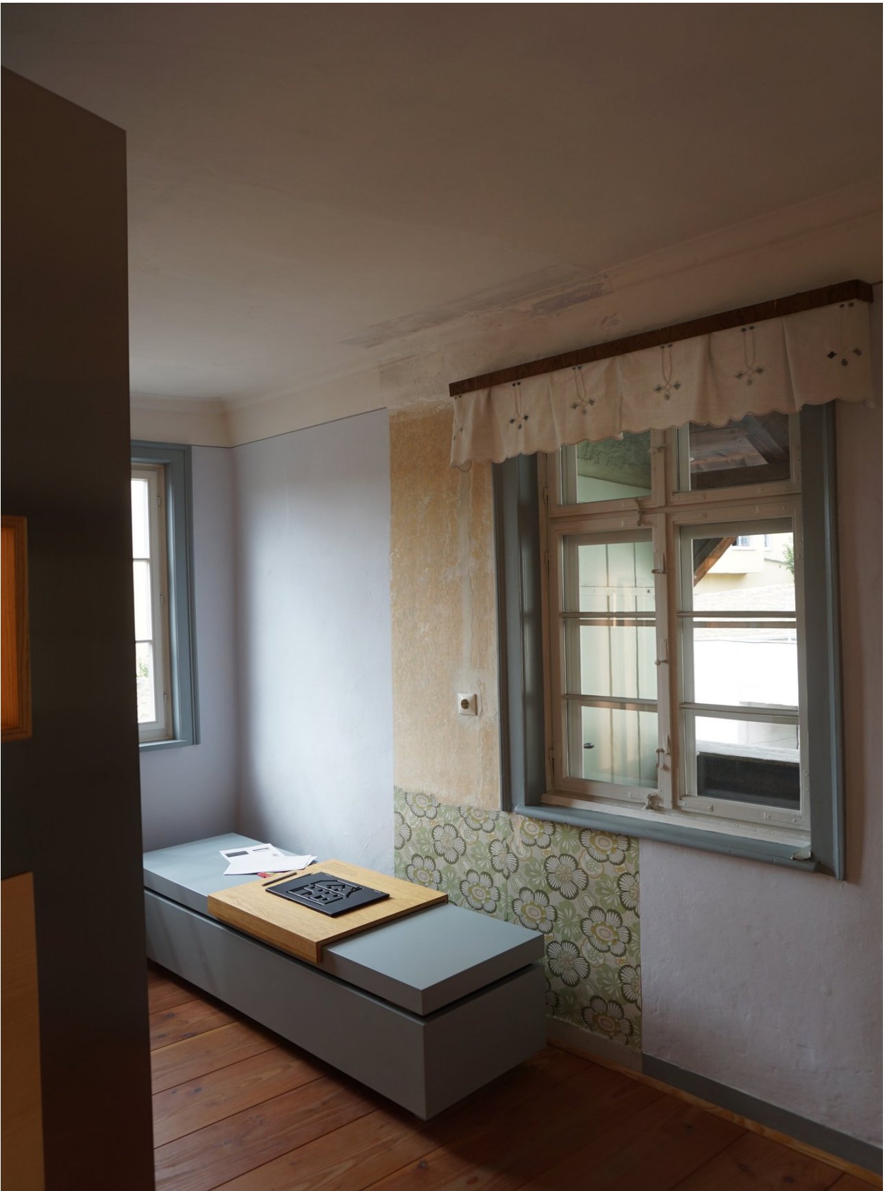
Ansicht der fertig sanierten Wand mit Einhausung Heizkörper.
