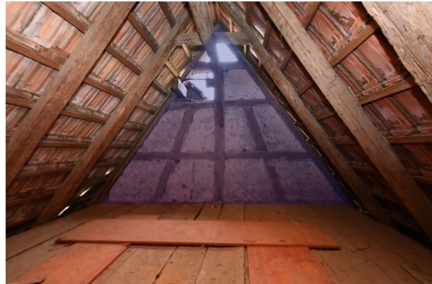
Frontalansicht Wand a, Raum 3.02, mit Blickrichtung Norden;
