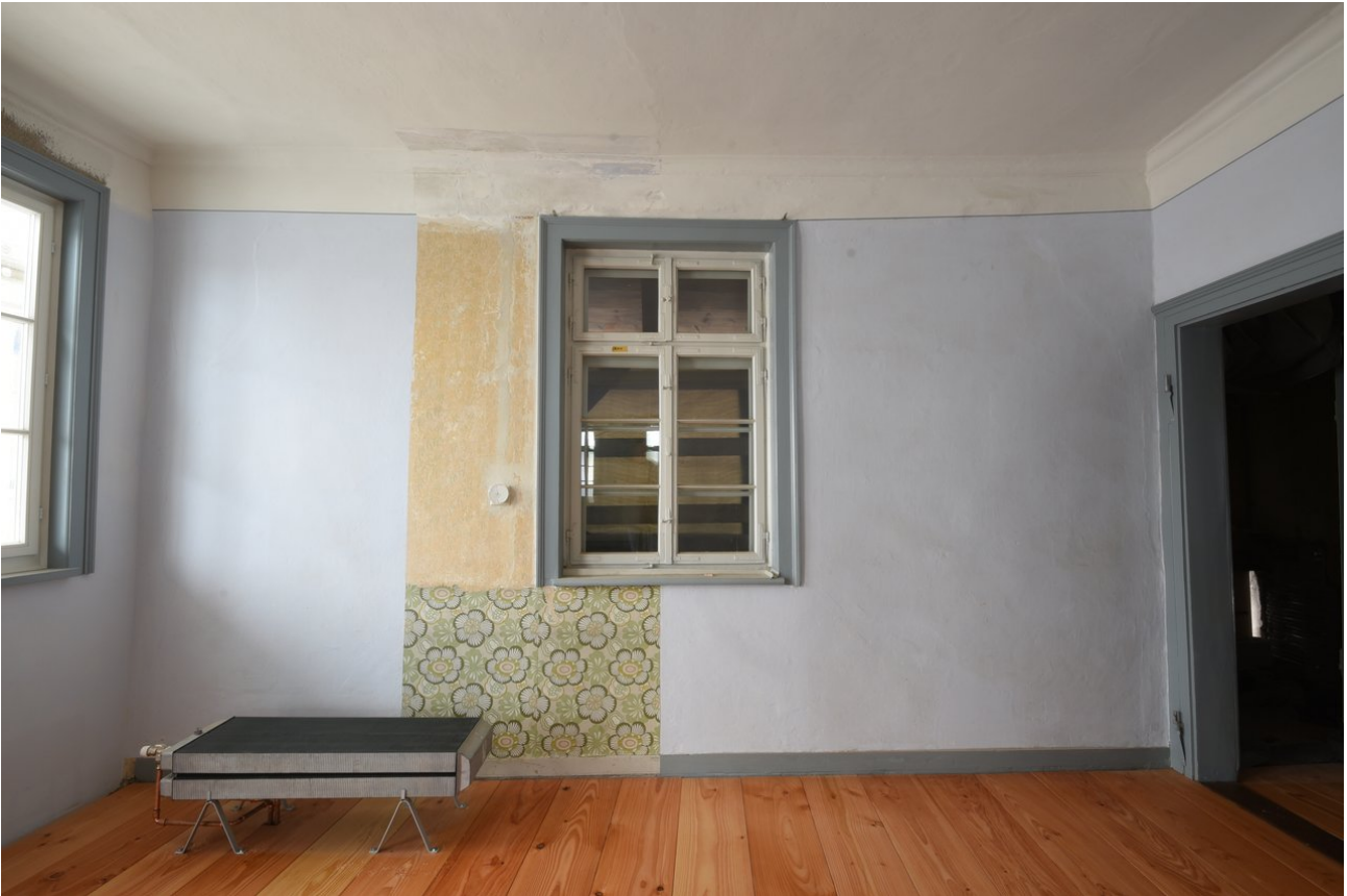
Ansicht während der Sanierung.
