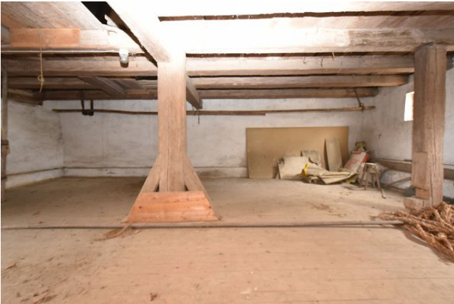
Frontalansicht Wand a, Raum 1.13, mit Blickrichtung Norden;
