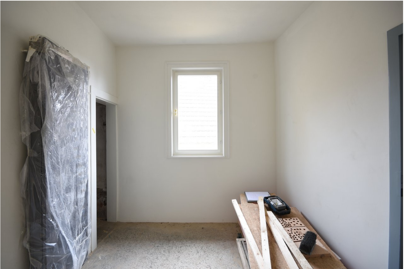
Ansicht fertig sanierte Wand
