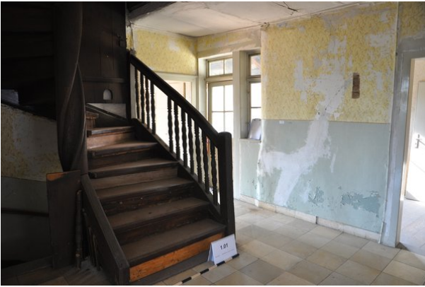
Raum 1.01da, Diagonalaufnahme mit Blickrichtung Nordwesten (strebewerk. 13.08.2015)
