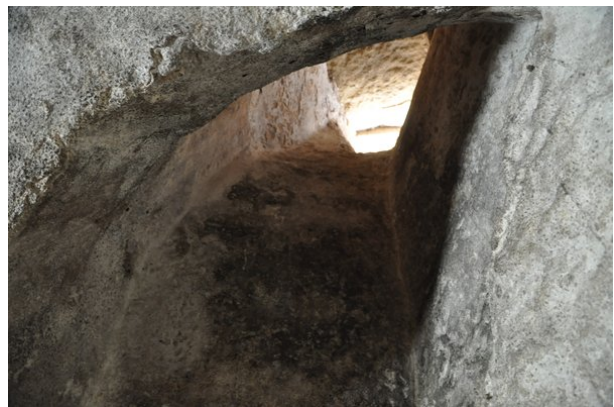
Raum -1.02d, Detailansicht des südlichen Lichtschachts an Wand d mit Blickrichtung Westen (streberwerk. 13.08.2015)
