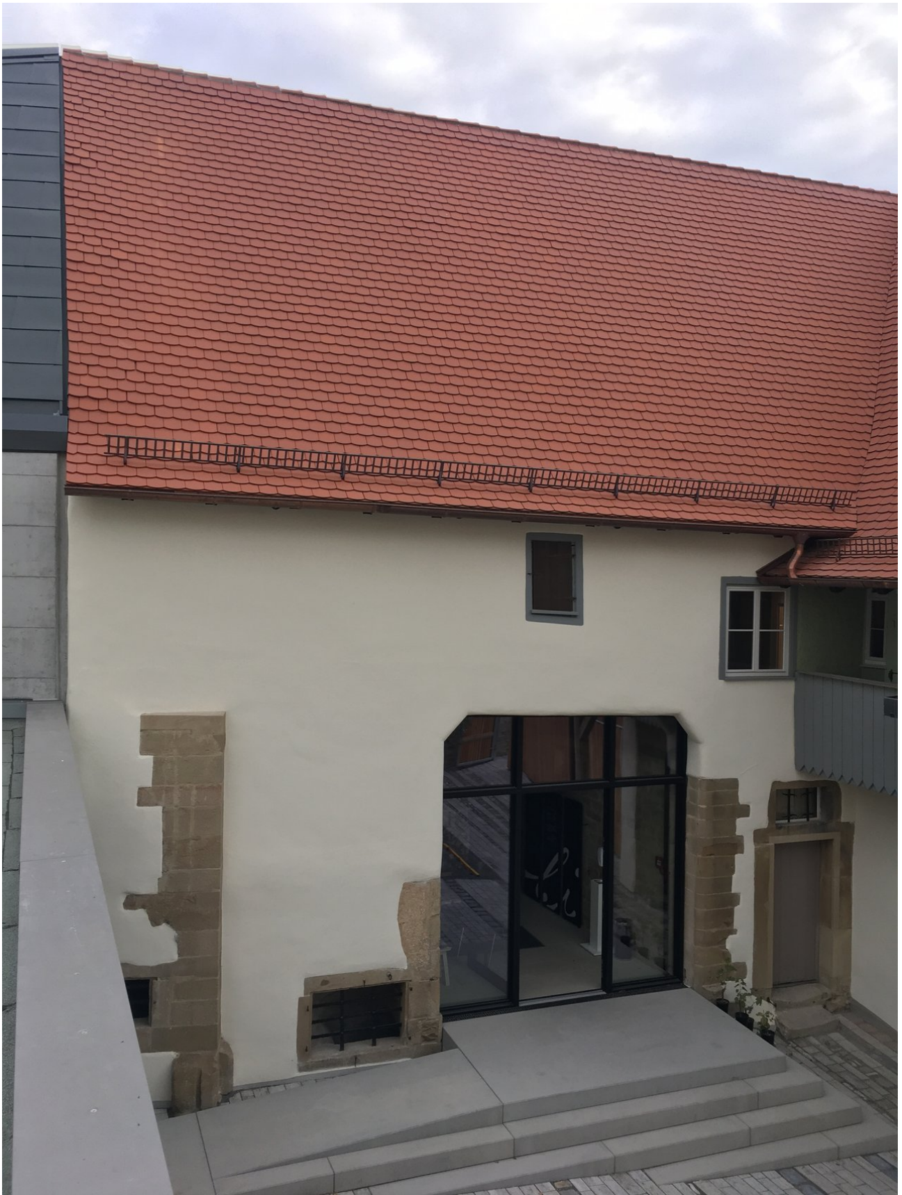
Ansicht sanierte Fassade ehem. Scheunenbereich
