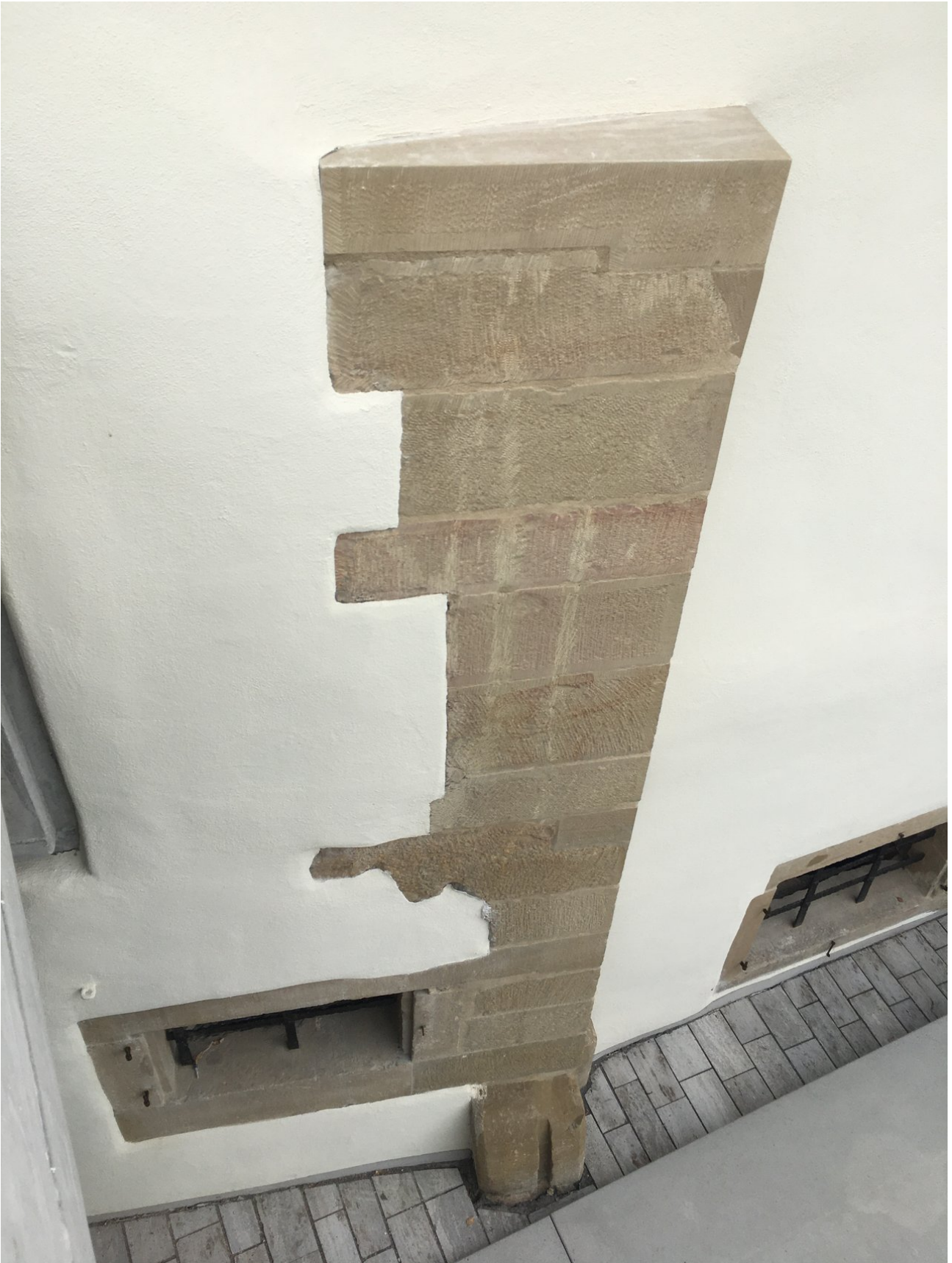
Ansicht Stoß Werksteinecke / Putzfläche
