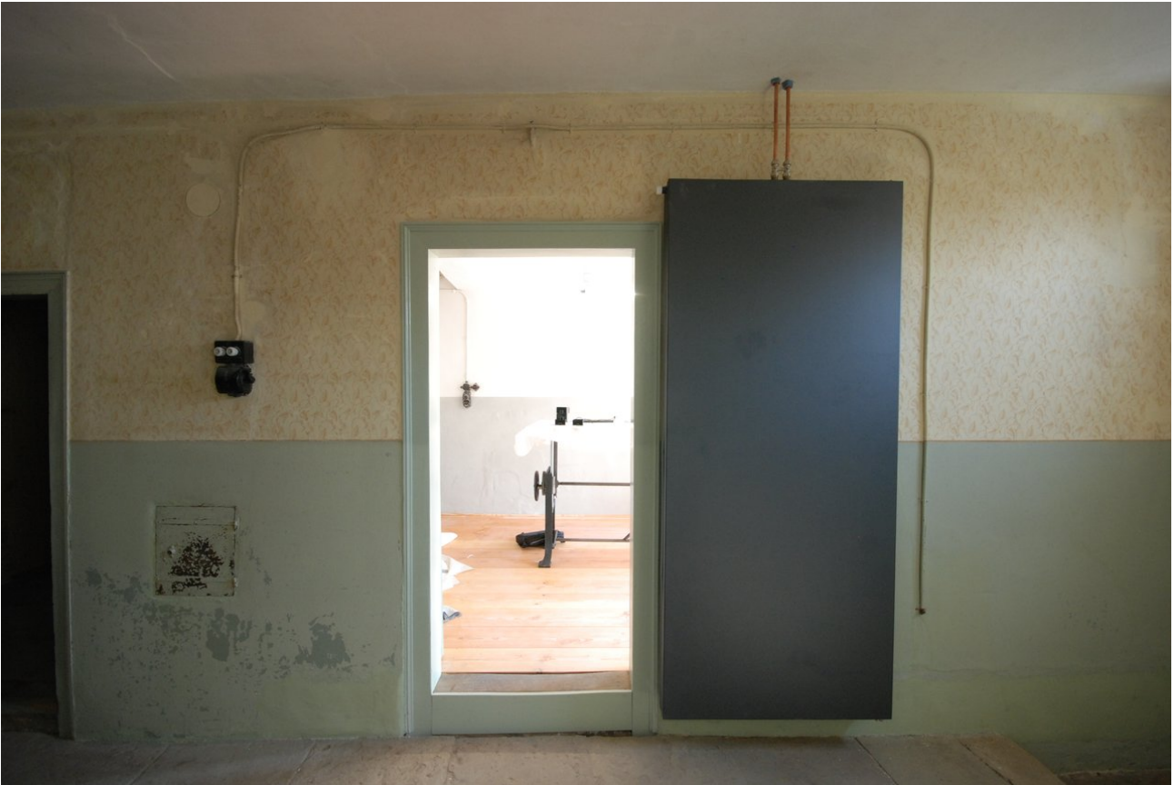
Ansicht der fertig sanierten südlichen Hälfte
