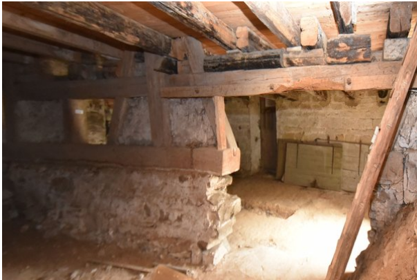
Frontalansicht Wand c, Raum 0.09, mit Blickrichtung Süden;
