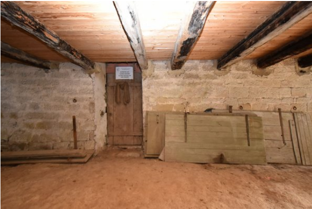
Frontalansicht Wand c, Raum 0.08, mit Blickrichtung Süden;
