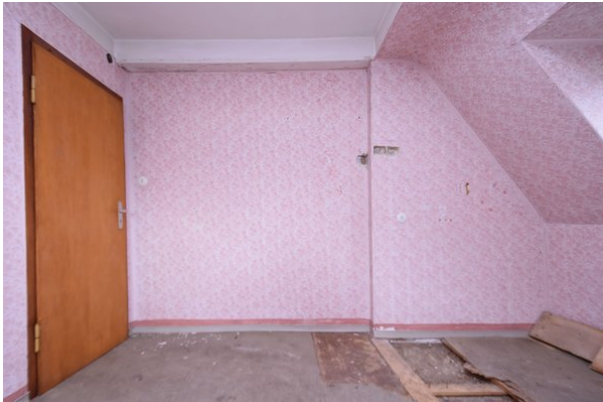
Frontalansicht Wand b, Raum 2.03, mit Blickrichtung Osten;
