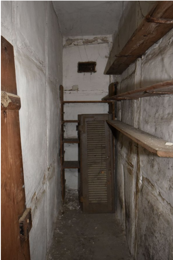
Frontalansicht Wand d, Raum 1.09, mit Blickrichtung Westen;
