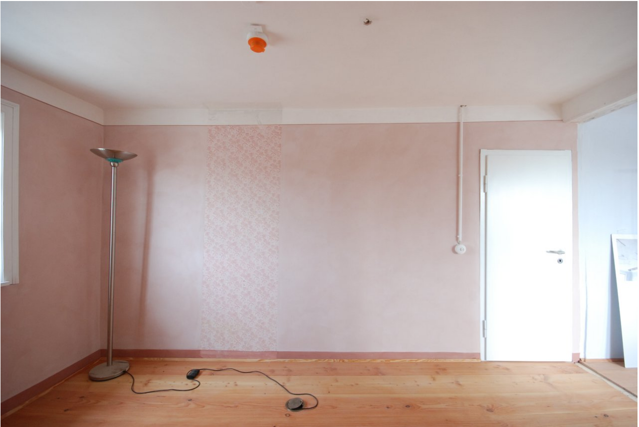
Ansicht fertig sanierte Wand während der Bauarbeiten
