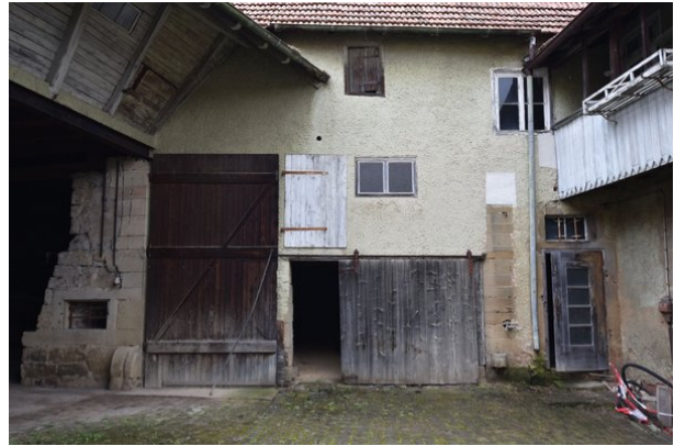
Frontalansicht der Außenseite von Wand d, Raum 2.06, mit Blickrichtung Osten;
