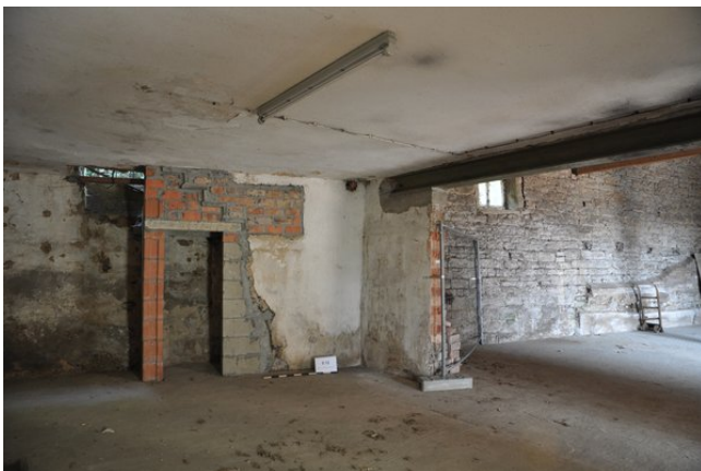
Raum 0.12ab, Diagonalaufnahme mit Blickrichtung Nordosten (streberk. 12.08.2015)
