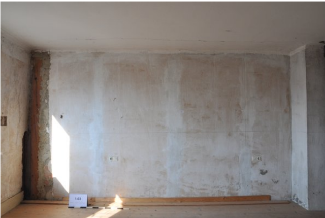
Raum 1.03d, Frontalansicht Wand d mit Blickrichtung Westen (streberwerk. 13.08.2015)
