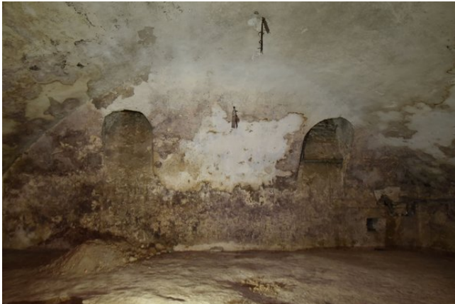
Frontalansicht Wand c, Raum -1.01, mit Blickrichtung Süden;
