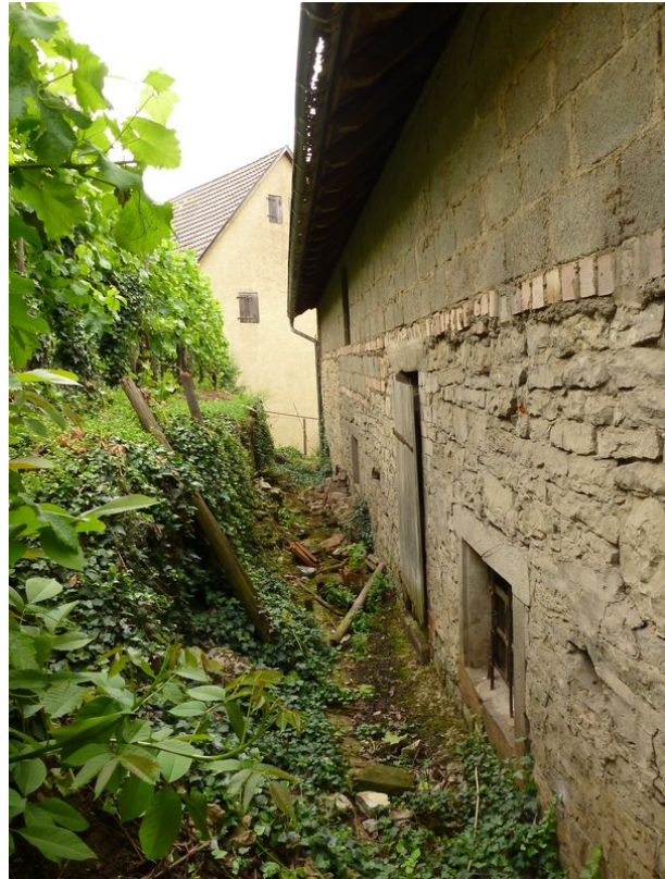
Ansicht Nordfassade: Scheunenwand aus Bruchsteinmauerwerk mit modernem Aufsatz (strebewerk. 13.08.2015)
