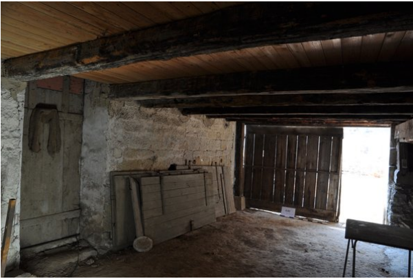
Wände cd (streberwerk. 13.08.2015)
