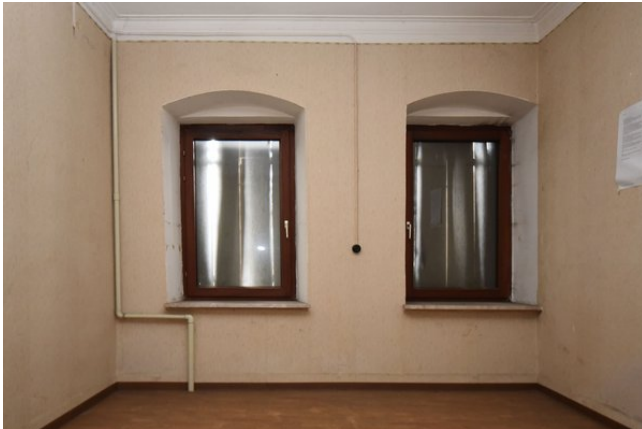
Frontalansicht Wand c, Raum 0.03, mit Blickrichtung Süden;
