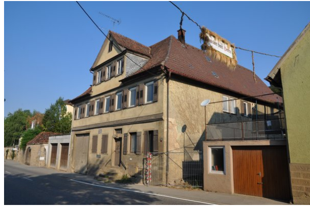
Straßenansicht der Südfassade mit moderner Garage von Osten kommend (strebewerk. 13.08.2015)
