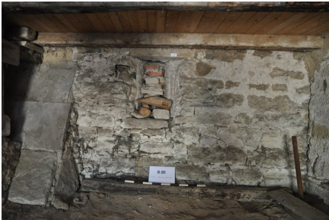
Raum 0.08b, Frontalansicht Wand b mit Blickrichtung Osten (strebewerk. 13.08.2015)
