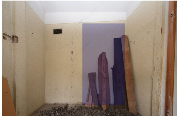
Frontalansicht Wand b, Raum 1.10, mit Blickrichtung Osten; Kartierung der zur Veränderung vorgesehenen Bereiche in blau;
