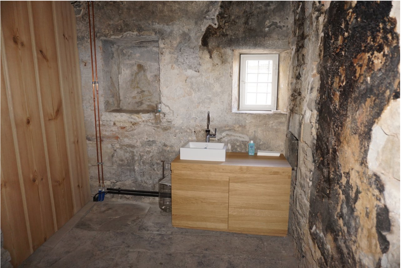
Ansicht nach Einbau Waschtisch
