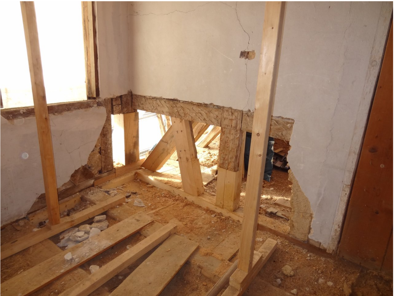
Deckenbalken und Fachwerkhölzer der Gaube nach der Sanierung
