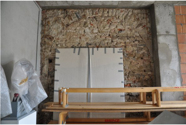
Wand b (streberwerk. 05.10.2015)
