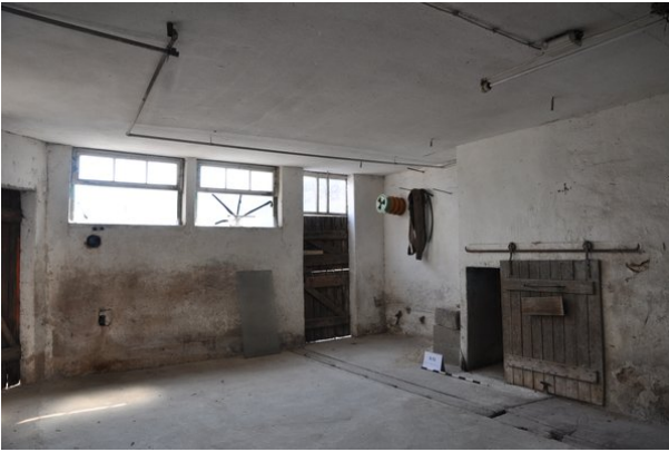
Wände cd (streberwerk. 13.08.2015)
