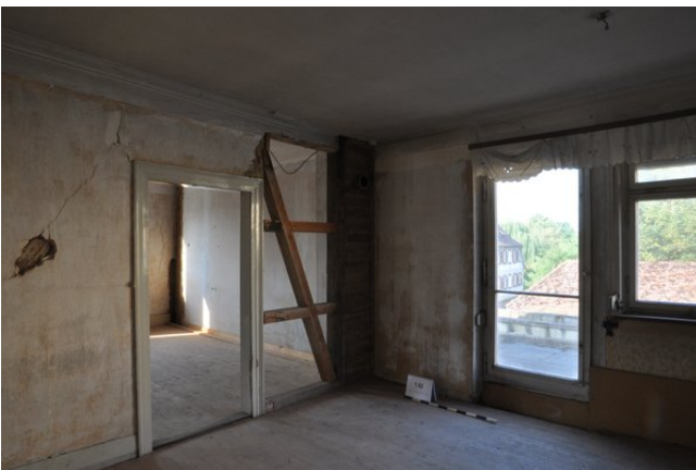
Wände cd (streberwerk. 13.08.2015)
