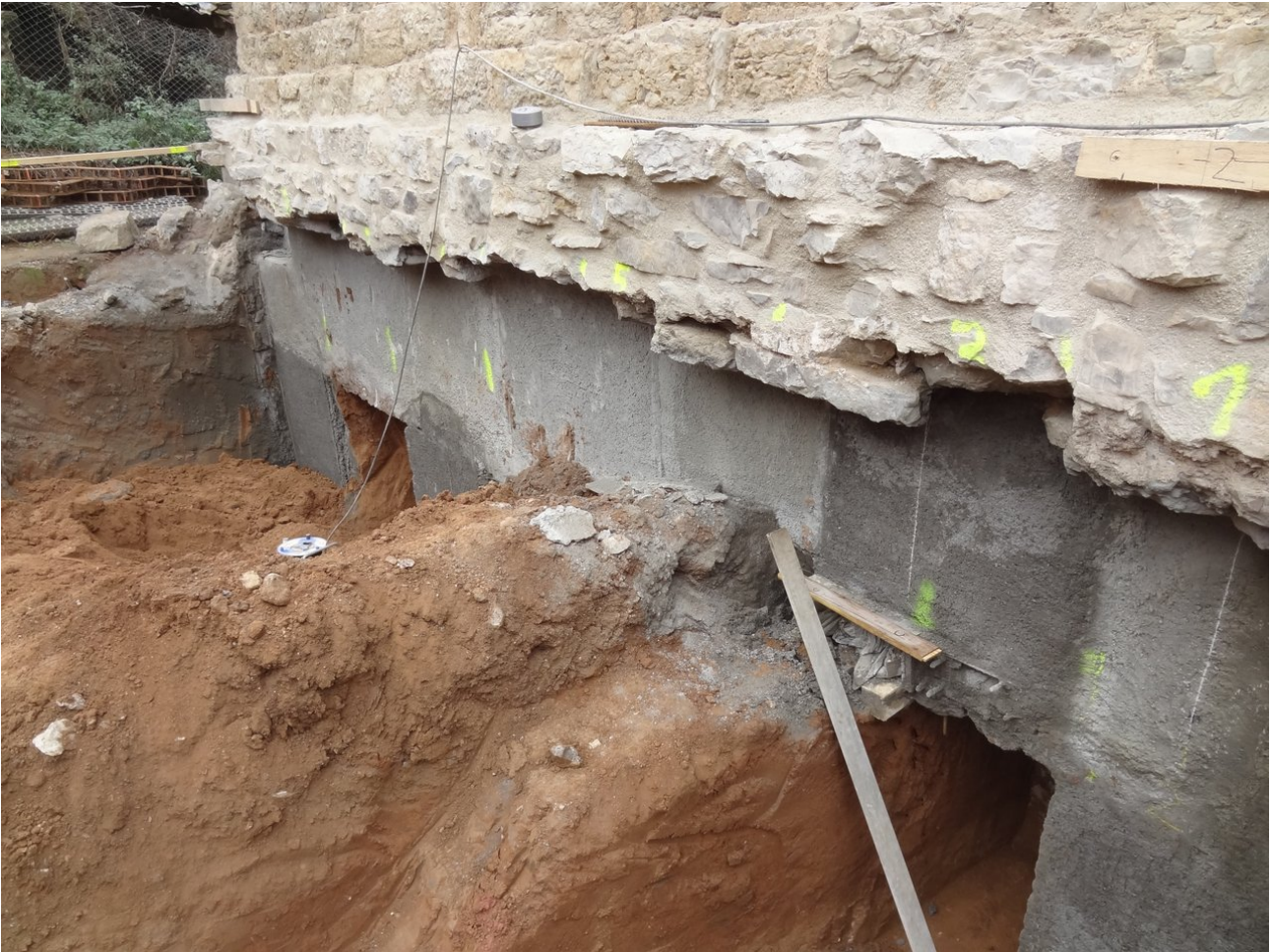
Abschnittsweise Unterfangung der Giebelwand
