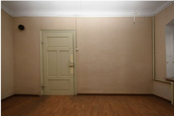
Frontalansicht Wand b, Raum 0.03, mit Blickrichtung Osten;
