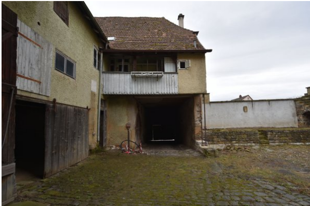
Frontalansicht der Außenseite von Wand a, Raum 1.02, mit Blickrichtung Süden;
