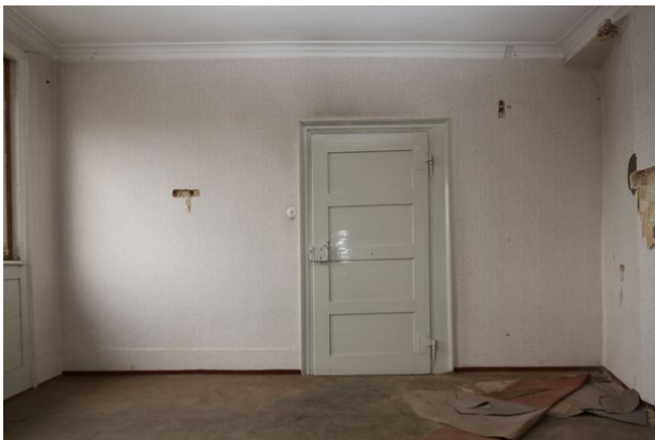
Frontalansicht Wand d, Raum 1.05, mit Blickrichtung Westen;
