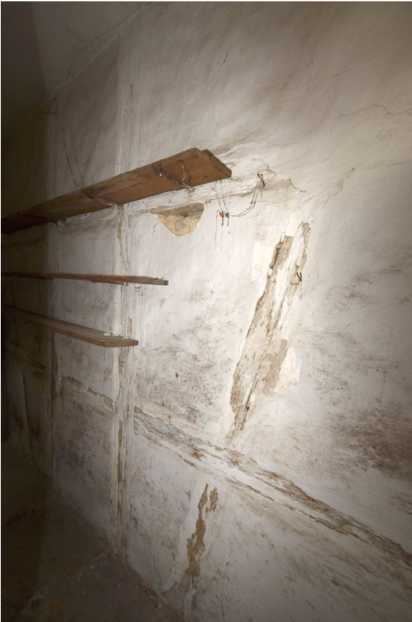
Frontalansicht Wand a, Raum 1.09, mit Blickrichtung Norden;
