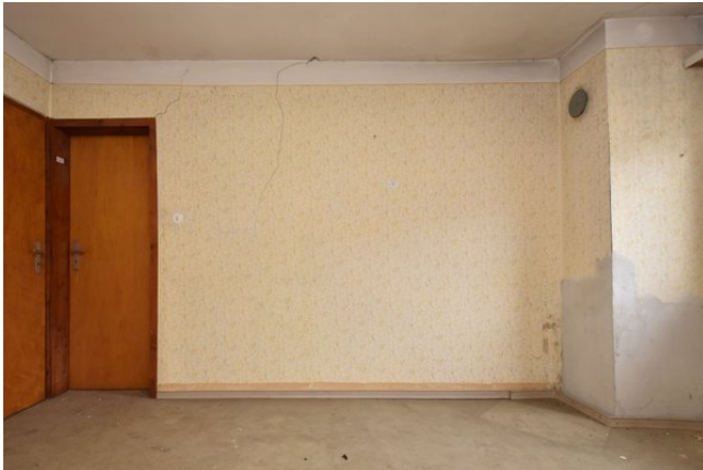
Frontalansicht Wand c, Raum 2.02, mit Blickrichtung Süden;
