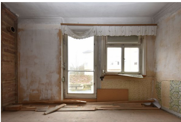
Frontalansicht Wand d, Raum 1.02, mit Blickrichtung Westen;
