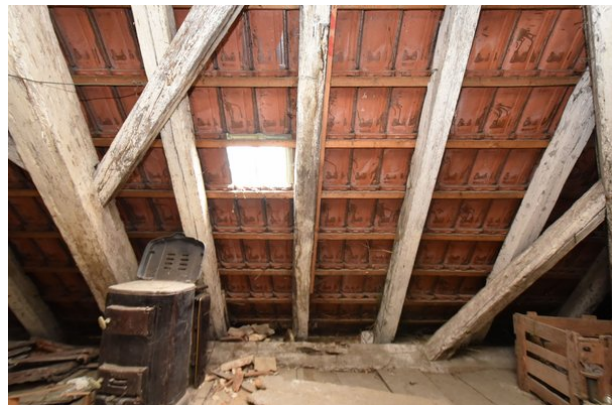
Frontalansicht Wand b (südlicher Teil), Raum 2.05, mit Blickrichtung Osten;
