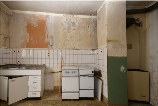
Frontalansicht Wand c, Raum 1.06, mit Blickrichtung Süden;
