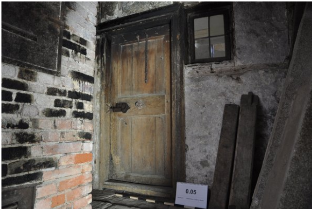
Raum 0.05d, Detailansicht der Tür zu Raum 0.02 mit Blickrichtung Westen (strebewerk. 13.08.2015)
