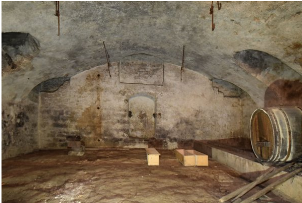
Frontalansicht Wand a, Raum -1.02, mit Blickrichtung Norden;
