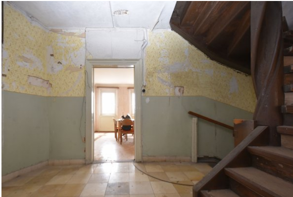
Frontalansicht Wand c, Raum 1.01, mit Blickrichtung Süden;
