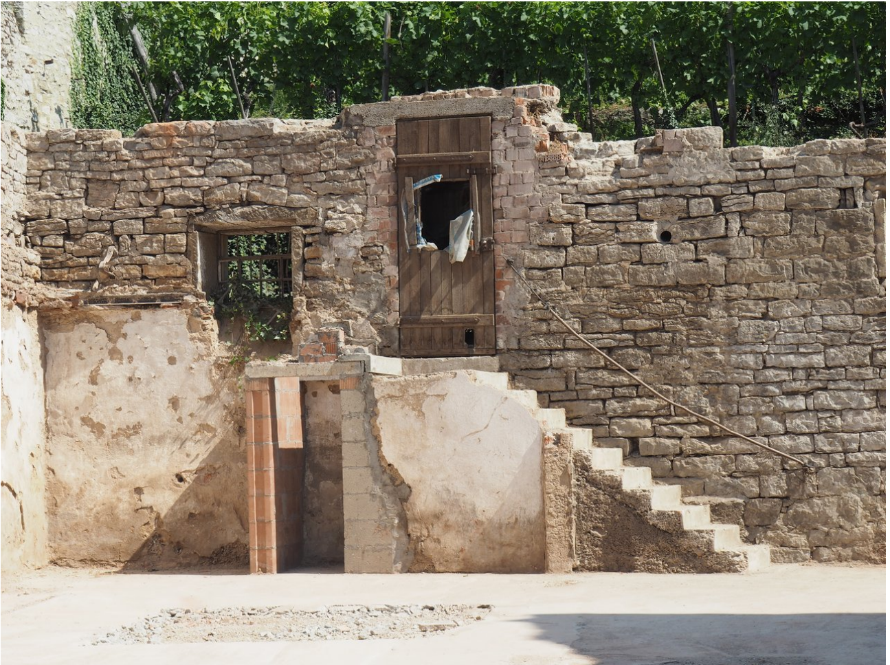
Nördliche Scheunenwand nach Abbruch der Scheune
