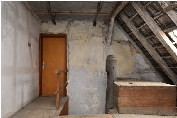
Frontalansicht Wand d, Raum 2.01, mit Blickrichtung Westen;
