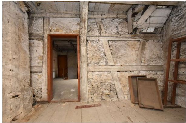
Frontalansicht Wand d (nördlicher Teil), Raum 2.05, mit Blickrichtung Westen;
