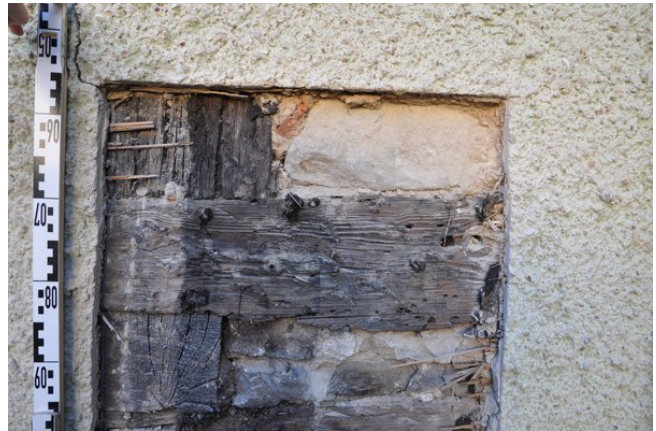
Hof Westfassade Öffnung 1 (Bereich um Schwelle des 1. OG) Abb. 10:
