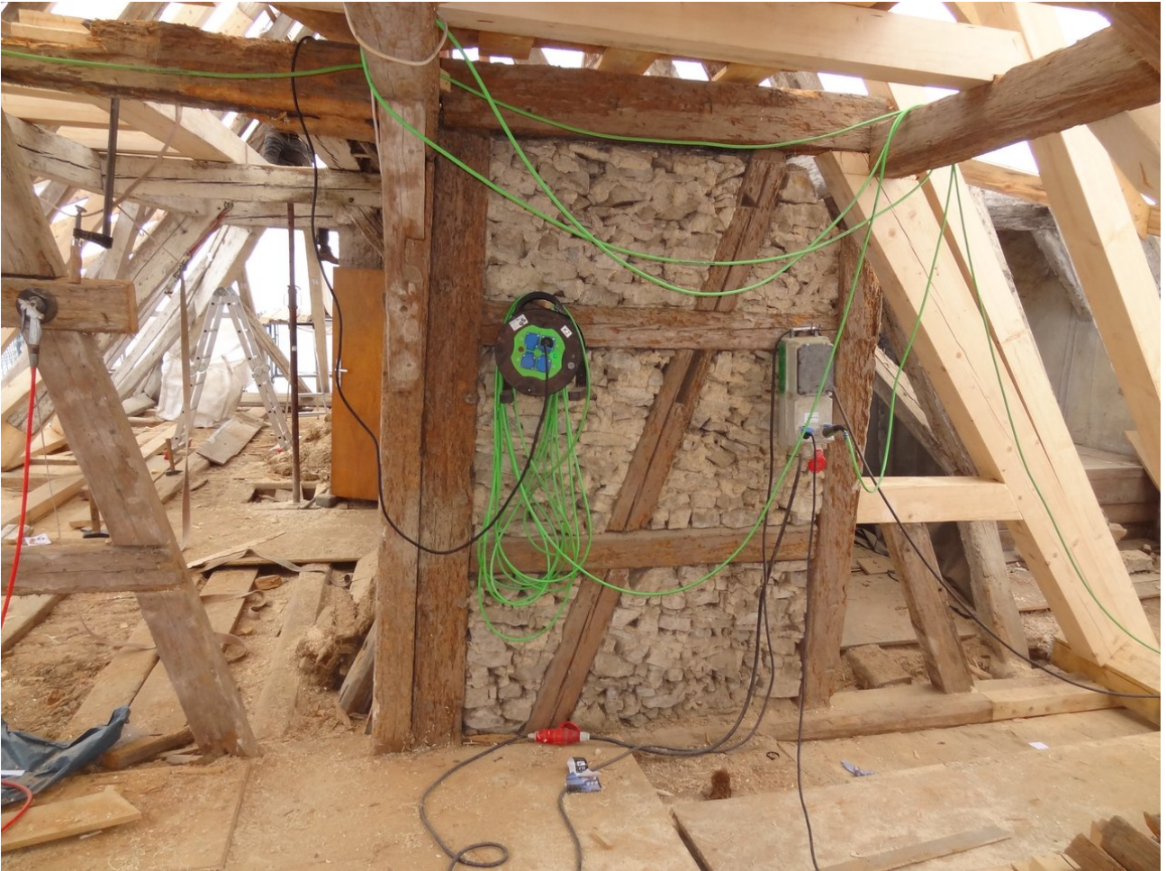
Aufnahme während der Sanierungsmaßnahmen am Dachtragwerk
