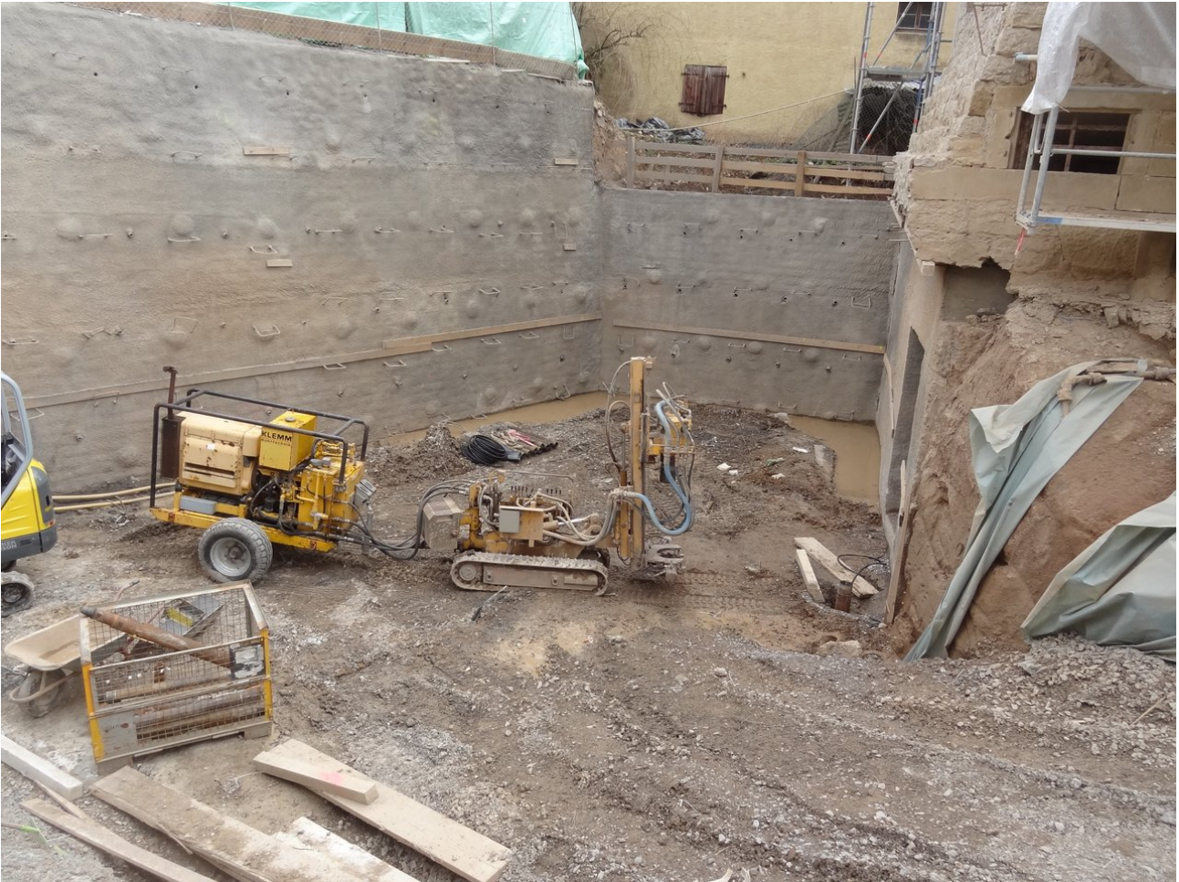
Baugrubenverbau nach Fertigstellung. Beginn der Gründungsarbeiten für den Neubau.
