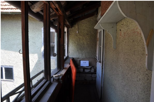
Raum 1.11abc, Diagonalaufnahme mit Blickrichtung Nordosten (strebewerk. 13.08.2015)
