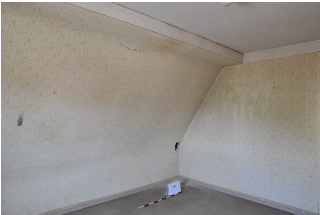
Raum 2.02ab, Diagonalaufnahme mit Blickrichtung Nordosten (strebewerk. 13.08.2015)
