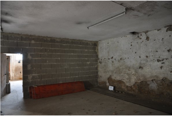
Wände cd (streberwerk. 13.08.2015)
