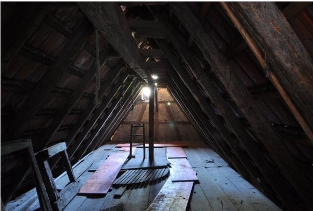
Raum 3.02a, Frontalansicht Wand a mit Blickrichtung Norden (streberwerk. 05.10.2015)
