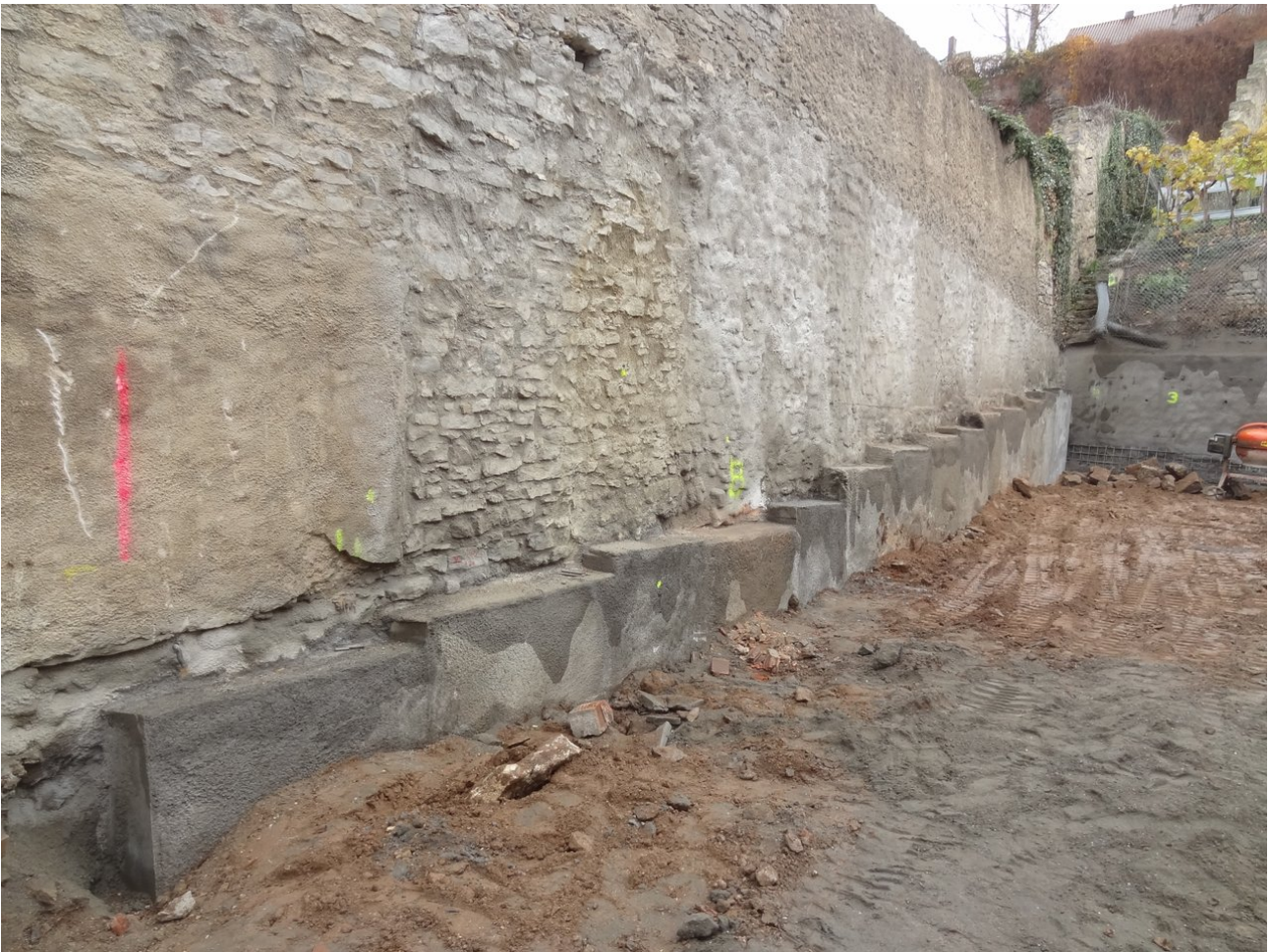
Abschnittsweise Unterfangung der Klostermauer nach der Fertigstellung
