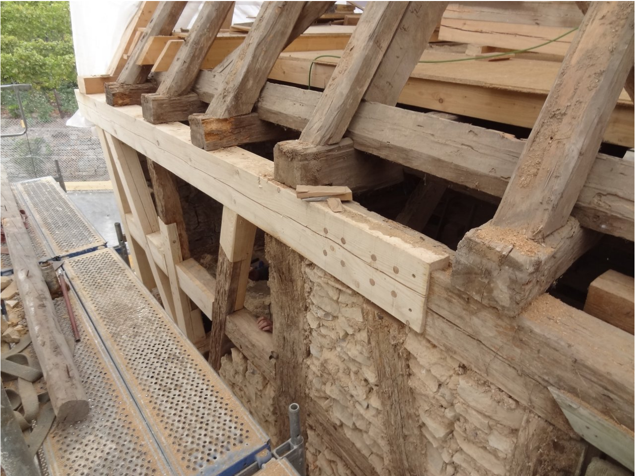
Sanierung Traufe West
