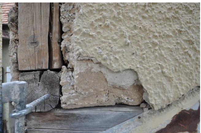
Wohnhaus Westfassade Öffnung 1 (Bereich der Gebäudeecke im 1. OG) Abb. 16: Befundöffnung 1 Eckständer und Schwelle des um 1900 angebauten WC-Annex; (Feldtkeller, 02.08.2017)
