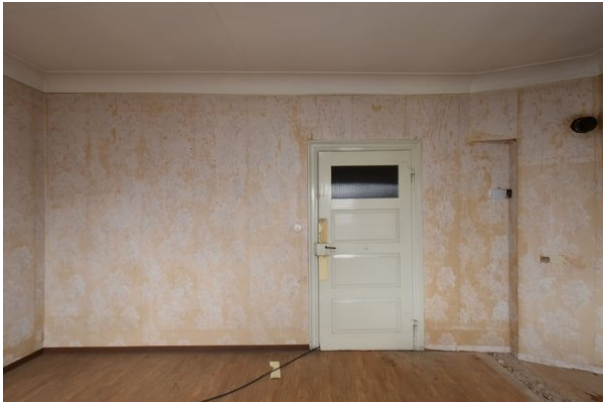
Frontalansicht Wand a, Raum 1.04, mit Blickrichtung Norden;
