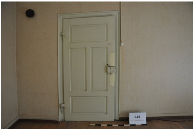
Raum 0.03b, Detailansicht der Tür zu Raum 0.02 mit Blickrichtung Osten (streberwerk. 13.08.2015)
