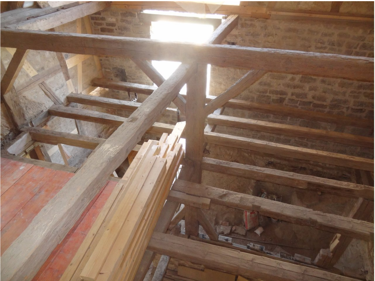
Balkenlage Zischendecke Scheune
