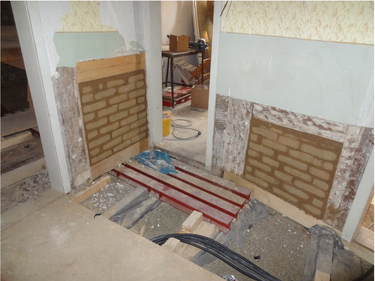
Statische Verstärkung der Decke
