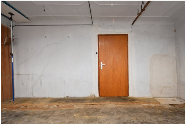
Frontalansicht Wand a, Raum 2.04, mit Blickrichtung Norden;
