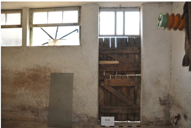
Raum 0.13c, Detailansicht der Tür zum Innenhof mit Blickrichtung Süden (streberwerk. 12.08.2015)
