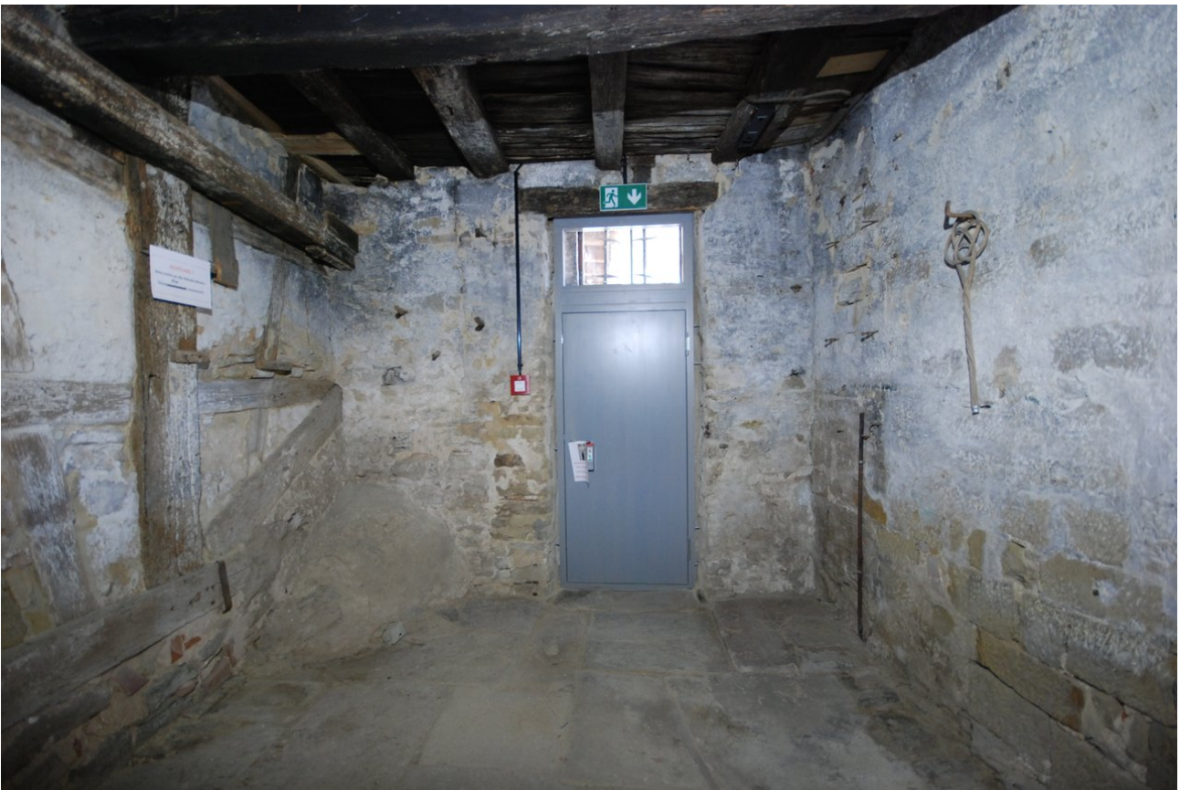
Ansicht der fertig sanierten Wand
