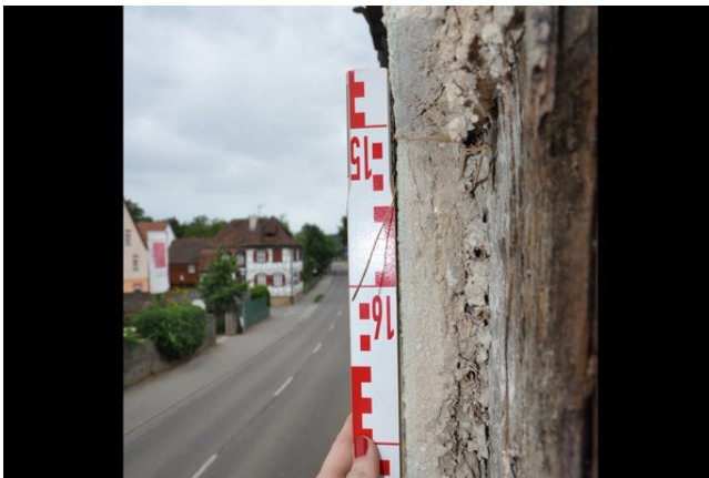
Ostfassade Öffnung 1 (Gebäudeecke) Abb.4:
