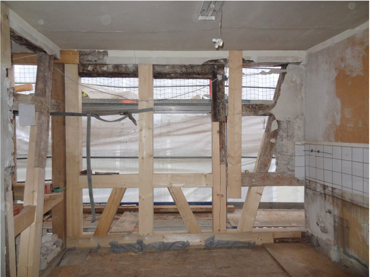
Fachwerkwände nach der Sanierung
