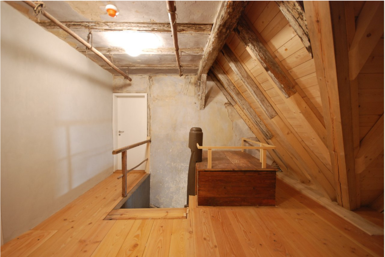
Ansicht fertig sanierte Wand
