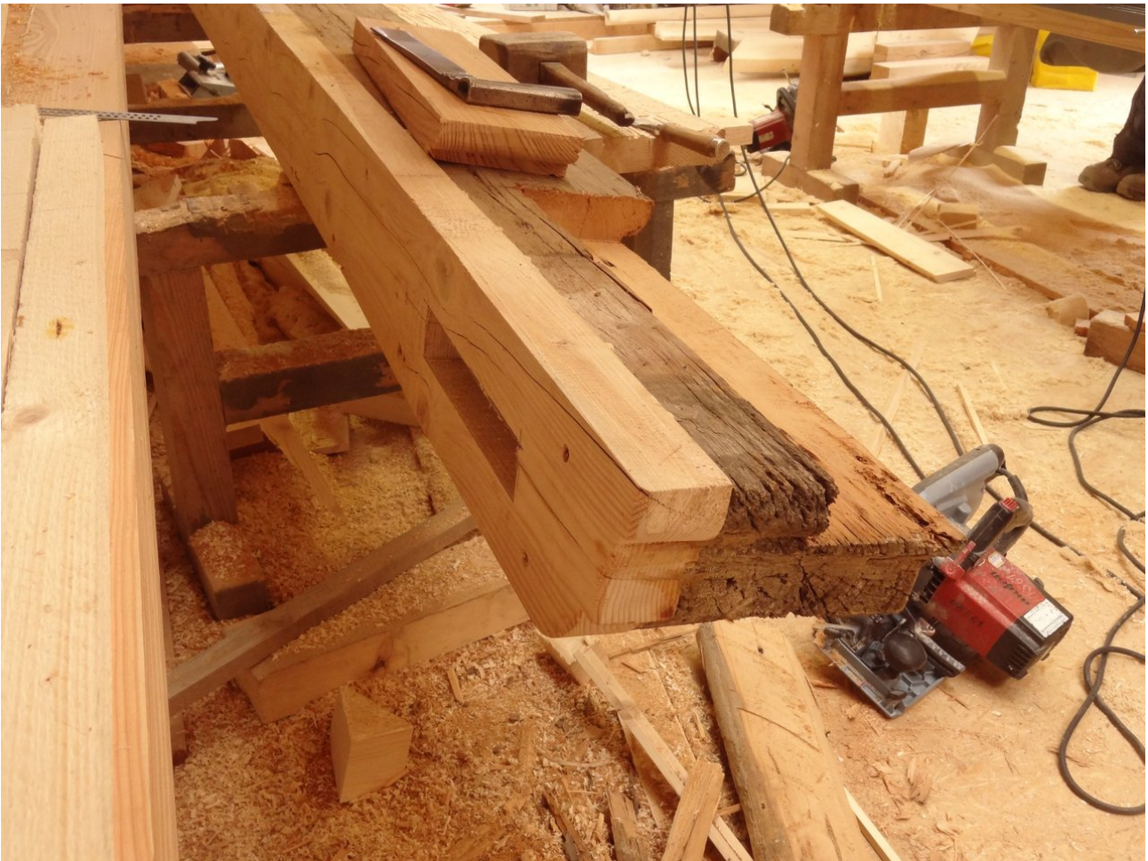
Sanierung profilierter Gesimsbalken
