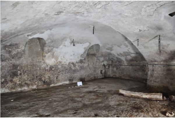
Kellerraum R101cd (streberwerk. 13.08.2015)
