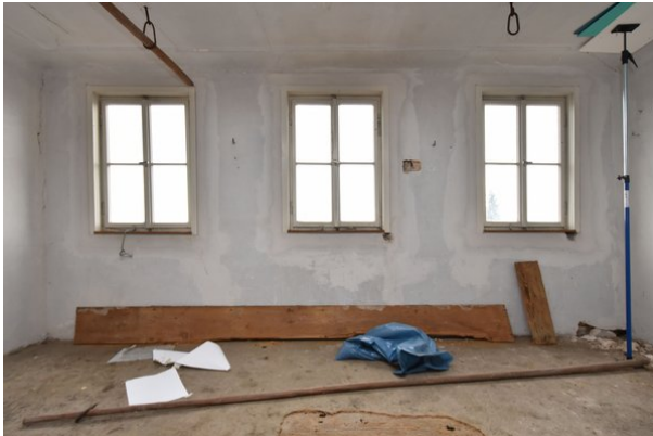
Frontalansicht Wand c, Raum 2.04, mit Blickrichtung Süden;
