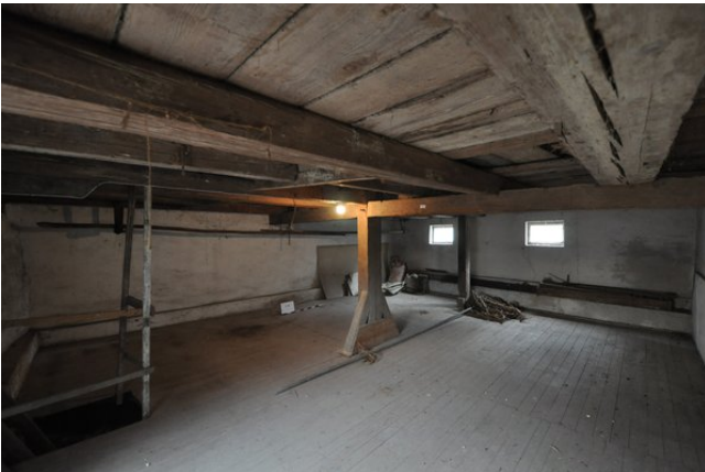
Raum 1.13ab, Diagonalaufnahme mit Blickrichtung Nordosten strebewerk.(05.10.2015)
