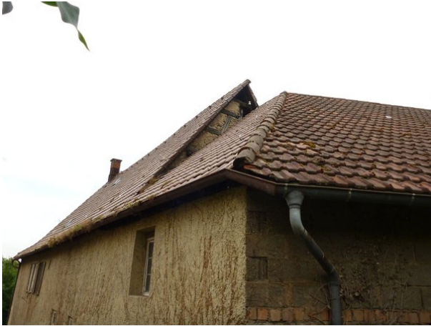
Ansicht Fassaden aus Nordost (strebewerk. 13-08-2015)
