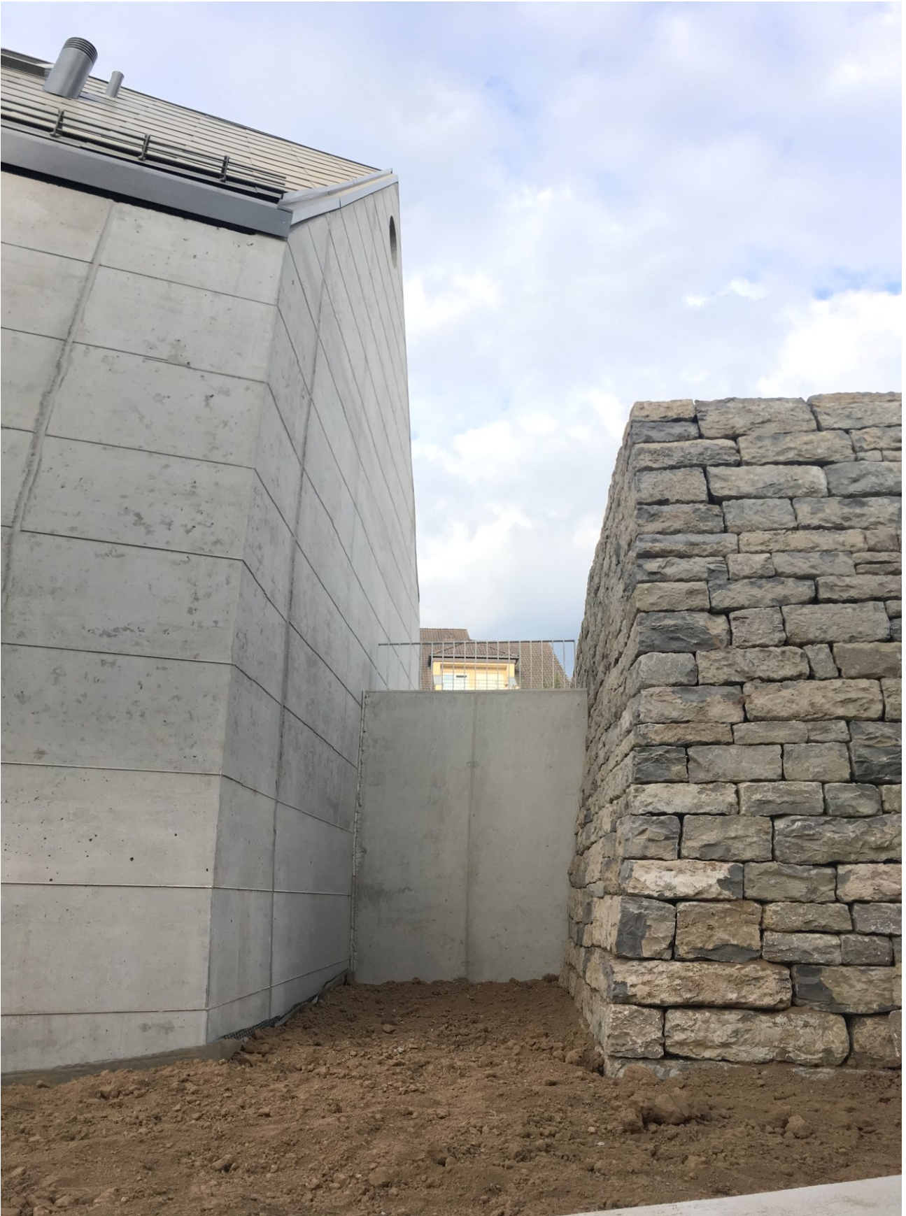
Ansicht Zwischenraum Treppenabau / Weinbergsmauer
