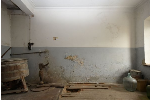
Frontalansicht Wand b, Raum 0.04, mit Blickrichtung Osten;
