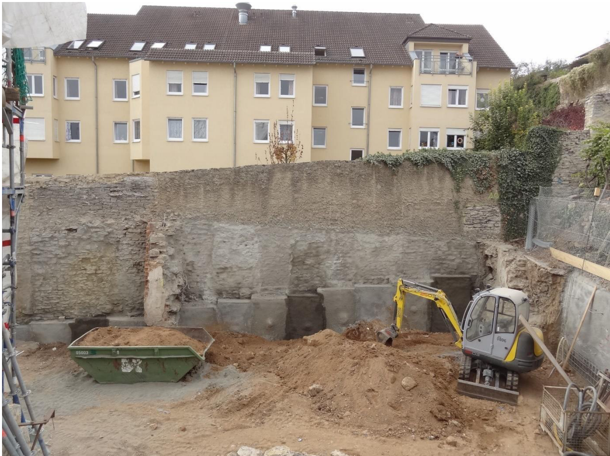
Bild 11 Ansicht der Klostermauer unmittelbar vor Abschluss der Unterfangungsarbeiten (zur Fertigstellung fehlt noch ein Unterfangungsabschnitt).
