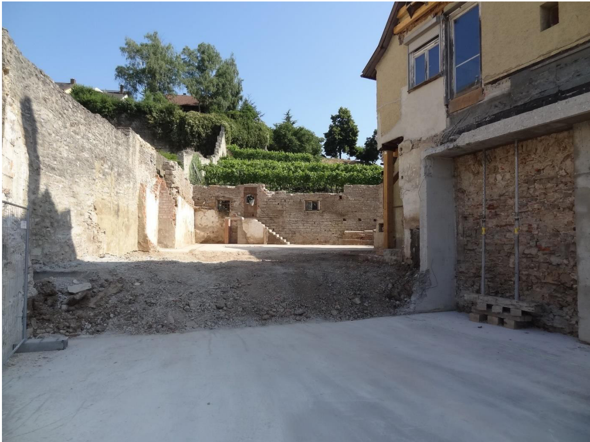
Bild 1 Zustand der Klostermauer (links im Bild) während der Abbruch- und Rückbauarbeiten im Bereich des Hölderlinwohnhauses (rechts im Bild).
