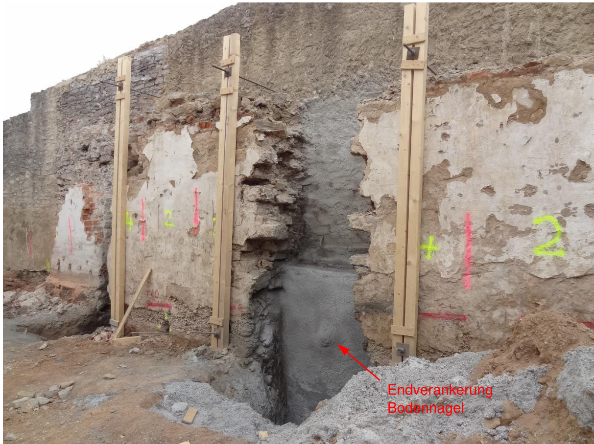
Bild 7 Fertiggestellte Abschnitte L (rechts) und H (links) des Unterfangungstaktes Nr.1.
