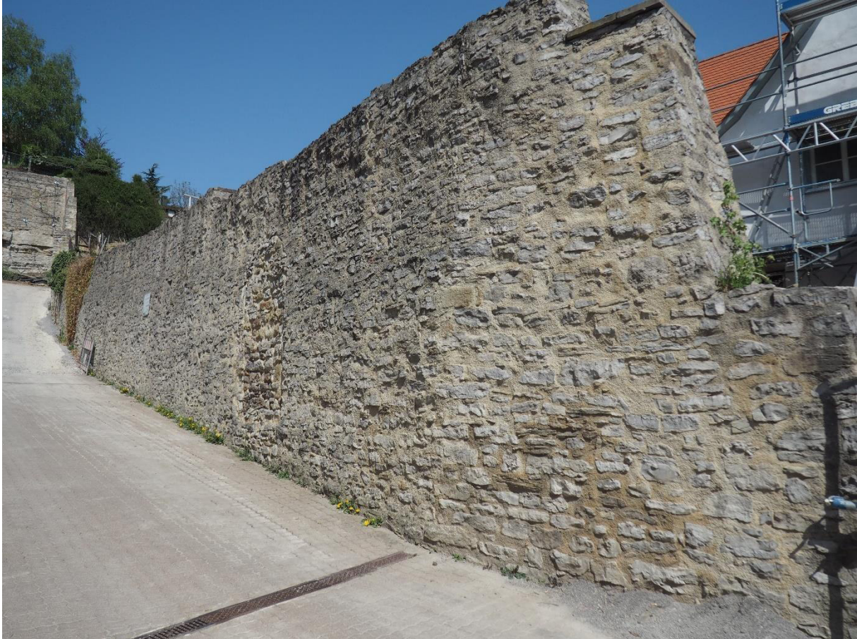
Bild 13 Ansicht der westlichen Wandflächen der Klostermauer
