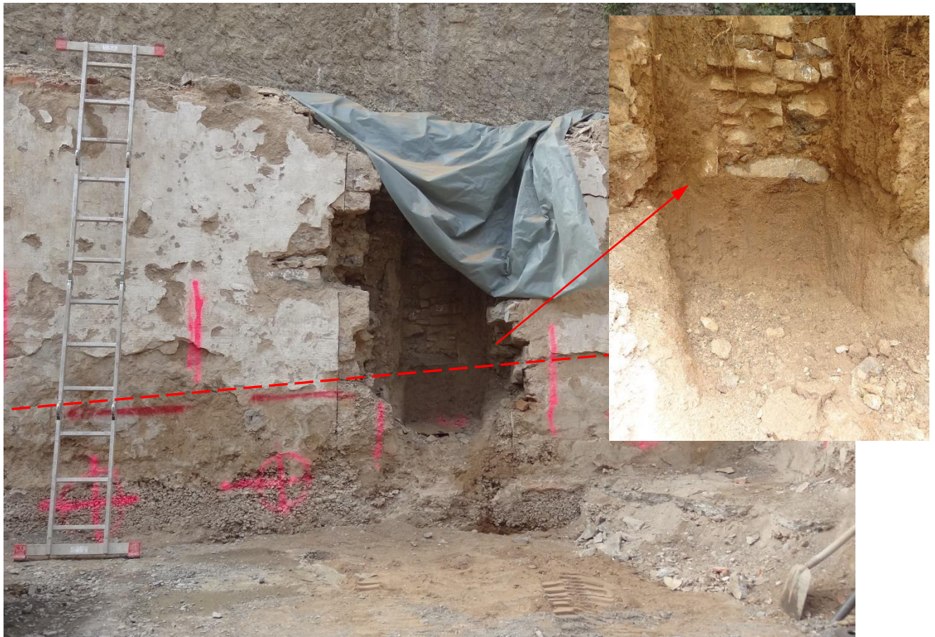
Bild 5 Detailaufnahme zu Bild 4: Sondageöffnung in der westlichen Scheunenwand.
