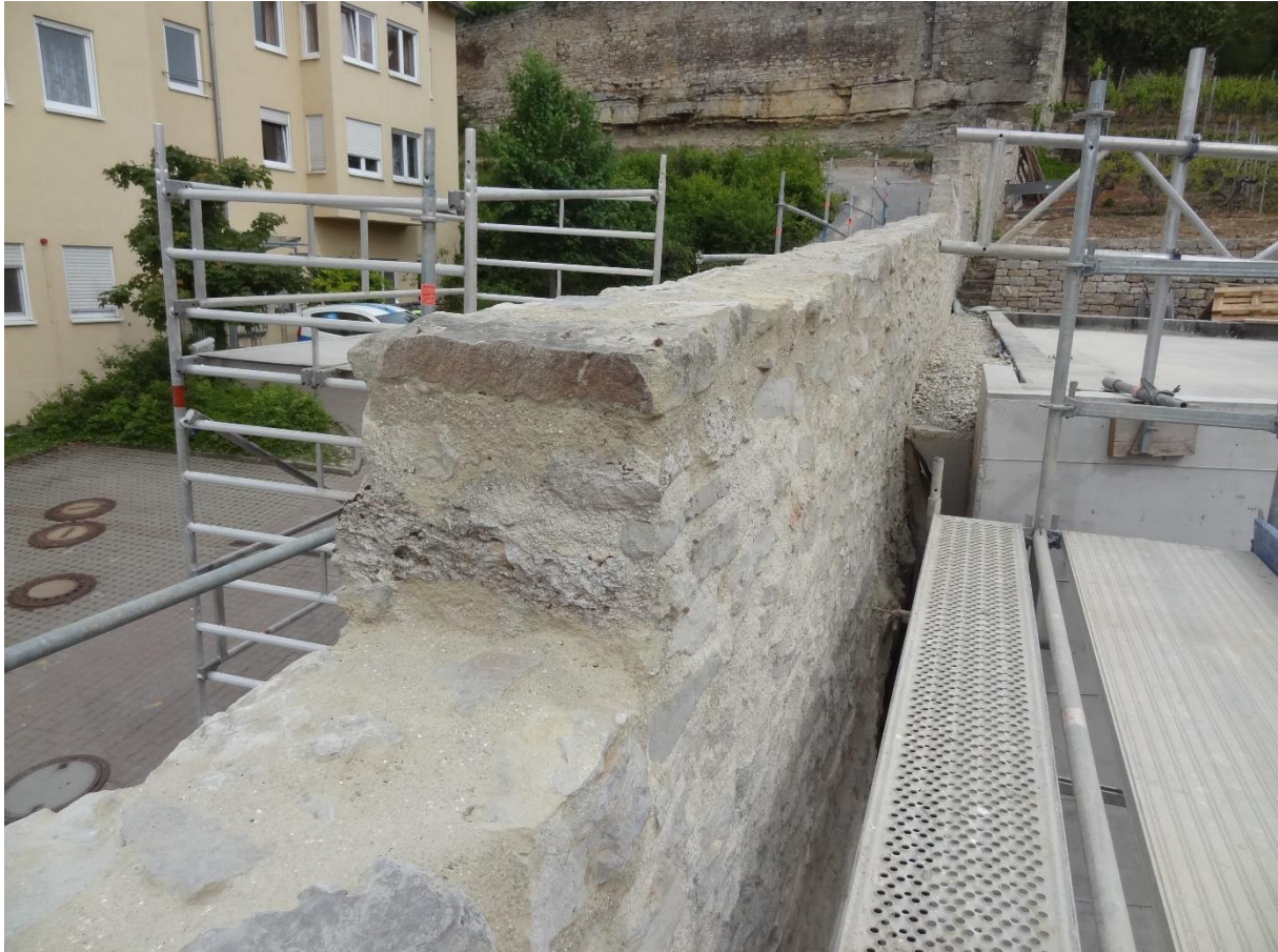
Bild 21 Mauerkrone nach Abschluss der Sanierungsmaßnahmen (Aufnahme Mai 2020)
