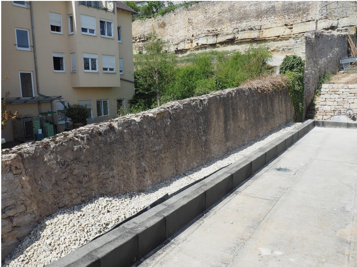
Bild 17 Ansicht der westlichen Mauerfläche der Klostermauer (nördlicher Abschnitt) vor Beginn der Sanierungsmaßnahmen.
