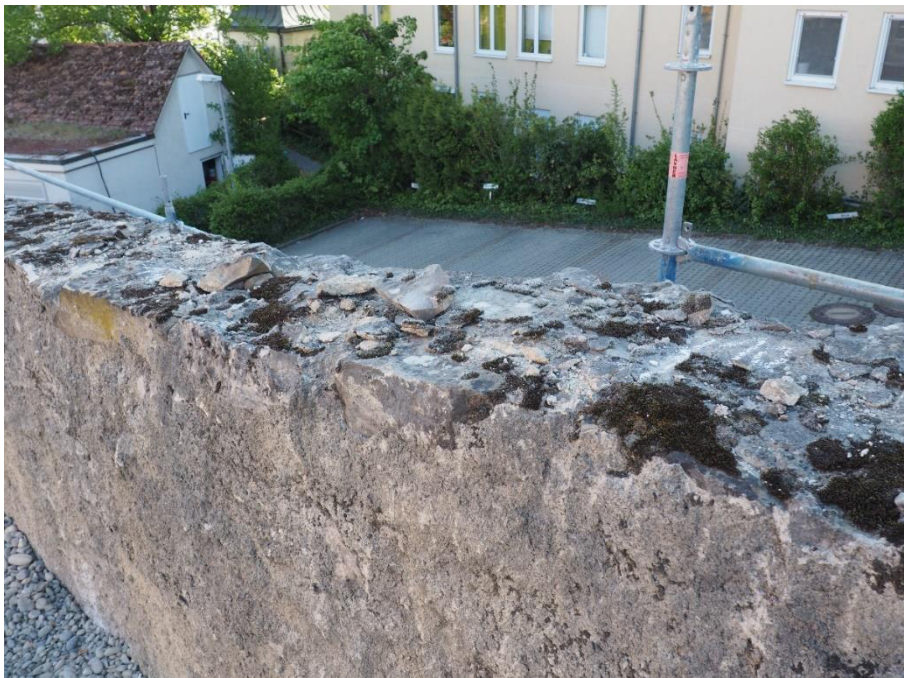
Bild 14 und Bild 15 Mauerkrone der Klostermauer
