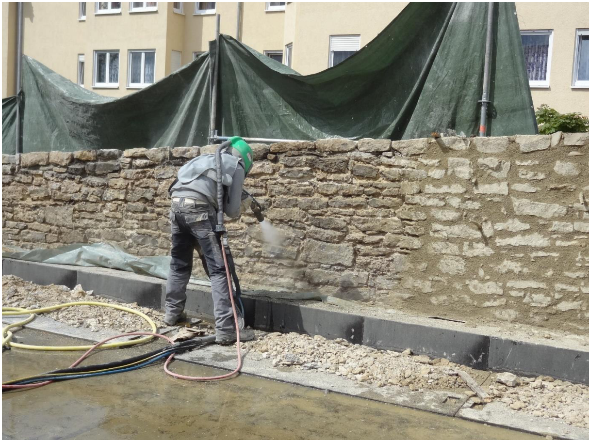
Bild 19 Maschinelle Neuverfugung der Mauerflächen (Aufnahme April 2020)
