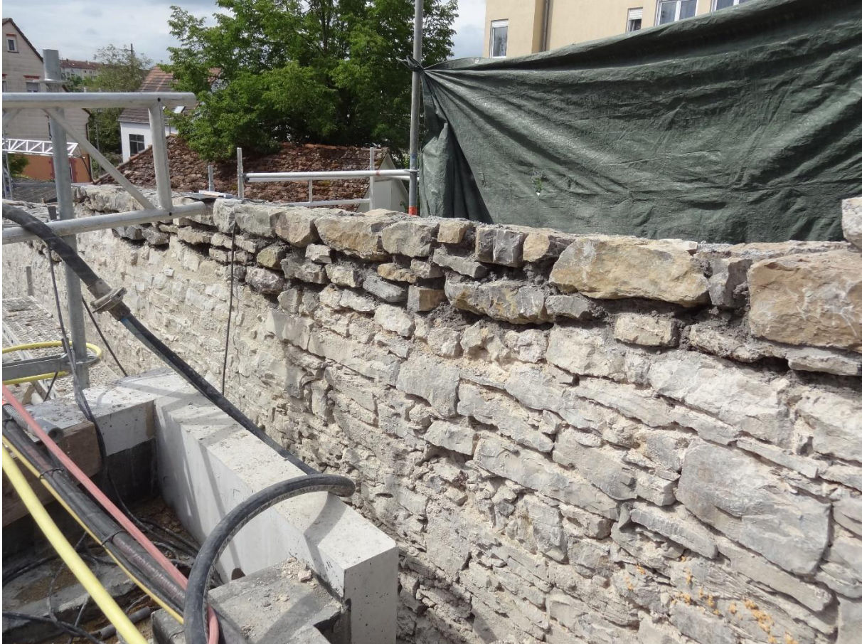
Bild 18 Sanierung der Mauerkrone
