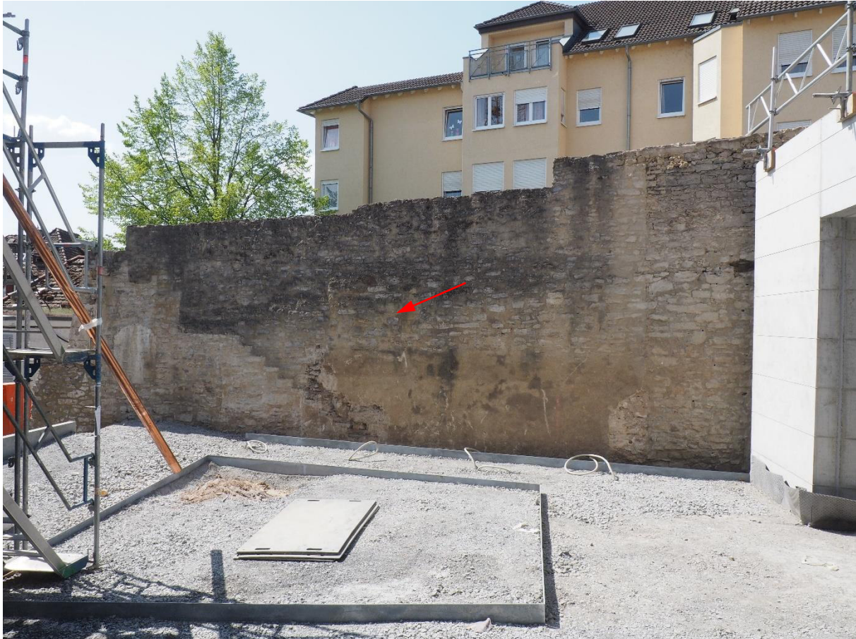
Bild 16 Ansicht der westlichen Mauerfläche der Klostermauer (südlicher Abschnitt) vor Beginn der Sanierungsmaßnahmen
