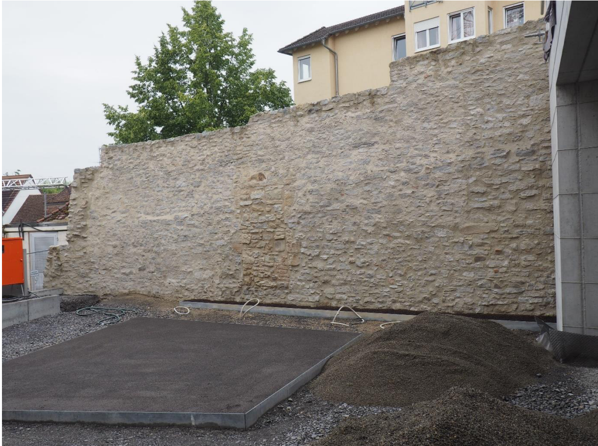
Bild 20 Ansicht der westlichen Mauerfläche der Klostermauer (südlicher Abschnitt) nach Abschluss der Sanierungsmaßnahmen.
