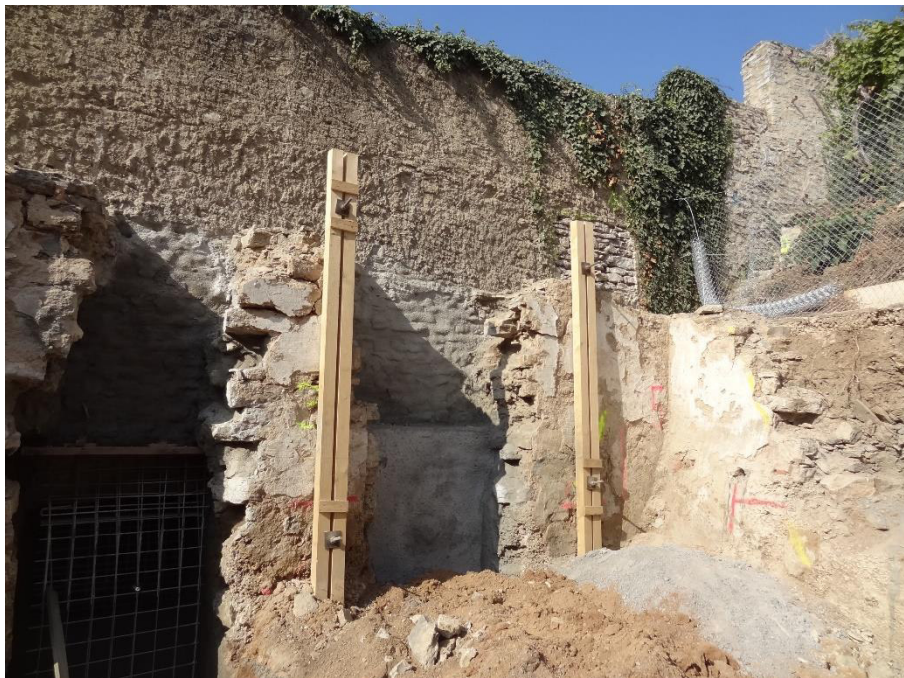
Bild 8 und Bild 9 Abschnittsweises Herstellen der Unterfangung (Aufnahmen Oktober 2018)
