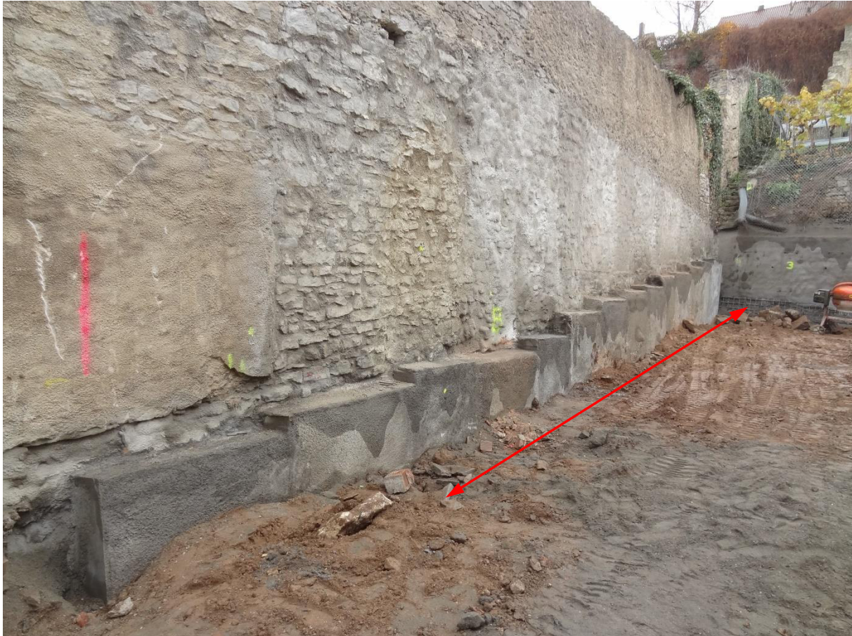
Bild 10 Ansicht der Klostermauer nach Fertigstellung aller Unterfangungsabschnitte.
