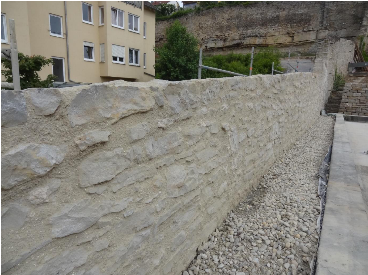
Bild 22 Ansicht der westlichen Mauerfläche der Klostermauer (nördlicher Abschnitt) nach Abschluss der Sanierungsmaßnahmen.
