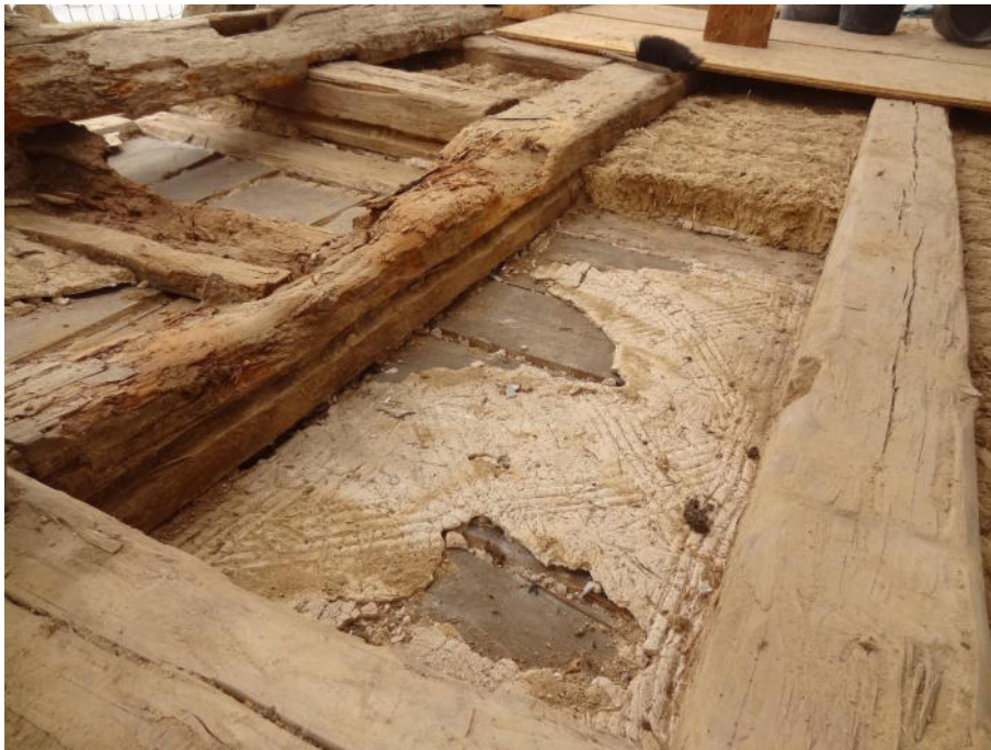
Bild 23 Wohnhaus, Decke über Obergeschoss (Aufnahme September 2018)
