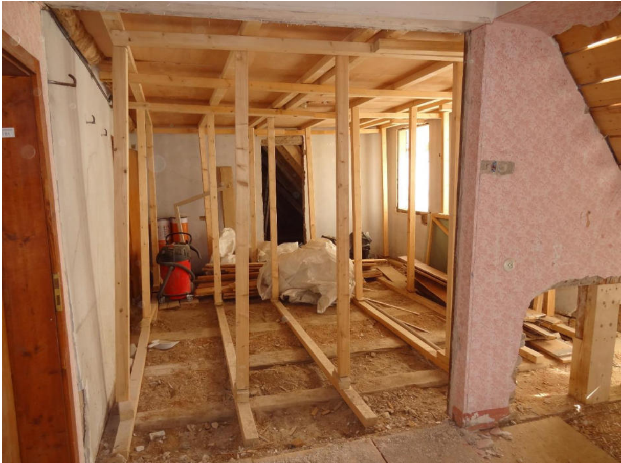
Bild 32 Wohnhaus, 1. Dachgeschoss, Raum 2.04: Weichsprießung der Decke
