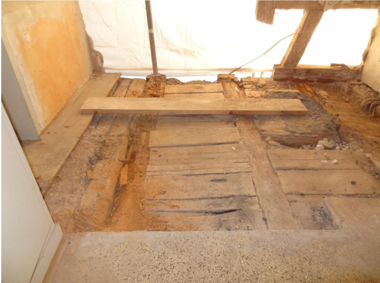
Bild 27 Wohnhaus, Obergeschoss (Decke über EG), Raum 1.06 (ehemalige Küche)
