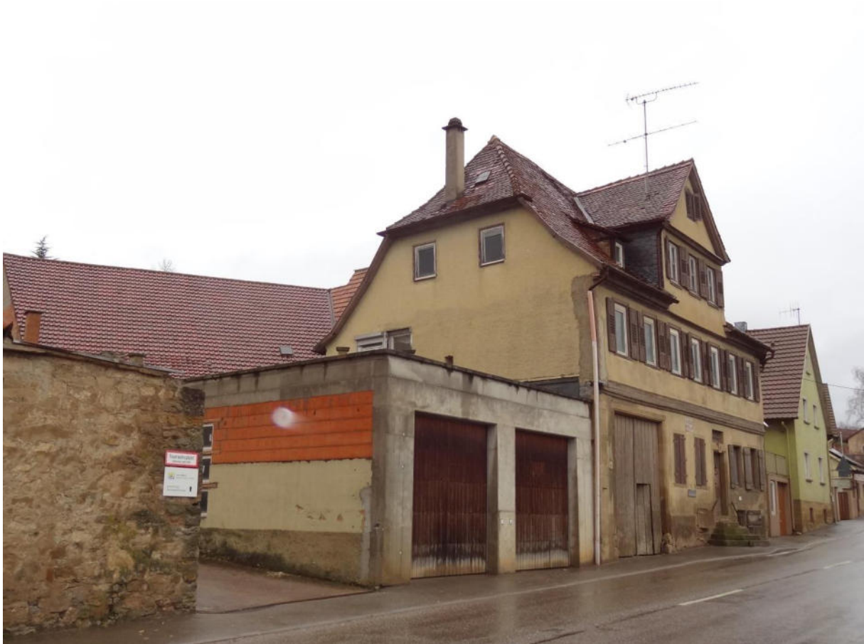
Bild 51 Ansicht Hölderlinhaus vor Beginn der Sanierungsmaßnahmen
