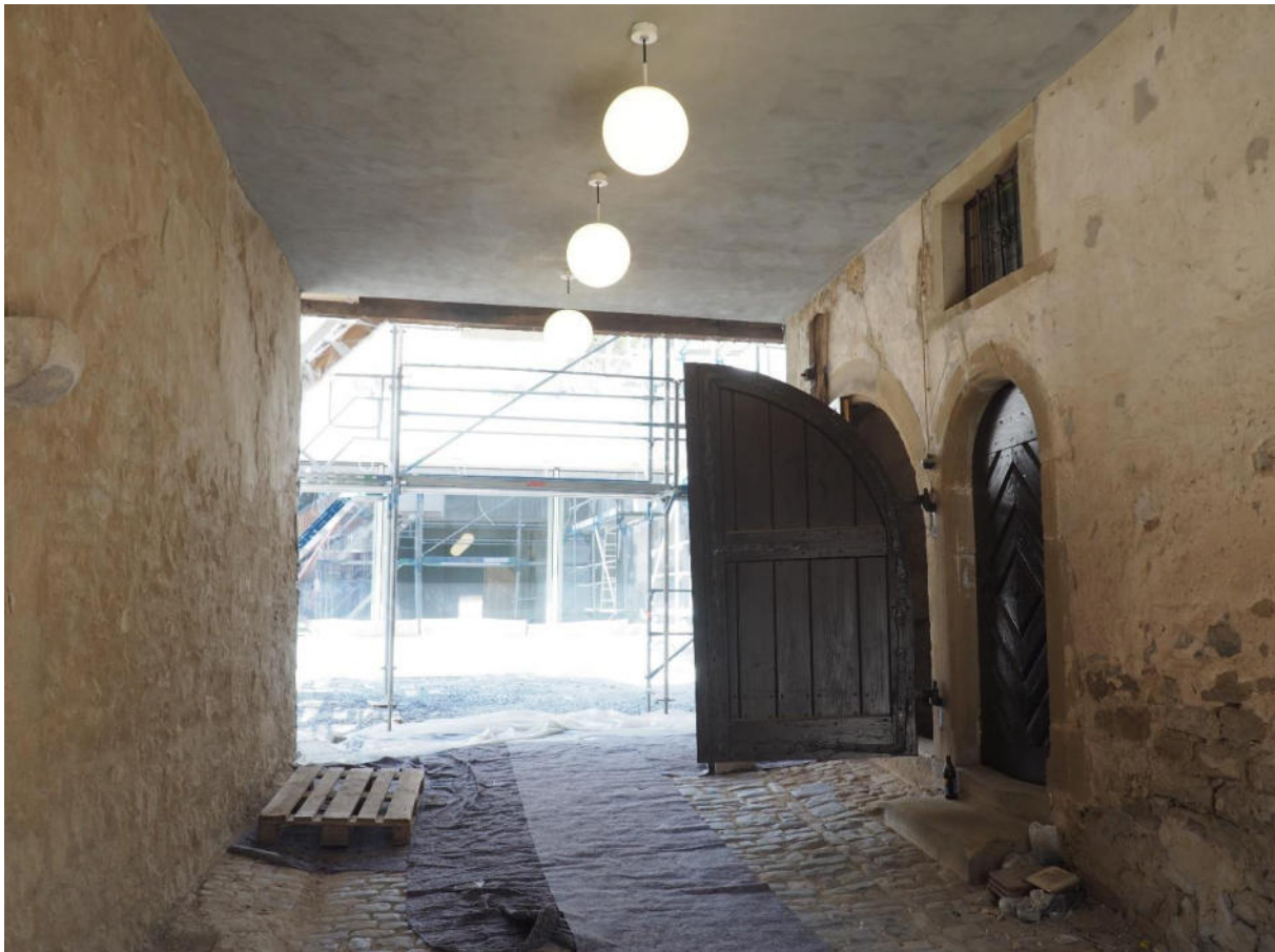
Bild 44 Hofdurchfahrt nach Abschluss der Sanierungs- und Restaurierungsmaßnahmen (Aufnahme April 2020)
