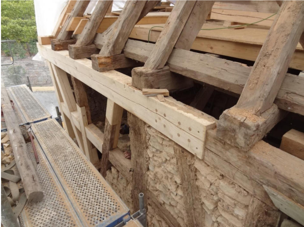
Bild 22 Scheune, Außenwand West, Gebäudeecke Nord-West, nach Abschluss der Sanierungsarbeiten am Fachwerk.
