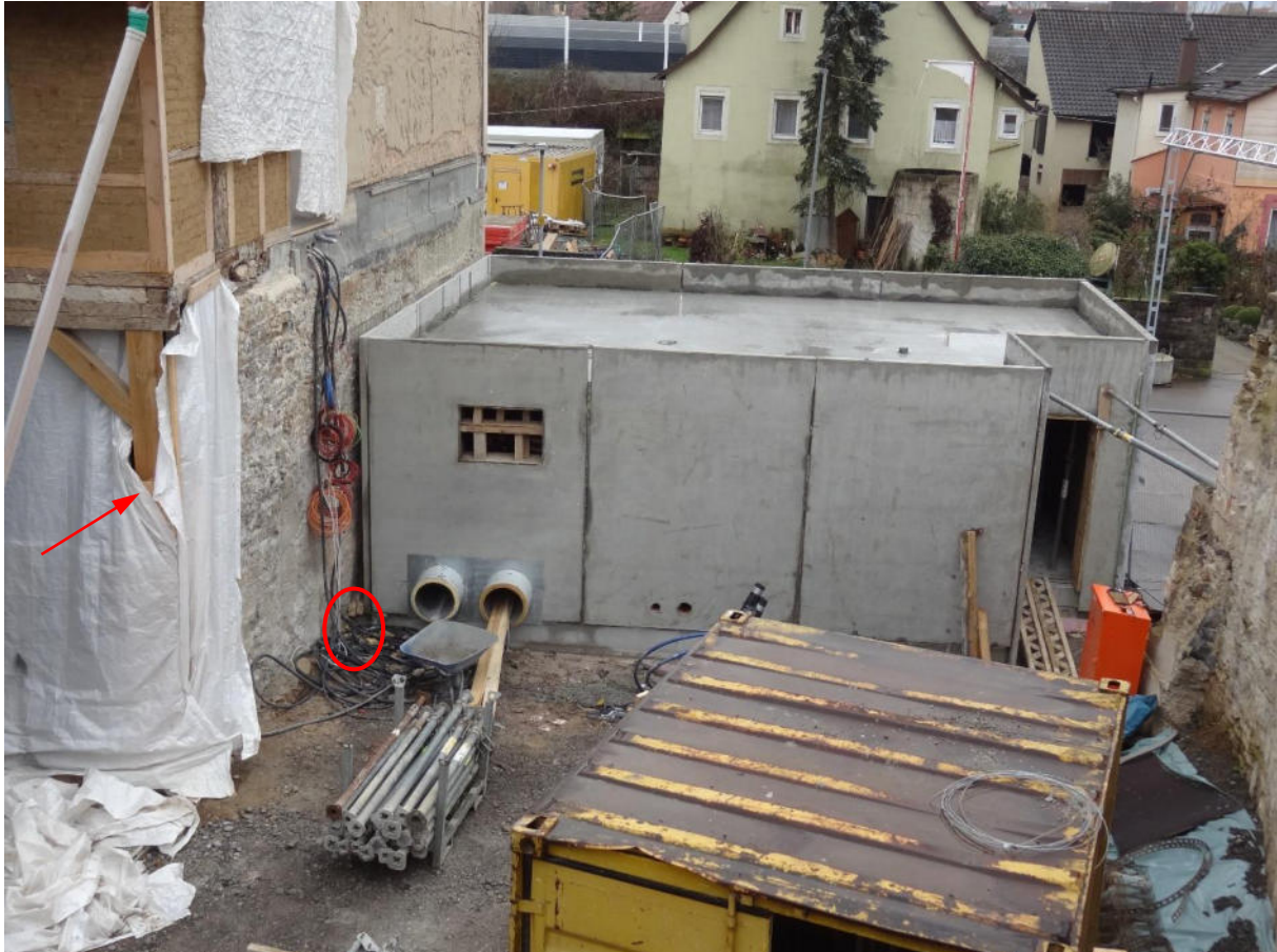
Bild 43 Wohnhaus, Giebelwand West nach Abschluss der Rohbauarbeiten am Technikgebäude und den Unterfangungsarbeiten an der westlichen Mauerwerkswand der Hofdurchfahrt.
