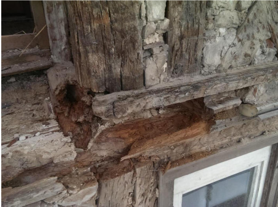
Bild 25 Wohnhaus, Außenwand Süd (Aufnahme Januar 2019)
