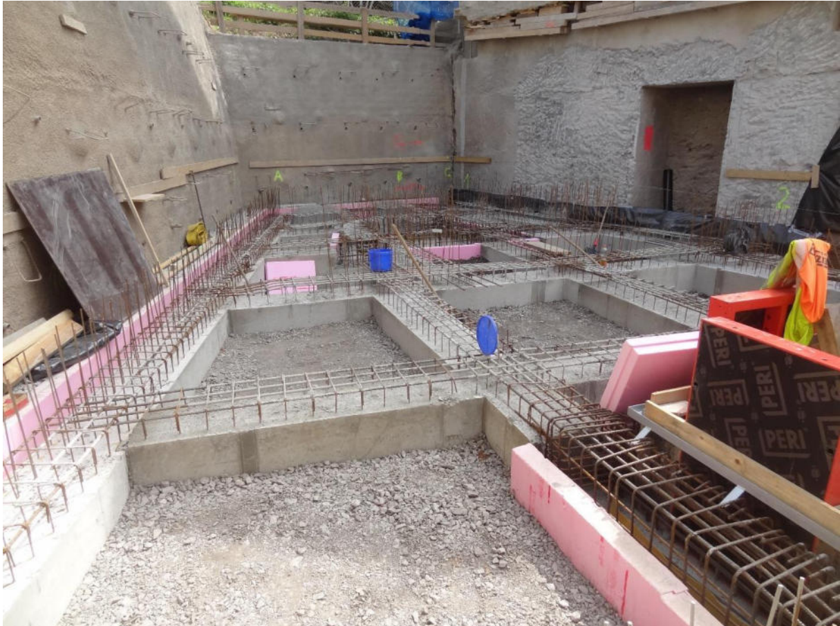
Bild 16 Errichtung Neubau, Fundamentbalken des Untergeschosses.
