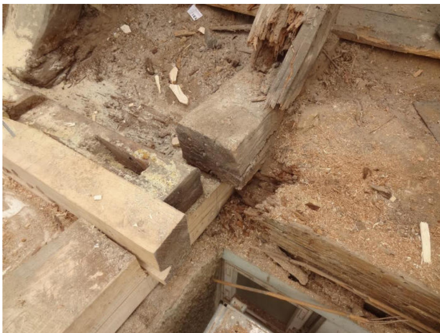
Bild 26 Wohnhaus, Außenwand Nord, Übergang zur Scheune (Aufnahme Oktober 2018)
