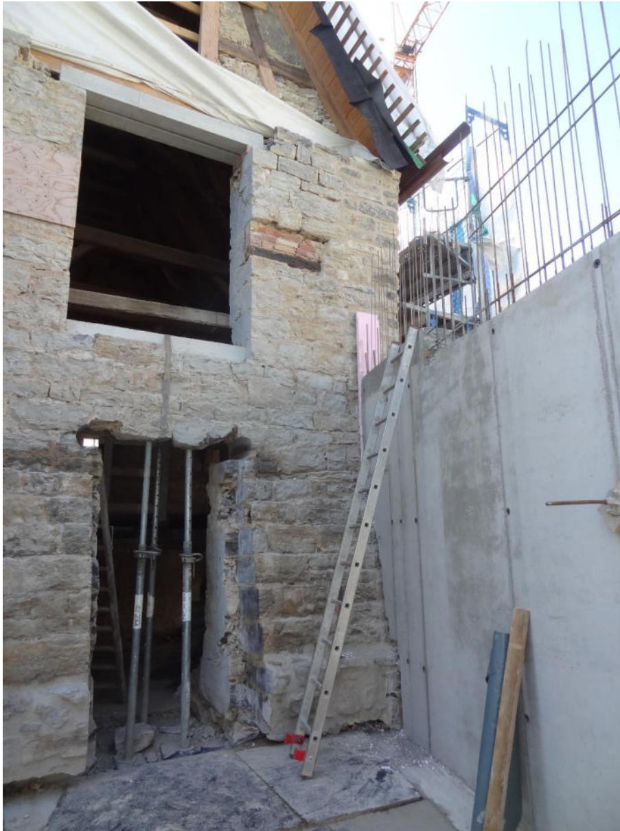
Bild 45 Scheune, Giebelwand Nord während dem Herstellen der Wanddurchbrüche im Erd- und Obergeschoss.
