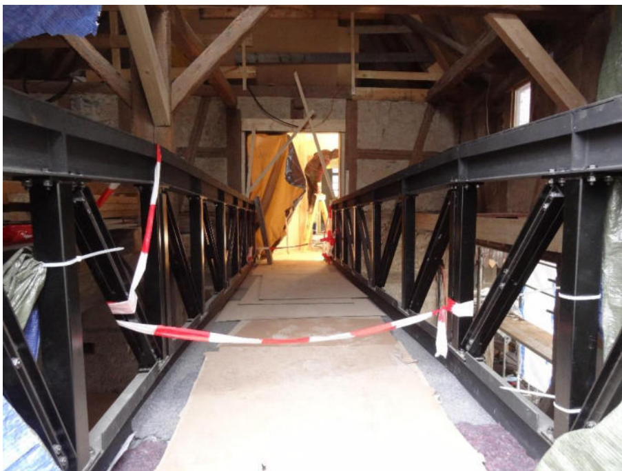
Bild 47 und Bild 48 Stahlstege im Ober- und Dachgeschoss während der Montage.
