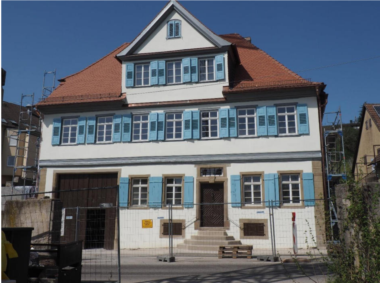
Bild 53 Südansicht des Hölderlinhauses unmittelbar vor Abschluss der Sanierungsmaßnahmen
