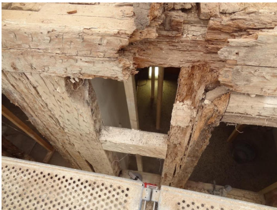
Bild 24 Wohnhaus, Außenwand Ost (Aufnahme September 2018)
