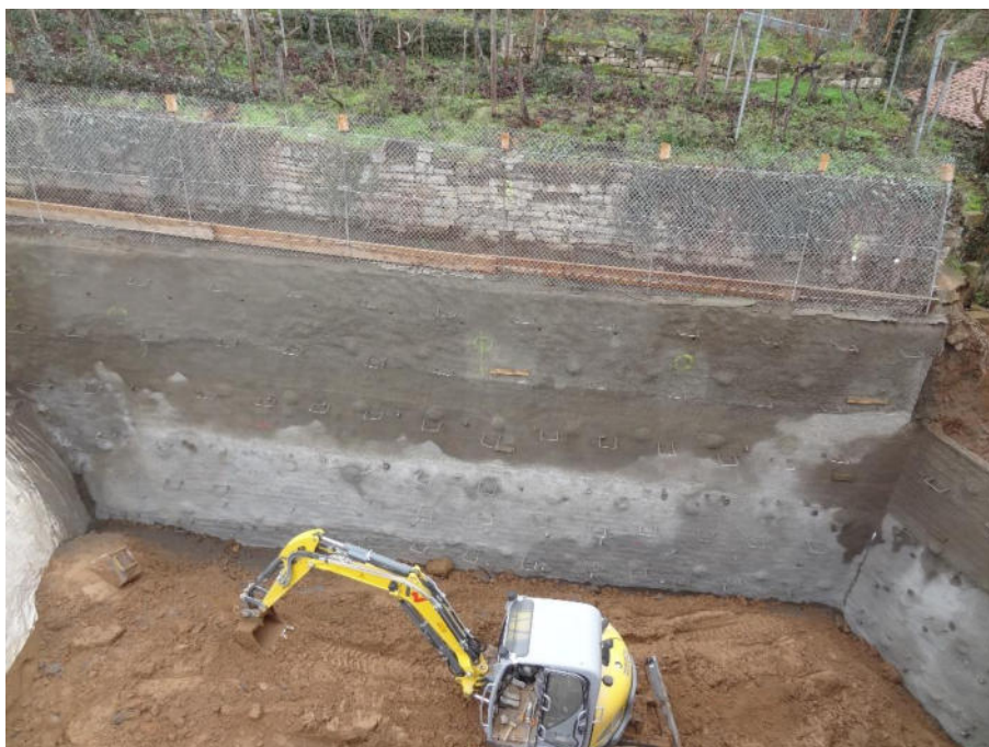
Bild 7 Ausführungsplan ingenieurbürograu Wurst.Wisotzki.GbR zur Ausführung des Baugrubenverbaus mittels Bodenvernagelung und Spritzbetonschale
