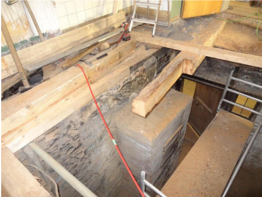
Bild 28 wie Bild 27, Aufnahme während der Sanierungsmaßnahmen (Aufnahme November 2018)
