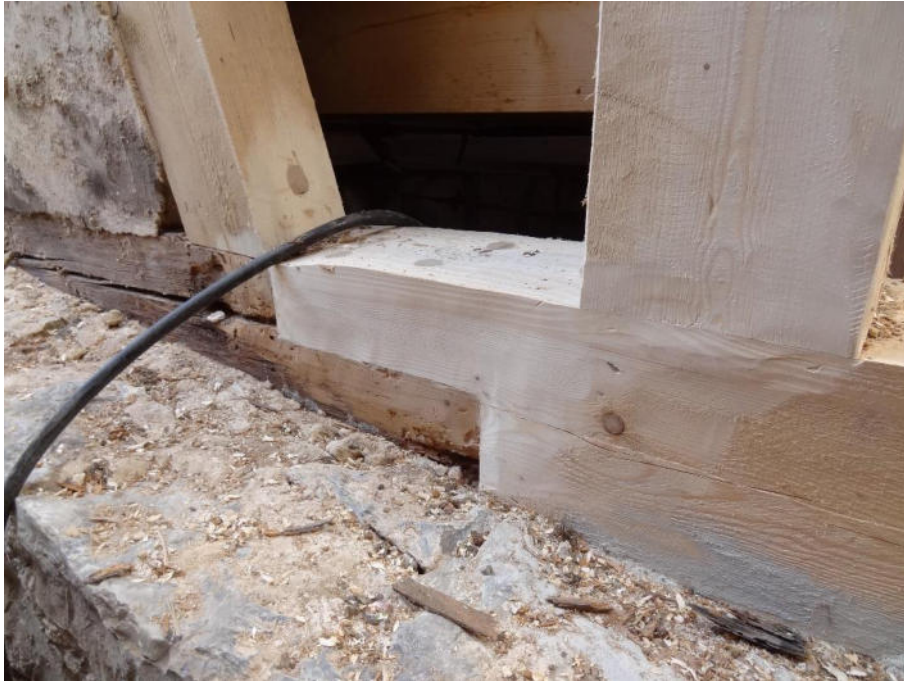
Bild 3 Detailaufnahme zu Bild 2: Sanierung Fachwerkschwelle (Aufnahme April 2018)
