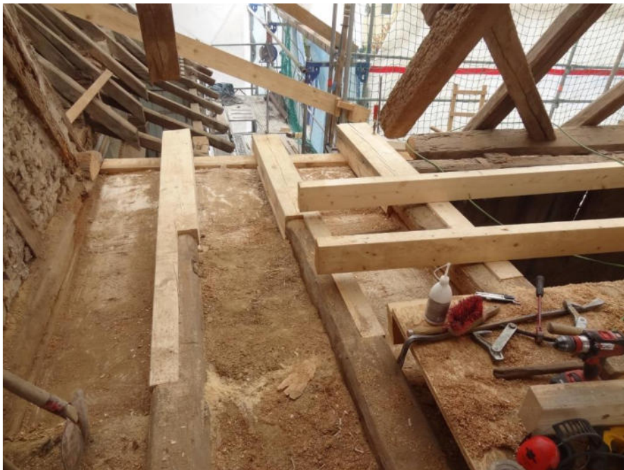
Bild 20 und Bild 21 Scheune, Traufpunkte West, vor uns während der Sanierungsmaßnahmen
