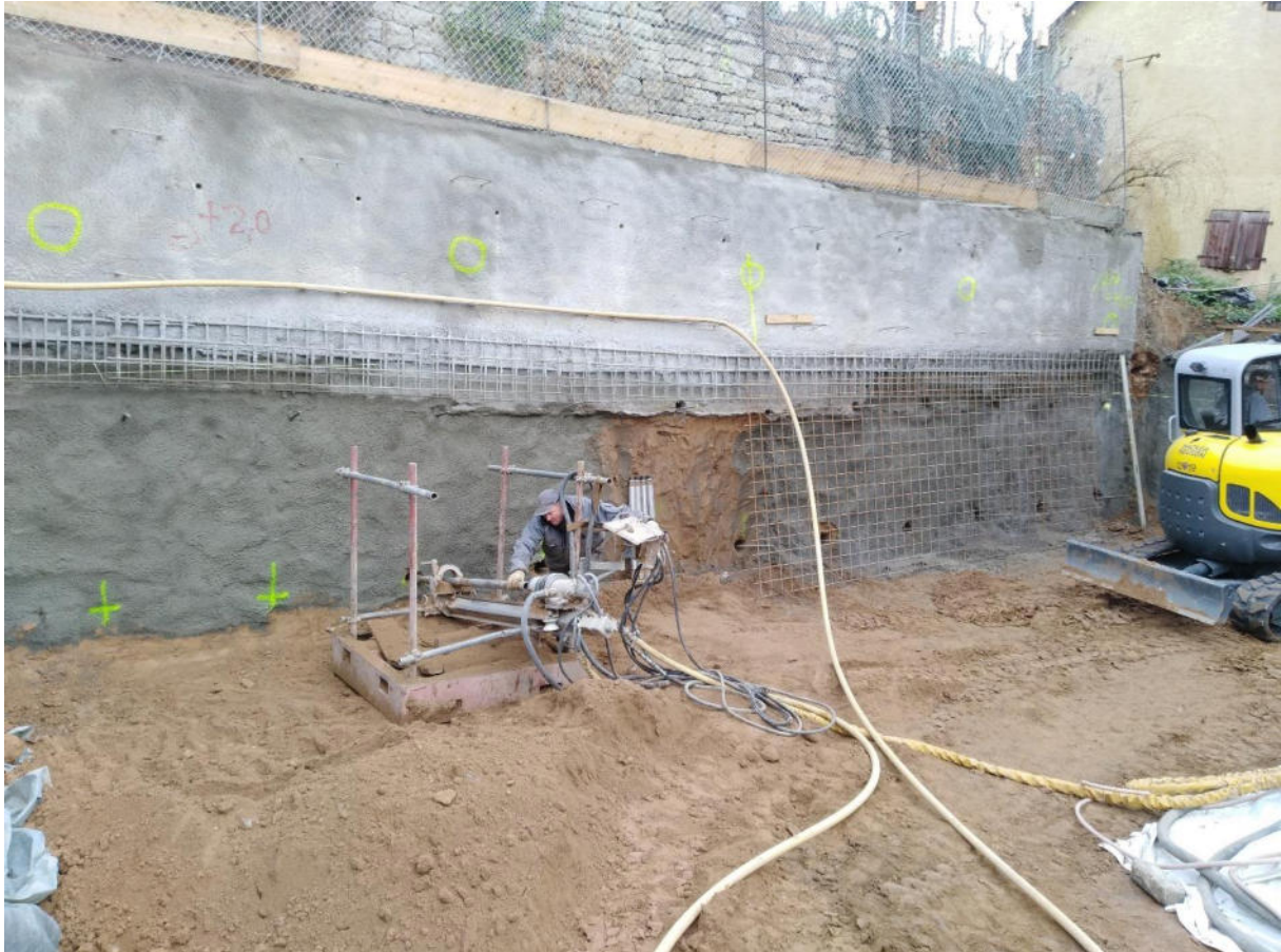
Bild 6 Baugrubenaushub des Neubaus mit Sicherung des anstehenden Geländes mittels rückverhängter Spritzbetonschale.
