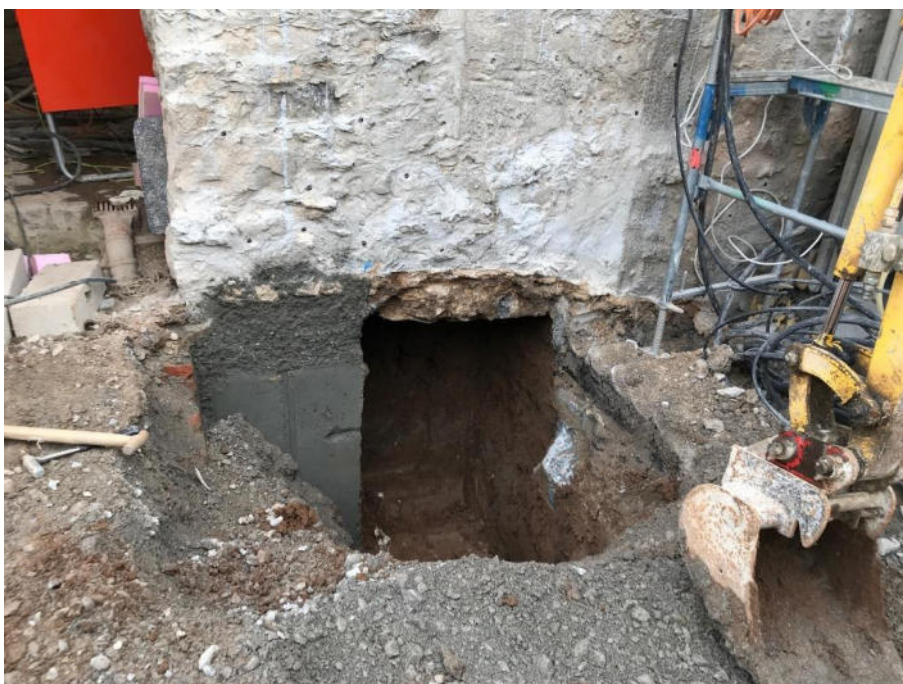
Bild 42 Unterfangungsarbeiten (Aufnahme Januar 2020)
