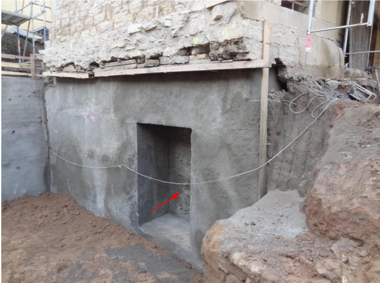
Bild 13 Aufnahme nach Fertigstellung der Unterfangung der Giebelwand.
