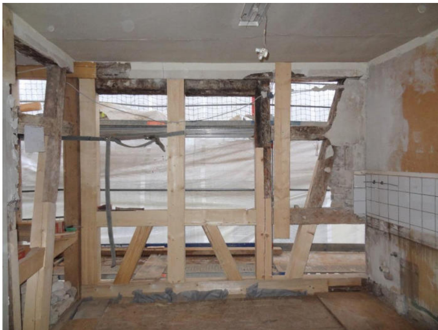
Bild 31 wie Bild 27/30 nach Abschluss der Sanierung
