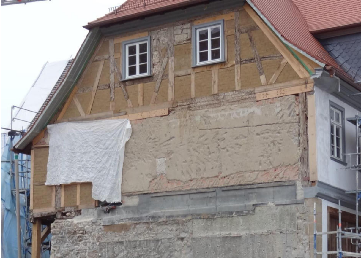
Bild 35 Wohnhaus, Giebelwand West, Ober- und Dachgeschoss nach Abschluss der konstruktiven Sanierungsmaßnahmen.
