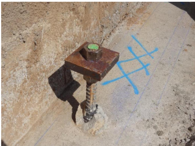
Bild 17 Detailaufnahme Pfahlkopf Erdgeschoss (Aufnahme Juli 2019)
