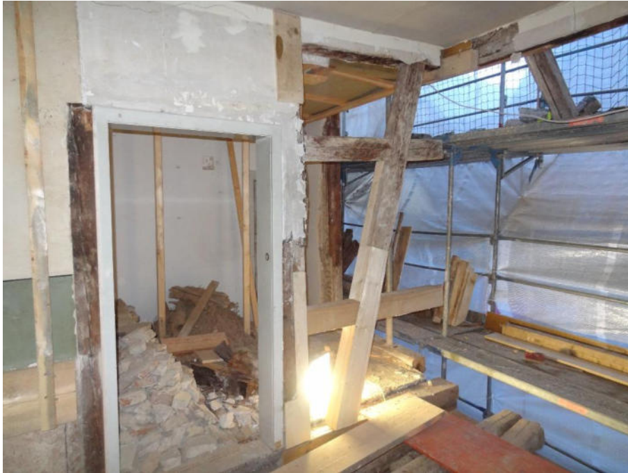
Bild 30 wie Bild 27, Aufnahme während der Sanierungsmaßnahmen an der Innenwand und der Balkenlage
