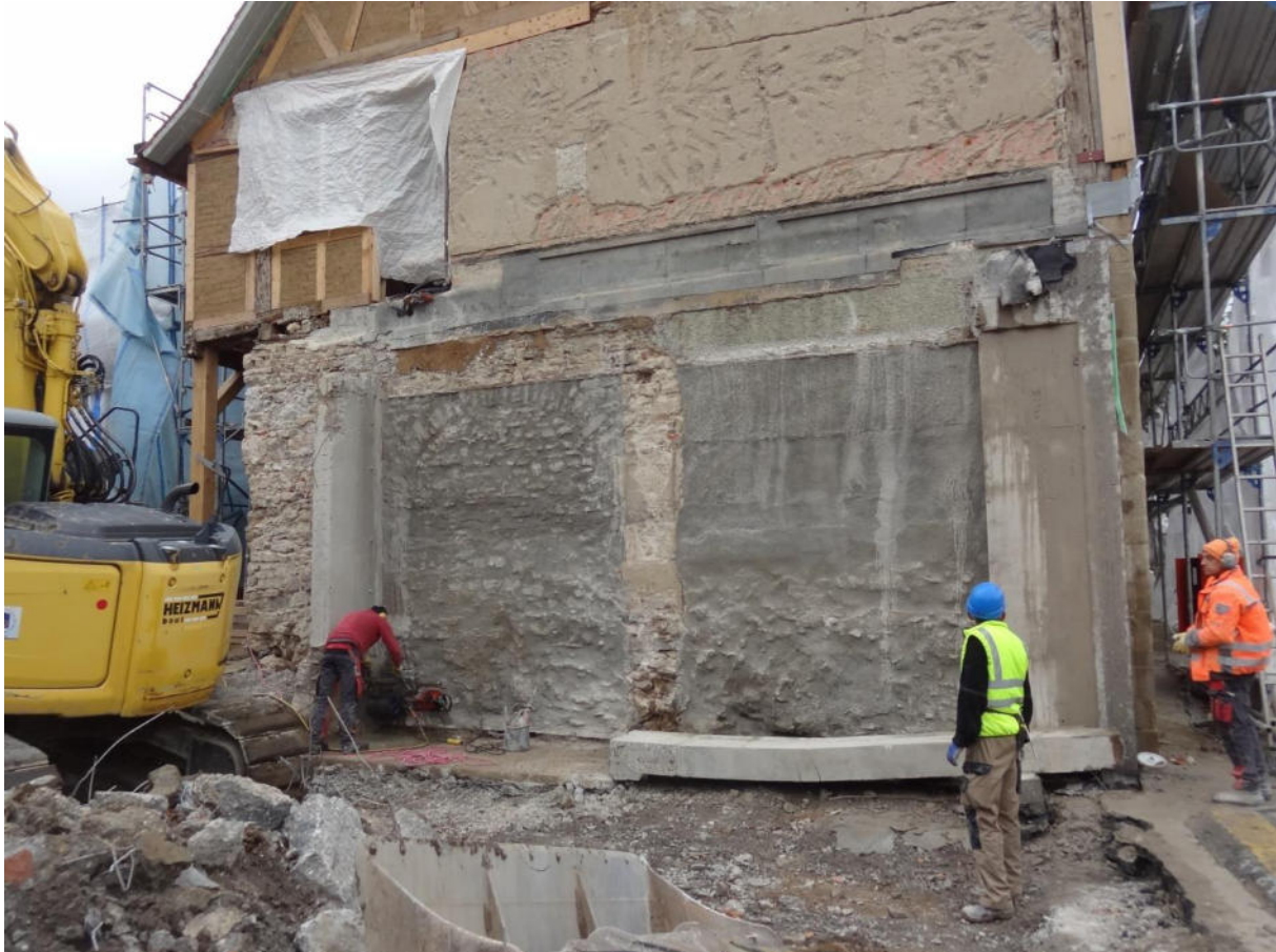
Bild 40 Wohnhaus, Außenwand West im Bereich der Hofdurchfahrt
