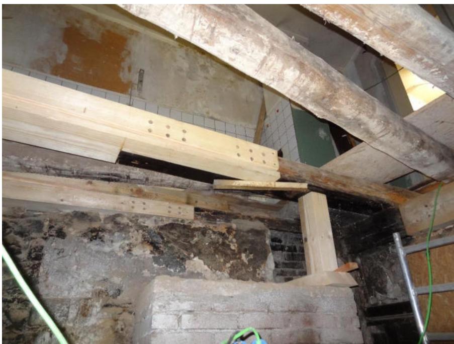
Bild 29 wie Bild 27/28, Aufnahme nach Abschluss der Balken- sanierung (Aufnahme Dezember 2018)
