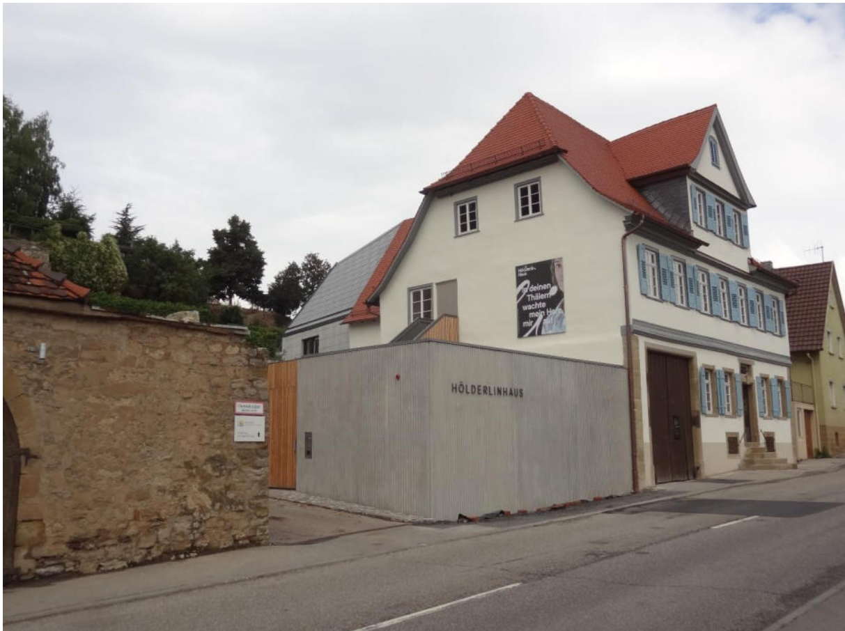
Bild 52 Ansicht Hölderlinhaus nach Abschluss der Sanierungsmaßnahmen
