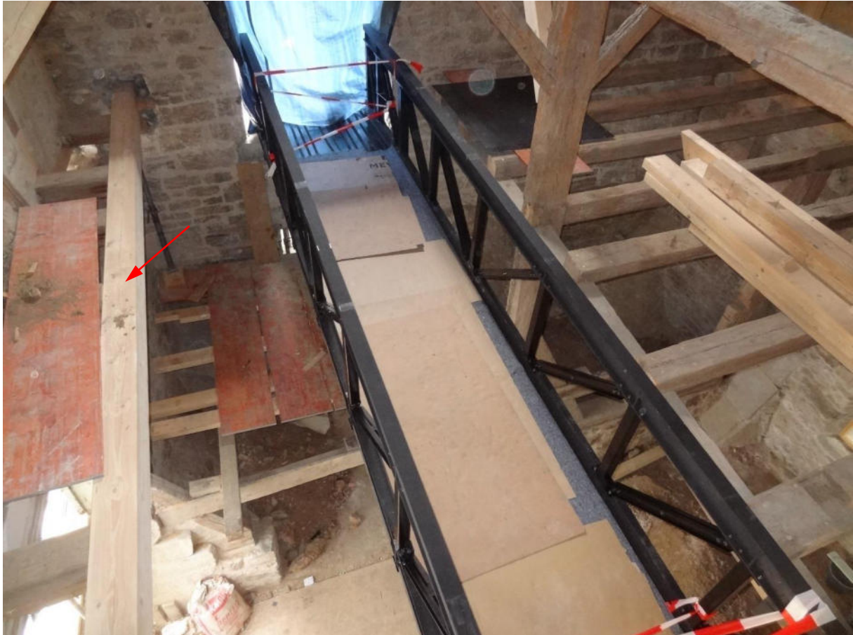
Bild 46 Scheune, Stahlsteg im Obergeschoss.
