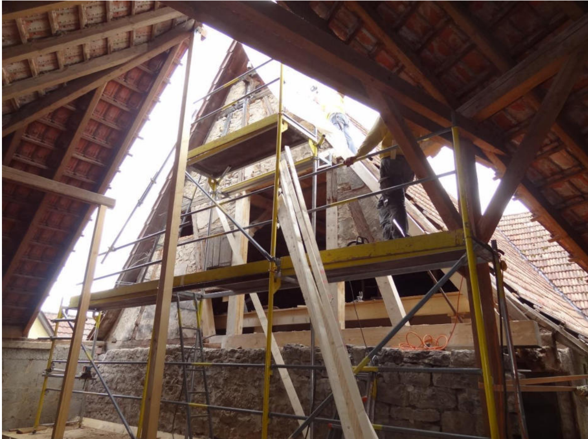
Bild 2 Nordseitige Fachwerkgiebelwand unmittelbar vor Abschluss der vorgezogenen Sanierungsmaßnahmen.
