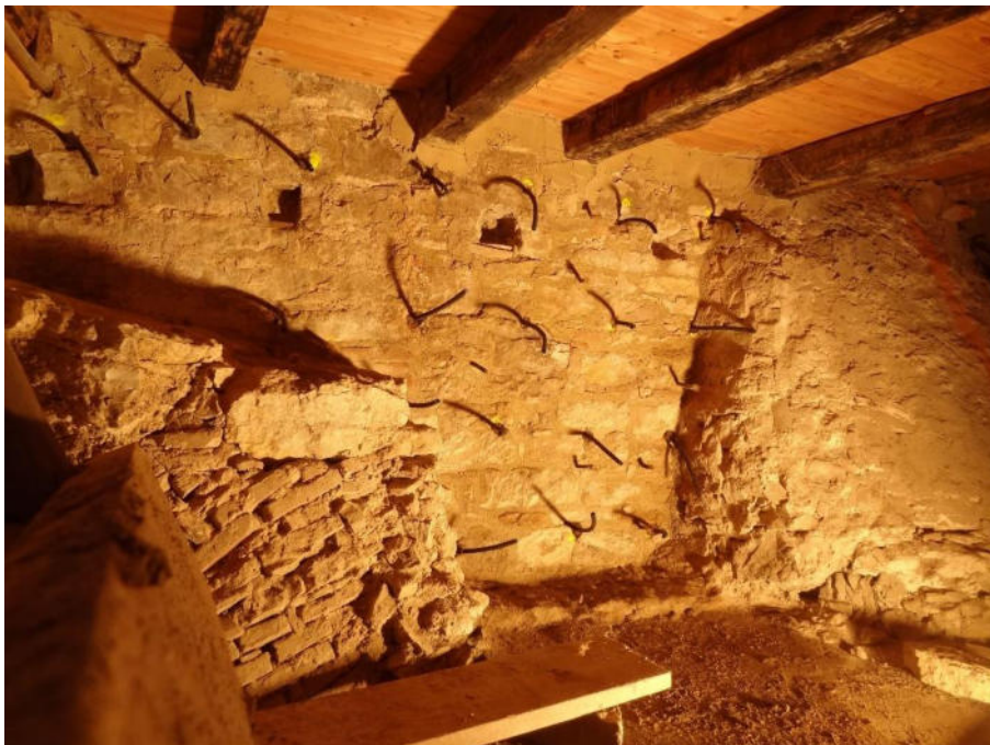
Bild 10 und Bild 11 Giebelwand Nord während der Sanierungs- und Sicherungsmaßnahmen im Erdgeschoss.
