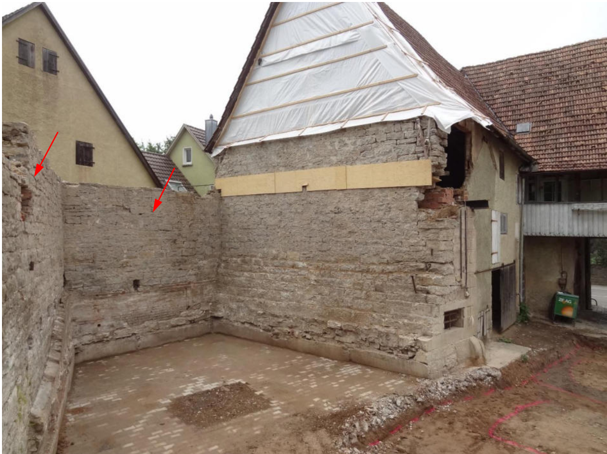
Bild 5 Ansicht des Wohnhauses und der historischen Scheune nach Abbruch des Holztragwerks der neuzeitlichen Scheune.
