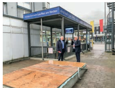
Bürgermeister Waldenberger informiert Landrat Heuser über den Stand des Einbaus des stadtsseitigen Aufzugs am Bahnhof Foto: Frieder Schuh
