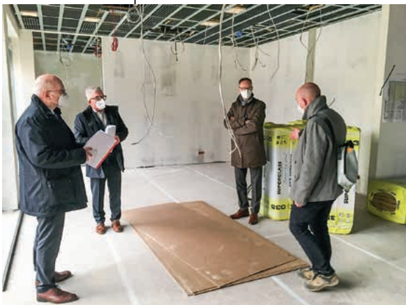
Landrat Heuser, Bürgermeister Waldenberger, Sparkassenvorstand Nähser und Bauleiter Patzelt in der künftigen Mitarbeitercafeteria (v. l. n. r.) Foto: Frieder Schuh
