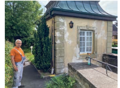
Bauhofmitarbeiter Reiner Schütz bei den Arbeiten an der Fassade.
