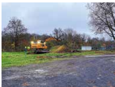
Pumpwerk Städtle startet mit Kampfmitteluntersuchung
