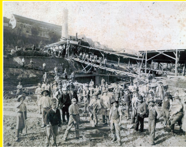
1889, Arbeiter beim Bau des Zementwerks in Lauffen Foto: ZEAG Energie AG Heilbronn
