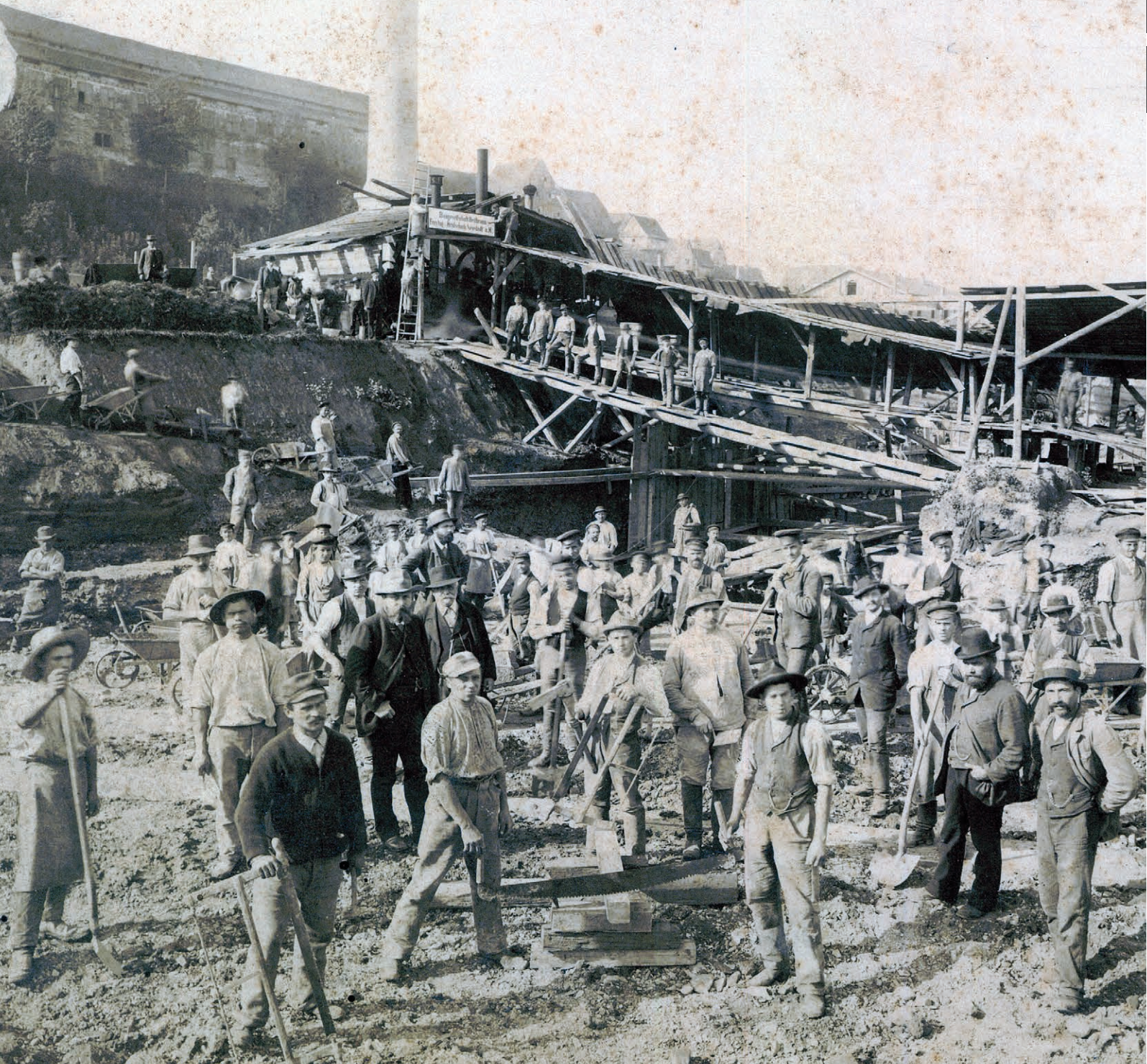
1889, Arbeiter beim Bau des Zementwerks in Lauffen Foto: ZEAG Energie AG Heilbronn
