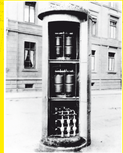
Transformatorsäule in Heilbronn 1892, Foto: ZEAG Energie AG
