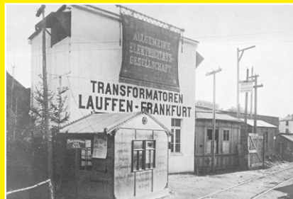
Ansichtskarte des Transformatorhauses der Fernstromübertragung
