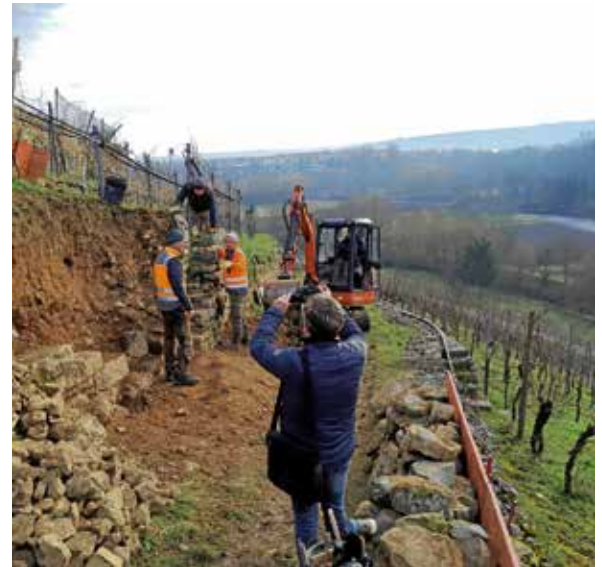
Wiederaufbau eines Mauerstücks auf der Ebinheide
