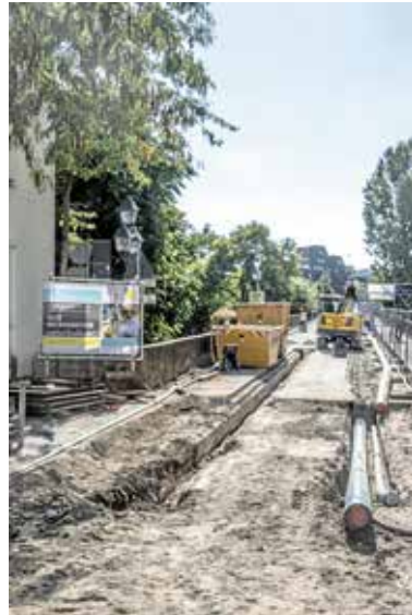
Leitungsverlegung Alte Neckarbrücke
