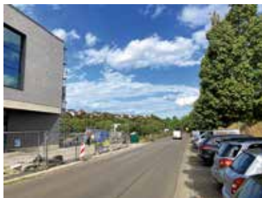
Zukünftiger Standort des Fußgängerüberwegs im Brühl
