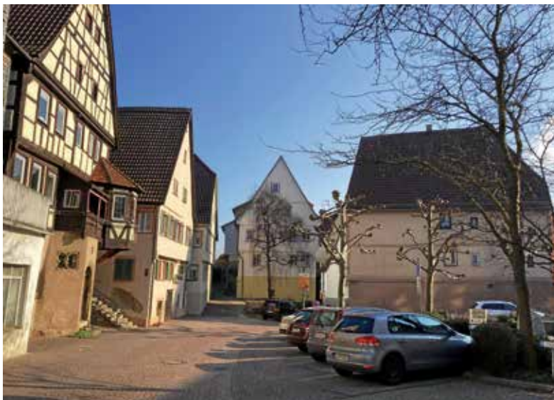
Im Städtle sollen durch das Sanierungsgebiet positive Impulse gesetzt werden.
