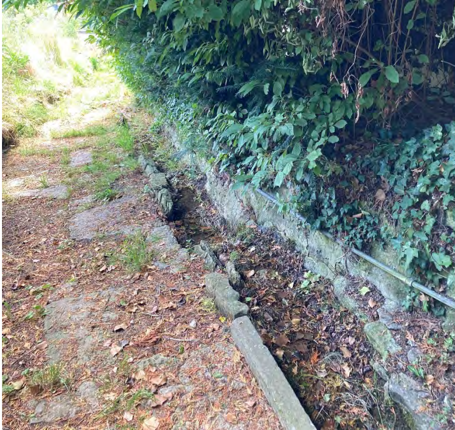
Abbildung 21: Bestehender Graben der Maßnahme Klosterstraße I (Ortbegehung am 24.06.2022)
