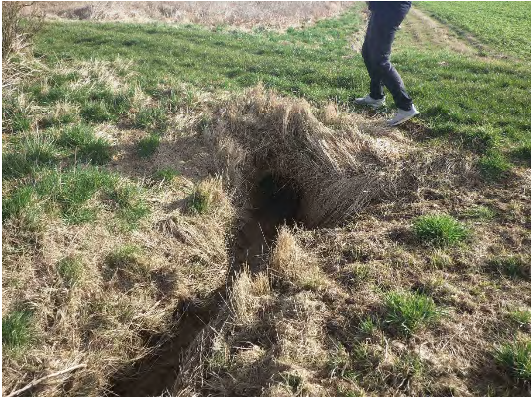
Abbildung 36: Bestehender Einlauf des Riedergrabens (Ortbegehung am 24.02.2022)
