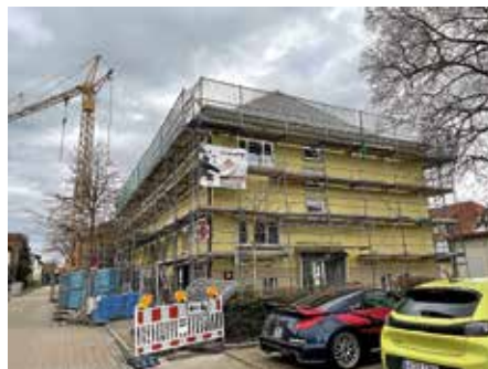
Die Musikschule in der Südstraße wird saniert
