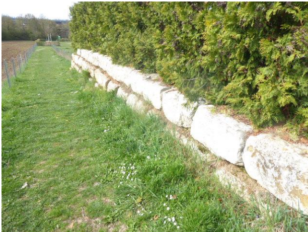
Abb. 11: Blocksteinmauer an der Wohnbebauung neben dem nordwestlichen Plangebiet.
