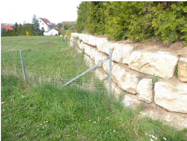
Abb. 26: Muschelkalkblockmauer an Flst.-Nr. 48/1 an der Mühlrotstraße als Mauereidechsenhabitat.
