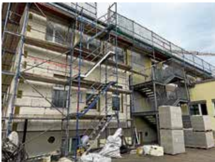
Fassadensanierung an der Musikschule
