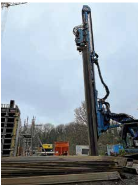
Die Arbeiten am Pumpwerk Städtle laufen auf Hochtouren
