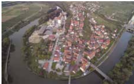
Sanierung Lauffen V Städtle
